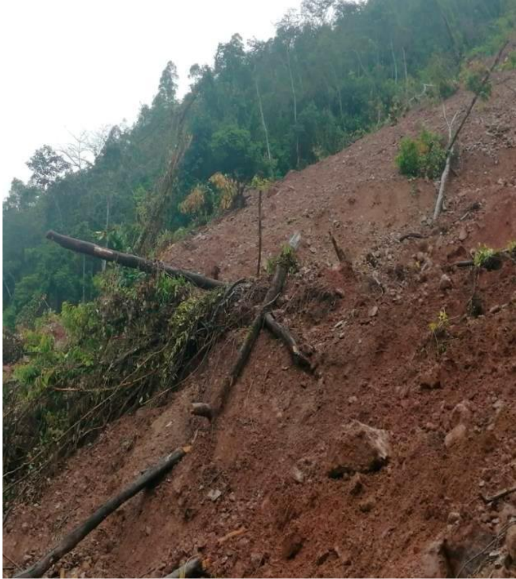
Fotografía 1. Escarpa de deslizamiento registrado el 22 de febrero del 2022 (fuente: Informe de emergencia N° 254 - 6/3/2022 / COEN - INDECI)
