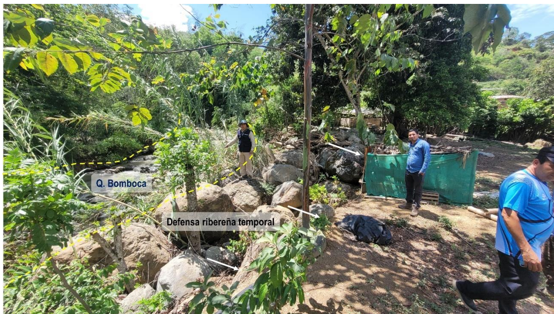
Figura 8. Defensa ribereña temporal en el sector crítico de la quebrada Bomboca.
