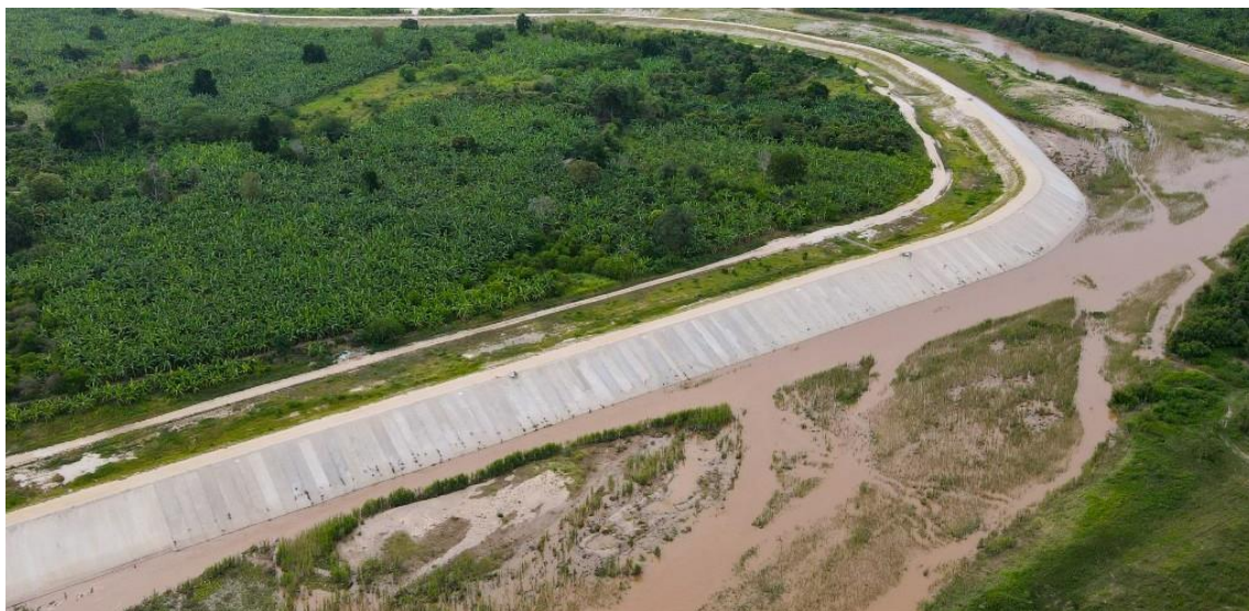
Fotografía 3. Ejemplo de una defensa ribereña con un muro de concreto.
