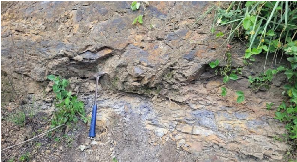
Fotografía 1. Vista de un talud donde se deja al descubierto al macizo rocoso compuesto por calizas ferruginosas muy fracturadas y moderadamente meteorizadas.
