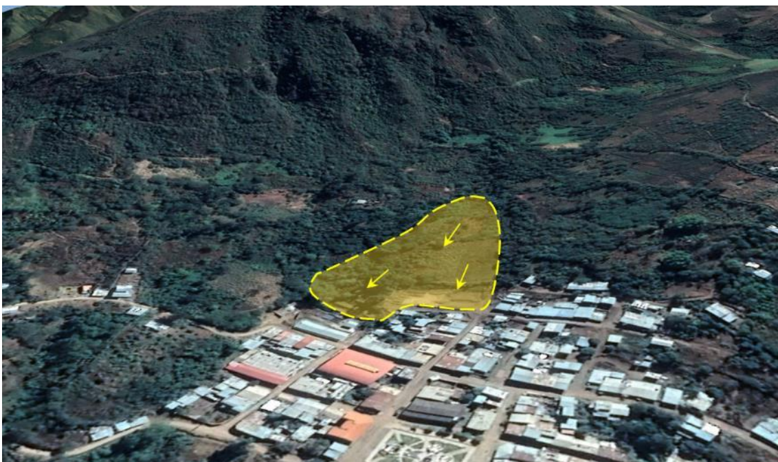
Figura 7. Vista del de deslizamiento inactivo latente en la localidad de San Felipe (delimitada por la línea discontinua amarilla).
