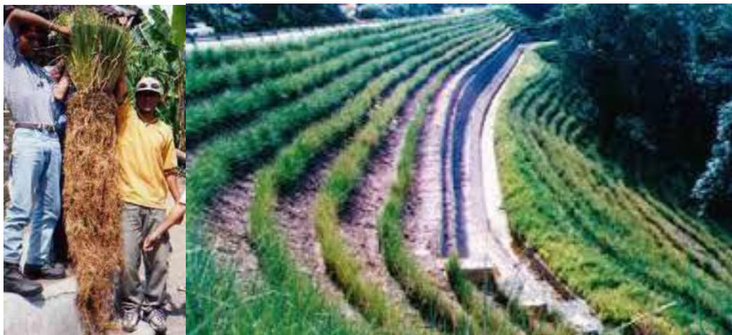
Fotografía 3. Ejemplo de bioingeniería con arbusto (vetiver) en taludes de materiales sueltos.
