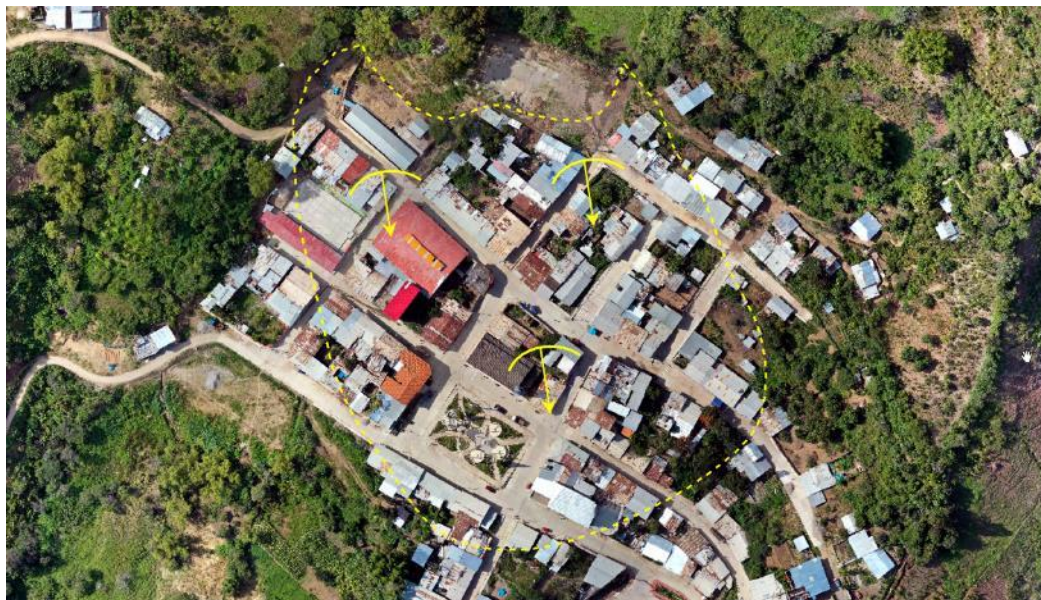
Figura 10. Vista del cuerpo de reptación, donde se aprecia el área urbana afectada por el movimiento.
