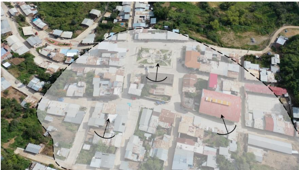
Figura 6. Vista de la localidad de San Felipe y la zona afectada por la reptación de suelos (delimitada por la línea discontinua negra).
