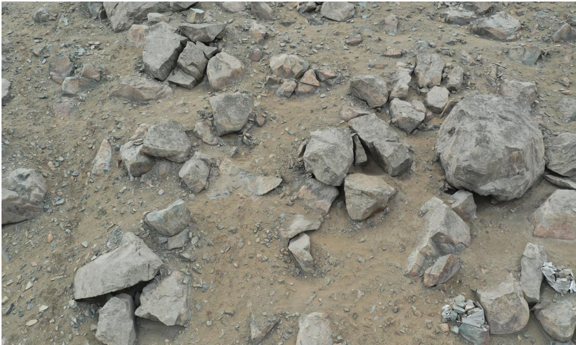
Fotografía 9. Laderas con afloramientos rocosos susceptibles a caída, hacia la parte alta del A.H. "Diente de Oro".
