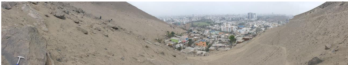
Fotografía 6. Vista panorámica de la zona de estudio, se observan procesos de caídas de rocas en las laderas del cerro Centinela que podrían afectar el A.H. “Diente de Oro”. Coordenadas UTM (WGS 84): 286683 E, 8661880 N.
