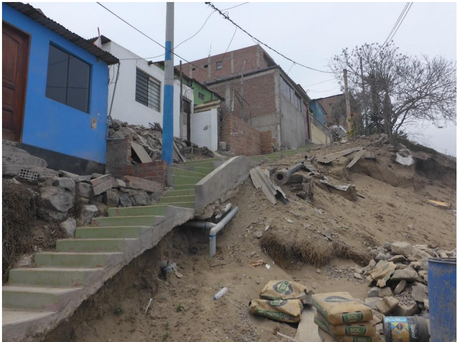
Fotografía 3. Depósitos eólicos sobre los cuales se asienta el A.H. “Diente de Oro”.
