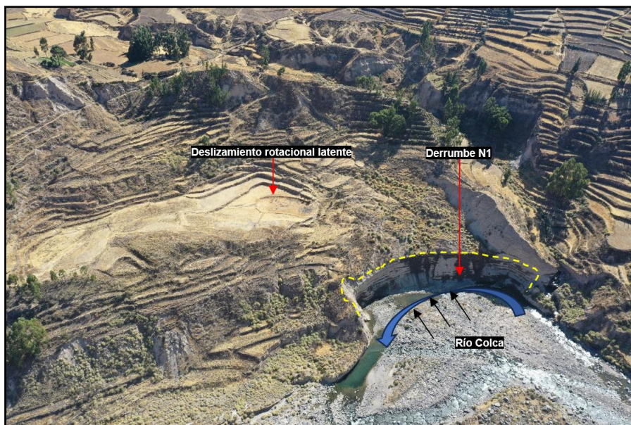
Figura 10. Derrumbes en el sector Uncollo.
