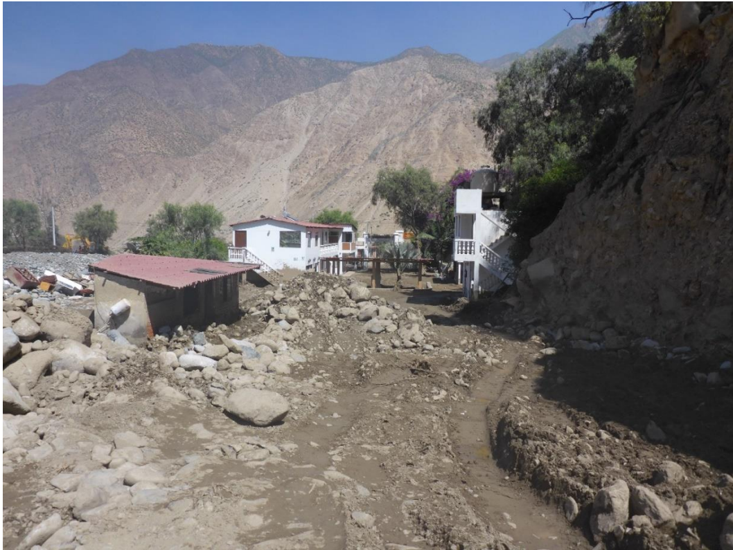
Fotografía 15. Daños generados por el aluvión en el club campestre “Real Club” en el sector Santa Rosa de Quives.
