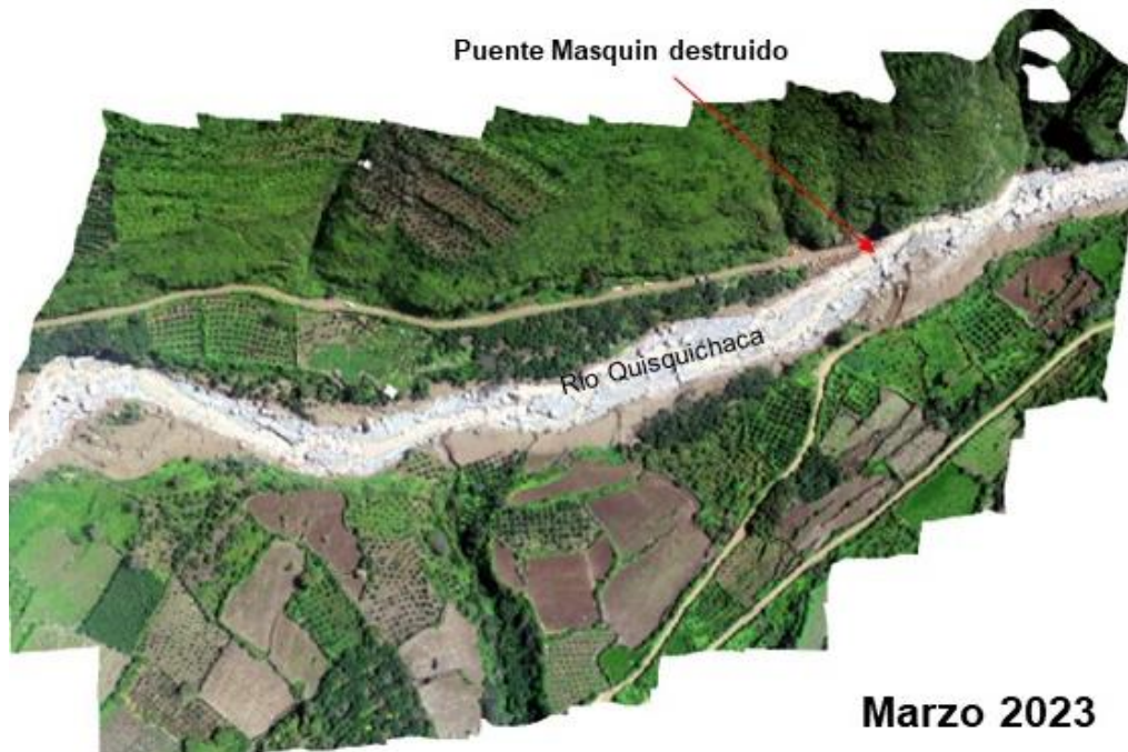
Figura 12. El análisis multitemporal utilizando una imagen satelital de Google Earth (agosto 2021) y las imágenes obtenidas mediante vuelos con dron (marzo 2023), permitió verificar el ensanchamiento del cauce del río Arahua, hasta en 70.5 m aproximadamente, así como la destrucción total del puente Masquín, única vía de acceso al sector de Arahua.
