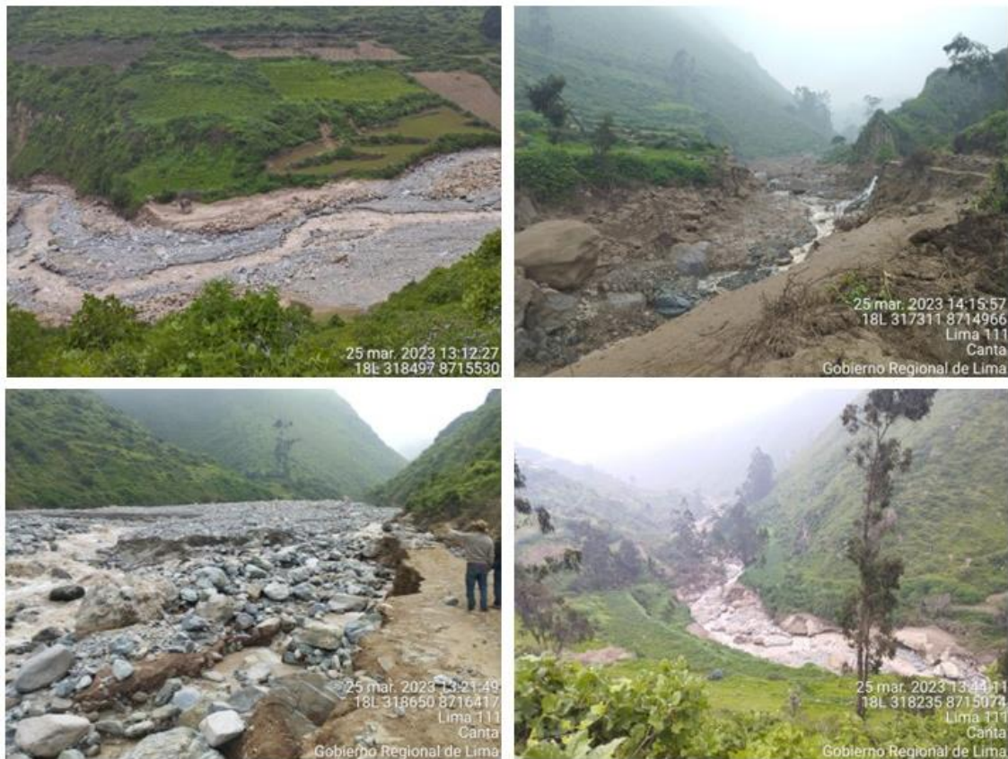
Figura 13. Algunas zonas en los alrededores del sector de Arahuary que fueron afectadas por el aluvión del ocurrido el 20 de marzo de 2023. Se puede observar el ensanchamiento y profundización del cauce del río Arahuary, así como la afectación de terrenos de cultivo y vías de acceso hacia el sector de Arahuary. Fuente: Municipalidad Distrital de Arahuary.
