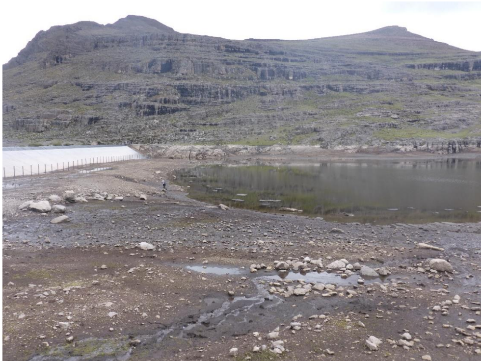
Fotografía 9. Desembalse de la laguna Yarcán a consecuencia de la rotura parcial del dique.
