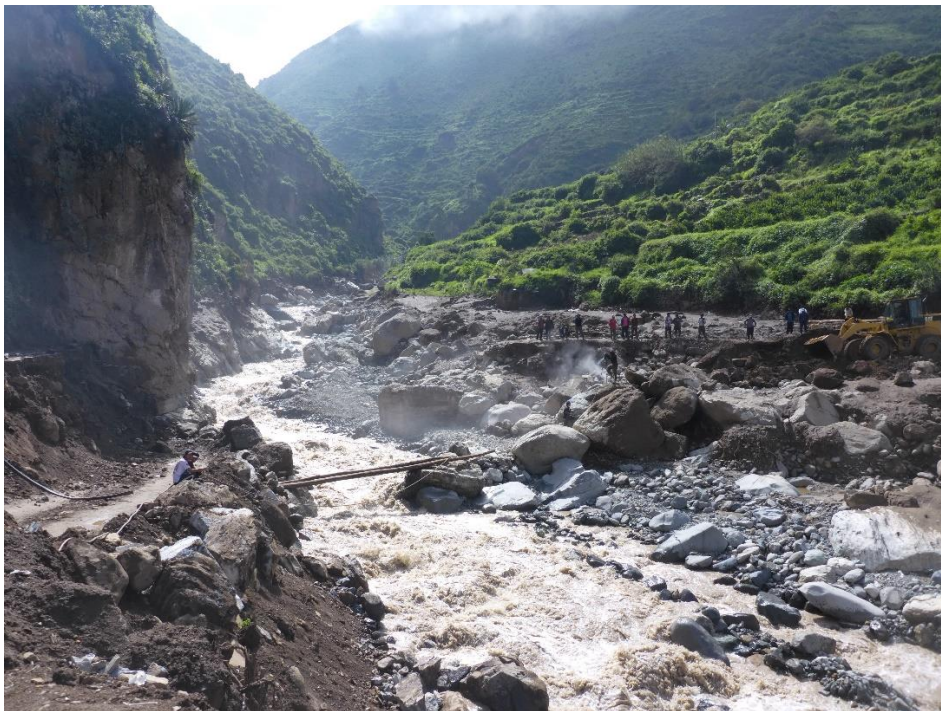
Fotografía 12. Material depositado por el aluvión generado el 20 de marzo de 2023 y canalizado por el río Arahua, el cual generó la destrucción del puente Maquín.
