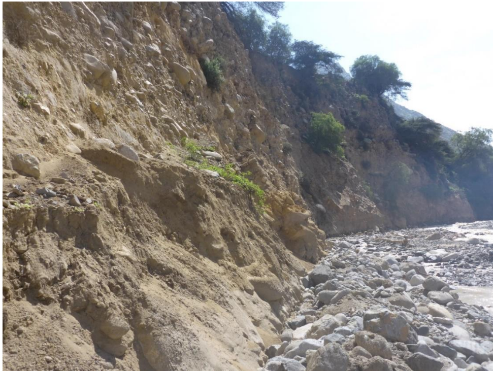
Fotografía 4. Depósitos aluviales conformados por bloques, gravas y cantos subangulosos a subredondeados envueltos en una matriz arenolimososa, ubicados en la margen derecha del río Arahua.
