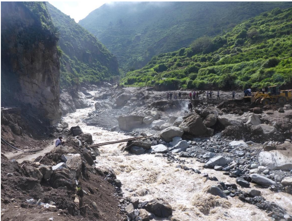
Fotografía 8. Depósitos proluviales canalizados por el cauce principal del río Arahúay. Estos materiales generaron inundaciones y erosiones que destruyeron el puente Maquín, única vía de acceso al centro poblado de Arahúay.
