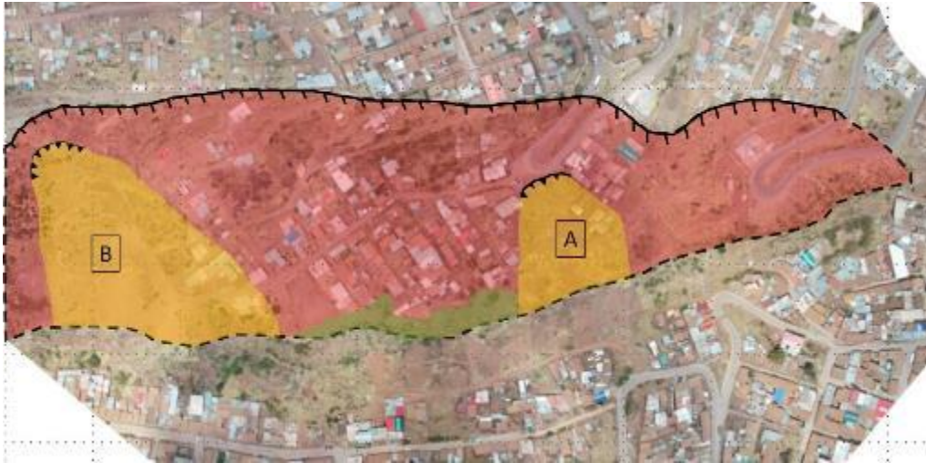
Figura 7. Se aprecia la escarpa de derrumbe antiguo con activación de deslizamiento en la parte baja.
