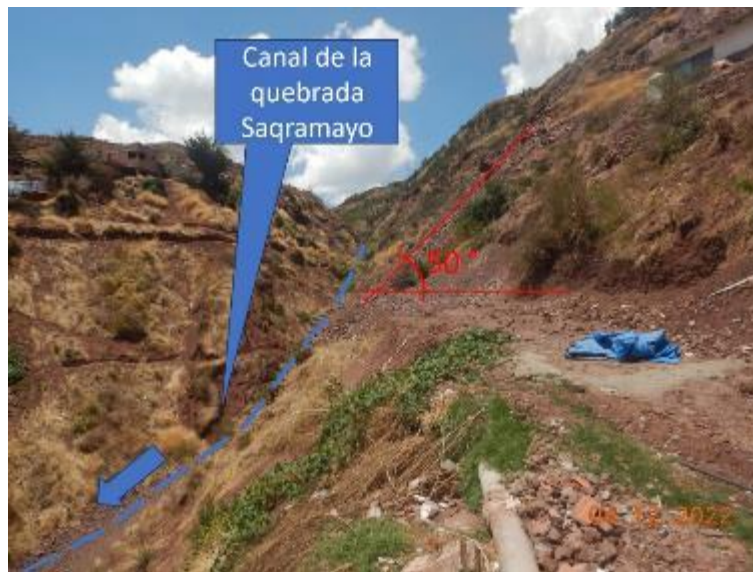
Figura 6. Se aprecia el canal de la quebrada a la altura del deslizamiento en el sector B, se aprecia la pendiente en la margen izquierda de la quebrada.
