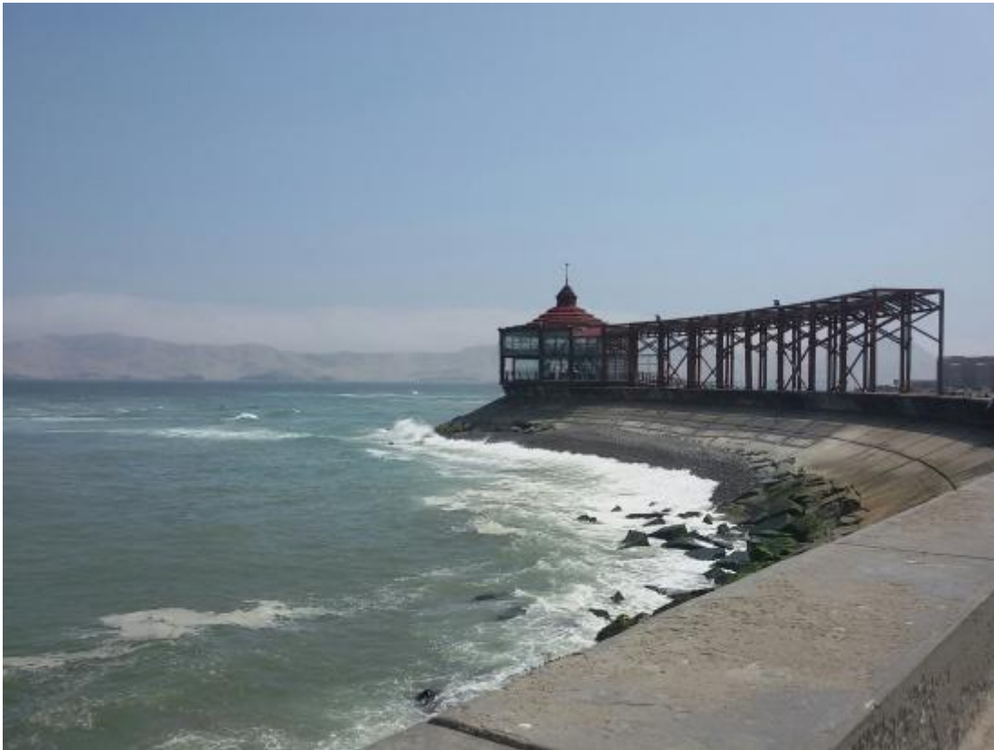
Fotografía 8 Imagen a tomar en cuenta de Barrera rompeolas del distrito La Punta Región Callao, vista de enrocado al pie de la barrera o dique rompeolas de concreto. Fuente: Tripadvisor.com.pe
