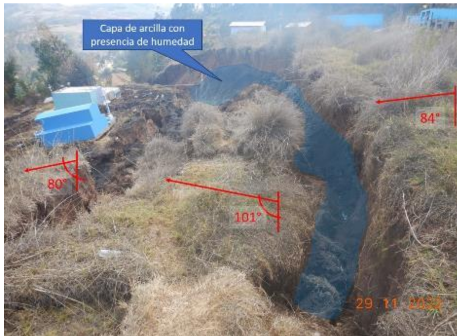
Figura 8. Se aprecia la escarpa principal con el cuerpo deslizado basculado y con retención de humedad en la capa de arcilla.
