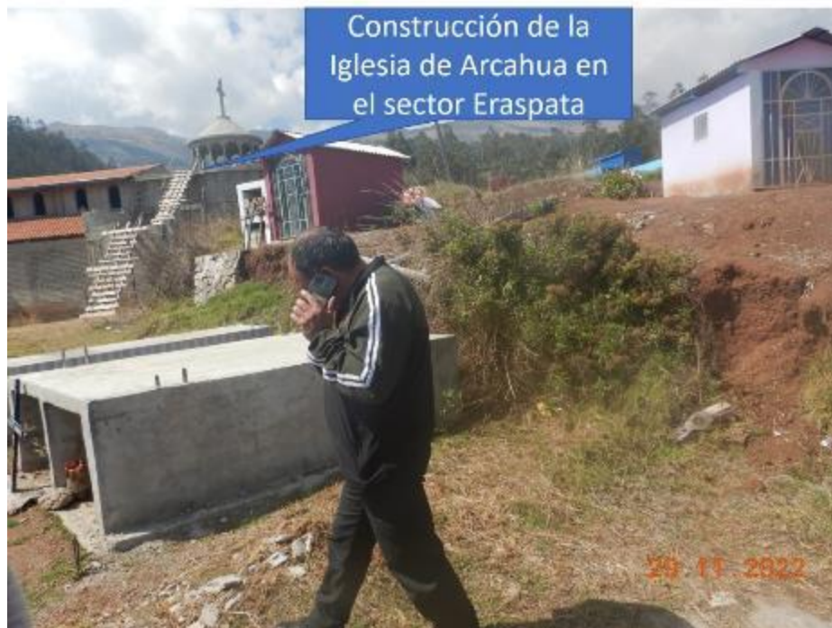
Figura 9. Se aprecia la iglesia en construcción junto al cementerio, la que puede ser afectada si las grietas retrogresivas llegan hasta la iglesia.
