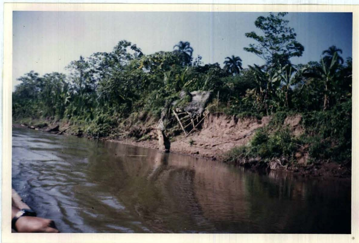
FOTO 9.1: DAÑOS OCASIONADOS POR LA ACCION GEODINAMICA (INUNDACIONES, EROSION DE RIBERAS) DEL RIO PARANAPURA EN LA LOCALIDAD DE TRES UNIDOS. (CUADRANGULO DE YURIMAGUAS)
