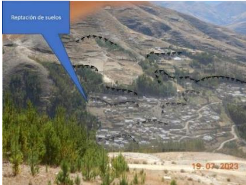
Figura 7. Se aprecia la comunidad de Quisinsaya, se observa escarpas de antiguos deslizamientos (marcados con líneas negras).
