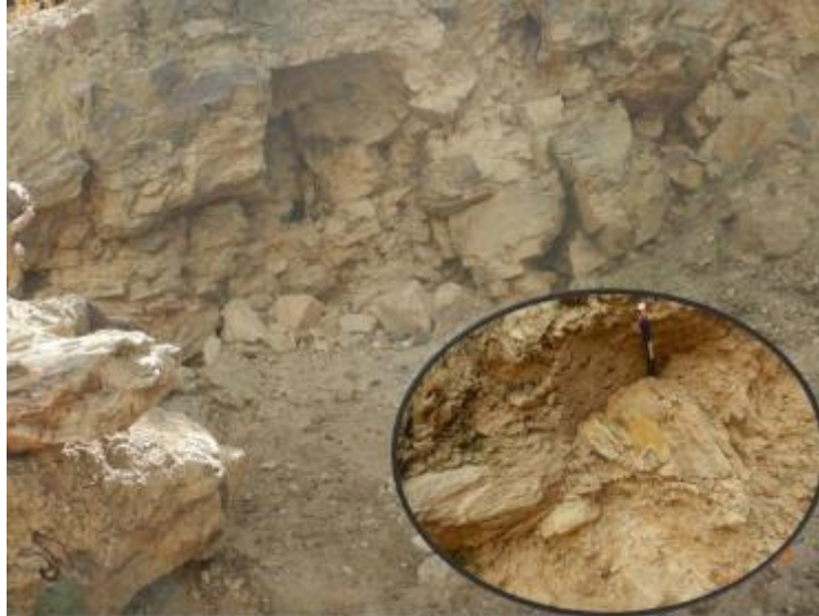
Figura 2. En el poblado de la comunidad de Quisinsaya se aprecia pelitas micáceas verdes muy fracturadas y moderadamente meteorizadas.
