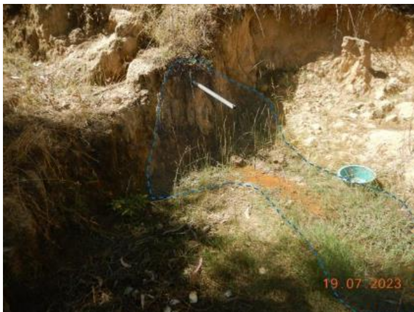
Figura 9: En coordenadas UTM: 230645 E, 8503253 S. Se aprecia el manante de agua con una pequeña captación, el cual no presenta ninguna canalización y dejan que infiltre toda el agua al sub suelo.
