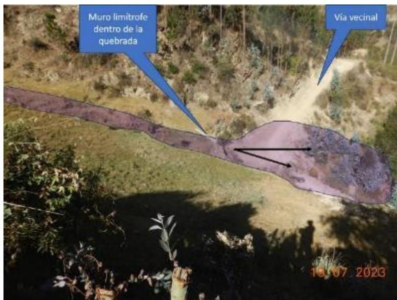
Figura 12. Se aprecia la continuación del canal por donde paso el flujo y la zona donde se explayo ayudado por la vía.
