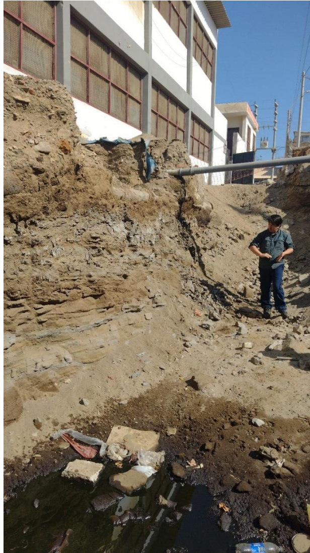
Foto 4. Afloramiento de hidrocarburo en la estación 50.0 de la sección L-01, ubicado en la calle adyacente a la I.E.
