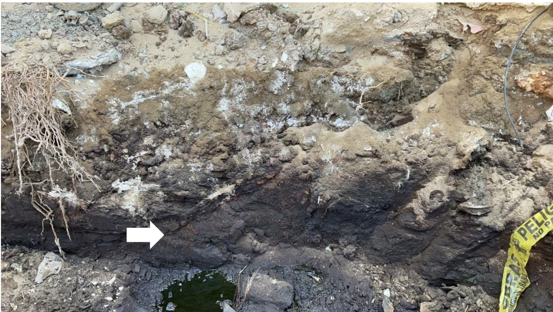
Foto b. Fallas E-W (flecha blanca) en la calicata ubicada en el jardín del colegio. Nótese la arenisca saturada en hidrocarburo.
