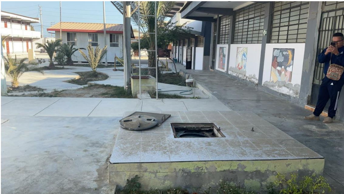
Foto f. Ubicación de tanque de agua enterrado.
