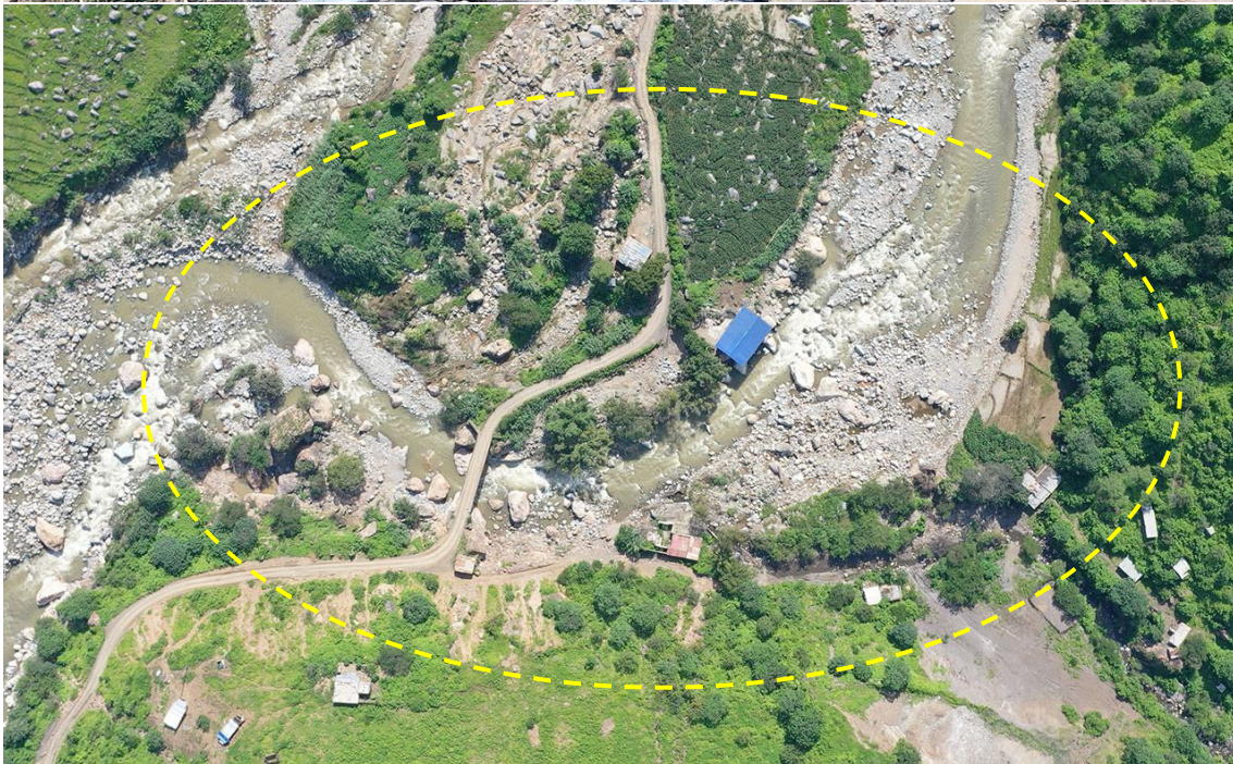
Fotografía 133. Zona crítica 14-102, flujo de detritos en la localidad de Montecardo que podría afectar 250 m, un puente de la vía LA-103 y 4 viviendas. Coordenadas E: 670555; N:9295275. (13/09/23).
