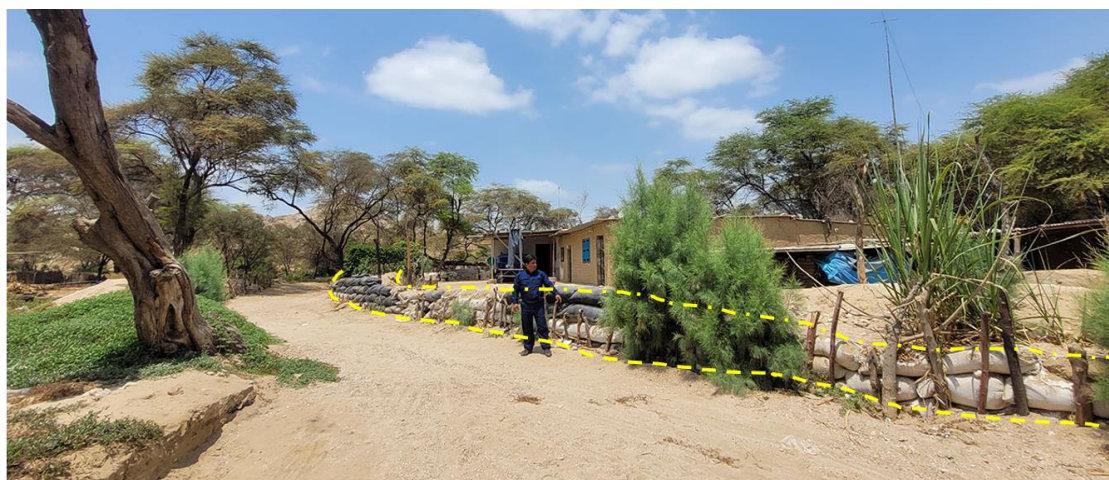
Figura 27. Flujo de detritos con mayoritaria composición de arenas en la localidad de San Antonio, Túcume (ZC 14-170), se aprecia una defensa hecha con sacos (en amarillo).
