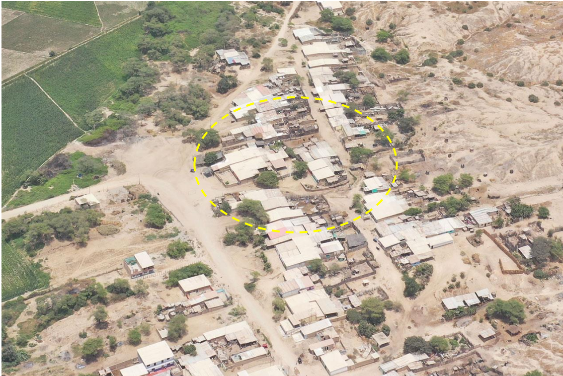
Fotografía 203. Zona crítica 14-172, flujo de detritos en la localidad de La Raya que podría afectar 10 viviendas y 10 m de la vía LA-606. Coordenadas E: 628626; N:9279074. (14/09/23).
