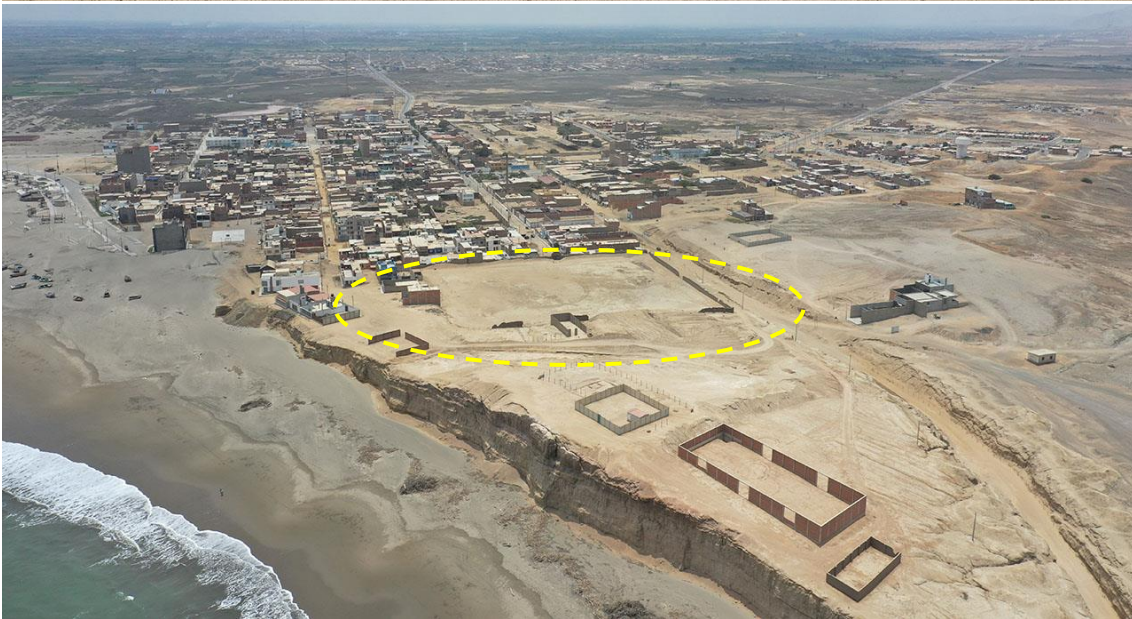
Fotografía 59. Zona crítica 14-028, flujo de detritos en la localidad de Eten Puerto que podría afectar 2 vivienda. Coordenadas E: 625272; N:9233656. (19/09/23).
