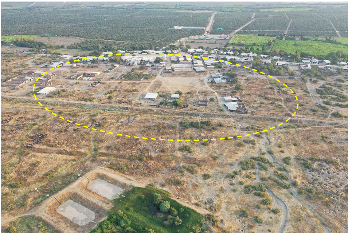
Fotografía 109. Zona crítica 14-078, flujo de detritos en la localidad de Cojal que podría afectar 30 viviendas ante probable colapso del canal de coronación. Coordenadas E: 665689; N:9238329. (21/09/23).
