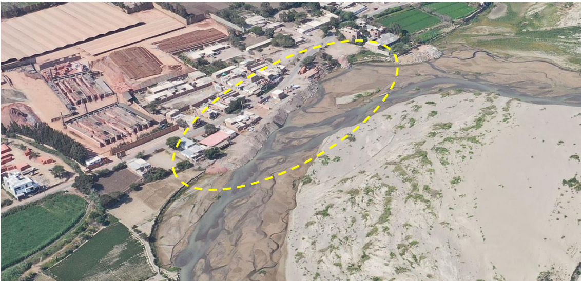
Fotografía 68. Zona crítica 14-037, erosión fluvial en la localidad de Valencia que podría afectar 7 viviendas. Coordenadas E: 631100; N:9242985. (19/09/23).
