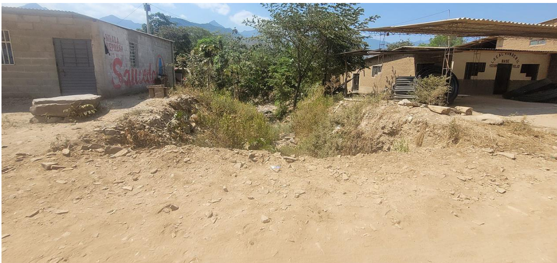
Fotografía 146. Zona crítica 14-115, flujo de detritos en la localidad de Mochumí Bajo que podría afectar 10 m de la vía LA-103 y 5 viviendas. Coordenadas E: 665085; N:9291752. (13/09/23).
