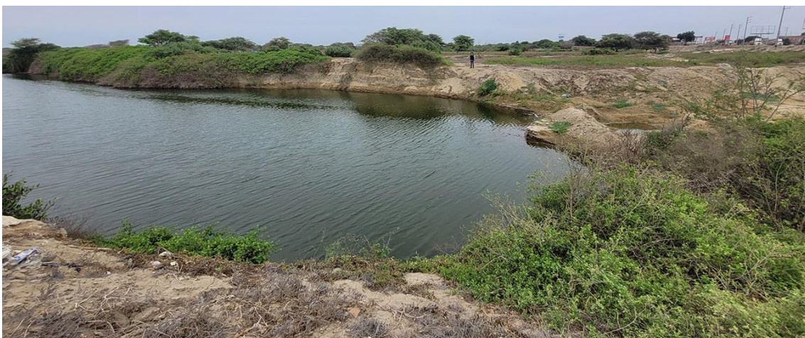
Fotografía 170. Zona crítica 14-139, inundación fluvial en la localidad de Mórrope que podría afectar 1 puente de la vía PE-1N y 3 viviendas próxima. Coordenadas E: 609437; N:9276058. (08/09/23).
