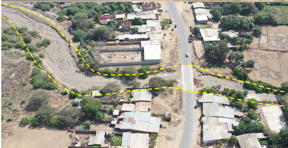
Fotografía 142. Zona crítica 14-111, flujo de detritos en la localidad de Desaguadero que podría afectar 1 badén de la vía LA-103 y 2 viviendas. Coordenadas E: 656467; N:9289266. (13/09/23).
