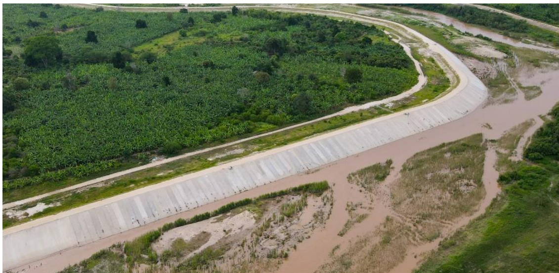
Fotografía 207. Ejemplo de una defensa ribereña con un muro de concreto.
