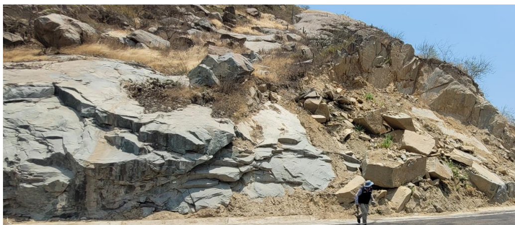
Fotografía 17. Macizo rocoso diorítico poco fracturado y medianamente meteorizado en la vía PE-06A. Coordenadas E: 665799; N: 9254365 (27/09/2023).
