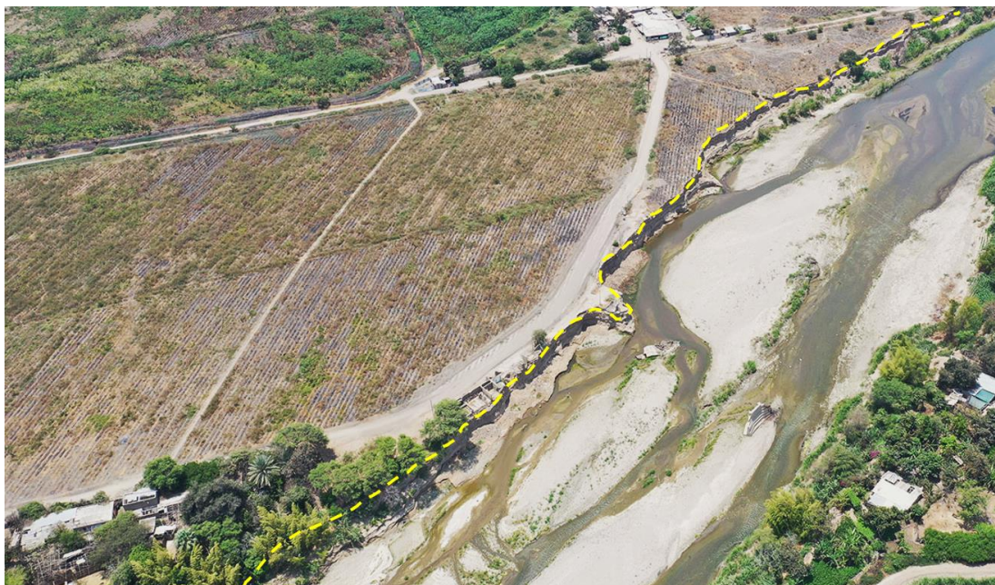
Figura 30. Erosión fluvial en el sector San Baltazar Pucalá (ZC 14-089), donde el río Reque ha erosionado el margen derecho de su cauce, afectando viviendas y una vía.
