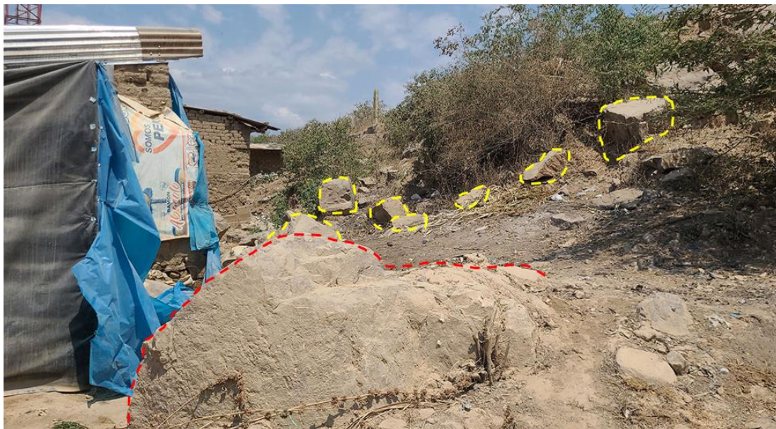
Figura 22. Caída de rocas en la localidad de Las Delicias, Oyotún (ZC 14-046), se aprecian viviendas afectadas por caída de rocas; los bloques recientes están delimitados en amarillo y los antiguos en rojo.
