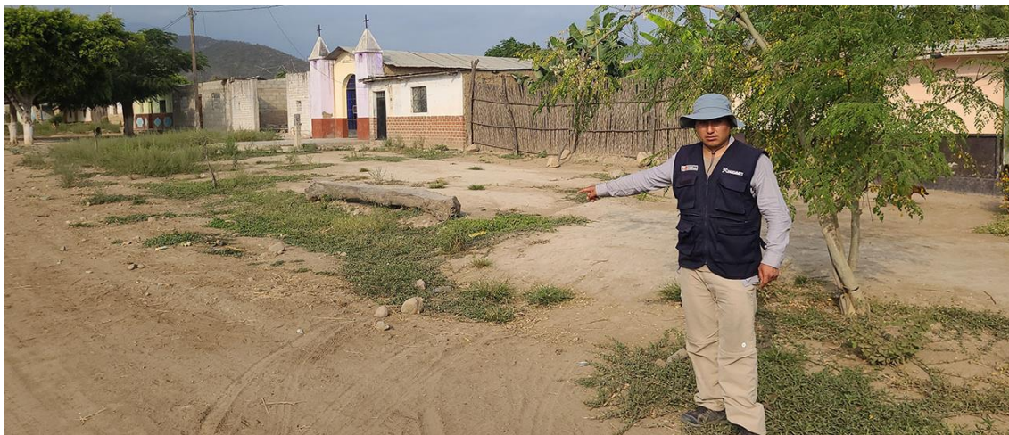
Fotografía 51. Zona crítica 14-020, inundación fluvial en la localidad de Overazal que podría afectar 25 viviendas y 200 ha de terrenos de cultivo. Coordenadas E: 679062; N:9270339. (27/09/23).
