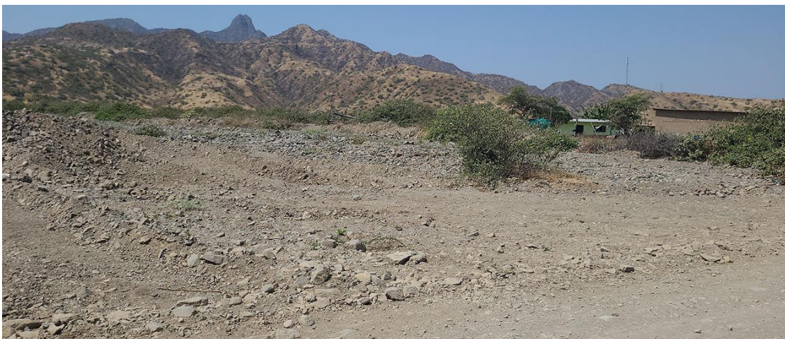
Fotografía 38. Zona crítica 14-007, flujo de detritos en la localidad de Campo Nuevo que podría afectar 50 m de la vía LA-743 y 3 viviendas. Coordenadas E: 678091; N:9262495. (28/09/23).
