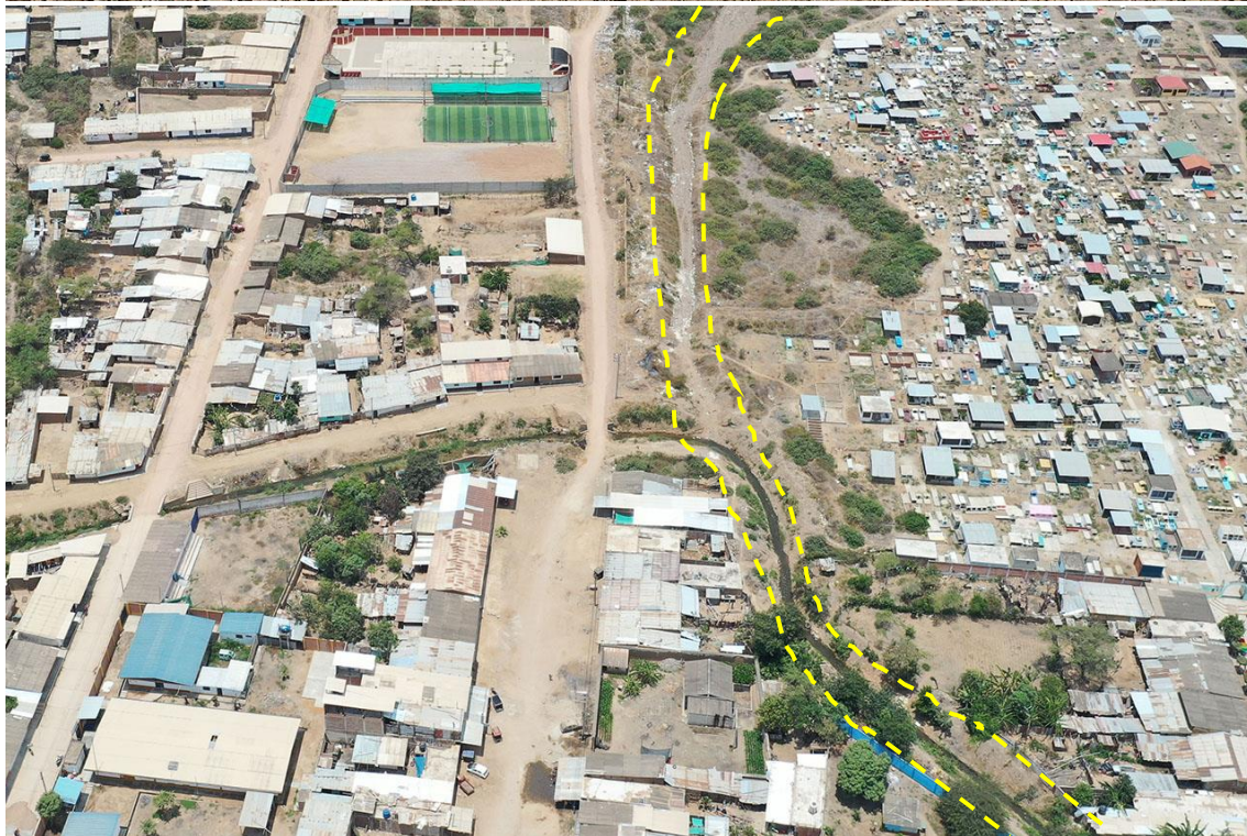
Fotografía 75. Zona crítica 14-044, flujo de detritos en la localidad de Quebrada El Cementerio 2 que podría afectar 2 viviendas y 20 m de una vía. Coordenadas E: 688066; N:9242635. (21/09/23).
