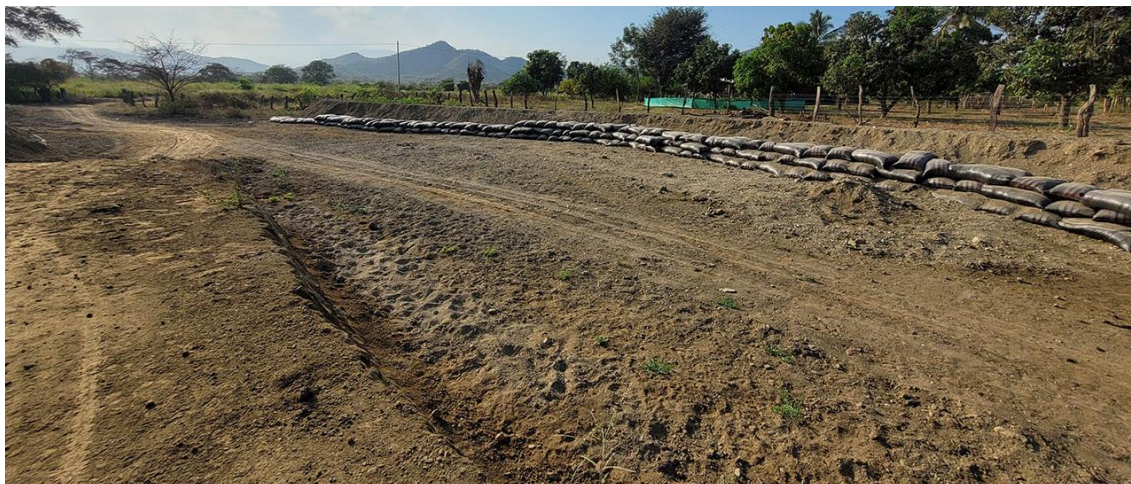
Fotografía 186. Zona crítica 14-155, flujo de detritos en la localidad de El Puquio que podría afectar 100 m de la vía LA-506 y 2 viviendas. Coordenadas E: 639118; N:9344292. (10/09/23).
