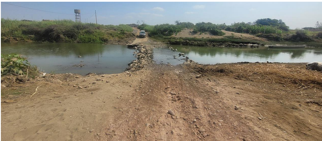
Fotografía 63. Zona crítica 14-032, inundación fluvial en la localidad de Las Vegas que podría afectar 70 m de trocha carrozable y 15 viviendas. Coordenadas E: 643542; N:9219444. (20/09/23).
