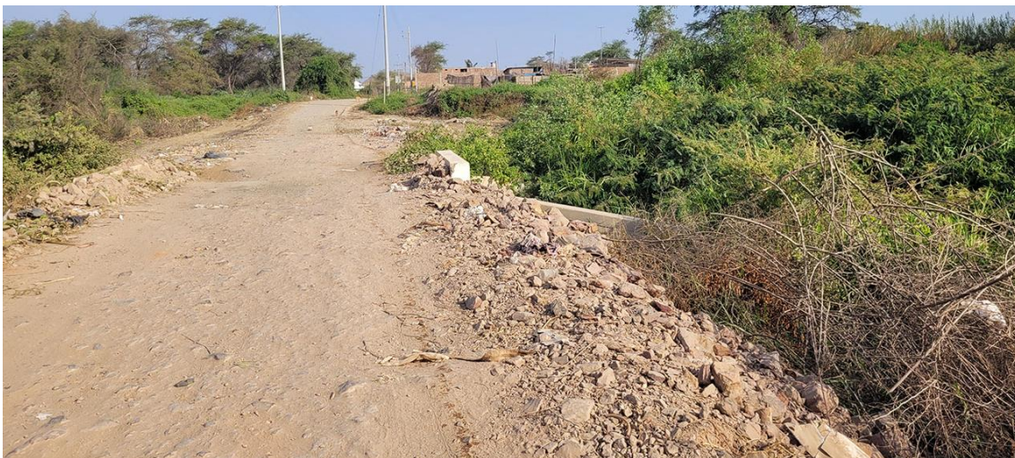
Fotografía 195. Zona crítica 14-164, inundación fluvial en la localidad de Los Ventura que podría afectar 50 m de una vía local y 4 viviendas. Coordenadas E: 627151; N:9288361. (14/09/23).
