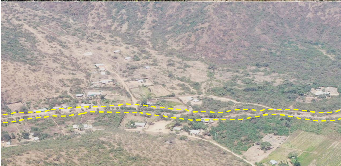
Fotografía 153. Zona crítica 14-122, flujo de detritos en la localidad de Huaca Colorada que podría afectar 5 viviendas. Coordenadas E: 648026; N:9319288. (12/09/23).
