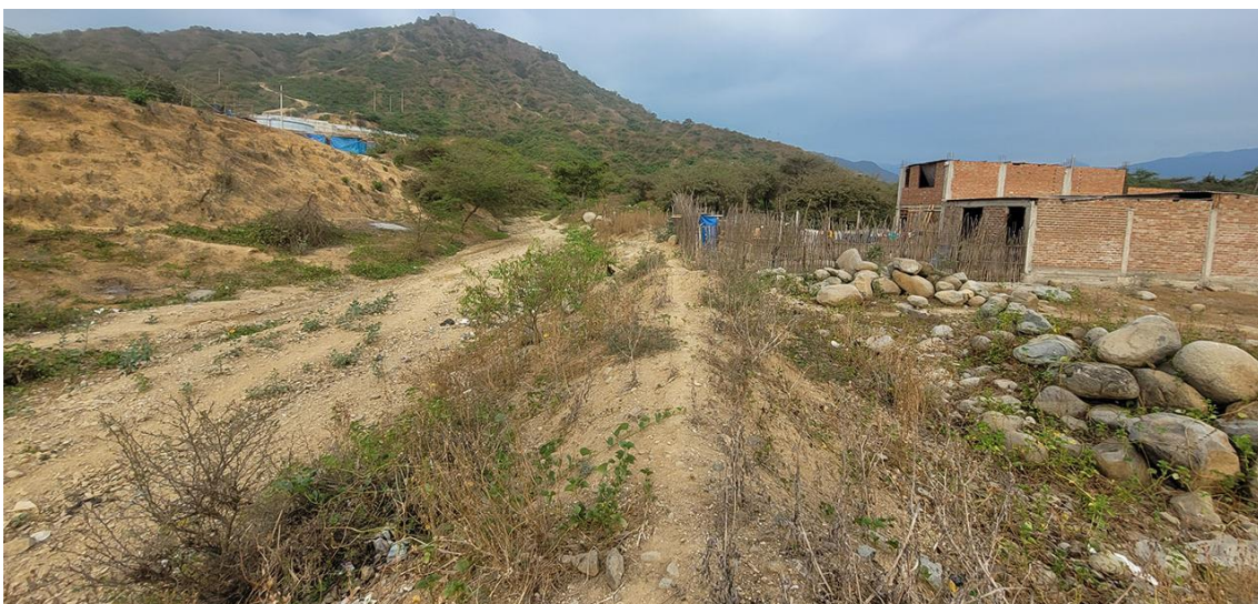
Fotografía 196. Zona crítica 14-165, flujo de detritos en la localidad de Salas Quebrada Riachuelo que podría afectar 5 viviendas. Coordenadas E: 654786; N:9306418. (11/09/23).
