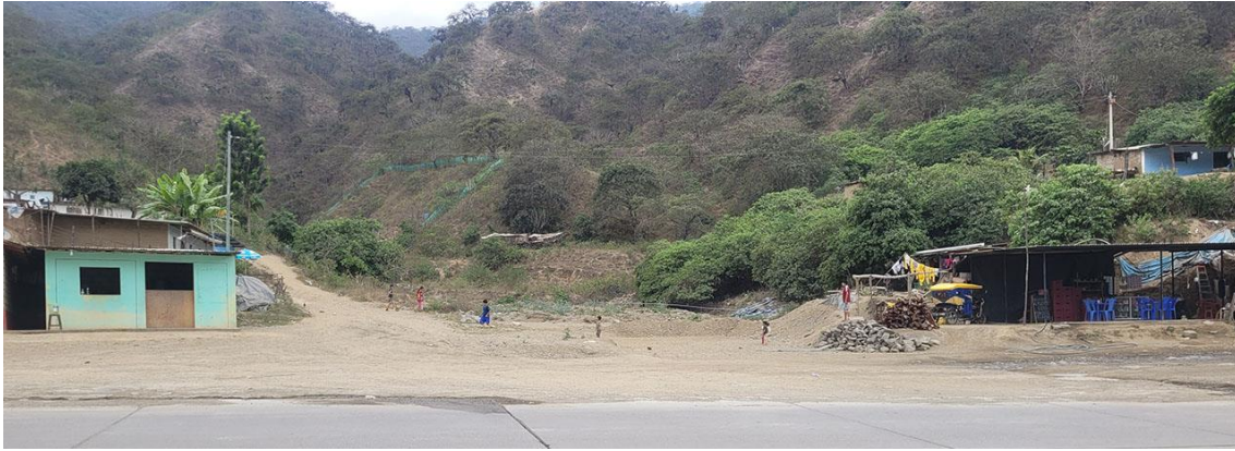
Fotografía 198. Zona crítica 14-167, flujo de detritos en la localidad de Túpac Amaru que podría afectar 50 m de la vía PE-04B y 3 viviendas. Coordenadas E: 654916; N:9343171. (09/09/23).
