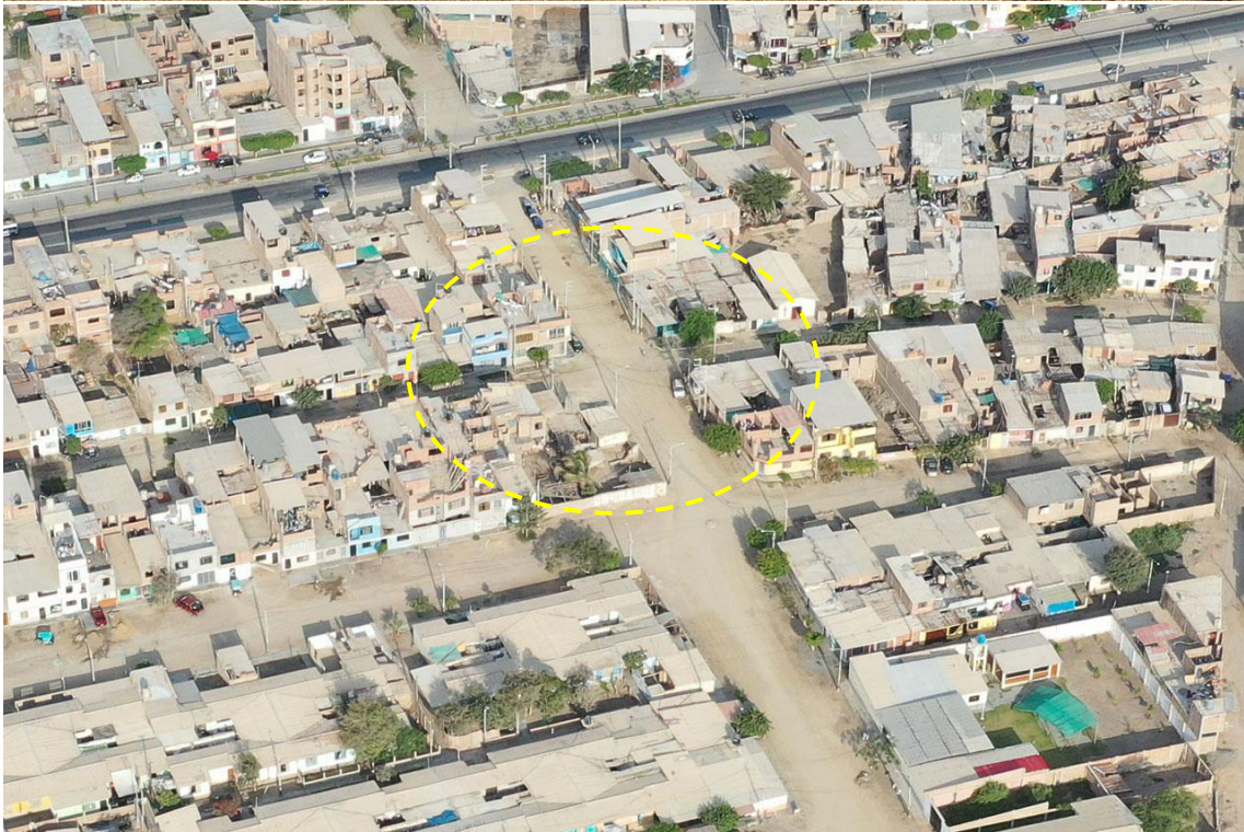
Fotografía 84. Zona crítica 14-053, inundación pluvial en la localidad de Pisci pueblo que podría afectar 15 viviendas. Coordenadas E: 635730; N:9257324. (16/09/23).
