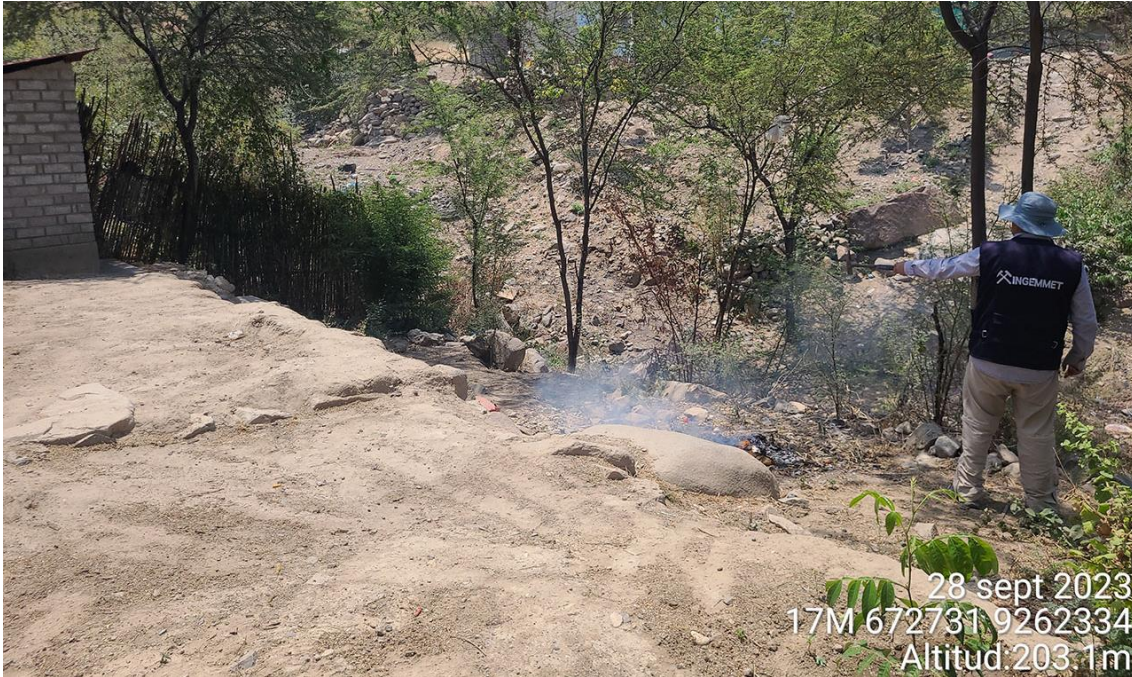
Fotografía 45. Zona crítica 14-014, flujo de detritos en la localidad de Malpaso que podría afectar 2 viviendas y 15 m de un canal de regadío próximos. Coordenadas E: 672700; N:9262400. (28/09/23).
