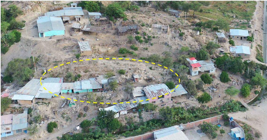
Fotografía 105. Zona crítica 14-074, Caída de rocas en la localidad de Collique Bajo que podría afectar 4 viviendas. Coordenadas E: 658860; N:9245095. (20/09/23).
