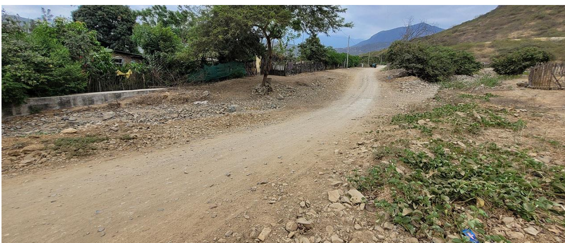
Fotografía 56. Zona crítica 14-025, flujo de detritos en la localidad de Magin que podría afectar 2 viviendas y 50m de la vía LA-740. Coordenadas E: 682638; N:9270992. (27/09/23).
