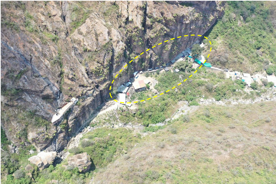
Fotografía 176. Zona crítica 14-145, Caída de rocas en la localidad de Cerro Chalpón que podría afectar 15 viviendas y puestos comerciales. Coordenadas E: 639761; N:9327225. (11/09/23).
