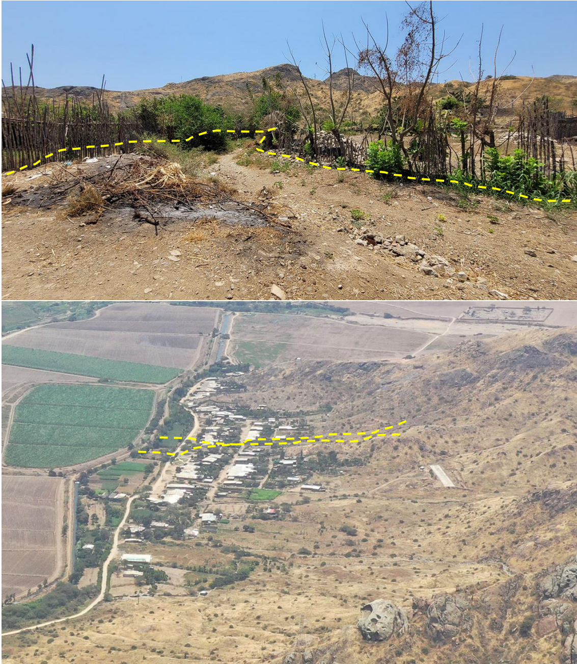
Fotografía 35. Zona crítica 14-004, flujo de detritos en la localidad de Boca de Tigre que podría afectar 5 viviendas. Coordenadas E: 669922; N:9255541. (28/09/23).
