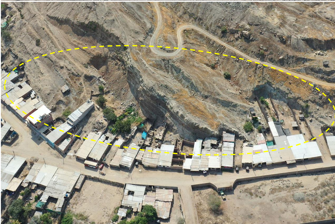
Fotografía 102. Zona crítica 14-071, Caída de rocas en la localidad de Cerro Corvacho que podría afectar 10 viviendas. Coordenadas E: 656882; N:9234637. (20/09/23).
