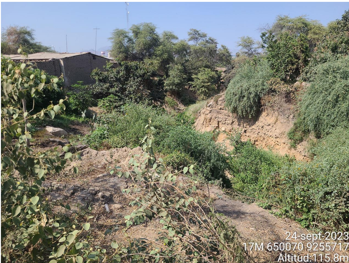
Fotografía 111. Zona crítica 14-080, flujo de detritos en la localidad de El Cinto - Pasope Alto que podría afectar 100 m de un canal de riego y 60 m de la vía LA-735 y 4 viviendas. Coordenadas E: 650061; N:9255720. (24/09/23).
