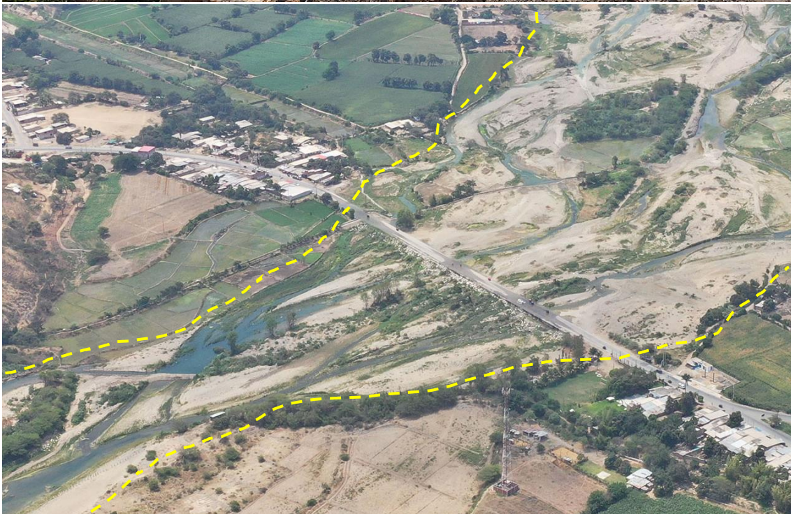
Fotografía 48. Zona crítica 14-017, flujo de detritos en la localidad de Quebrada Magin - Juana Ríos que podría afectar 320 m de badén en la vía PE-06A y 7 viviendas. Coordenadas E: 676524; N:9266806. (28/09/23).
