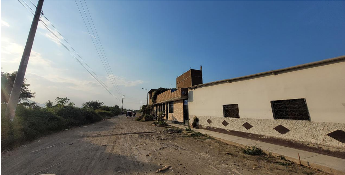
Fotografía 106. Zona crítica 14-075, inundación pluvial en la localidad de Bagazos que podría afectar 8 viviendas. Coordenadas E: 658481; N:9237840. (20/09/23).
