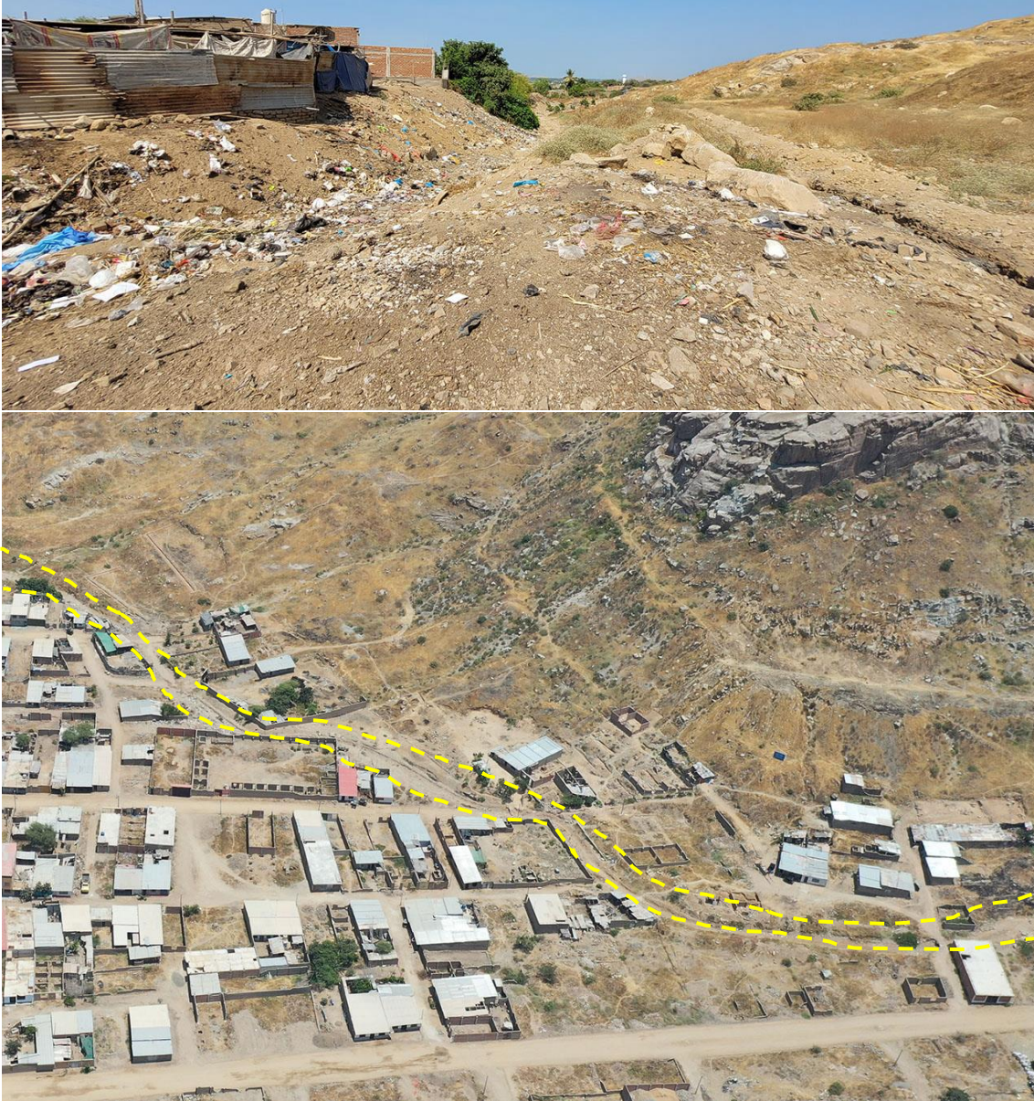
Fotografía 112. Zona crítica 14-081, flujo de detritos en la localidad de Pátapo (Quebrada Almendra) que podría afectar 9 viviendas. Coordenadas E: 651058; N:9255827. (24/09/23).
