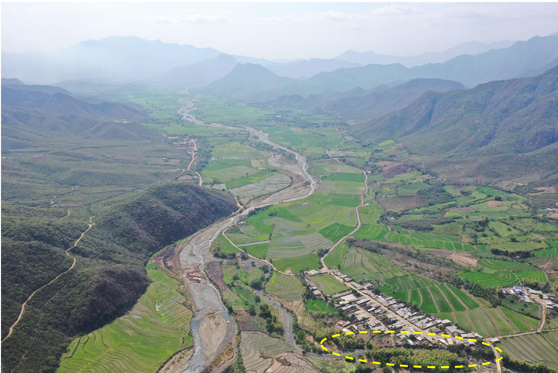
Fotografía 83. Zona crítica 14-052, erosión fluvial en la localidad de Espinal que podría afectar 1 puente de la vía PE-1NI y 7 viviendas. Coordenadas E: 698671; N:9245798. (22/09/23).
