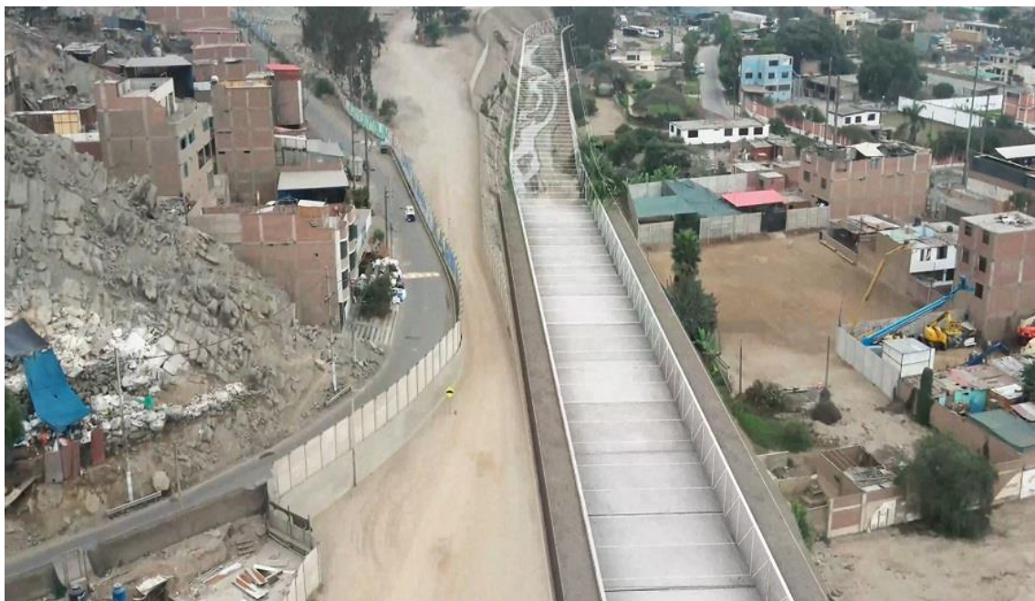
Fotografía 205. Canalización de una quebrada en los márgenes de un sector urbano.
