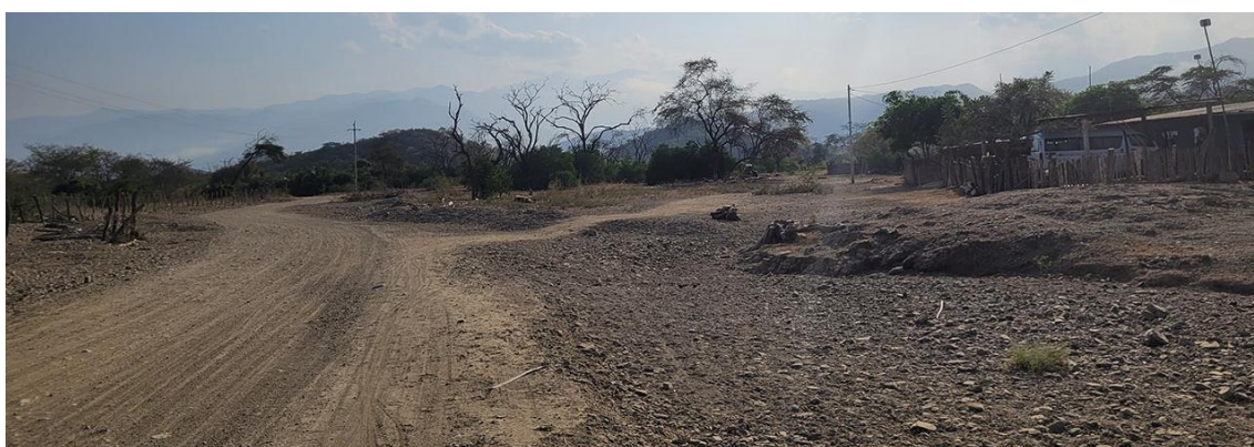
Fotografía 188. Zona crítica 14-157, flujo de detritos en la localidad de El Pueblito que podría afectar 450 m de la vía LA-506 y 3 viviendas. Coordenadas E: 640433; N:9347057. (10/09/23).
