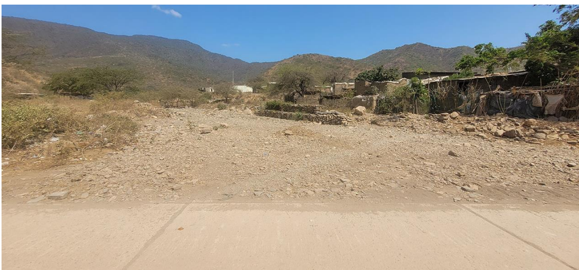
Fotografía 148. Zona crítica 14-117, flujo de detritos en la localidad de La Libertad-Qda. Seca que podría afectar 20 m de la vía LA-103 y 5 viviendas próximas. Coordenadas E: 666869; N:9293140. (13/09/23).
