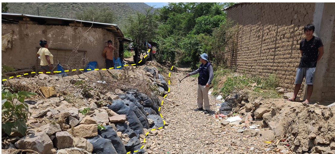
Figura 26. Flujo de detritos canalizado en el sector urbano de Oyotún, Oyotún (ZC 14-045), se aprecia una defensa hecha con sacos y rocas (en amarillo).
