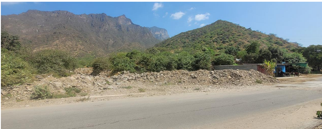
Fotografía 143. Zona crítica 14-112, flujo de detritos en la localidad de La Traposa- Mayascón que podría afectar 15 m de la vía LA-103, 1 badén y 2 viviendas. Coordenadas E: 659338; N:9290465. (13/09/23).
