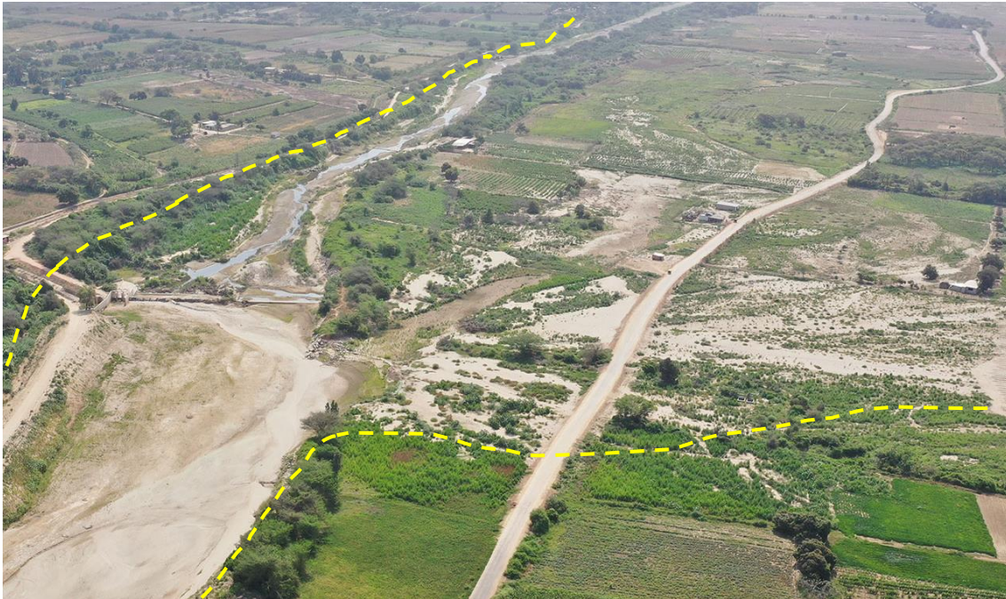
Fotografía 193. Zona crítica 14-162, inundación fluvial en la localidad de Las Juntas Baja que podría afectar 5 viviendas y 15 ha de terrenos de cultivos. Coordenadas E: 624277; N:9286923. (14/09/23).
