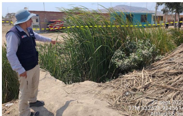
Figura 35. Inundación fluvial por desborde de canal de riego en mal estado en la localidad de San Pablo, Pomalca (ZC 14-088), la altura de inundación se delimita en amarillo.
