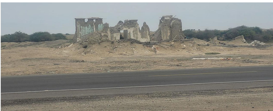
Fotografía 181. Zona crítica 14-150, inundación fluvial en la localidad de Vía Lambayeque- Piura que podría afectar 50 m de la vía PE-1N y 5 viviendas. Coordenadas E: 575935; N:9305904. (08/09/23).
