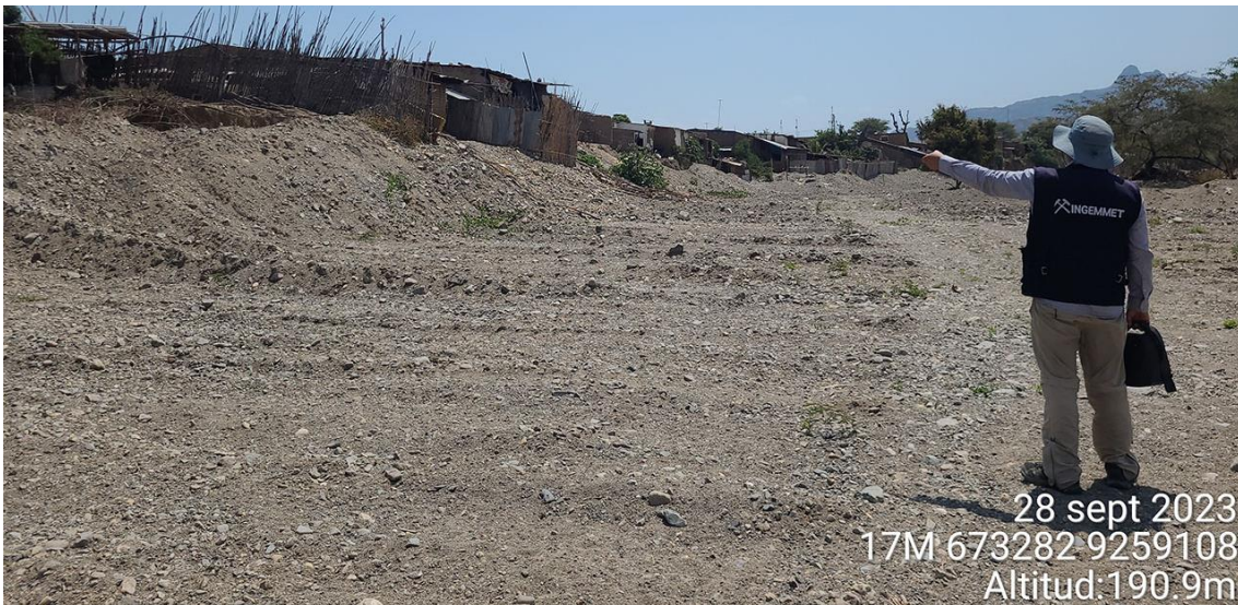
Fotografía 37. Zona crítica 14-006, erosión fluvial en la localidad de Tablazos que podría afectar 15 viviendas. Coordenadas E: 673443; N:9259169. (28/09/23).
