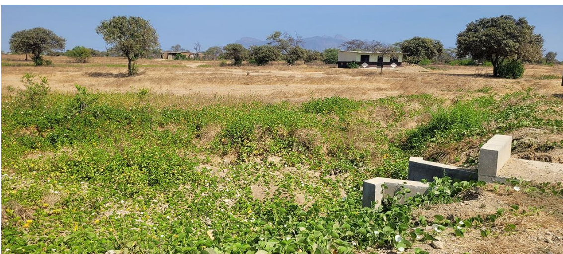
Fotografía 166. Zona crítica 14-135, inundación fluvial en la localidad de Noria Nueva que podría afectar 1 alcantarilla de la vía LA-541 y 4 viviendas. Coordenadas E: 641592; N:9302772. (15/09/23).
