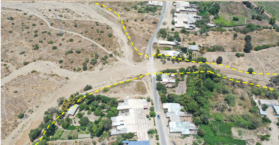
Fotografía 33. Zona crítica 14-002, flujo de detritos en la localidad de Pampa Grande que podría afectar 3 viviendas, 1 badén de la vía LA-116 y 20 m de un canal de regadío. Coordenadas E: 667583; N:9252707. (28/09/23).
