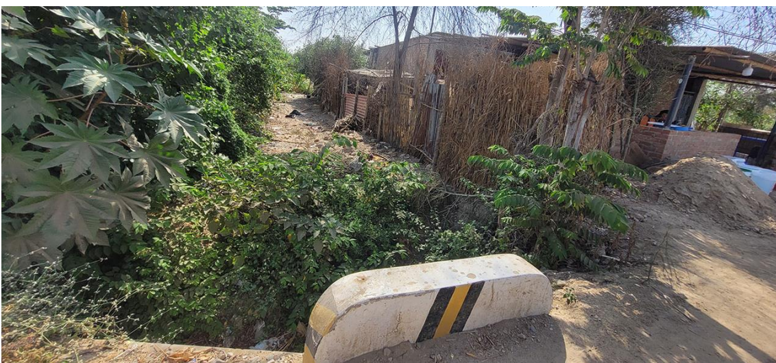
Fotografía 157. Zona crítica 14-126, inundación fluvial en la localidad de Íllimo que podría afectar 2 viviendas. Coordenadas E: 626509; N:9285073. (14/09/23).
