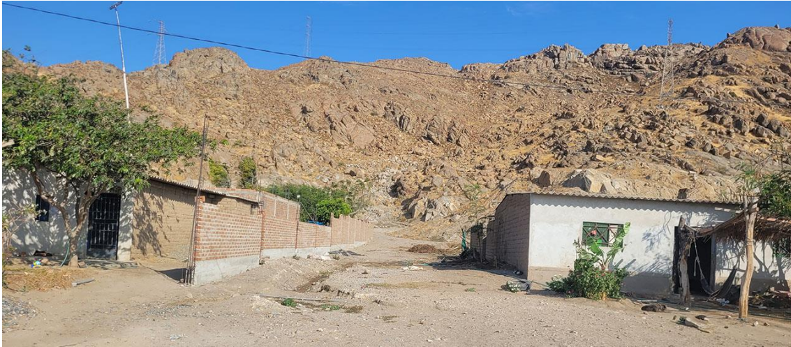
Fotografía 95. Zona crítica 14-064, flujo de detritos en la localidad de Nuevo Paraíso que podría afectar 3 viviendas. Coordenadas E: 634291; N:9243577. (19/09/23).
