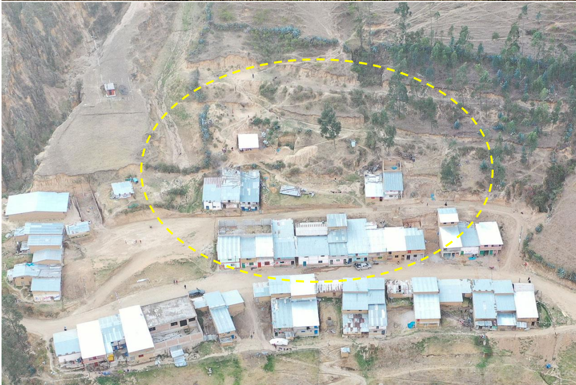
Fotografía 130. Zona crítica 14-099, deslizamiento rotacional en la localidad de Huayabamba que podría afectar 0.2 ha de terrenos de cultivos y 13 viviendas del sector urbano de la localidad. Coordenadas E: 676978; N:9330589. (12/09/23).
