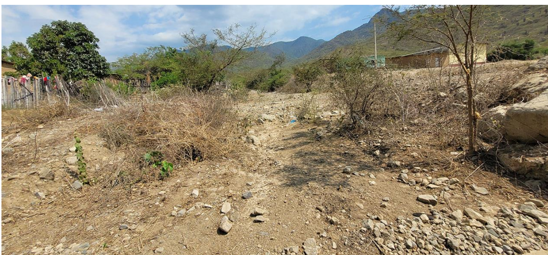
Fotografía 81. Zona crítica 14-050, flujo de detritos en la localidad de Viru que podría afectar 10 m de la vía LA-833 y 3 viviendas. Coordenadas E: 696468; N:9246260. (21/09/23).
