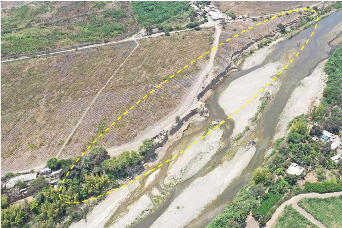
Fotografía 120. Zona crítica 14-089, erosión fluvial en la localidad de San Baltazar que podría afectar 12 viviendas y 100 m de una vía local. Coordenadas E: 652955; N:9249112. (26/09/23).
