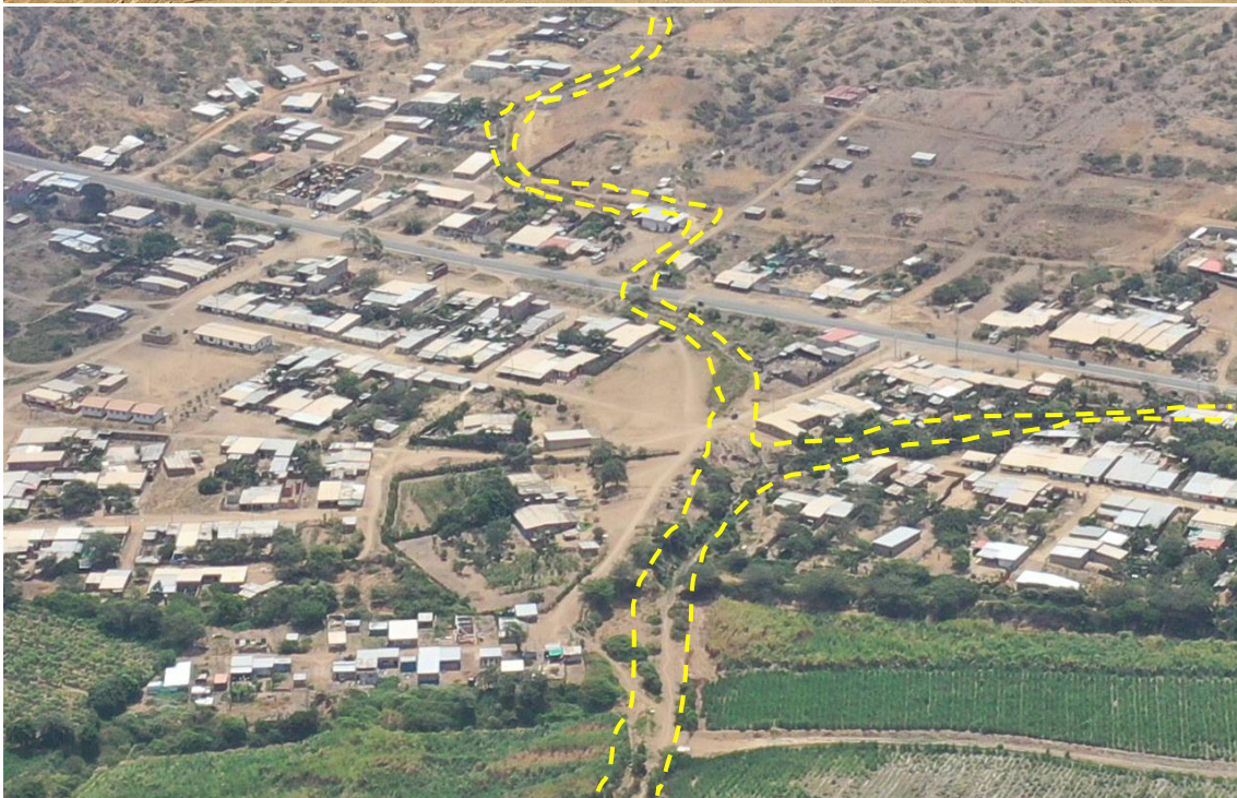
Fotografía 47. Zona crítica 14-016, flujo de detritos en la localidad de Piedra Parada que podría afectar 10 viviendas. Coordenadas E: 675534; N:9266050. (28/09/23).
