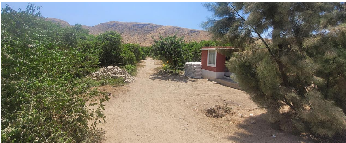
Fotografía 138. Zona crítica 14-107, flujo de detritos en la localidad de El Triunfo (Cerro Las Canteras) que podría afectar 200 m de la vía LA-698, 5 ha de cultivos y 1 vivienda. Coordenadas E: 647411; N:9258856. (17/09/23).
