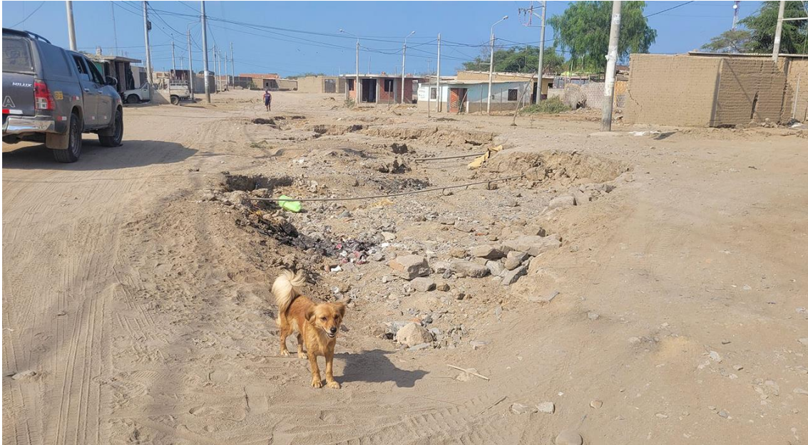
Fotografía 66. Zona crítica 14-035, inundación pluvial en la localidad de Nuevo Mocupe que podría afectar 10 viviendas. Coordenadas E: 649572; N:9228182. (20/09/23).
