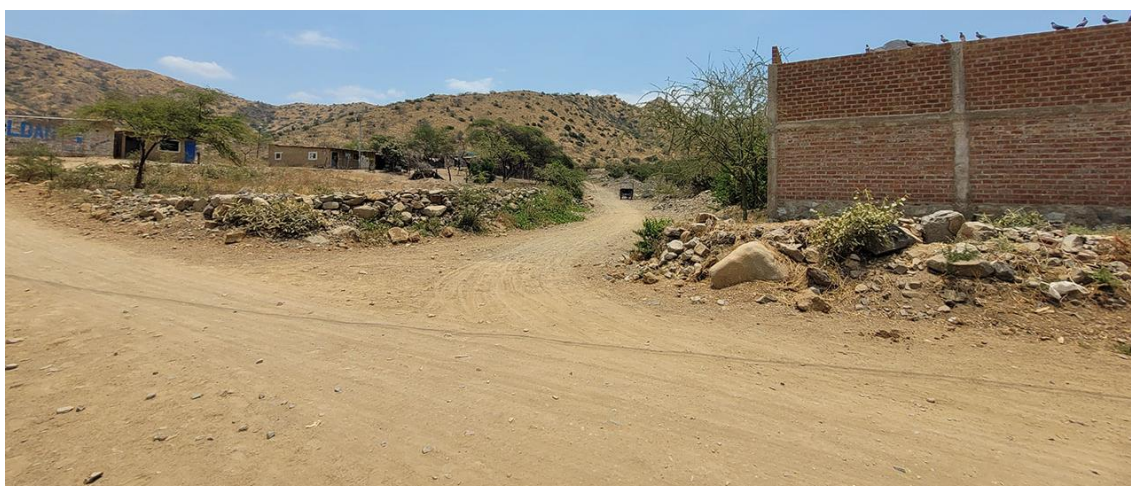
Fotografía 44. Zona crítica 14-013, flujo de detritos en la localidad de Los Algarrobos que podría afectar 3 viviendas, 30 m de una trocha carrozable y 0.5 ha de cultivos próximos. Coordenadas E: 671209; N:9261416. (27/09/23).
