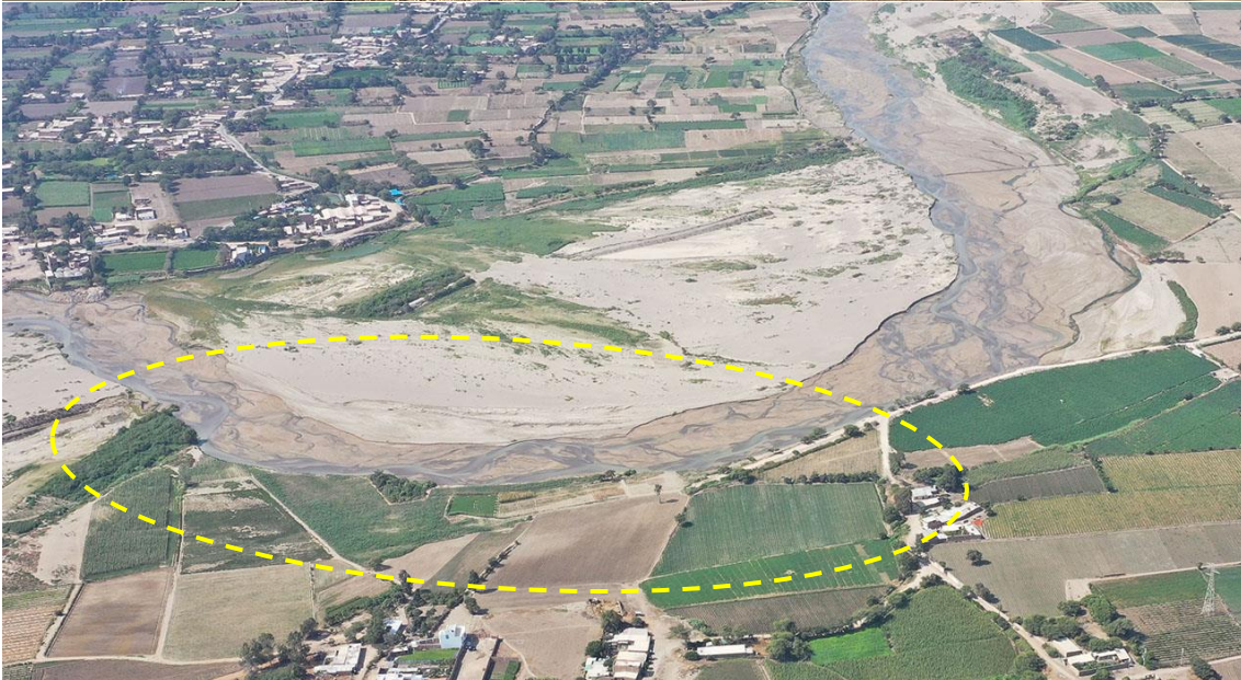
Fotografía 93. Zona crítica 14-062, inundación fluvial en la localidad de El Potrero que podría afectar 50 ha de terrenos de cultivos y 6 viviendas. Coordenadas E: 632056; N:9242565. (19/09/23).
