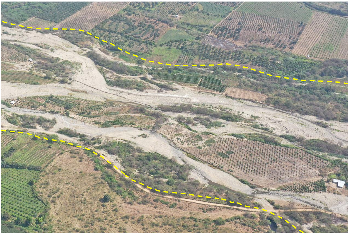
Fotografía 155. Zona crítica 14-124, inundación fluvial en la localidad de Las juntas que podría afectar 5 viviendas y 50 ha de terrenos de cultivos. Coordenadas E: 648937; N:9320878. (12/09/23).
