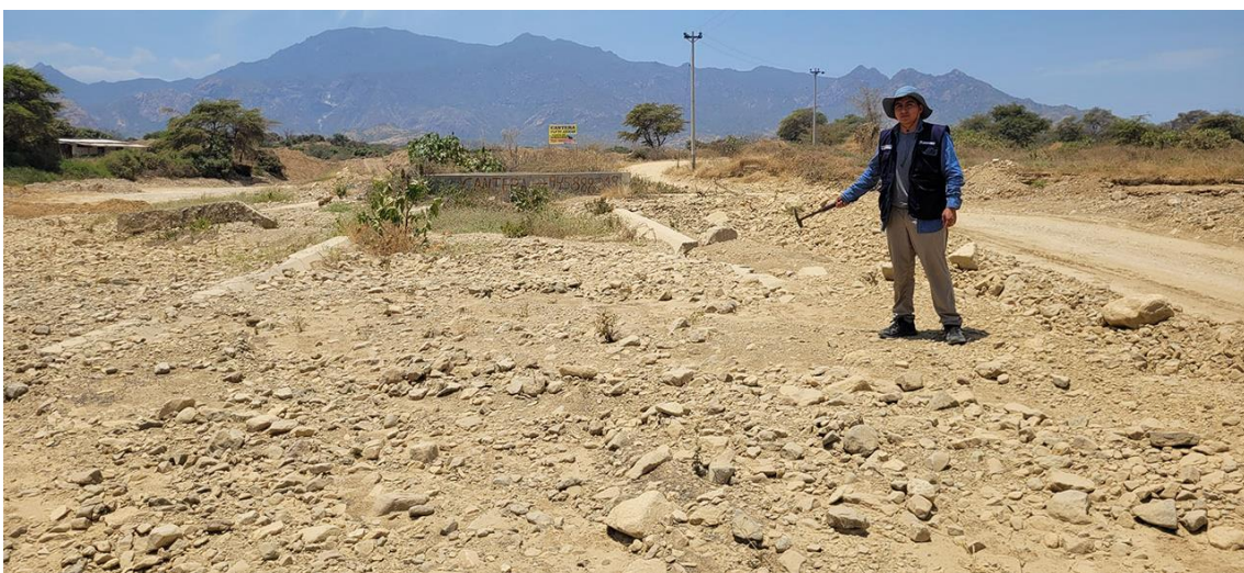
Fotografía 165. Zona crítica 14-134, flujo de detritos en la localidad de Pan de azúcar que podría afectar 200 m de la vía LA-559, 100 m de un canal y 2 vivienda próxima. Coordenadas E: 641731; N:9289253. (15/09/23).
