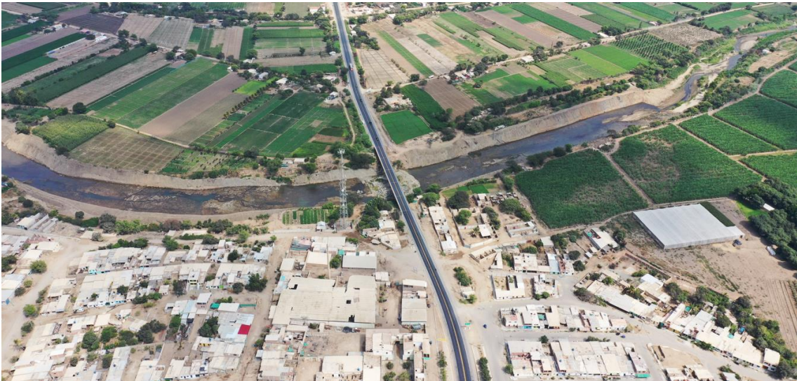
Fotografía 5. Río Zaña en la localidad de Mocupe, cuenca Zaña, Lagunas.
