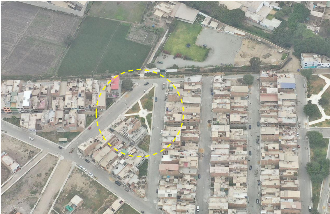
Fotografía 61. Zona crítica 14-030, inundación pluvial en la localidad de Villa León que podría afectar 20 viviendas. Coordenadas E: 626708; N:9248334. (19/09/23).
