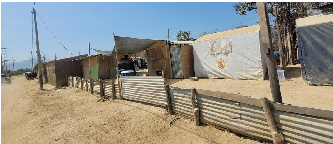
Fotografía 162. Zona crítica 14-131, inundación fluvial en la localidad de Cruce la Viña Víctor Raúl que podría afectar 20 viviendas y 150 de la vía LA-557. Coordenadas E: 633070; N:9296208. (15/09/23).
