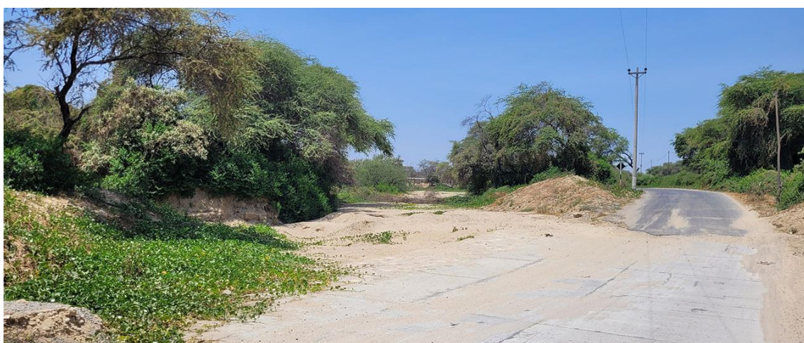
Fotografía 163. Zona crítica 14-132, flujo de detritos en la localidad de La Represa Laurel que podría afectar 25 m de la vía LA-559 y 3 viviendas. Coordenadas E: 638285; N:9293169. (15/09/23).
