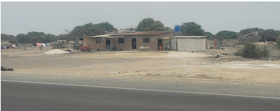
Fotografía 180. Zona crítica 14-149, inundación fluvial en la localidad de Vía Lambayeque- Piura que podría afectar 50 m de la vía PE-1N y 2 viviendas. Coordenadas E: 571912; N:9307623. (08/09/23).
