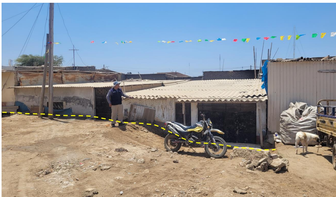
Figura 38. Localidad de Los Arenales de la Pradera, Pimentel (ZC 14-057), donde en los anteriores Fenómenos del Niño provocaron la inundación pluvial de decenas de viviendas, actualmente el terreno se ha levantado a fin de mitigar las inundaciones (material de relleno en amarillo).
