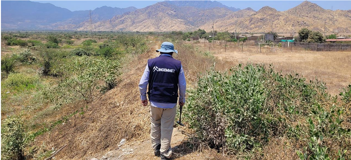
Fotografía 36. Zona crítica 14-005, flujo de detritos en la localidad de Wadington Alto que podría afectar 20 viviendas de colapsar el terraplén existente. Coordenadas E: 671650; N:9256960. (28/09/23).
