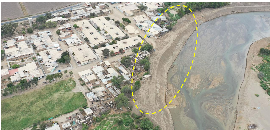
Fotografía 125. Zona crítica 14-094, erosión fluvial en la localidad de Rinconazo que podría afectar 11. Coordenadas E: 645924; N:9247030. (23/09/23).
