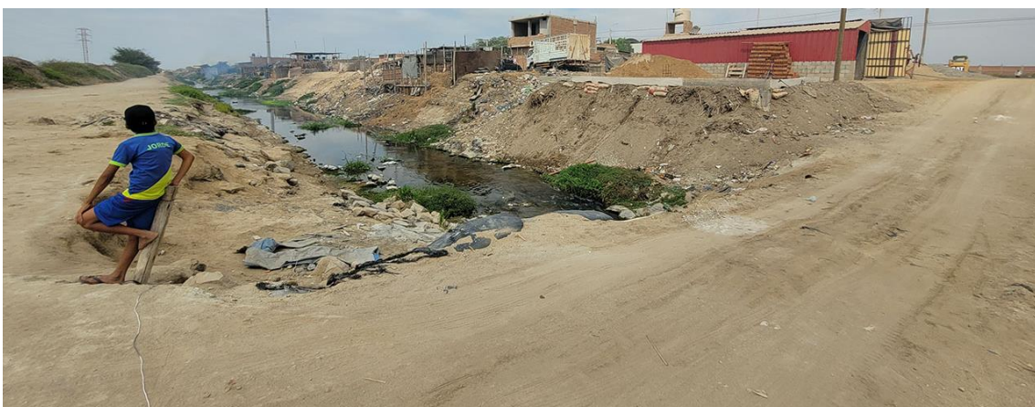
Fotografía 151. Zona crítica 14-120, erosión fluvial en la localidad de Demetrio Acosta Chuez que podría afectar 1 puente carrozable artesanal y 50 viviendas. Coordenadas E: 622271; N:9264674. (14/09/23).
