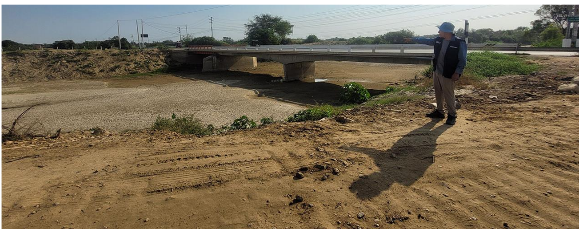
Fotografía 194. Zona crítica 14-163, inundación fluvial en la localidad de Las Juntas que podría afectar 1 vivienda, 1 puente de la vía PE-1NJ y 5 ha de terrenos de cultivos. Coordenadas E: 626626; N:9286790. (14/09/23).
