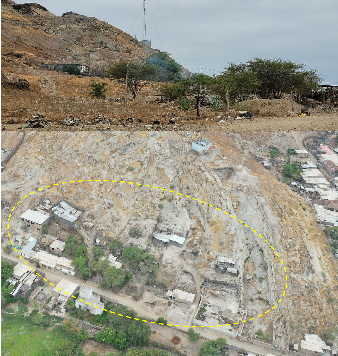
Fotografía 100. Zona crítica 14-069, Caída de rocas en la localidad de La Mariposa que podría afectar 3 viviendas. Coordenadas E: 651059; N:9246388. (23/09/23).
