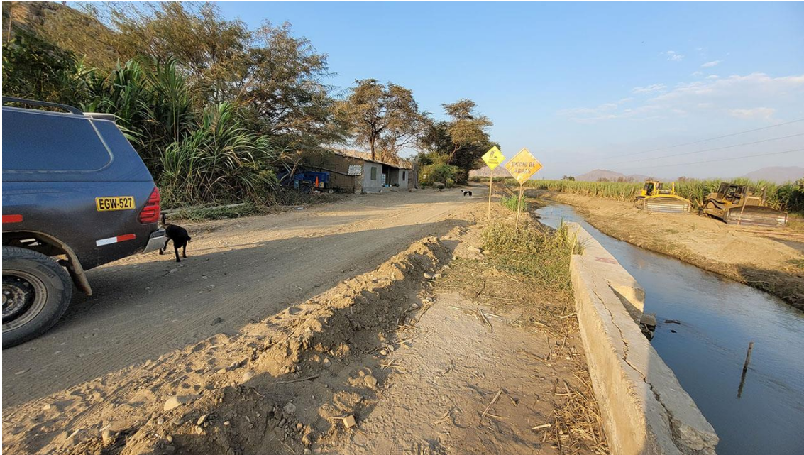
Fotografía 110. Zona crítica 14-079, inundación fluvial en la localidad de Toma y Canal Cayaltí que podría afectar 1 ha de cultivos, 50 m de una vía y 1 vivienda próxima. Coordenadas E: 667570; N:9237322. (21/09/23).
