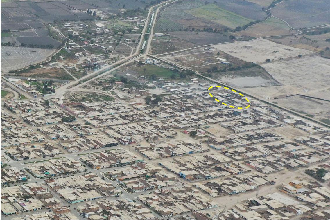
Fotografía 149. Zona crítica 14-118, inundación pluvial en la localidad de Pueblo Nuevo que podría afectar 10 viviendas. Coordenadas E: 632309; N:9265848. (16/09/23).
