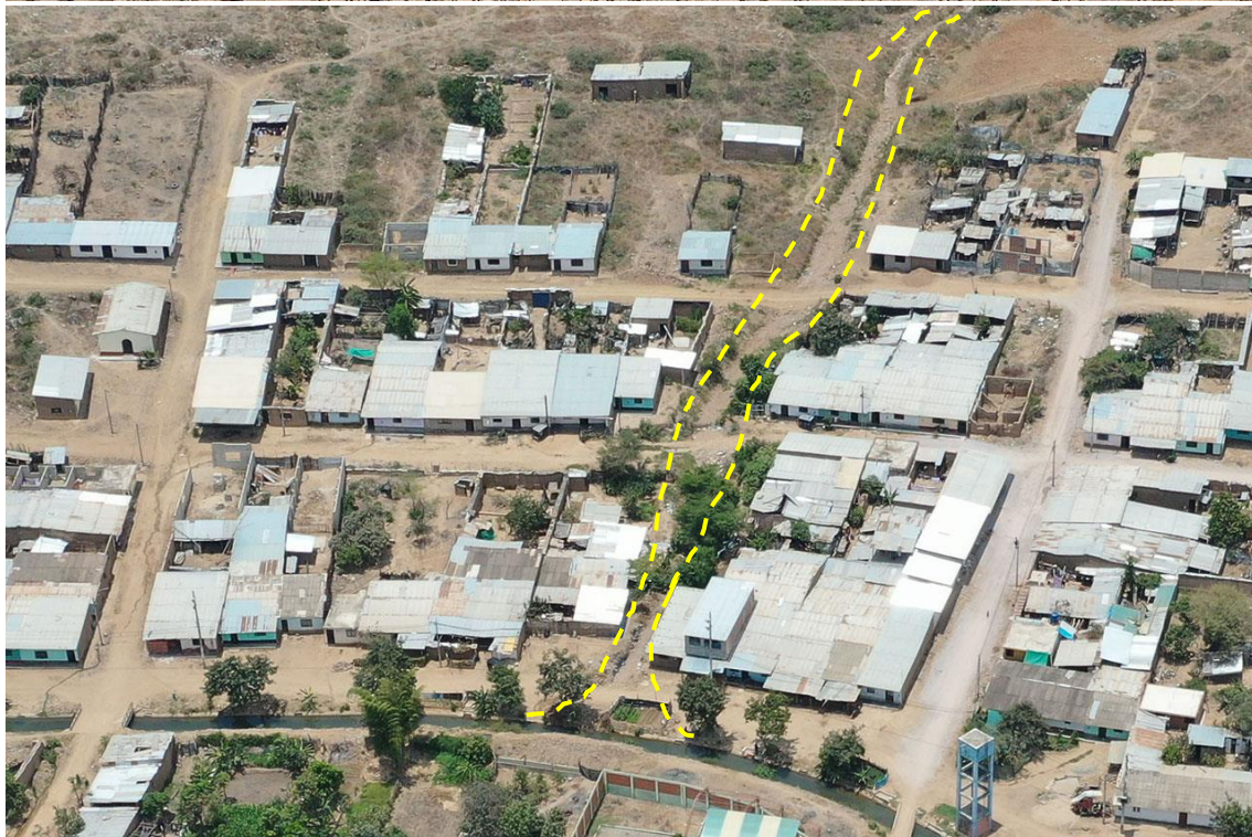
Fotografía 76. Zona crítica 14-045, flujo de detritos en la localidad de Quebrada San Juan que podría afectar 10 viviendas y 20 m de una vía. Coordenadas E: 688071; N:9243496. (21/09/23).
