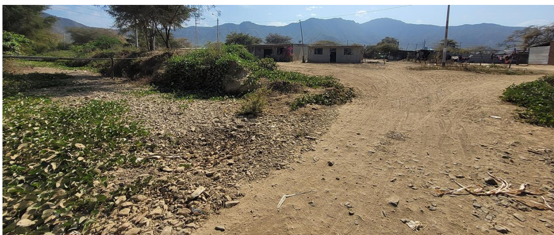
Fotografía 174. Zona crítica 14-143, flujo de detritos en la localidad de El Papayo que podría afectar 20 m de vías locales y 4 viviendas. Coordenadas E: 644660; N:9316706. (15/09/23).
