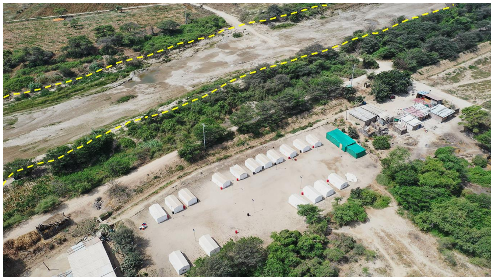
Figura 34. Inundación fluvial en la localidad de Nuevo San Isidro, Pacora (ZC 14-161), donde el 2023 el río Motupe desbordó su cauce (delimitado en amarillo) y afectó terrenos de cultivo, viviendas y vías.
