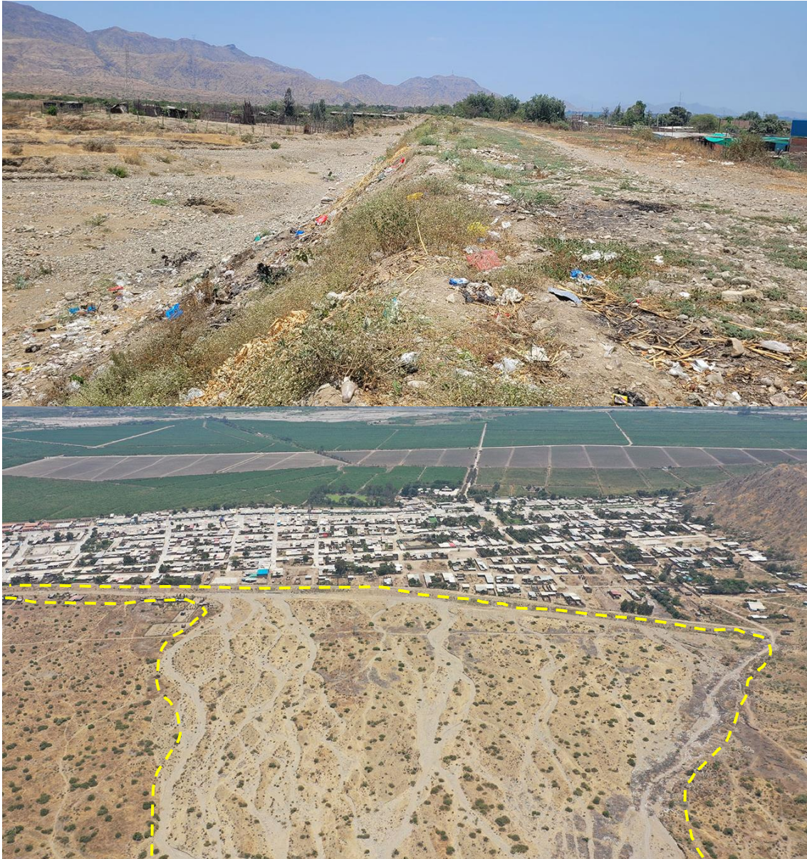
Fotografía 34. Zona crítica 14-003, flujo de detritos en la localidad de Pampa Grande que podría afectar 8 viviendas, de colapsar el terraplén gran parte del sector urbano se vería afectado. Coordenadas E: 668188; N:9253547. (28/09/23).
