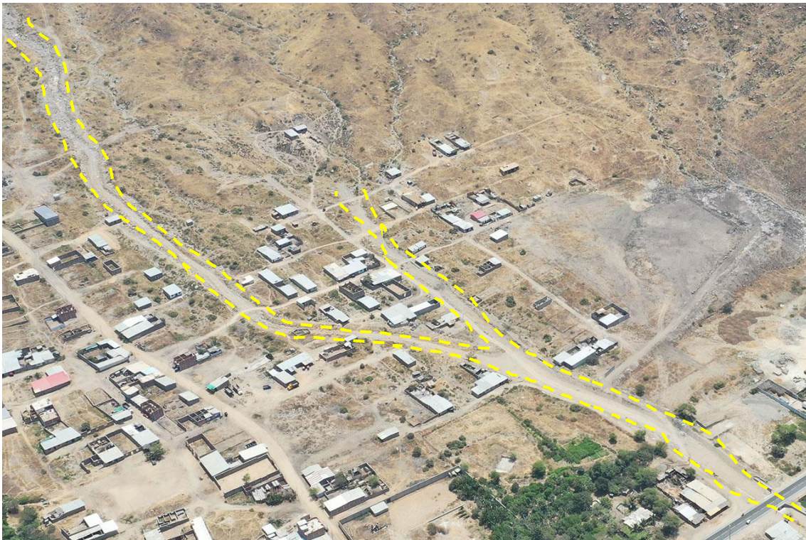
Fotografía 115. Zona crítica 14-084, flujo de detritos en la localidad de Pátapo (Quebrada La Primavera) que podría afectar 4 viviendas. Coordenadas E: 652186; N:9255729. (24/09/23).
