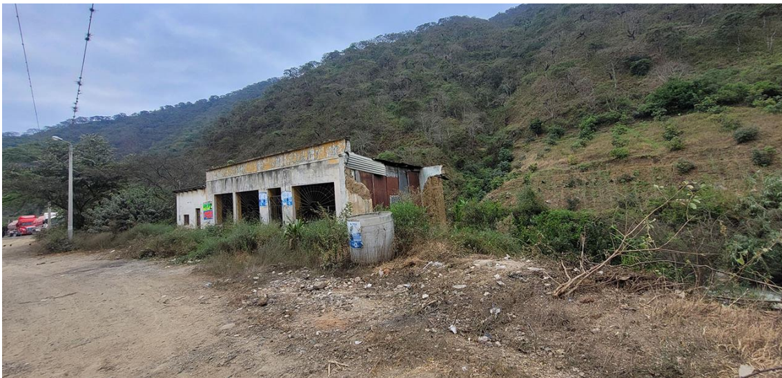
Fotografía 199. Zona crítica 14-168, erosión fluvial en la localidad de Olmos - Abra Porcuya que podría afectar 150 m de la vía PE-04B y 2 viviendas. Coordenadas E: 655820; N:9343787. (09/09/23).
