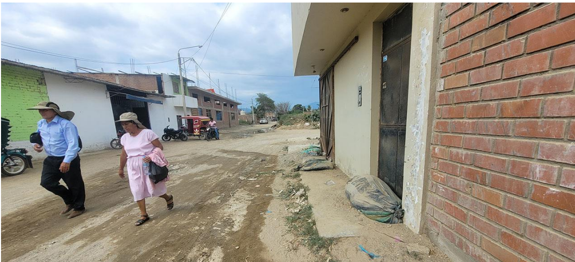
Fotografía 184. Zona crítica 14-153, flujo de detritos en la localidad de San Pedro que podría afectar 20 viviendas. Coordenadas E: 638099; N:9337973. (10/09/23).
