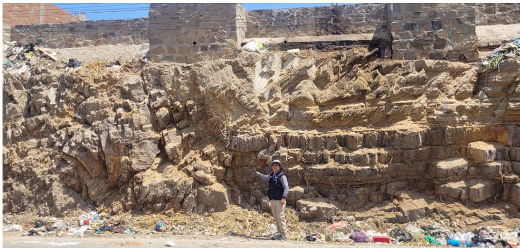
Fotografía 14. Macizo rocoso de areniscas muy fracturadas y altamente meteorizadas del Grupo Goyllarisquizga en la vía PE-1N. Coordenadas E: 624507; N: 9251707 (18/09/2023).
