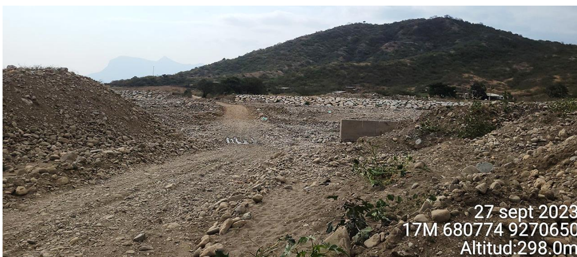
Fotografía 52. Zona crítica 14-021, flujo de detritos en la localidad de Magin que podría afectar 600 m de una trocha carrozable, 800 m de un canal y 6 viviendas. Coordenadas E: 680819; N:9270854. (27/09/23).
