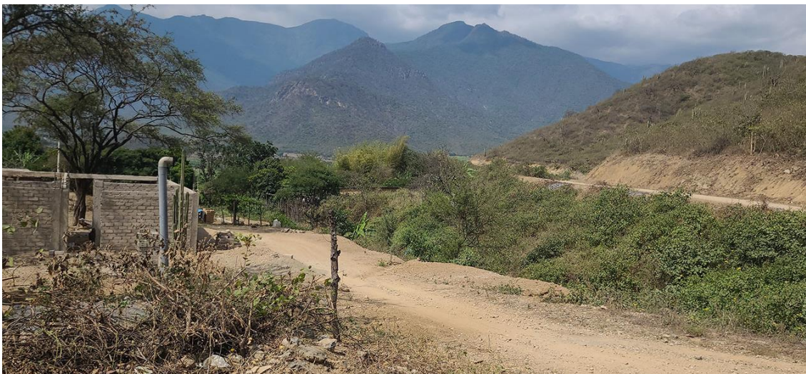
Fotografía 80. Zona crítica 14-049, flujo de detritos en la localidad de Sorronto Viru que podría afectar 10 m de la vía LA-833 y 2 viviendas. Coordenadas E: 695750; N:9246007. (21/09/23).
