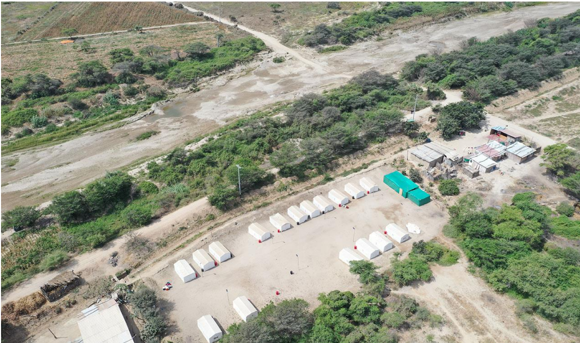
Fotografía 192. Zona crítica 14-161, inundación fluvial en la localidad de Nuevo San Isidro que podría afectar 17 viviendas y 10 ha de terrenos de cultivos. Coordenadas E: 621414; N:9287745. (14/09/23).
