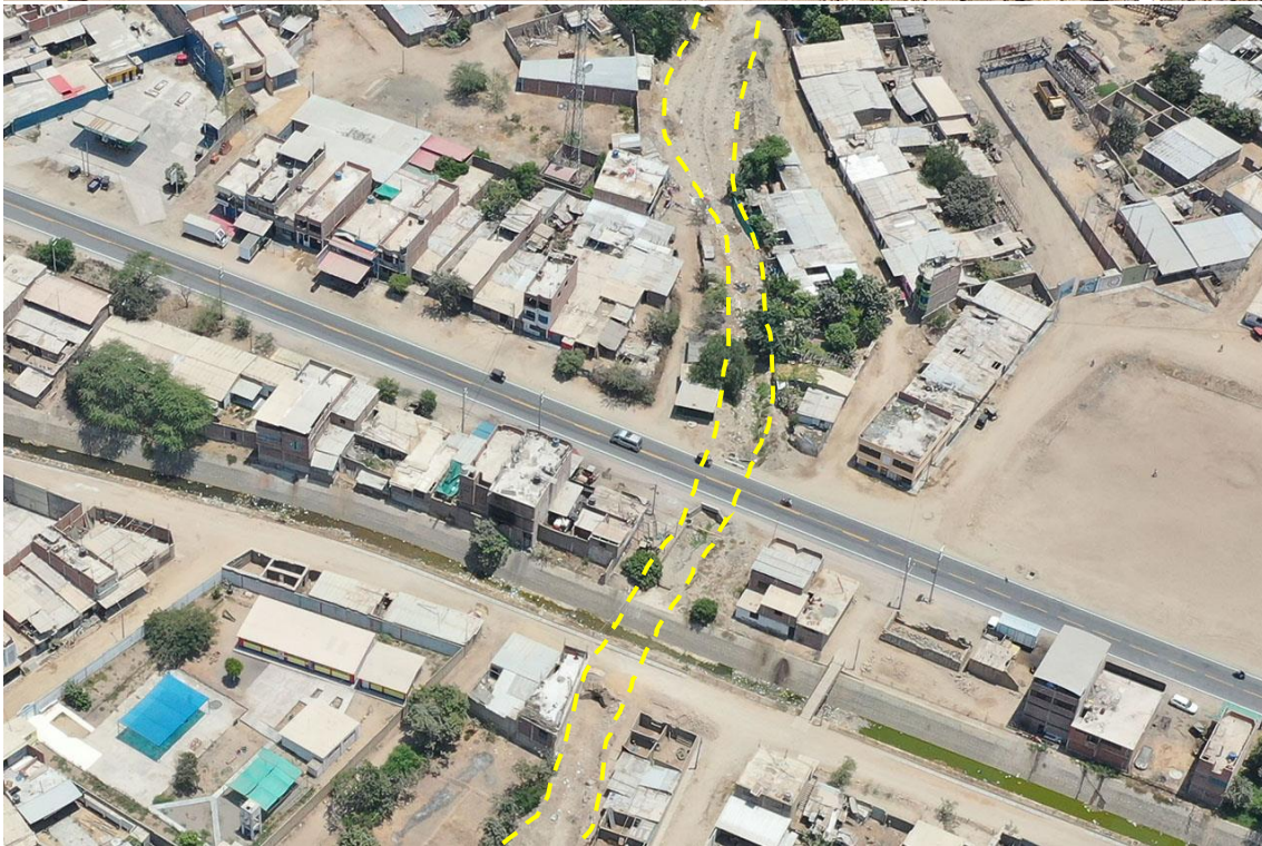
Fotografía 114. Zona crítica 14-083, flujo de detritos en la localidad de Pátapo (Quebrada Santa Lucía) que podría afectar 10 vivienda. Coordenadas E: 651601; N:9255309. (24/09/23).
