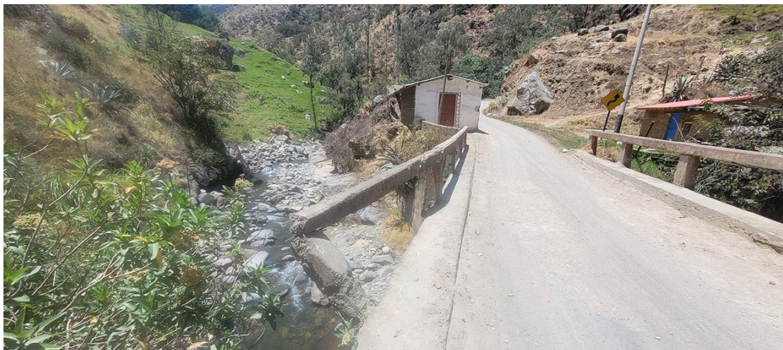
Fotografía 135. Zona crítica 14-104, flujo de detritos en la localidad de Pagaypuente que podría afectar 1 puente de la vía LA-104 y 5 viviendas. Coordenadas E: 681838; N:9309928. (13/09/23).
