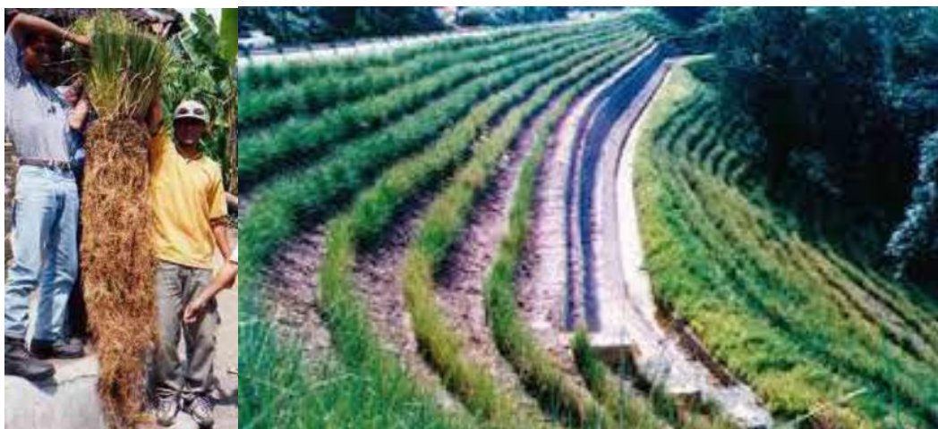
Fotografía 204. Ejemplo de bioingeniería con arbusto (vetiver) en taludes de materiales sueltos.
