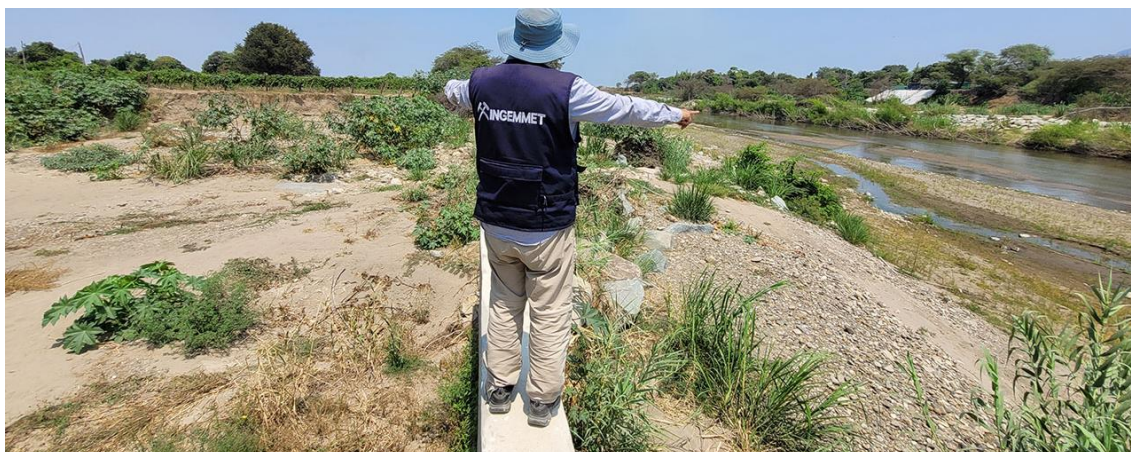
Fotografía 121. Zona crítica 14-090, erosión fluvial en la localidad de La Vega Cholocal que podría afectar 1 bocatoma y 7 viviendas. Coordenadas E: 656360; N:9250706. (26/09/23).
