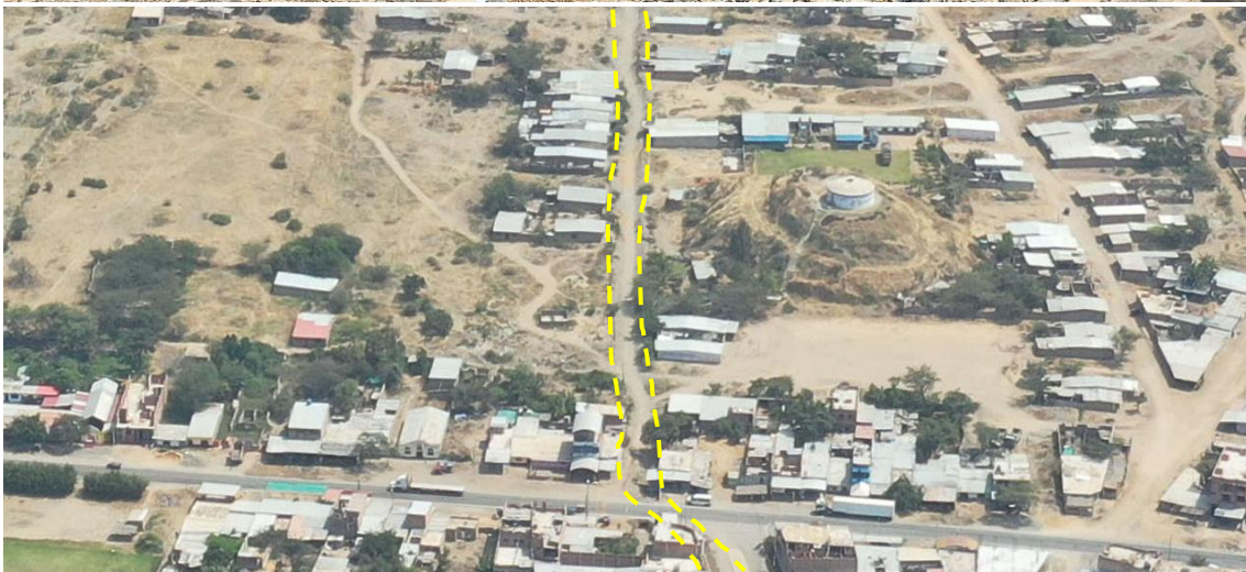
Fotografía 117. Zona crítica 14-086, flujo de detritos en la localidad de La Cría que podría afectar 4 viviendas y 1 alcantarilla de la vía PE-06A. Coordenadas E: 661143; N:9255225. (24/09/23).
