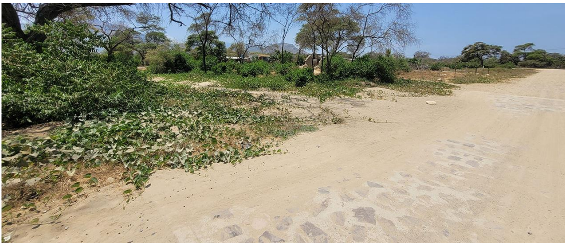
Fotografía 164. Zona crítica 14-133, flujo de detritos en la localidad de El Marco que podría afectar 15 m de la vía LA-559 y 4 viviendas. Coordenadas E: 639057; N:9291135. (15/09/23).
