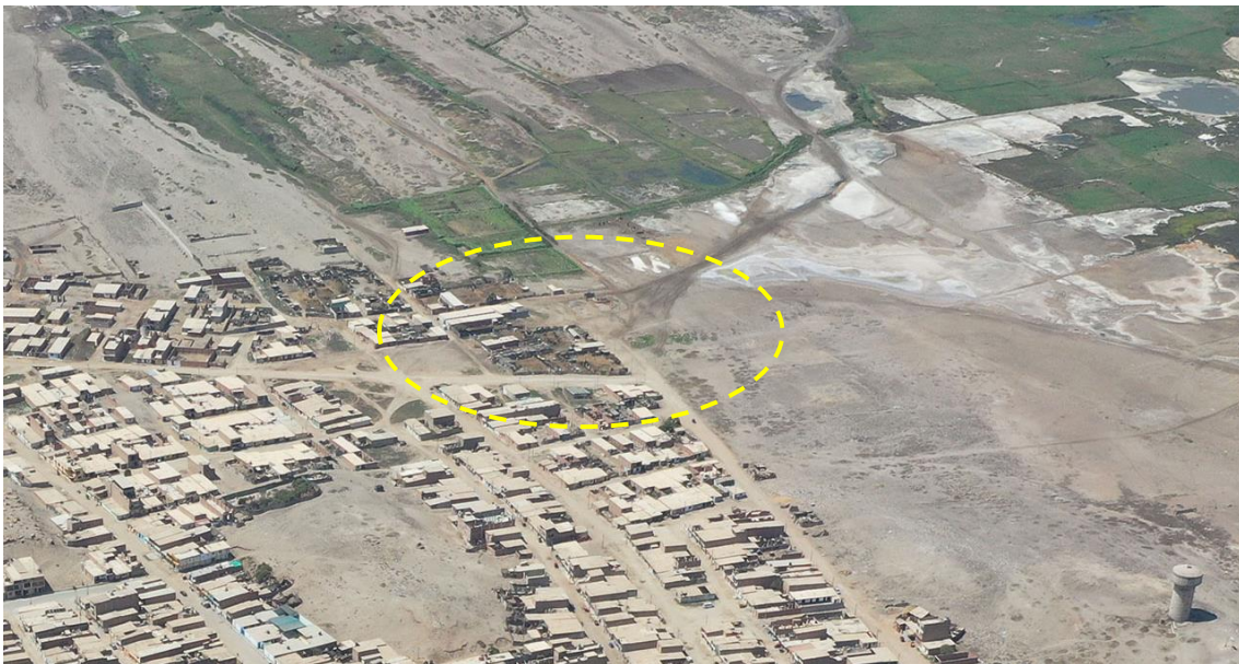
Fotografía 200. Zona crítica 14-169, inundación fluvial en la localidad de San José que podría afectar 10 viviendas, 2 ha de terrenos de cultivos y 50 viviendas del sector urbano. Coordenadas E: 614403; N:9252273. (18/09/23).
