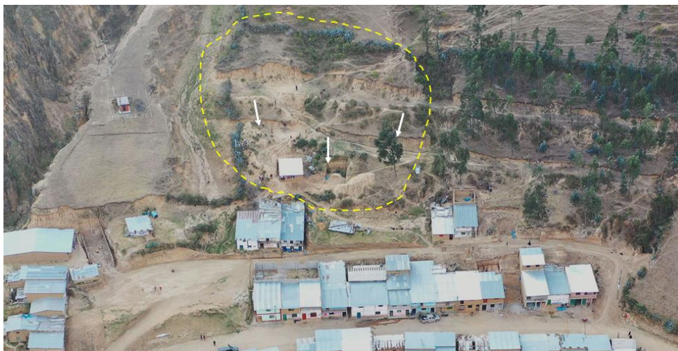
Figura 20. Delimitación del deslizamiento rotacional de Huayabamba, Cañarís (ZC 14-099) con posible afectación al sector urbano de la localidad.
