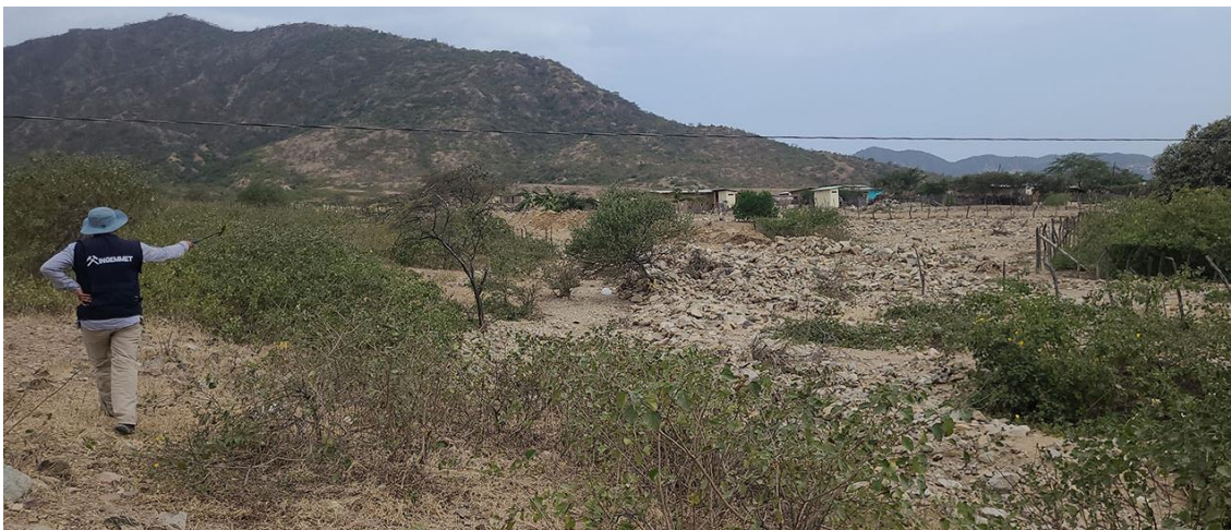
Fotografía 54. Zona crítica 14-023, flujo de detritos en la localidad de Magin que podría afectar 10 viviendas y 90 m de la vía LA-740. Coordenadas E: 681535; N:9269908. (27/09/23).
