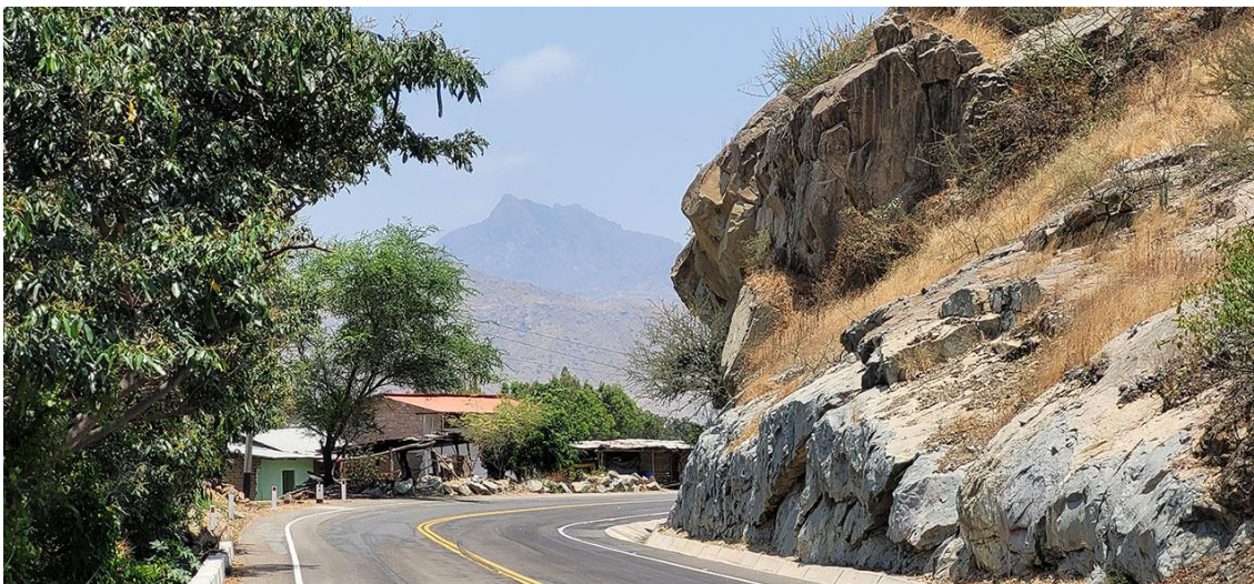
Fotografía 40. Zona crítica 14-009, Caída de rocas en la localidad de La Puntilla que podría afectar 100 m de la vía PE-06A y 2 viviendas. Coordenadas E: 665941; N:9255018. (28/09/23).
