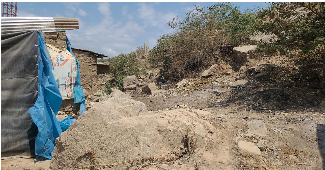
Fotografía 77. Zona crítica 14-046, Caída de rocas en la localidad de Las Delicias que podría afectar 4 viviendas y 15 m de la vía PE-1NI. Coordenadas E: 688592; N:9246585. (21/09/23).
