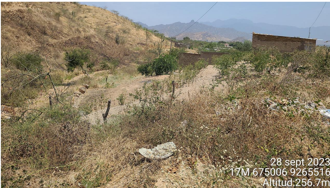
Fotografía 46. Zona crítica 14-015, flujo de detritos en la localidad de Zapotal Tinajones que podría afectar 1 alcantarilla de la vía PE-06A y 5 viviendas. Coordenadas E: 675006; N:9265516. (28/09/23).
