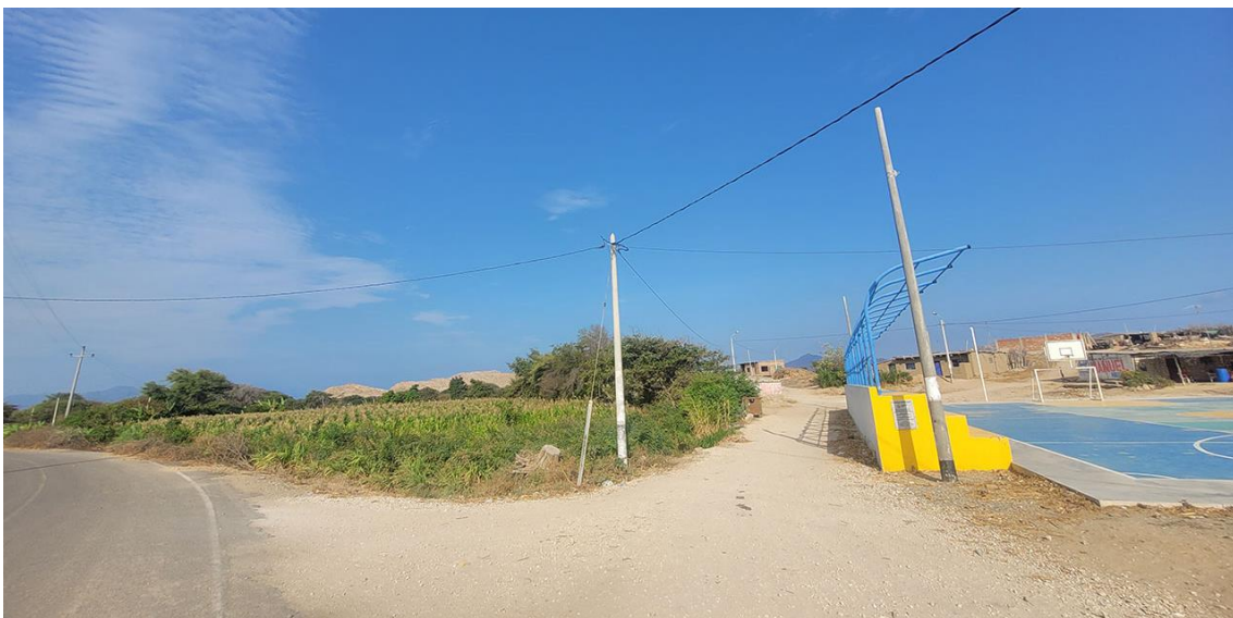
Fotografía 97. Zona crítica 14-066, flujo de detritos en la localidad de La Calera que podría afectar 120 m de la vía LA-808 y 2 viviendas. Coordenadas E: 637769; N:9245497. (19/09/23).
