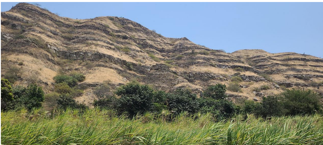
Fotografía 41. Zona crítica 14-010, Caída de rocas en la localidad de Garraspiña que podría afectar 3 viviendas. Coordenadas E: 667854; N:9257511. (27/09/23).
