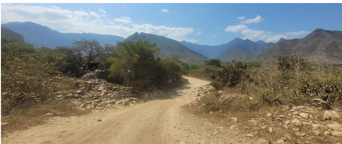
Fotografía 145. Zona crítica 14-114, flujo de detritos en la localidad de La Calzada que podría afectar 20 m de la vía LA-103, 1 badén y 3 viviendas próximas. Coordenadas E: 663440; N:9291955. (13/09/23).
