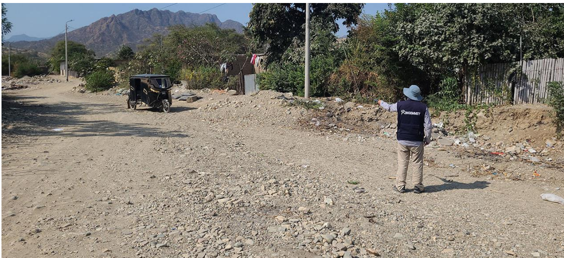
Fotografía 39. Zona crítica 14-008, flujo de detritos en la localidad de Huaca Blanca que podría afectar 10 viviendas. Coordenadas E: 680179; N:9263269. (28/09/23).
