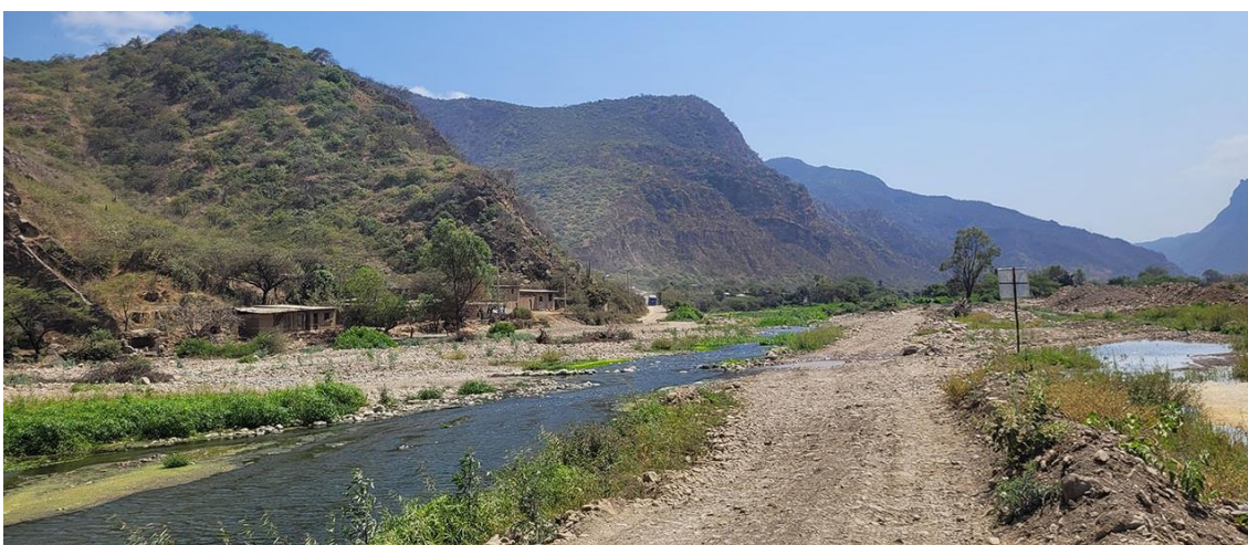
Fotografía 147. Zona crítica 14-116, flujo de detritos en la localidad de Mochumí Bajo-Mochumí Viejo que podría afectar 200 m de la vía LA-103 y 6 viviendas próximas. Coordenadas E: 665694; N:9291932. (13/09/23).
