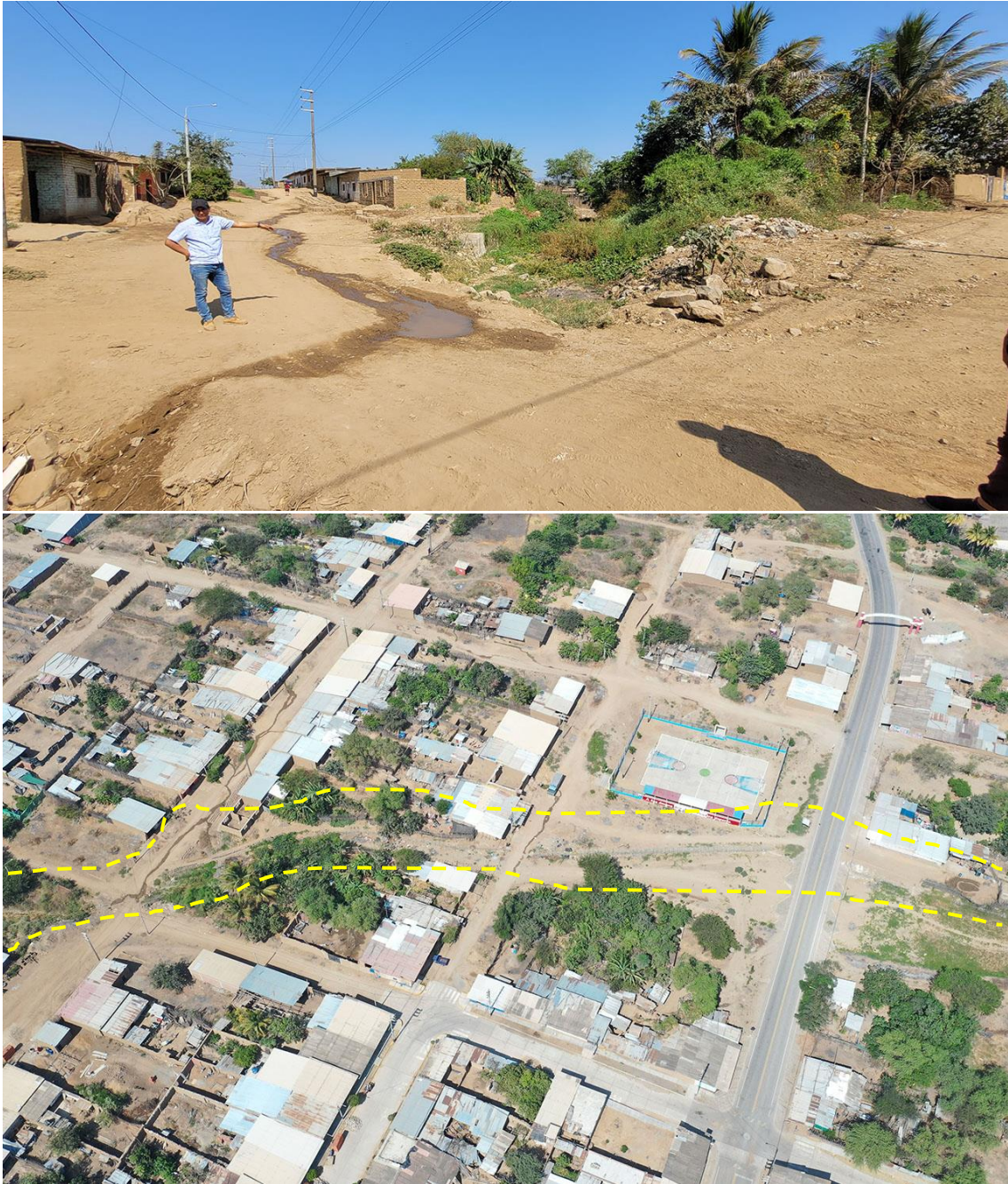
Fotografía 70. Zona crítica 14-039, flujo de detritos en la localidad de San Juan de Miraflores que podría afectar 5 viviendas. Coordenadas E: 682698; N:9239697. (22/09/23).
