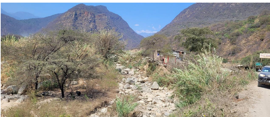
Fotografía 134. Zona crítica 14-103, flujo de detritos en la localidad de El Limón que podría afectar 200 m de la vía LA-103 y 2 viviendas. Coordenadas E: 672161; N:9296670. (13/09/23).
