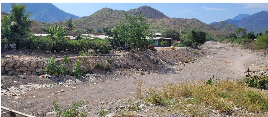
Fotografía 79. Zona crítica 14-048, flujo de detritos en la localidad de Macuaco - Quebrada Las Yeguas que podría afectar 1 puente de la vía PE-1NI y 4 viviendas al cauce de la quebrada. Coordenadas E: 694611; N:9247772. (22/09/23).
