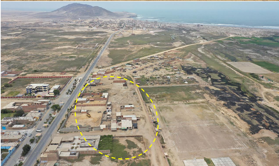
Fotografía 58. Zona crítica 14-027, inundación pluvial en la localidad de Capilla que podría afectar 15 viviendas. Coordenadas E: 625141; N:9235739. (19/09/23).
