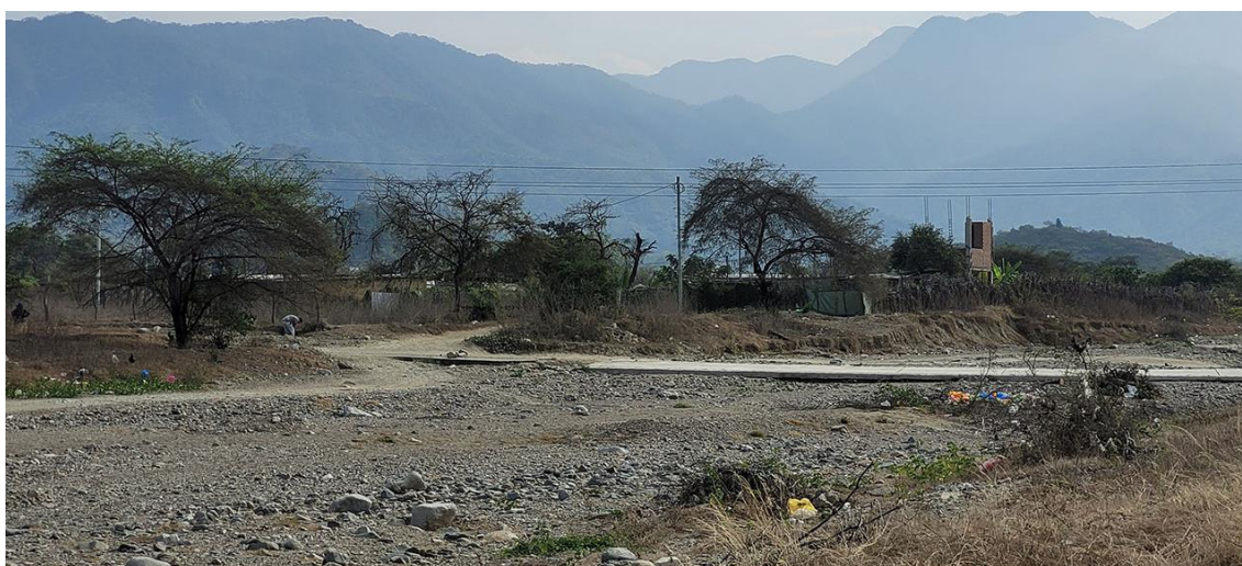
Fotografía 179. Zona crítica 14-148, flujo de detritos en la localidad de Tongorrape (La Capilla) que podría afectar 100 m, 2 badenes de la vía LA-520 y 4 viviendas. Coordenadas E: 646119; N:9330680. (11/09/23).
