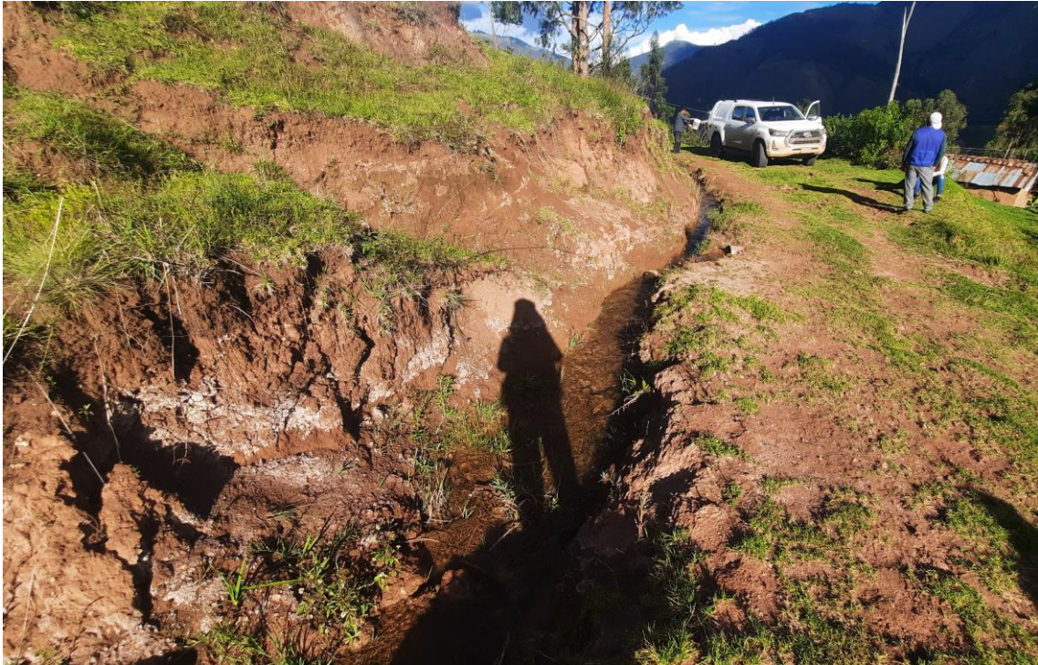
Fotografía 3. Saturación suelo da lugar a la reptación de suelos precursores de deslizamientos y flujo de lodo en la comunidad Barropata.
