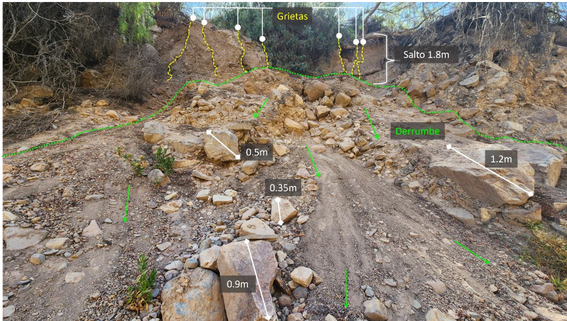
Figura 22. Se observa bloques del derrumbe con tamaños máximos de hasta 1.2 metros, grietas en la pared del salto del derrumbe en el sector de Aguasana Chico.
