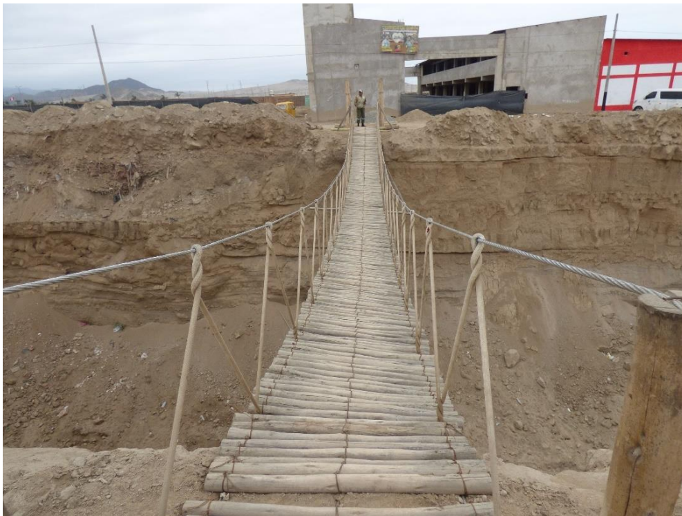
Fotografía 200. Zona crítica 15-069. Puente peatonal debilitado debido al flujo de detritos del 14/03/2023. Coordenadas UTM 18S E305142; N8638712 (Tomada el 04/09/2023).
