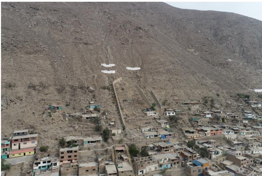
Fotografía 165. Zona crítica 15-051. Material superficial inconsolidado adosado en las laderas con erosión de laderas y torrenteras por donde puede generarse flujos de detritos y afectar viviendas de la A.H. Virgen del Rosario, se ha colocado muros de contención. Coordenadas UTM 18S E315912; N8679589 (tomada el 05/10/2023).
