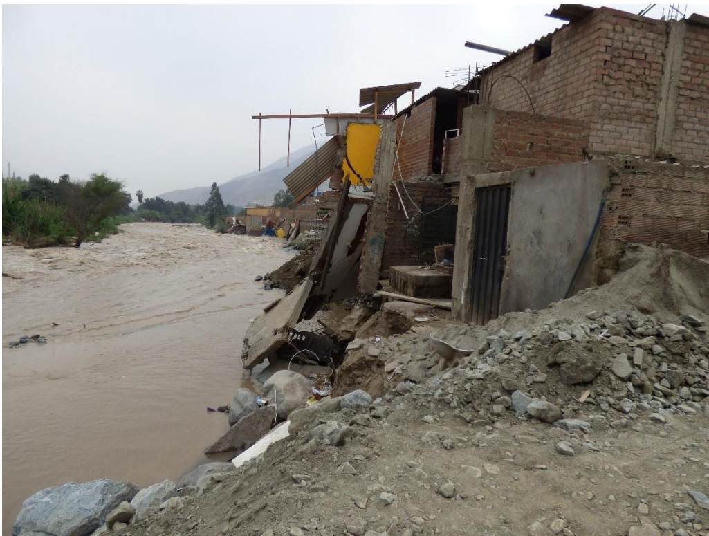
Fotografía 177. Zona crítica 15-055. Viviendas del sector Santa María de Campanillas afectadas por la erosión fluvial. Coordenadas UTM 18S E312527; N8678178 (Fuente: Ochoa et al., 2017).
