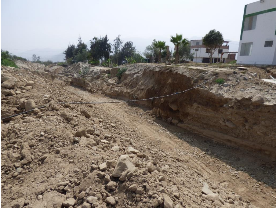
Fotografía 97. Zona crítica 15-025. Tras paso del flujo de lodo de la quebrada Tinajas afectó tuberías de agua, destruyó un parque en la margen derecha de la quebrada, en el sector Cooperativa de Salud y Pampa Tinajas. Coordenadas UTM 18S E302987; N8657168 (tomada el 08/09/2023).
