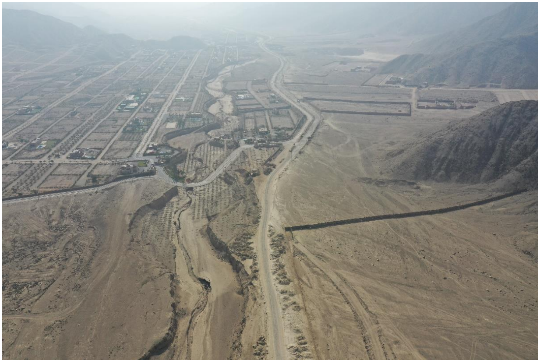
Fotografía 98. Zona crítica 15-025. Vista con dron de la parte media de la quebrada Tinajas, sector condominio Las Bahías que se encuentra en ambas márgenes, ancho de cauce 50 m. Coordenadas UTM 18S E308974; N8657792 (tomada el 28/10/2022).
