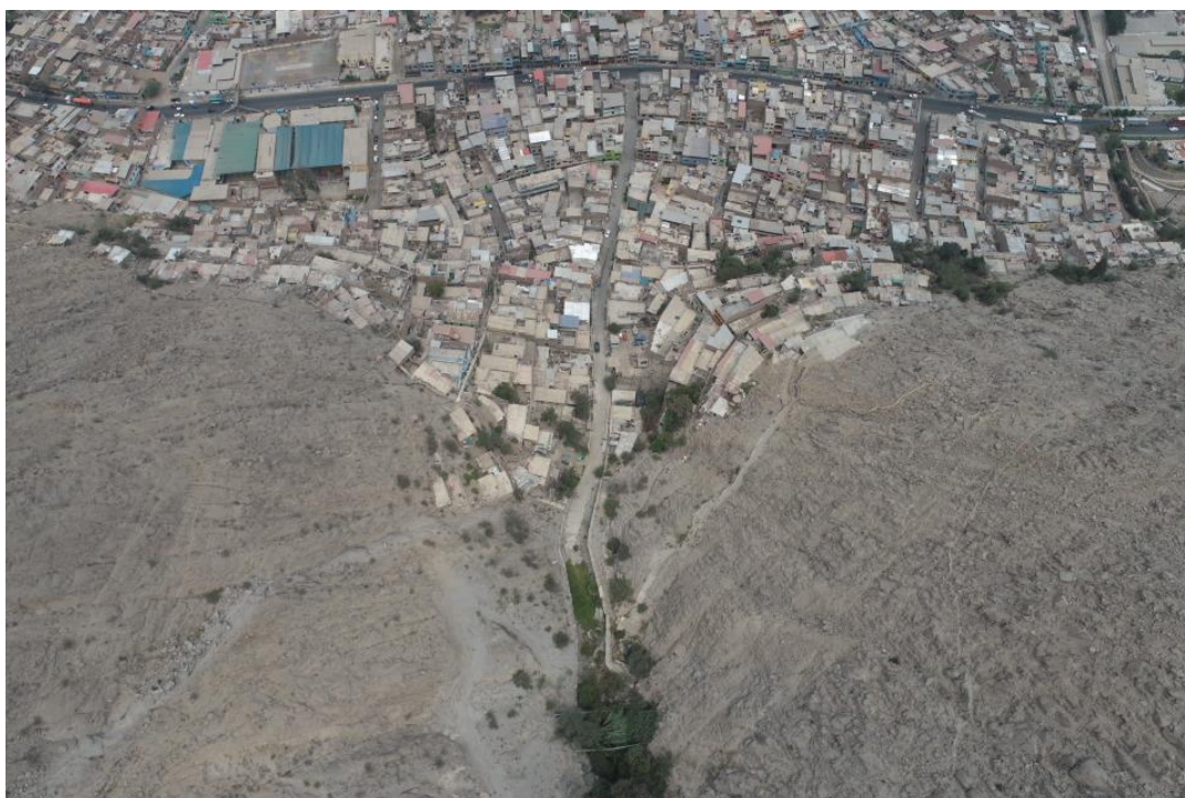
Fotografía 147. Zona crítica 15-045. Vista agua abajo de la quebrada Carossio, como se observa no existe un cauce definido hasta el río Rímac, en caso de un flujo de detritos lo receptiona la carretera Central. Coordenadas UTM E316210; 8681288 (tomada el 05/10/2023)
