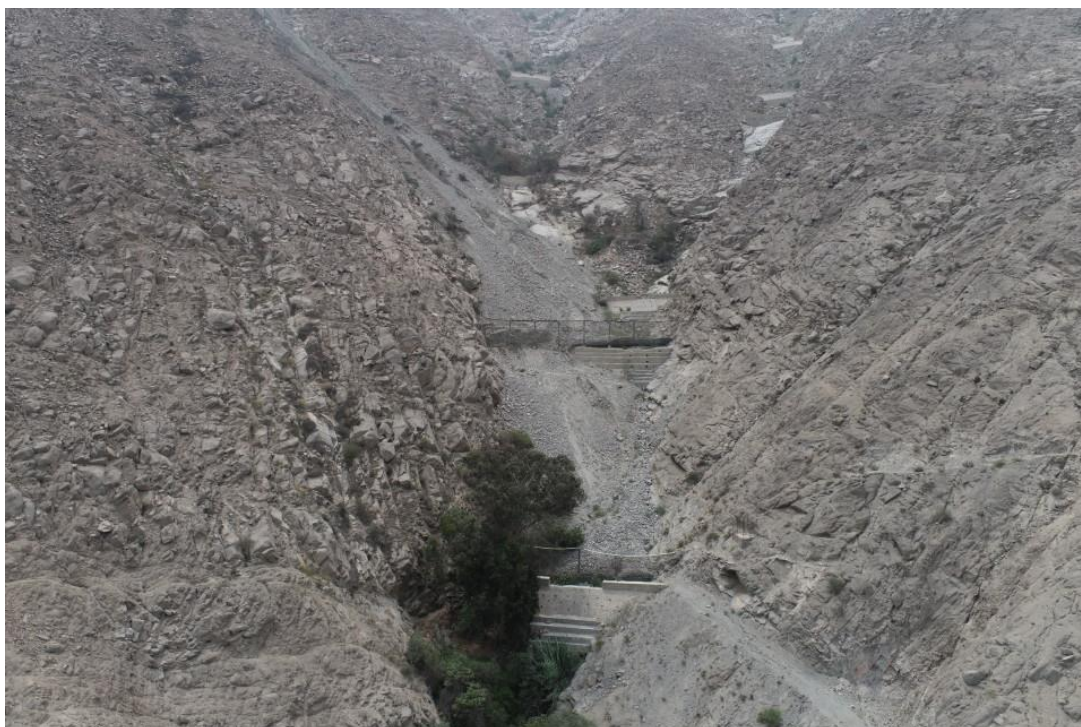
Fotografía 146. Zona crítica 15-045. Diques disipadores de energía y mallas o barras dinámicas en cauce colmatado de la quebrada Carossio, en la margen derecha se observa un depósito antiguo de una avalancha de rocas (1987) que transporta material suelto a la quebrada. Coordenadas UTM 18S E316210; N8681288 (tomada el 05/10/2023).
