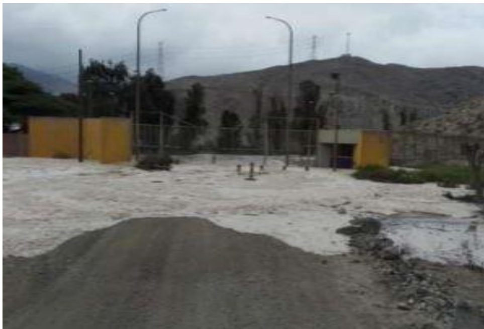
Fotografía 52. Zona crítica 15-007. Flujo de lodo del 14/03/2023 afectó instalaciones del Centro Nuclear Oscar Quesada de la Guerra, Huarangal. Coordenadas UTM 18S E280612; N8694994 (Fuente INDECI, 2023).
