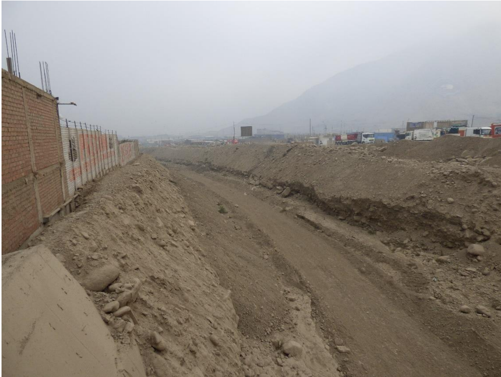
Fotografía 116. Zona crítica 15-031. Muro perimétrico de zona industrial se encuentra en el borde del cauce de la quebrada Huaycoloro, margen izquierda, no cuenta con defensa ribereña, se realizó descolmatación de cauce. Coordenadas UTM 18S E293933; N8676739 (tomada el 06/10/2023).
