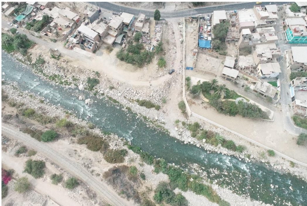
Fotografía 151. Zona crítica 15-046. Desembocadura de la quebrada Corrales hacia el río Rímac, se ha colocado muro de contención de la Asoc. de Prop. de terrenos Rayos del Sol. Coordenadas UTM 18S E316952; N8681426 (tomada el 24/11/2022).
