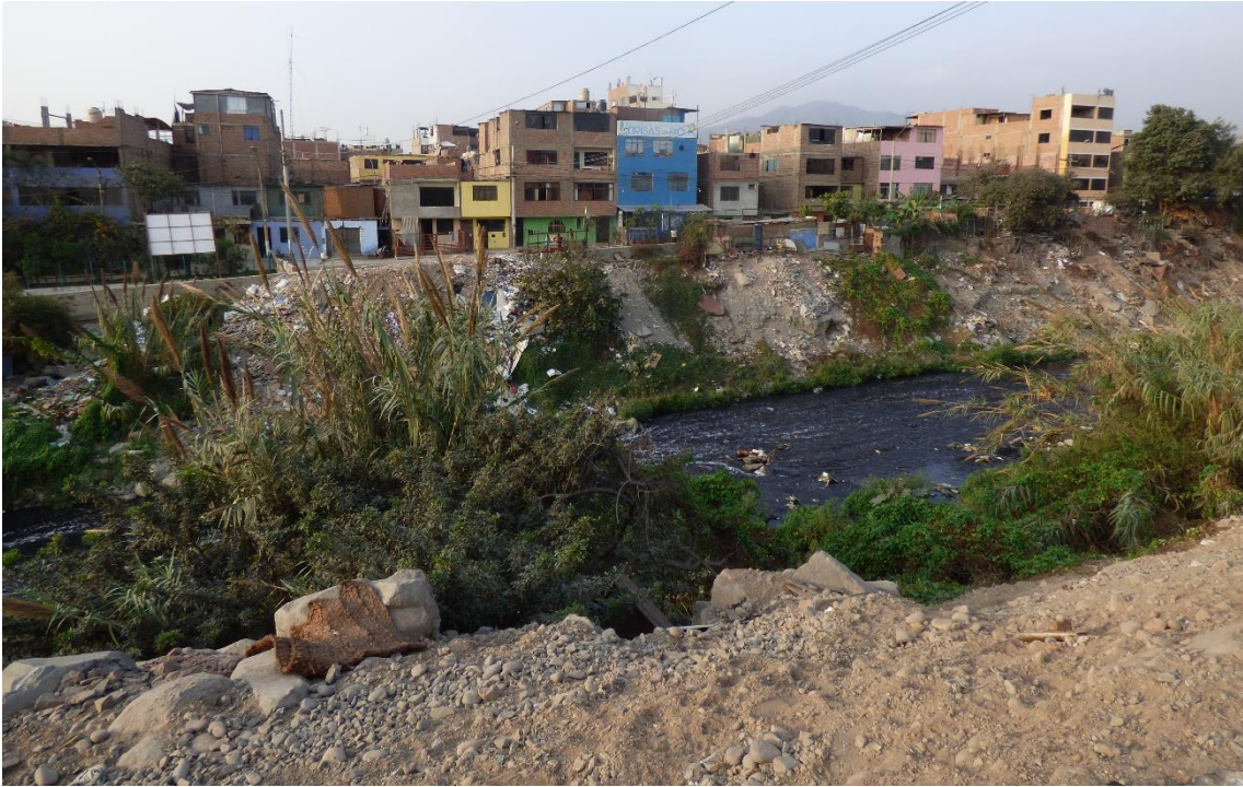
Fotografía 224. Zona crítica 15-080. Viviendas precarias en el Malecón Rímac en peligro alto debido a que se encuentran sobre depósitos de relleno en la margen derecha del río Rímac. Coordenadas UTM 18S E275140; N8668708. (Tomada el 20/03/2023).
