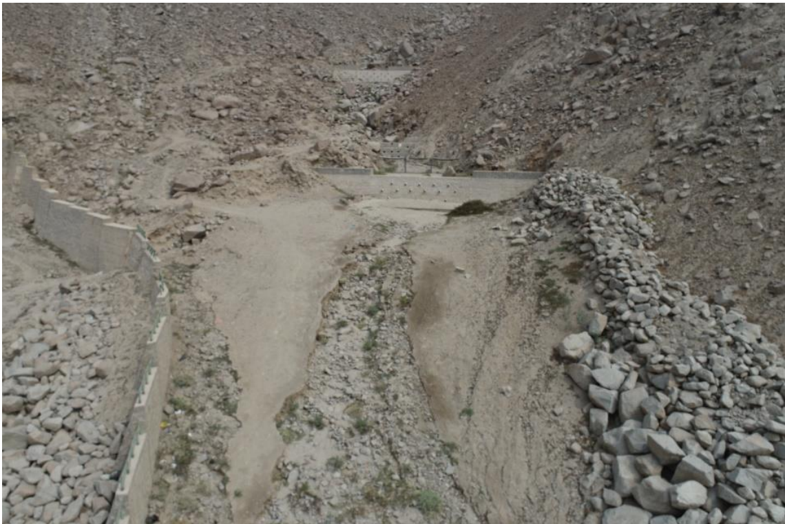
Fotografía 163. Zona crítica 15-050. Vista aguas arriba de la quebrada Mariscal Castilla, se observa diques disipadores de energía y muros de contención. Coordenadas UTM 18S E316482; N8679979 (tomada el 05/10/2023).
