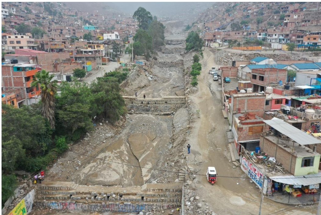
Fotografía 136. Zona crítica 15-041. Diques colmatados con material acarreado por flujo de detritos, se observa cómo se desbordó en la margen izquierda de la quebrada Quirio. Coordenadas UTM 18S E313051; N8680056 (tomada el 16/03/2023).
