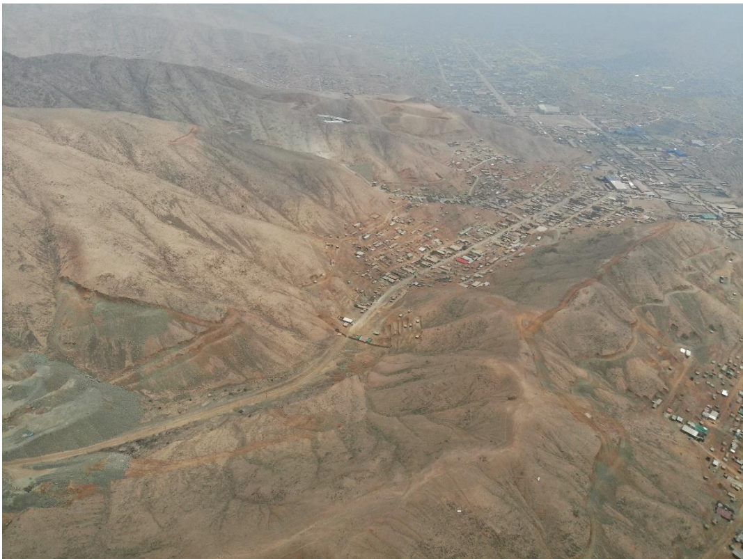
Fotografía 210. Zona crítica 15-073. Cauce de quebrada Media Luna antropizada por asentamiento de viviendas, han rellenado el cauce. Coordenadas UTM 18S E289285; N8683634. (Tomada el 20/03/2023).
