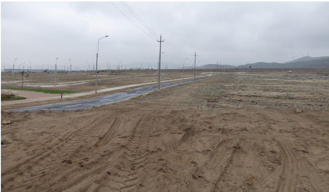
Fotografía 190. Zona crítica 15-064. Quebrada Lúcumo es obstruido por proyecto urbano Macropolis etapa 3 en Lurín, el cauce ha sido desviado con arrimado de material aguas arriba, en caso de una avenida excepcional se verán afectadas las futuras viviendas. Coordenadas UTM 18S E304558; N8642941 (tomada el 06/09/2023).
