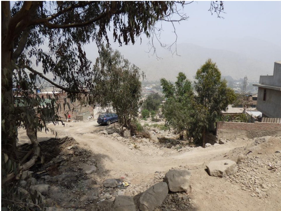
Fotografía 124. Zona crítica 15-037. Viviendas del sector Alto Huampaní etapa 2 se encuentran muy cerca del cauce de quebrada de 10 m de ancho de cauce, que se encuentra colmatado. Coordenadas UTM 18S E307926; N8676390 (tomada el 11/09/2023).
