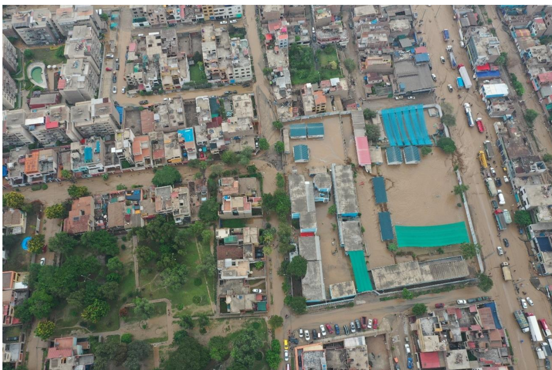
Fotografía 67. Zona crítica 15-013. Vista con dron de las zonas afectadas por el recorrido del flujo de detritos de la quebrada Cusipata, en la parte baja, Av. Nicolás Ayllón. Coordenadas UTM 18S E306972; N8674608 (tomada el 16/03/2023).
