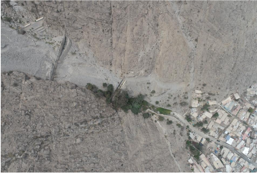
Fotografía 148. Zona crítica 15-045. Vista más detallada de las mallas dinámicas que se encuentran colmatadas de material suelto en la quebrada Carossio. Coordenadas UTM 18S E316210; N8681288 (tomada el 05/10/2023)
