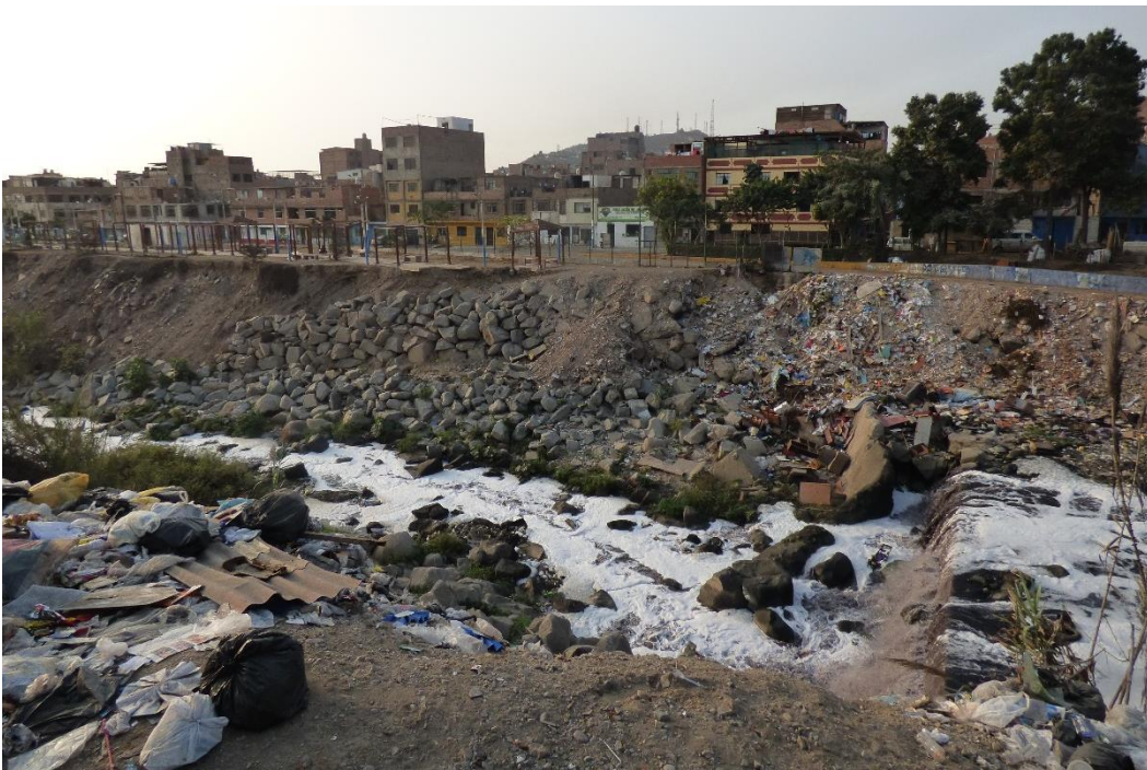
Fotografía 223. Zona crítica 15-080. Complejo deportivo del Malecón Rímac asentado sobre depósitos de relleno en la margen derecha del río Rímac, se observa socavación de la terraza. Coordenadas UTM 18S E275140; N8668708. (Tomada el 20/03/2023).
