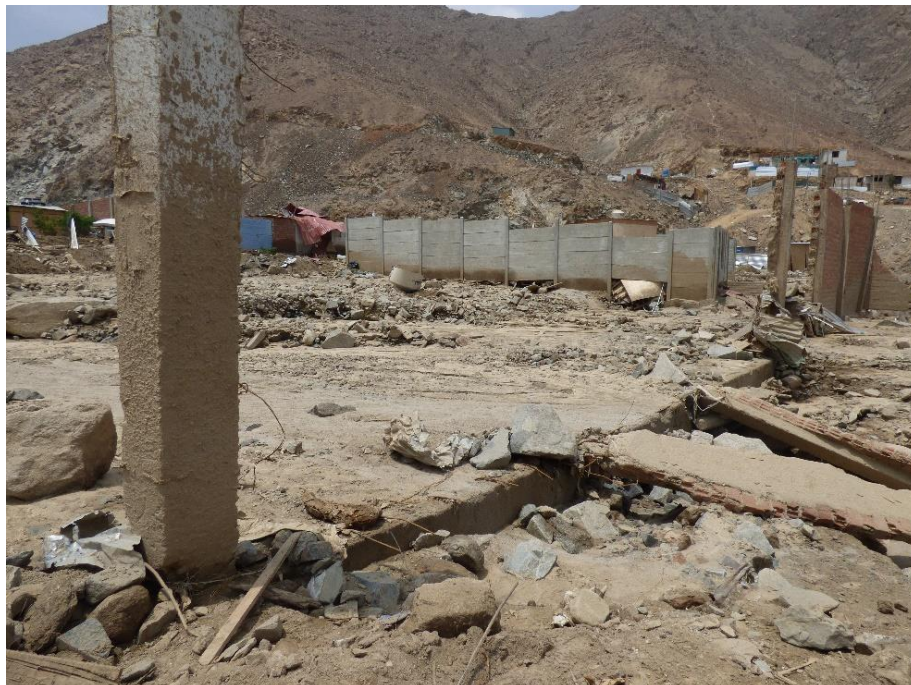
Fotografía 77. Zona crítica 15-018. Viviendas destruidas del sector Río Seco. Coordenadas UTM 18S E310798; N8663798 (tomada el 21/03/2023).
