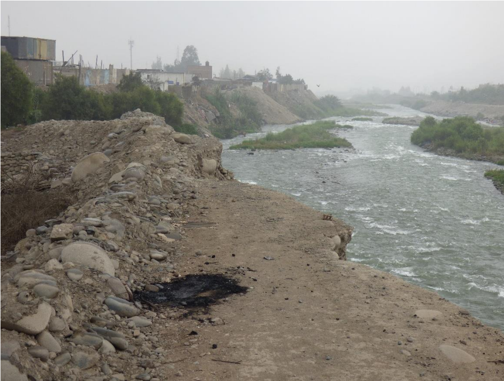
Fotografía 50. Zona crítica 15-006. Viviendas y corrales en la margen izquierda del río asentadas sobre depósito de relleno en peligro muy alto, aguas abajo de la urbanización Estrella Andina. Coordenadas UTM 18S E296810; N8671926 (Tomada el 13/09/2023).
