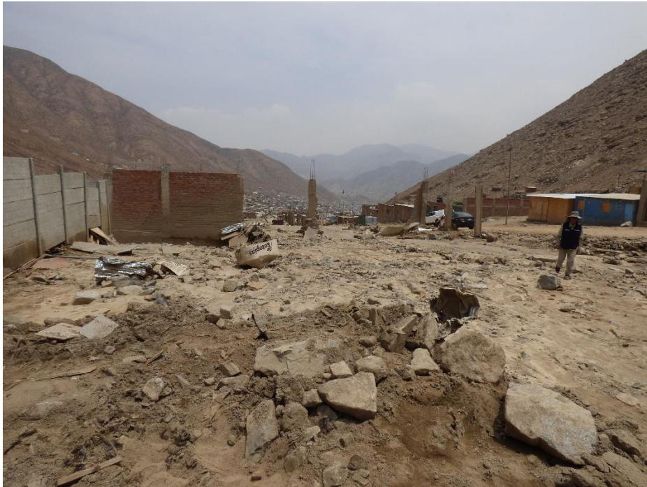
Fotografía 76. Zona crítica 15-018. Viviendas destruidas tras el paso del flujo de detritos en la quebrada Río Seco. Coordenadas UTM 18S E310473; N8663798 (tomada el 21/03/2023).
