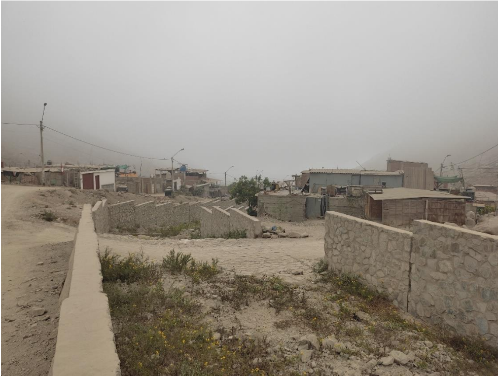
Fotografía 129. Zona crítica 15-039. Muros laterales en la quebrada Chacrasana, vías alternas cruzan la quebrada. Coordenadas UTM 18S E309711; N8678061 (tomada el 20/09/2023).
