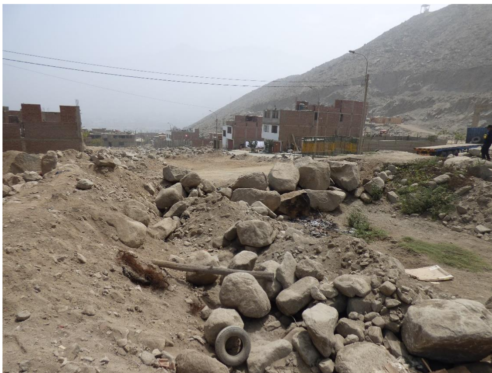
Fotografía 70. Zona crítica 15-014. Cauce de la quebrada Huascarán obstruido con enrocado, a la altura de la Mz. K de la Asoc. de Vivienda El Huascarán y viviendas aguas abajo en peligro. Coordenadas UTM 18S E306330; N8674455 (tomada el 12/09/2023).
