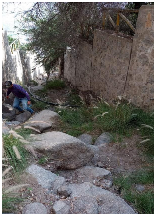
Fotografía 161. Zona crítica 15-049. Cauce de la quebrada Señor de Los Milagros se encuentra colmatado, se ha colocado muros de contención. Coordenadas UTM 18S E316777; N8680244 (Fuente: Municipalidad Distrital de Lurigancho, tomada el 08/08/2023).
