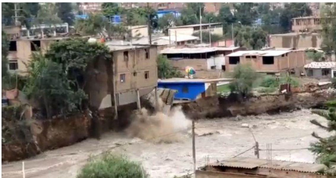
Fotografía 160. Zona crítica 15-048. Vivienda de 3 pisos cae por socavamiento del río Rímac debido a la avenida del 16/03/2023, la vivienda se ubica en la margen izquierda del río Rímac, en el sector Cooperativa Pablo Patrón. Coordenadas UTM 18S E316629; N8681042 (Fuente: Willax TV, 2023).
