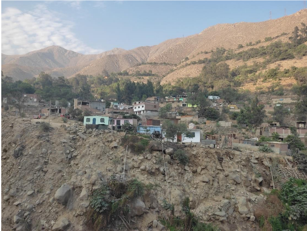
Fotografía 137. Zona crítica 15-042. Viviendas cerca del borde del acantilado, en margen izquierda de la quebrada Pedregal. Coordenadas UTM 18S E314611; N8681287 (tomada el 20/09/2023).
