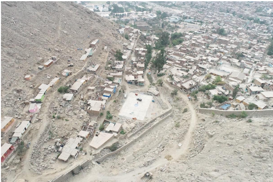
Fotografía 167. Zona crítica 15-052. Vista de los muros de contención colocados en la quebrada Santo Domingo. Coordenadas UTM 18S E315549; N8678777 (tomada el 24/11/2022).
