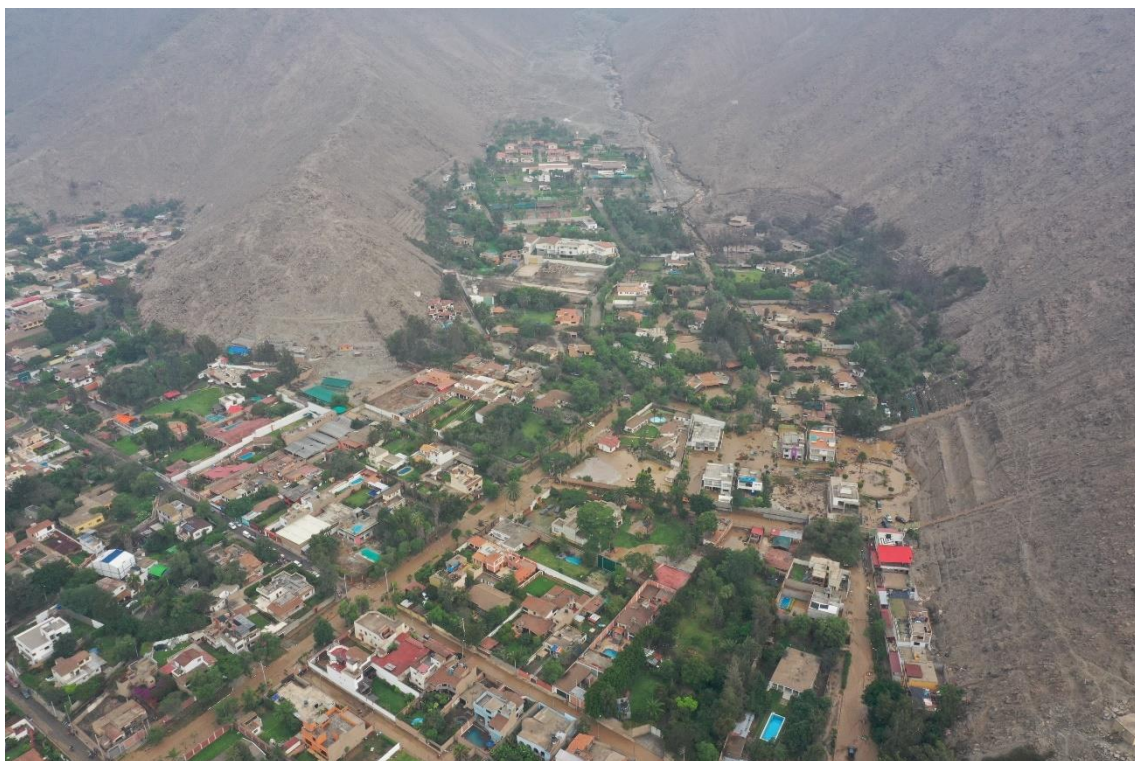
Fotografía 66. Zona crítica 15-013. Vista con dron de las zonas afectadas por el recorrido del flujo de detritos de la quebrada Cusipata. Coordenadas UTM 18S E306972; N8674608 (tomada el 16/03/2023).
