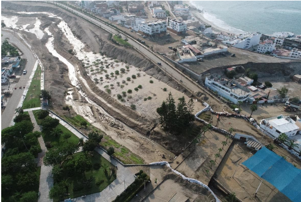
Fotografía 193. Zona crítica 15-066. Vista aguas arriba tomada con dron del flujo de lodo del 14/03/2023 que discurrió por la quebrada Malanche a la altura del puente y complejo deportivo Municipal. Coordenadas UTM 18S E301540; N8635545 (Tomada el 17/08/2023).
