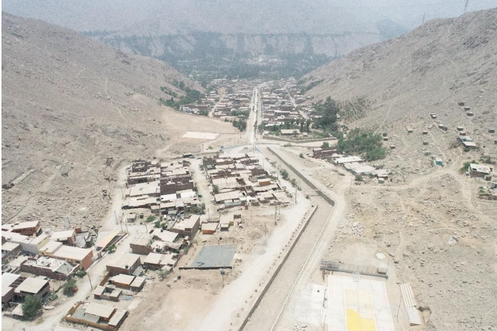
Fotografía 127. Zona crítica 15-039. Vista aguas abajo de la quebrada Chacrasana. Se observa canalización de la quebrada en un tramo. Coordenadas UTM 18S E309711; N8678061 (tomada con dron el 24/11/2022).
