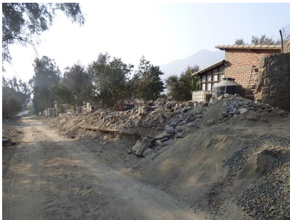
Fotografía 63. Zona crítica 15-013. Viviendas de la Av. Las Terrazas de la Urb. Cusipata afectadas por flujo de detritos de la quebrada. Coordenadas UTM 18S E306972; N8674608 (Tomada el 11/09/2023).
