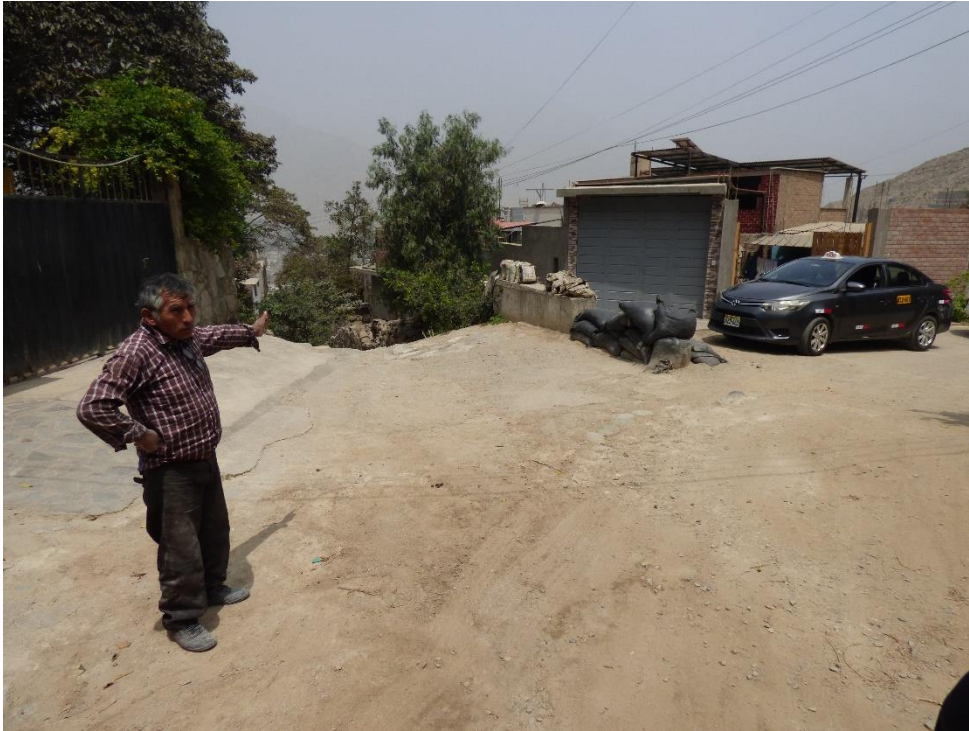
Fotografía 121. Zona crítica 15-036. Viviendas y vías del sector Alto Huampaní Etapa 1 fueron afectadas por flujo de lodo que se generó por las lluvias de Yaku, los pobladores colocaron sacos terreros para proteger sus viviendas. Coordenadas UTM 18S E307154; N8676250 (tomada el 11/09/2023).
