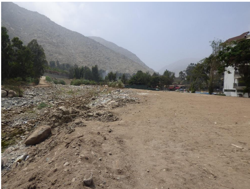
Fotografía 81. Zona crítica 15-019. Se ha colocado depósitos de desmonte en la ribera para protegerse de la erosión fluvial en la margen izquierda del río Lurín, sector Carricillo. Con las lluvias de Yaku este sector fue afectado por el flujo de lodo del 14/03/2023 en la quebrada Seca y por la erosión fluvial. Coordenadas UTM 18S E308263; N8665230 (tomada el 07/09/2023).
