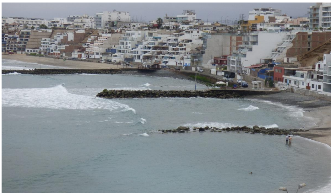
Fotografía 36. Playa Norte en el distrito de San Bartolo. Se observan cómo las corrientes marinas están erosionando los muros protectores y afectando algunas viviendas.
