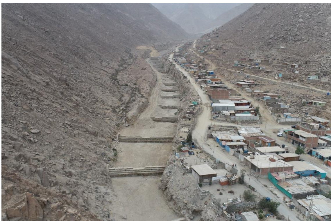
Fotografía 153. Zona crítica 15-047. Vista con dron de diques disipadores de energía se encuentran colmatados tras el paso del flujo de detritos del 14/03/2023 en la quebrada La Ronda, se observa viviendas ubicadas muy cerca del cauce, en la margen izquierda de la quebrada. Coordenadas UTM 18S E317236; N8680704 (tomada el 05/10/2023).
