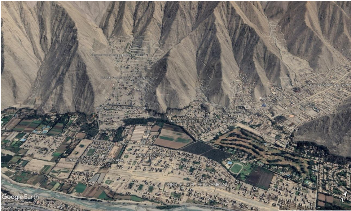
Figura 12. Zona crítica 15-034. Vista de quebradas que descienden del cerro Algarrobo, se puede apreciar como el cauce de las quebradas se encuentra antropizado por viviendas de la Asoc. Los Portales de Huampaní. Coordenadas UTM 18S E302434; N8676683 (Fuente Google Earth, 2023).
