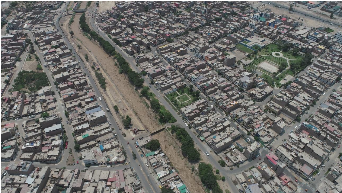
Fotografía 217. Zona crítica 15-078. Vista del río Chillón colmatado por material que se generó por las lluvias de Yaku, entre los puentes Milton y Bethania. Coordenadas UTM 18S E273774; N8680569. (Tomada el 20/03/2023).
