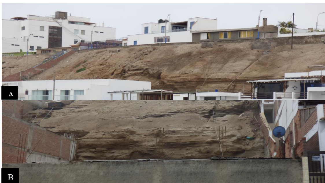
Fotografía 6. En A y B se tienen depósitos marinos de limo y arenas, se observan estratos semi-horizontales paralelos delante de las cuales se han construido viviendas ubicadas frente a Playa Norte en el distrito de San Bartolo.
