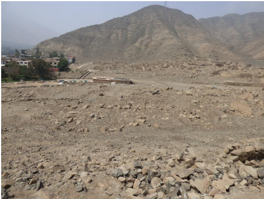
Fotografía 83. Zona crítica 15-020. Centro Arqueológico de Huaycán de Cieneguilla se ubica sobre quebrada Huaycán. Coordenadas UTM 18S E307539; N8663738 (tomada el 07/09/2023).
