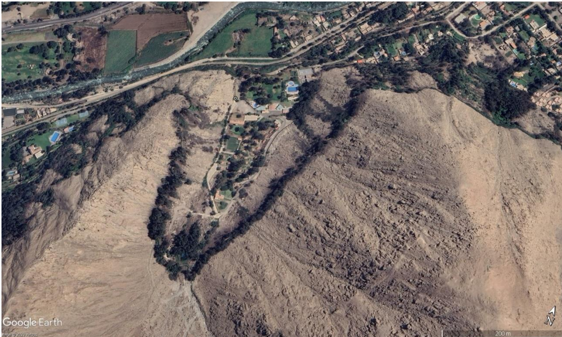
Figura 14. Zona crítica 15-058. Vista de la quebrada Koricancha, la cuenca media-superior muestra depósitos de huaicos antiguos con grandes bloques que rellenan su cauce principal, así como material suelto en las laderas. Coordenadas UTM 18S E311163; N8676972 (Fuente: Google Earth, 2023).
