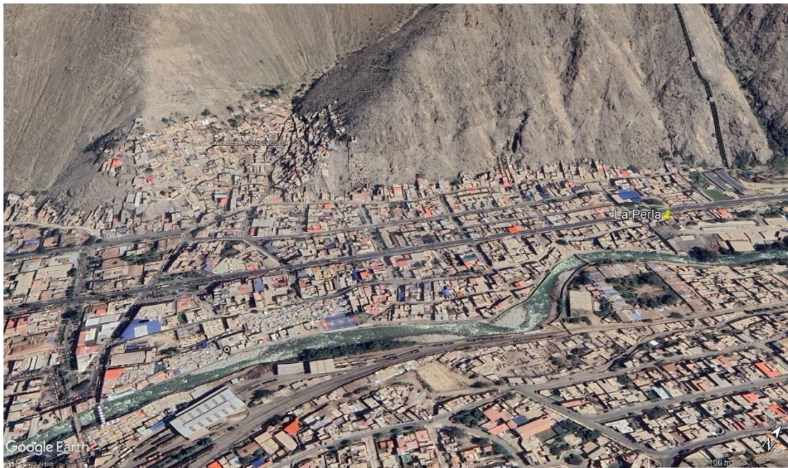
Figura 13. Zona crítica 15-044. Se ha colocado muro de contención en la margen derecha del río Rímac, sector La Perla, el cauce del río se encuentra colmatado. Coordenadas UTM 18S E315721; N8680201 (Fuente Google Earth, 2023).
