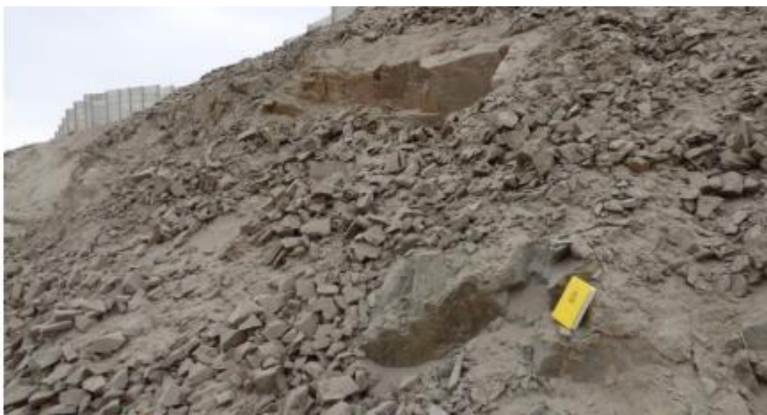
Fotografía 14. Andesitas muy fracturadas de la Formación Chilca ubicadas en la margen derecha de la quebrada Malanche en el distrito de Punta Hermosa.
