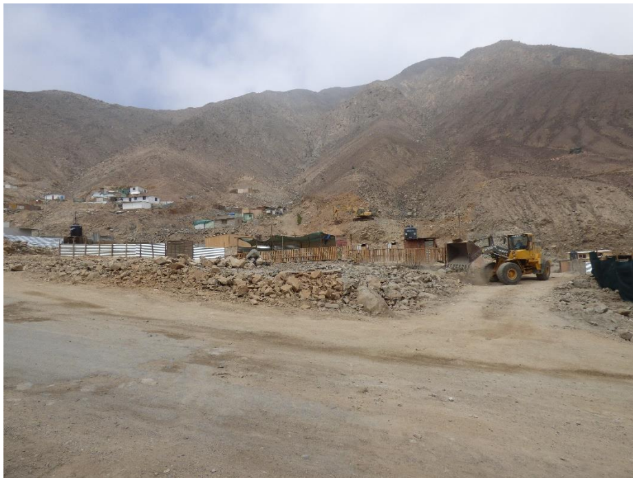
Fotografía 79. Zona crítica 15-018. Se sigue realizando la limpieza de escombros y movimiento de tierras en el sector y colocando viviendas prefabricadas en el mismo lugar de desastre. Coordenadas UTM 18S E310679; N8663873 (tomada el 07/09/2023).
