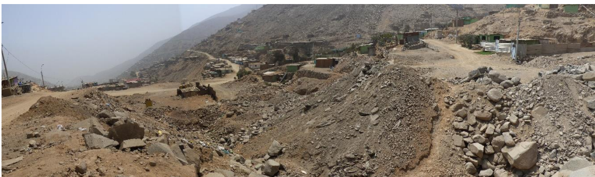
Fotografía 43. Zona crítica 15-002. Cauce de quebrada sin nombre obstruido por viviendas de la Asoc. La Rinconada, zona Z de Huaycán. Coordenadas UTM 18S E304556; N8671458 (Tomada el 12/09/2023).
