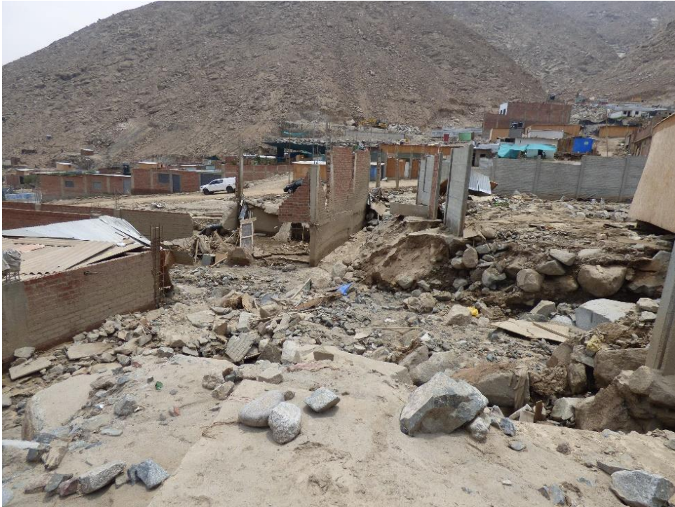
Fotografía 78. Zona crítica 15-018. Viviendas destruidas por flujo de detritos en el sector Río Seco. Coordenadas UTM 18S E310680; N8663875 (tomada el 21/03/2023).
