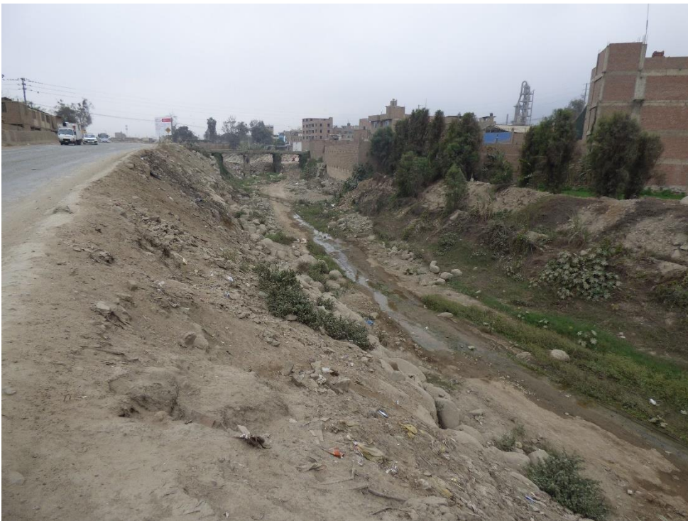
Fotografía 115. Zona crítica 15-030. Viviendas de la Asoc. Las Riveras de Cajamarquilla se ubican cerca del borde del cauce de la quebrada Huaycoloro, margen izquierda en caso de una avenida extraordinaria puede afectar estas viviendas, puente peatonal y vía, el cauce se encuentra colmatado. Coordenadas UTM 18S E292735; N8673788 (tomada el 06/10/2023).
