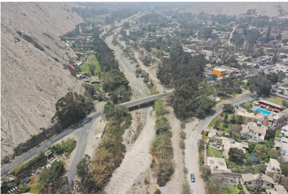
Fotografía 89. Zona crítica 15-022. Vista con dron del puente Panquilma se puede observar el cauce del río Lurín colmatado. Coordenadas UTM 18S E306667; N8662420 (tomada el 28/10/2022).
