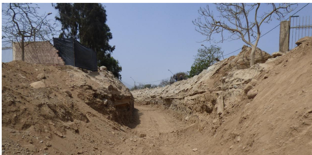
Fotografía 94. Zona crítica 15-025. Cauce de la quebrada Tinajas socavado por el flujo de lodo en la Av. Tulipanes, tras su paso se llevó una reja que impedía el paso de casa-hacienda, vía y terrenos de cultivo. Coordenadas UTM 18S E302117; N8656988 (tomada el 08/09/2023).
