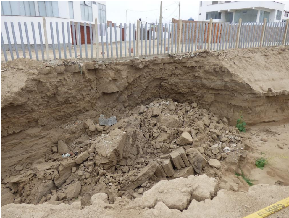
Fotografía 204. Zona crítica 15-071. Pequeños derrumbes de la terraza en la margen derecha de la quebrada Cruz de Hueso, distrito Punta Negra, por socavación del flujo de detritos del 16/03/2023. Coordenadas UTM 18S E306269; N8630890. (Tomada el 17/08/2023).
