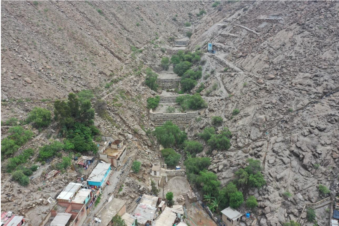
Fotografía 141. Zona crítica 15-043. Vista con dron se observa el recorrido del flujo de detritos del 14/03/2023 en la quebrada La Libertad. Coordenadas UTM 18S E315366; N8680644 (tomada el 16/03/2023).
