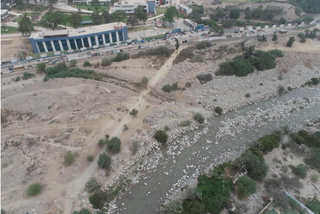
Fotografía 170. Zona crítica 15-052. Flujos de detritos recurrentes discurren por la quebrada Santo Domingo, en la margen izquierda de la quebrada se observa instalaciones de la Universidad La Cantuta que es afectada tras el paso de estos eventos. Coordenadas UTM 18S E314717; N8679001 (tomada el 06/10/2023).
