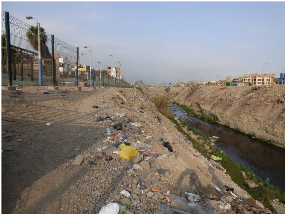
Fotografía 221. Zona crítica 15-079. Complejo deportivo de la alameda Maelcón Rímac se encuentra al borde de la ribera del río Rímac, actualmente se encuentra clausurado. Coordenadas. UTM 18S E273926; N8668731. (Tomada el 20/03/2023).
