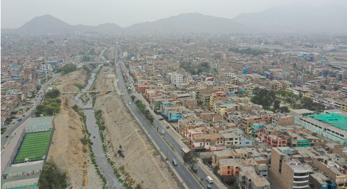
Fotografía 102. Zona crítica 15-026. Vista con dron del parque y complejo deportivo de la Cooperativa Talavera La Reyna-Los Libertadores no cuenta con defensa ribereña en la margen izquierda del río Rímac, se ha colocado depósitos de desmonte y el cauce del río se encuentra colmatado. Coordenadas UTM 18S E308974; N8657792 (tomada el 19/10/2022).
