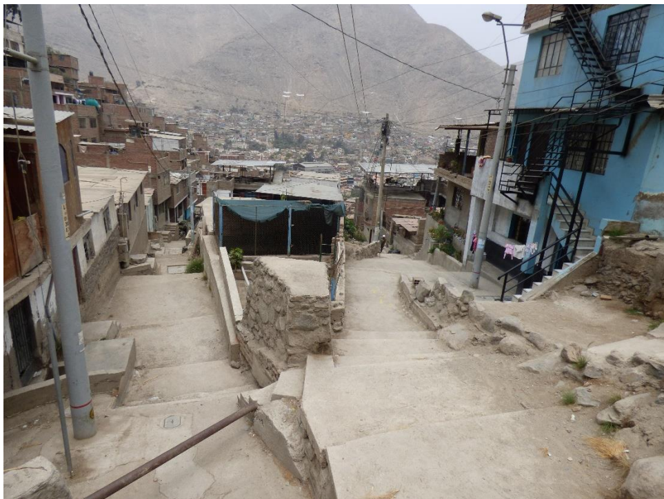
Fotografía 142. Zona crítica 15-043. Viviendas se encuentran asentadas sobre el cauce de la quebrada, el flujo discurre por ambos pasajes de la Prolongación Salaverry. Coordenadas UTM 18S E315366; N8680644 (tomada el 05/10/2023).
