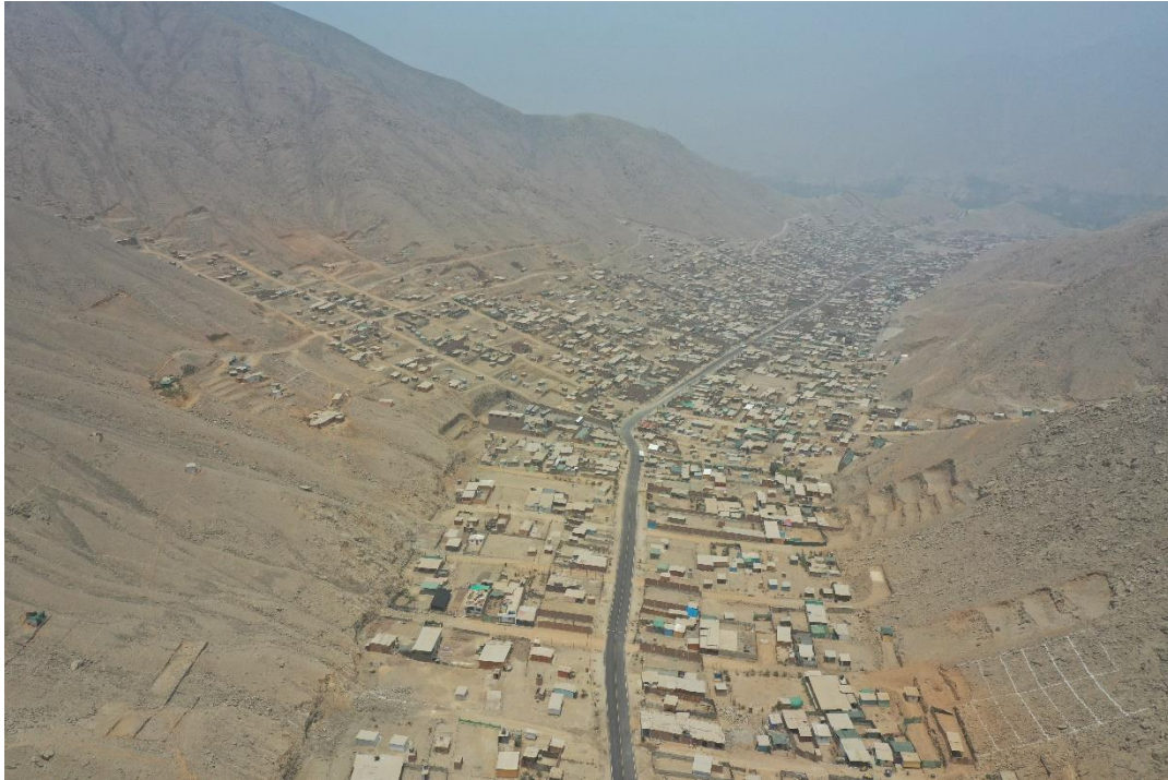
Fotografía 74. Zona crítica 15-018. Vista con dron de la quebrada Río Seco, viviendas de la Asociación de Vivienda Residencial Río Seco se ubican dentro del cauce de la quebrada que ha sido rellenado, se observa vía de acceso asfaltada. Coordenadas UTM 18S E310680; N8663875 (tomada el 28/10/2022).
