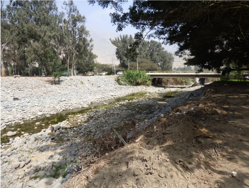
Fotografía 88. Zona crítica 15-022. En el sector Puente Panquilma el cauce del río se encuentra colmatado, con presencia de erosión fluvial en ambas márgenes. Coordenadas UTM 18S E306667; N8662420 (tomada el 07/09/2023).
