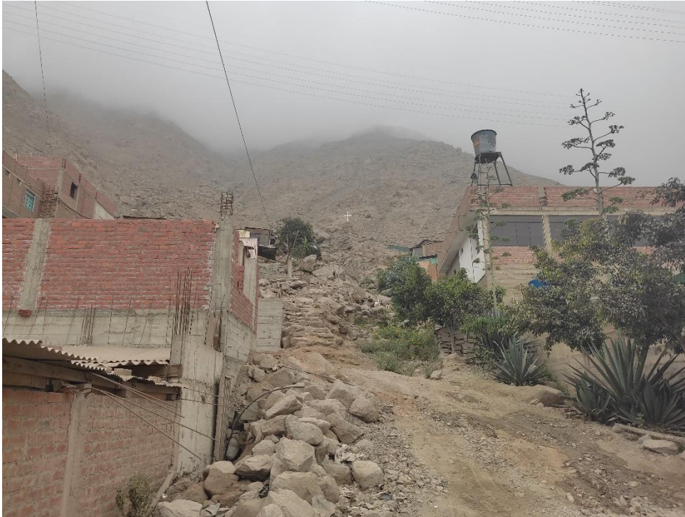
Fotografía 125. Zona crítica 15-038. Viviendas del A.H. Emilio del Sol y San Alberto se encuentran asentadas en ambas márgenes de quebrada. Coordenadas UTM 18S E309540; N8677216 (tomada el 20/09/2023).
