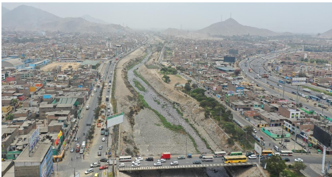
Fotografía 106. Zona crítica 15-028. Vista con dron, aguas arriba del puente Chinchaysuyo, se observa en la margen derecha los complejos deportivos, parques y áreas verdes sobre depósitos de relleno, sin defensa ribereña y cauce colmatado. Coordenadas UTM 18S E282233; N8669515 (tomada el 19/11/2022).
