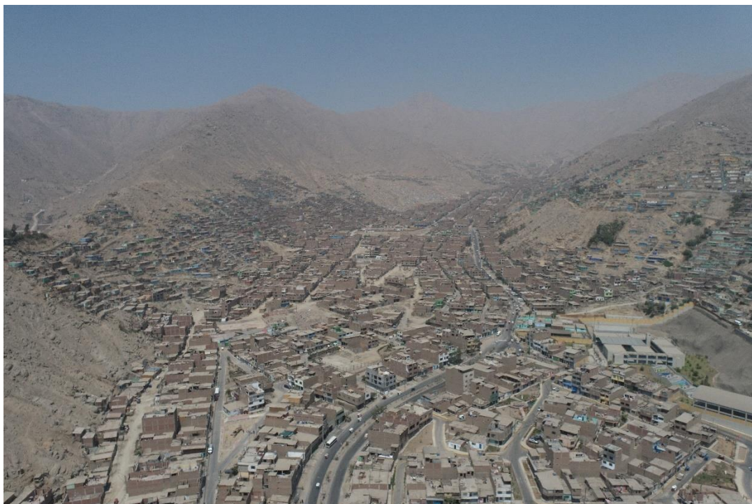
Fotografía 44. Zona crítica 15-002. Vista hacia el sureste tomada con dron de la Zona Z de Huaycán que fue afectado por flujos de lodo del 14/03/2023 que discurrió por quebrada cuyo cauce fue obstruido por la construcción de viviendas. Coordenadas UTM 18S E304556; N8671458 (Tomada el 10/11/2022).
