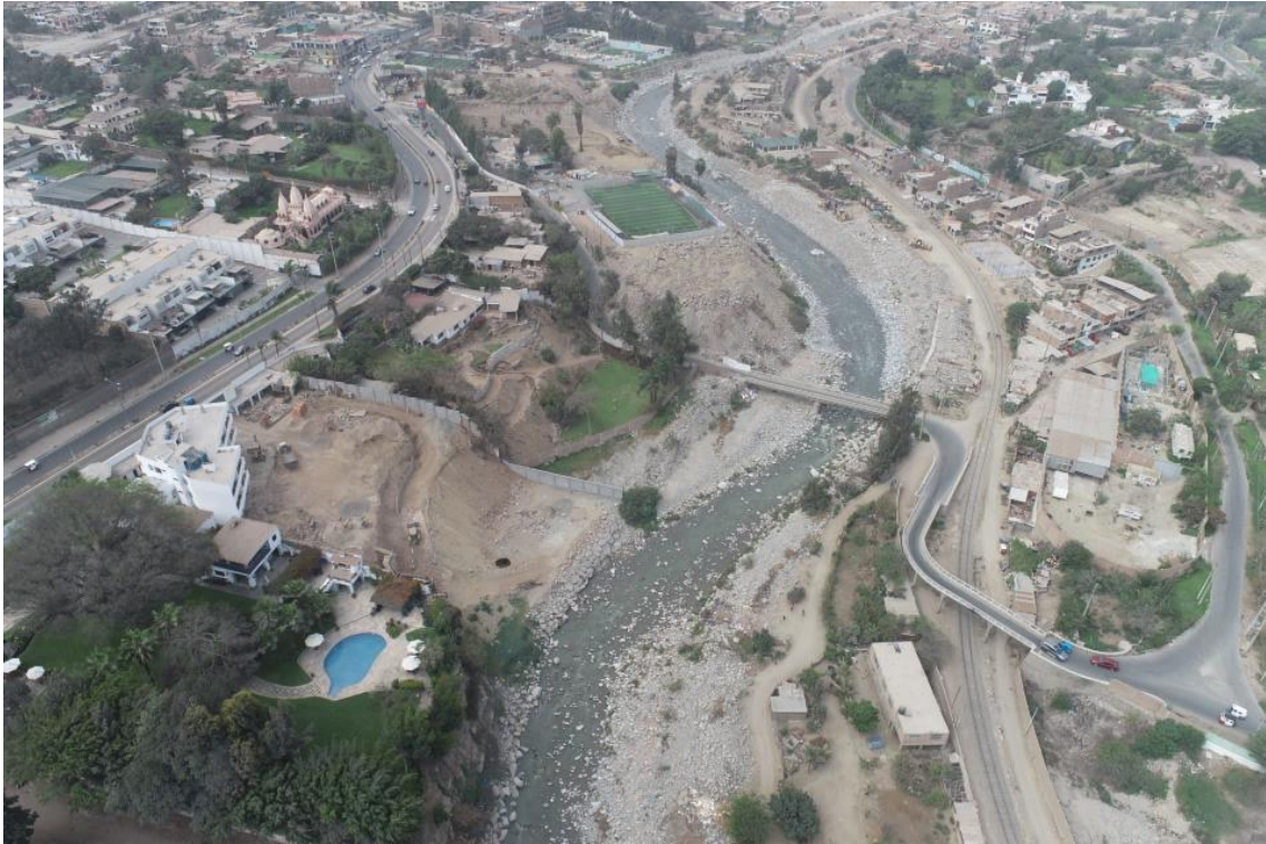
Fotografía 172. Zona crítica 15-054. Vista del cauce colmatado del río Rímac, sector puente Caracol, en la margen izquierda del río presenta erosión fluvial, que puede afectar la vía férrea y viviendas de la Asoc. Luis F. Bueno Quino. Coordenadas UTM 18S E313798; N8678742 (tomada el 06/10/2023).
