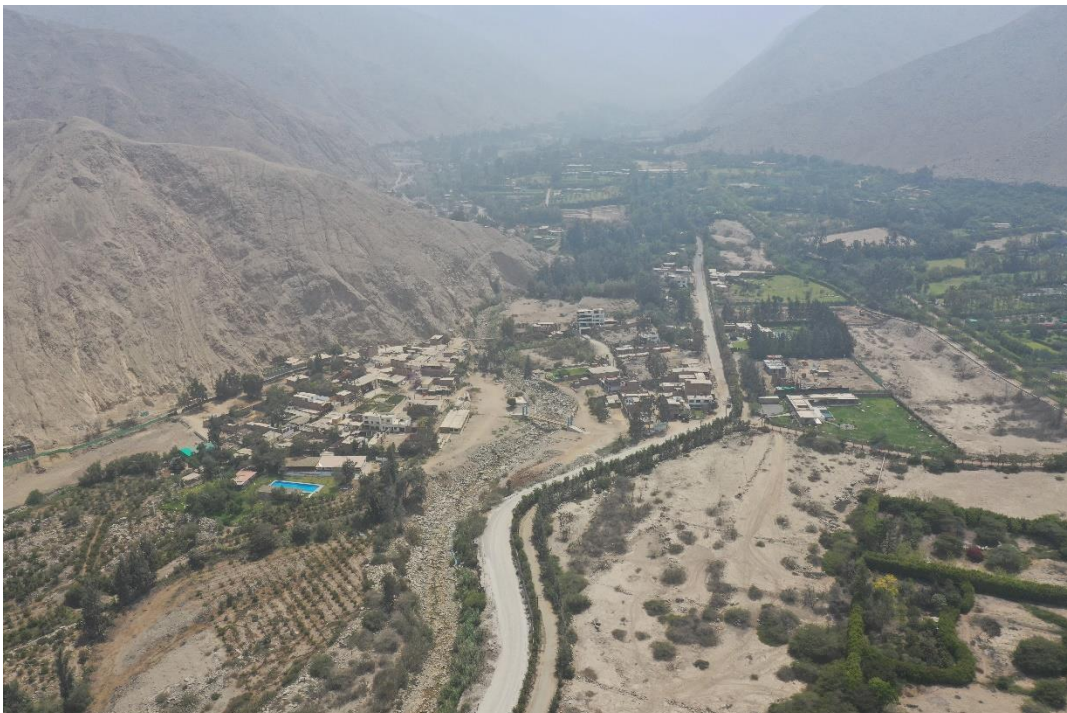
Fotografía 77. Zona crítica 15-017. Centros recreacionales, viviendas del sector Lindero. La zona también es afectada por erosión fluvial del río Lurín. Coordenadas UTM 18S E313432; N8668499 (tomada el 28/10/2022).
