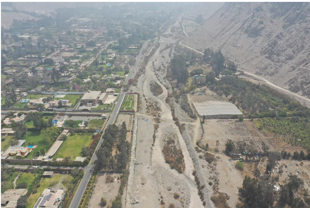
Fotografía 91. Zona crítica 15-023. Vista con dron, se observa la colmatación del río Lurín y procesos de erosión fluvial en ambas márgenes del río. Coordenadas UTM 18S E304049; N8660853 (tomada el 08/11/2022).
