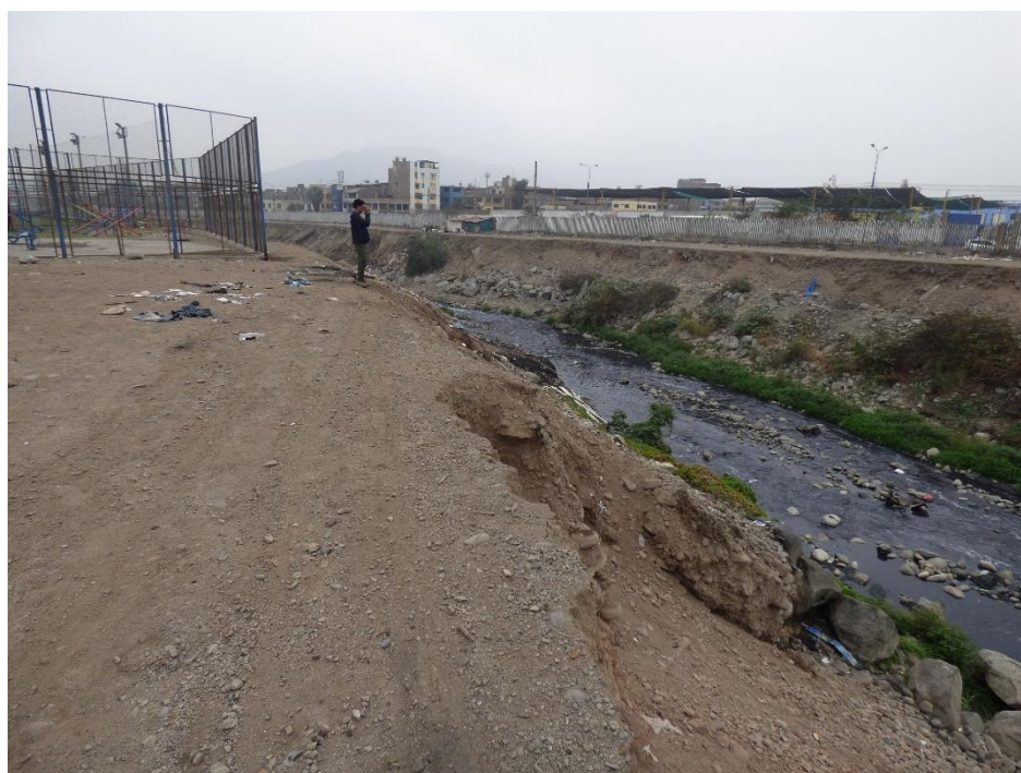
Fotografía 107. Zona crítica 15-028. Complejo deportivo del sector Bicentelo Bajo en margen izquierda del río Rímac a 1m del borde de la ribera, cauce colmatado del río Rímac. Coordenadas UTM 18S E282692; N8669638 (tomada el 15/09/2023).
