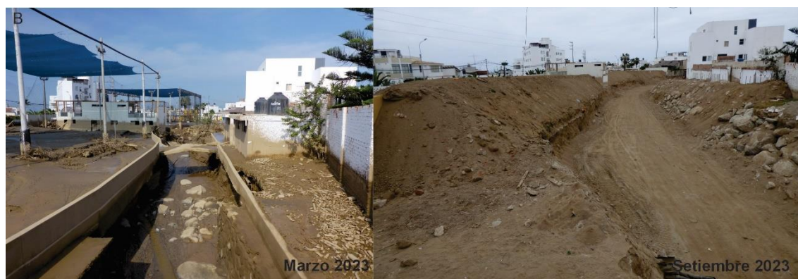
Figura 17. Zona crítica 15-066. Comparación de vistas del 17/03/2023 y 04/09/2023, se observa que se realizó la limpieza y ampliación de la quebrada Malanche, se demolió el Complejo Deportivo Municipal y otras viviendas en la margen izquierda de la quebrada. Coordenadas UTM 18S E301540; N8635545.
