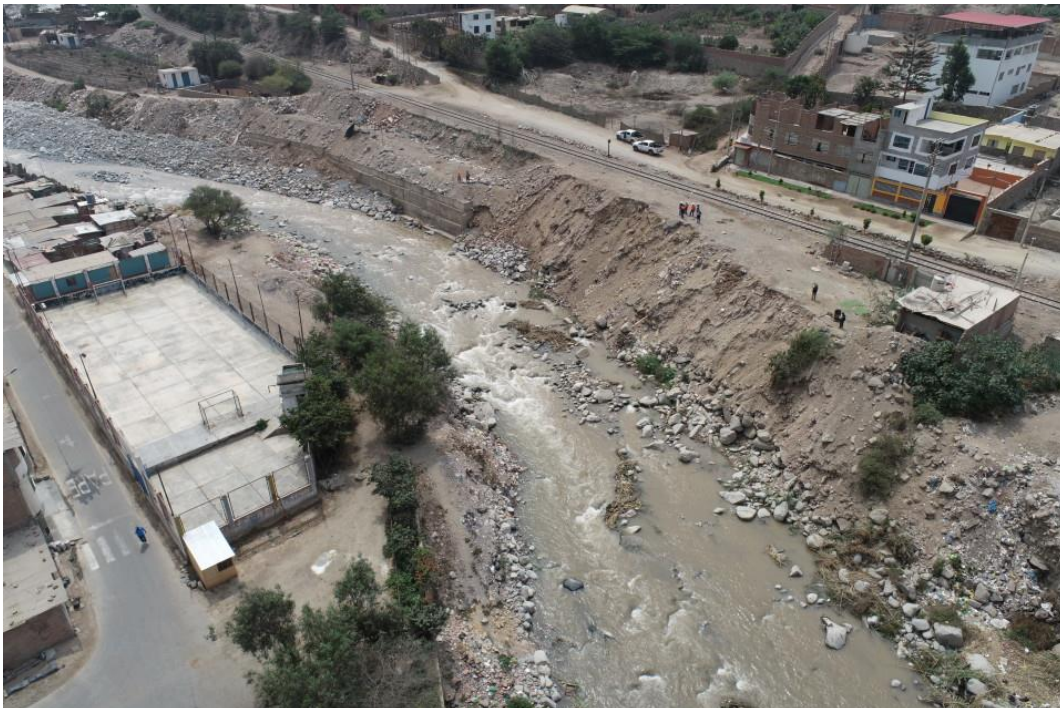
Fotografía 155. Zona crítica 15-048. Erosión fluvial en margen izquierda del río Rímac, viviendas del sector Cooperativa Pablo Patrón se encuentran asentadas sobre depósitos de relleno. Coordenadas UTM 18S E316629; N8681042 (tomada el 06/10/2023).
