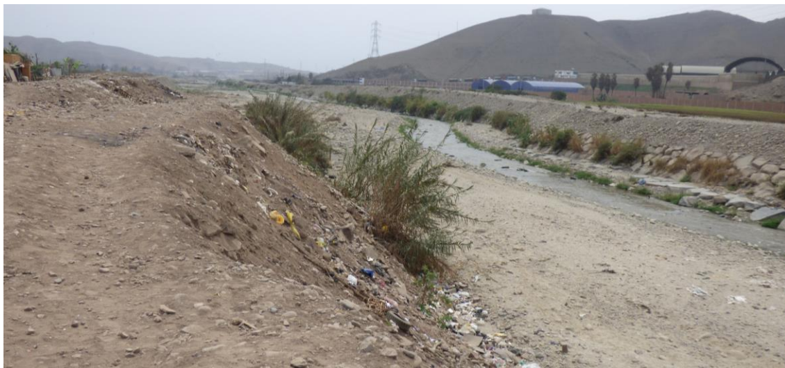
Fotografía 9. Depósitos antropogénicos en la margen izquierda del río Chillón, el depósito de desmante y basura se ha colocado a modo de barrera, sin embargo, las crecidas del río erosionan constantemente este material, poniendo en peligros viviendas del sector Lomas de Chillón en el distrito de San Martín de Porres.
