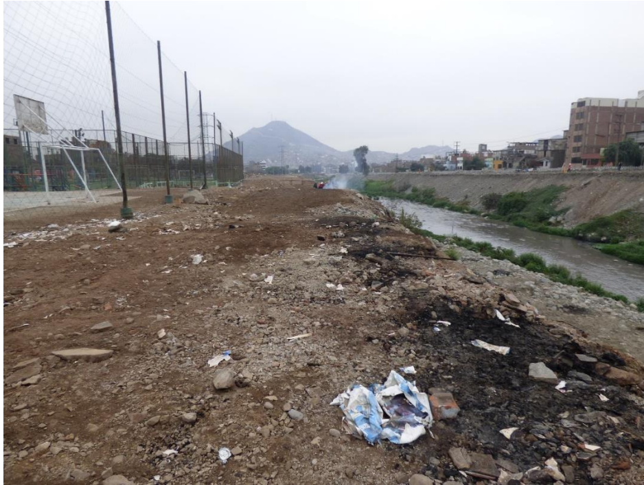
Fotografía 108. Zona crítica 15-028. Complejo deportivo aguas debajo de Puente Nuevo en Av. Malecón de la Amistad, margen izquierda del río Rímac sobre depósito de relleno. Coordenadas UTM 18S E281966; N8669437 (tomada el 14/09/2023).
