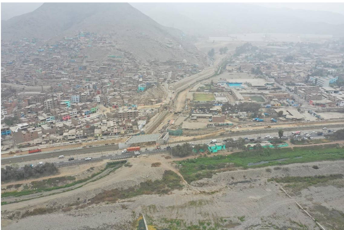
Fotografía 111. Zona crítica 15-029. Vista con dron de la quebrada Huaycoloro donde se observa el tramo canalizado con muros laterales hasta la vía Ramiro Prialé. Coordenadas UTM 18S E308974; N8657792 (tomada el 19/10/2022).
