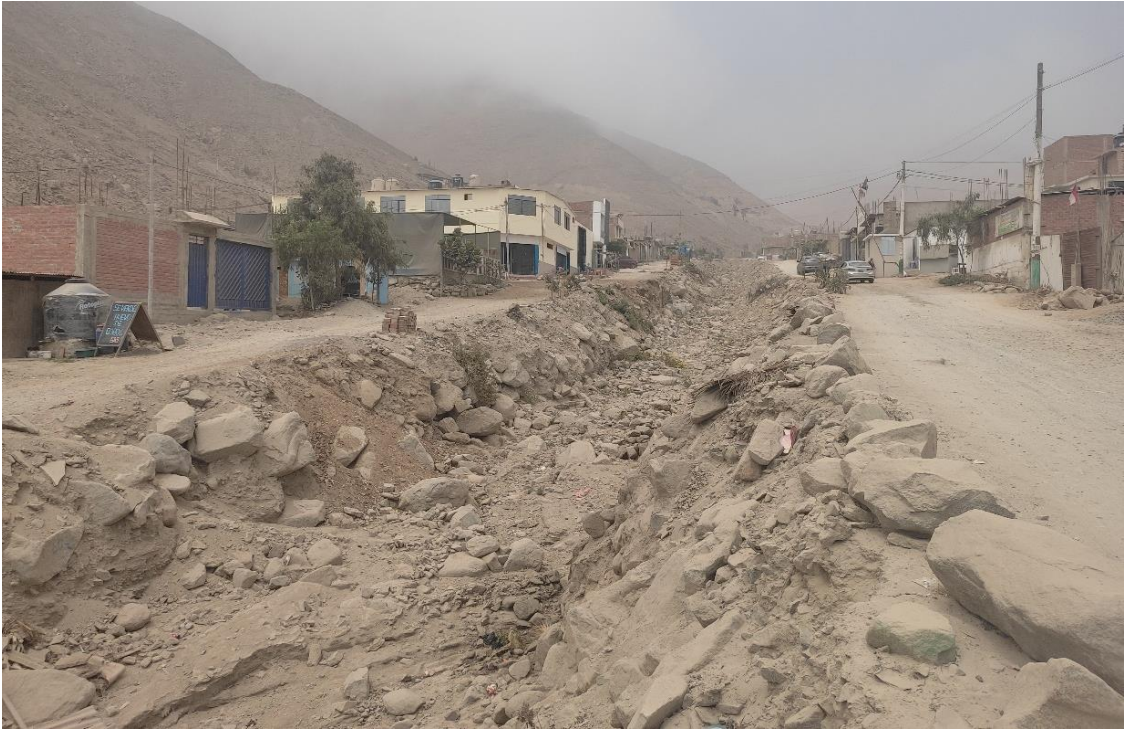
Fotografía 180. Zona crítica 15-057. Cauce reducido y colmatado de la quebrada California. Coordenadas UTM 18S E313455; N8675760 (tomada el 20/09/2023).
