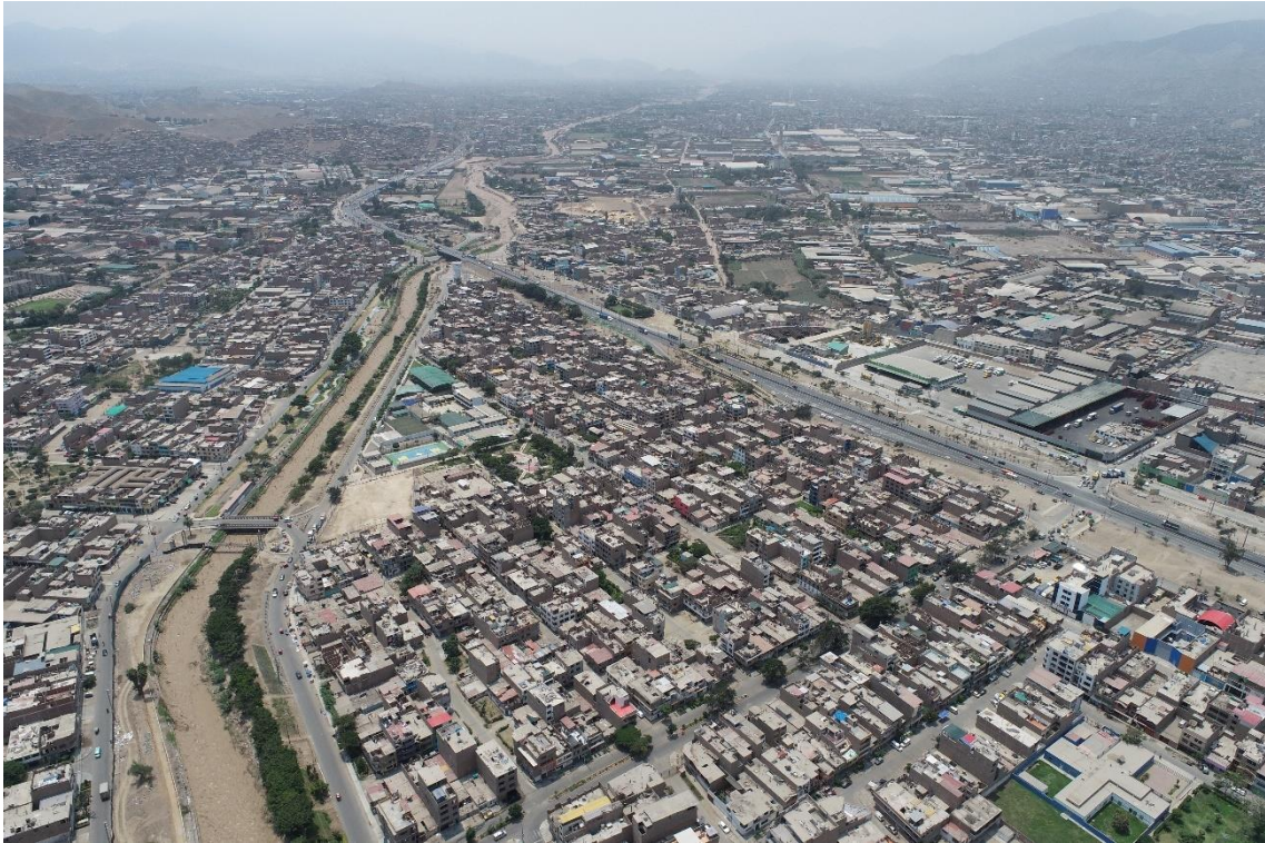
Fotografía 218. Zona crítica 15-078. Vista del río Chillón colmatado por material que se generó por las lluvias de Yaku, Puente Bethania. Coordenadas UTM 18S E273820; N8681001. (Tomada el 20/03/2023).
