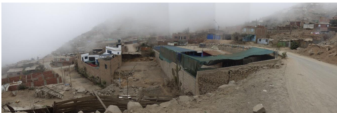
Fotografía 45. Zona crítica 15-003. Viviendas de la Asoc. Santa Rosa, zona T de Huaycán se encuentran asentadas sobre el cauce de quebrada. Coordenadas UTM 18S E303493; N8669628 (Tomada el 12/09/2023).
