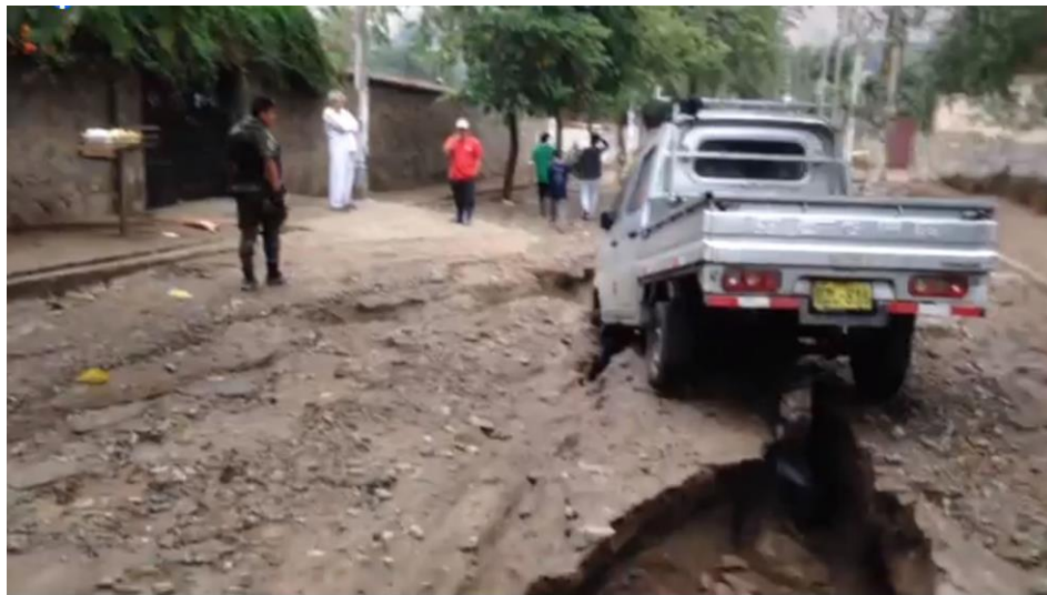
Fotografía 61. Zona crítica 15-012. Vía destruida por flujo de detritos que discurrió por la Av. El Sol, Urb. Santa Inés. Coordenadas UTM 18S E309175; N8675957 (Fuente: Exitosa Noticias, 2017).
