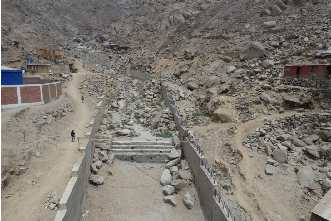
Fotografía 168. Zona crítica 15-052. Cauce de la quebrada Santo Domingo se encuentra colmatado de bloques. Coordenadas UTM 18S E315549; N8678777 (tomada el 06/10/2023).
