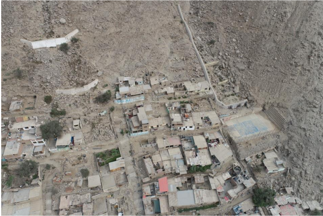
Fotografía 166. Zona crítica 15-051. Vista de los diques y muros de contención en la quebrada Virgen del Rosario requiere de limpieza. Coordenadas UTM 18S E315912; N8679589 (tomada el 05/10/2023).
