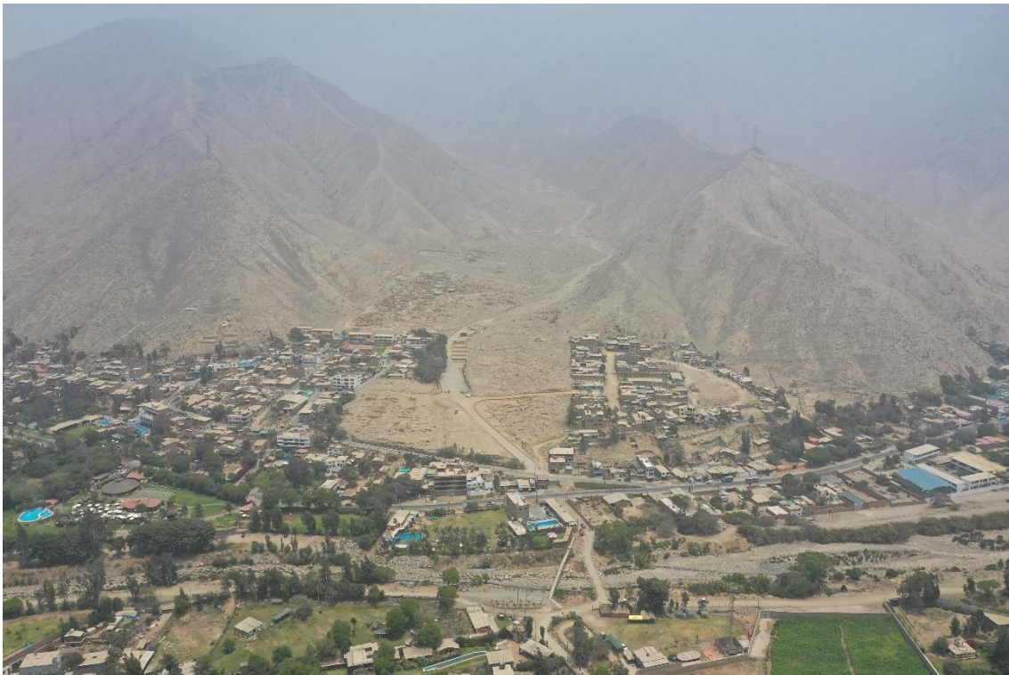
Fotografía 87. Zona crítica 15-021. Vista con dron de la quebrada Molle, la zona también afectada por flujo de detritos, viviendas de la Asoc. Jardines de Cieneguilla, zona agrícola de Molle y sector Ranchito se encuentran sobre depósito antiguo, en la parte baja es afectada por erosión fluvial, margen derecha del río Lurín. Coordenadas UTM 18S E307293; N8663797 (tomada el 28/11/2022).
