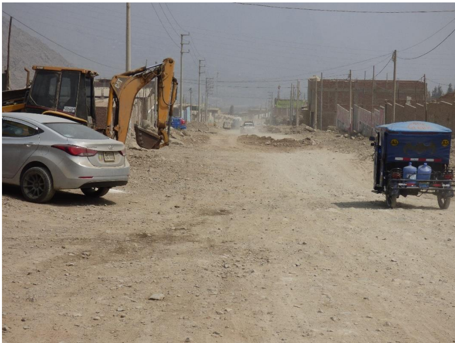
Fotografía 120. Zona crítica 15-035. Vía de la Av. Jicamarca y viviendas del sector El Mirador, Anexo 12 El Valle fueron afectadas por el paso de huaico proveniente de las quebradas Sucre, Los Andes y Vizcachera en marzo del 2023, las quebradas no tienen un cauce definido debido a la construcción de viviendas. Coordenadas UTM 18S E305244; N8677471 (tomada el 11/09/2023).
