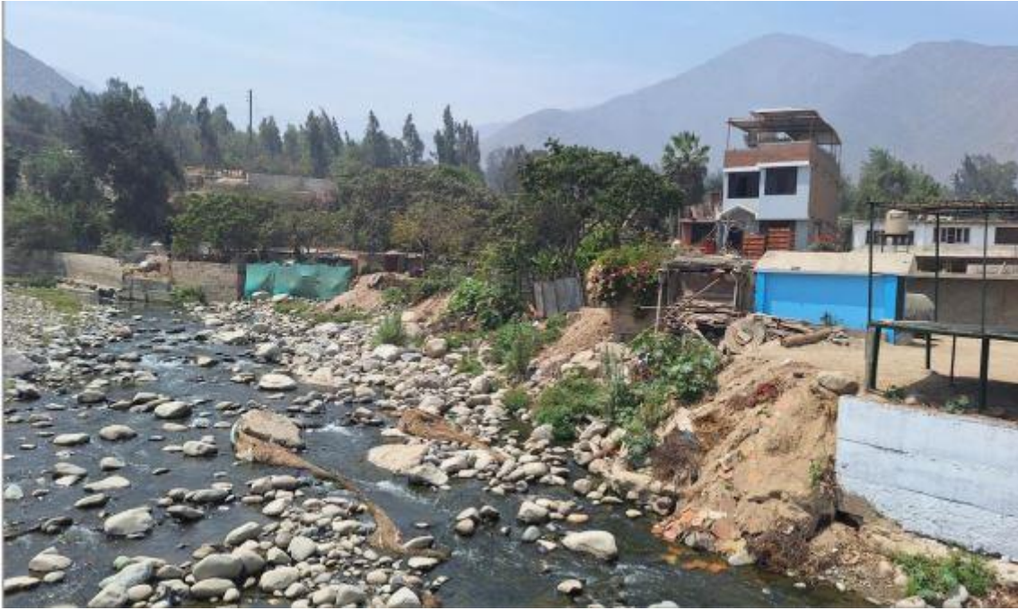
Fotografía 133. Zona crítica 15-040. Erosión fluvial en la margen izquierda del río Rímac, viviendas se encuentran muy cerca del borde y no cuentan con defensa ribereña, el cauce del río se encuentra colmatado. Coordenadas UTM 18S E311966; N8677960 (tomada el 29/09/2023).
