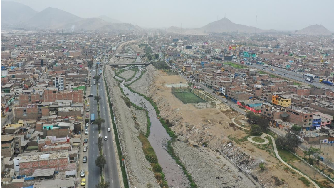
Fotografía 110. Zona crítica 15-028. Vista con dron aguas debajo de Puente Nuevo, se observa complejo deportivo del sector Los Jardines Ancieta Baja, sobre depósitos de relleno. Coordenadas UTM 18S E308974; N8657792 (tomada el 19/10/2022).
