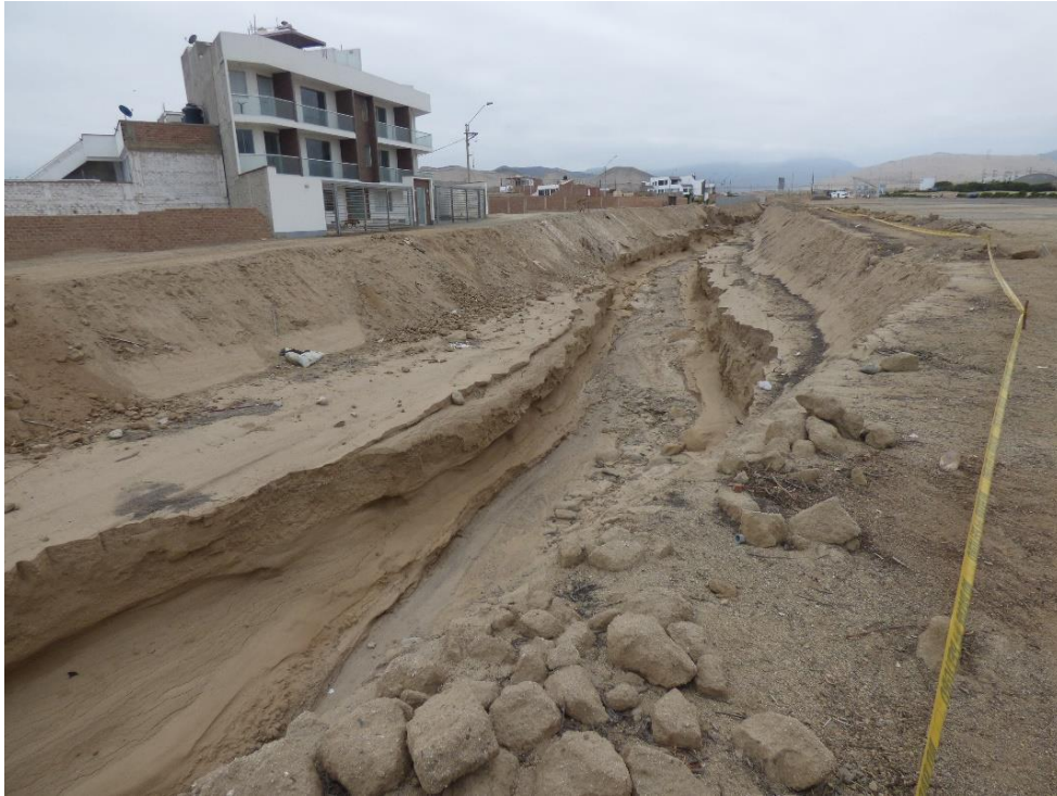
Fotografía 203. Zona crítica 15-071. Viviendas del A.H. Juventud del Bosque de Punta Negra a pocos metros del cauce de la quebrada Cruz de Hueso, margen derecha. Coordenadas UTM 18S E306005; N8630702. (Tomada el 17/08/2023).
