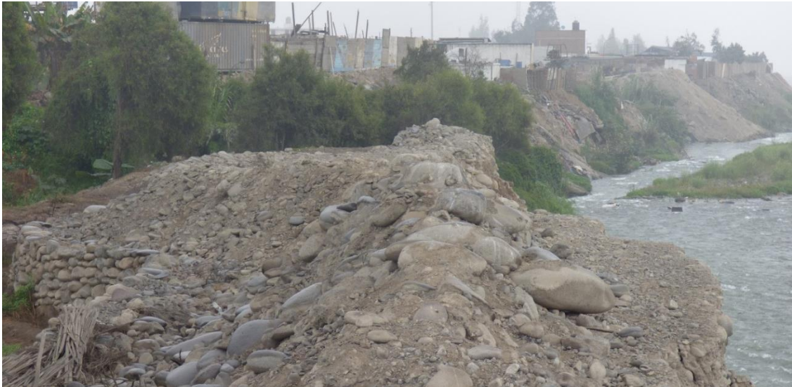
Fotografía 8. Depósitos antropogénicos en la margen izquierda del río Rímac, sobre el desmante se han asentado viviendas que se encuentran en peligros por erosión fluvial, ubicado aguas abajo del puente peatonal Carapongo en el distrito de Ate.
