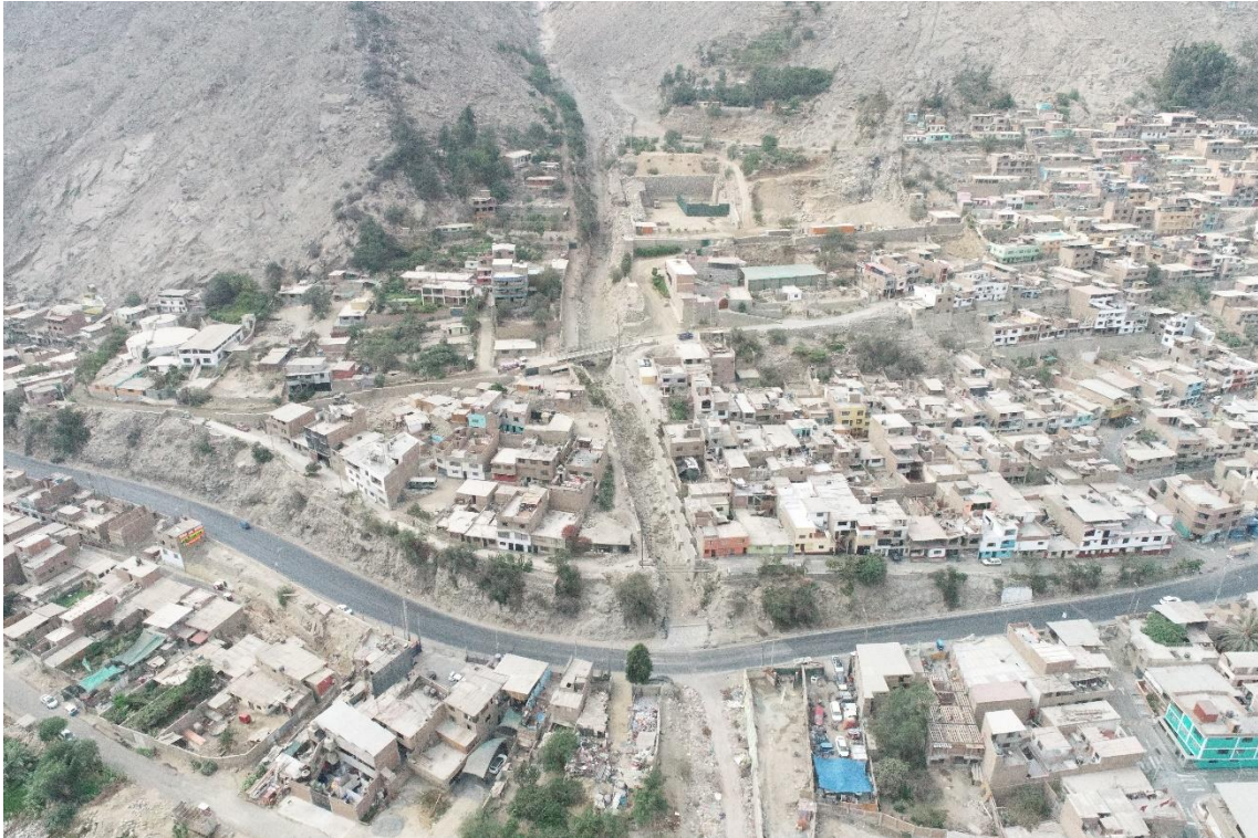
Fotografía 150. Zona crítica 15-046. Viviendas de la Asoc. Las Magnolias se ubican muy cerca de la quebrada Corrales. Coordenadas UTM 18S E316952; N8681426 (tomada el 24/11/2022).
