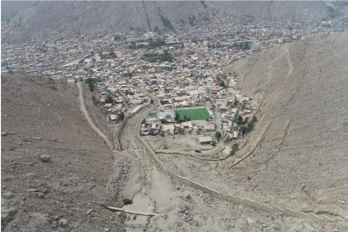
Fotografía 162. Zona crítica 15-050. Cauce de la quebrada Mariscal Castilla colmatado por el flujo de detritos del 14/03/2023, se ha colocado muros de contención en ambas márgenes. Coordenadas UTM 18S E316482; N8679979 (tomada el 05/10/2023).
