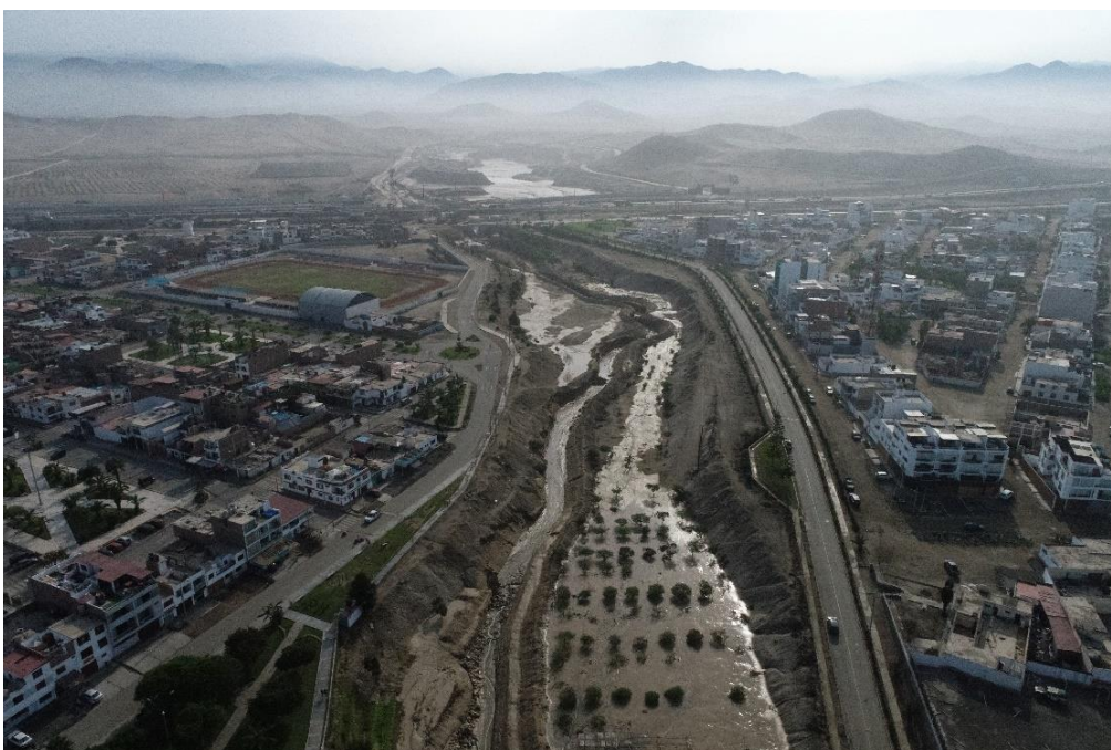
Fotografía 192. Zona crítica 15-066. Vista aguas arriba tomada con dron del flujo de lodo del 14/03/2023 que discurrió por la quebrada Malanche. Coordenadas UTM 18S E301540; N8635545 (Tomada el 17/08/2023).
