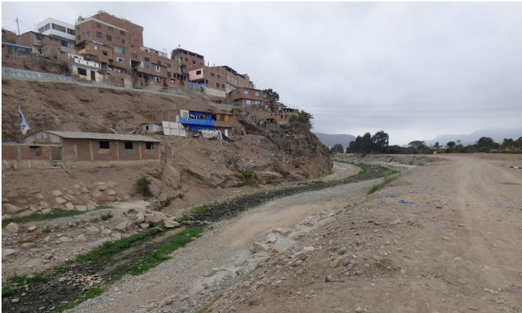
Fotografía 186. Zona crítica 15-063. Erosión fluvial en ambas márgenes del río Lurín, en la margen derecha se encuentran viviendas del sector Puente Lurín Coordenadas UTM 18S E293927; N8644790 (tomada el 05/09/2023).
