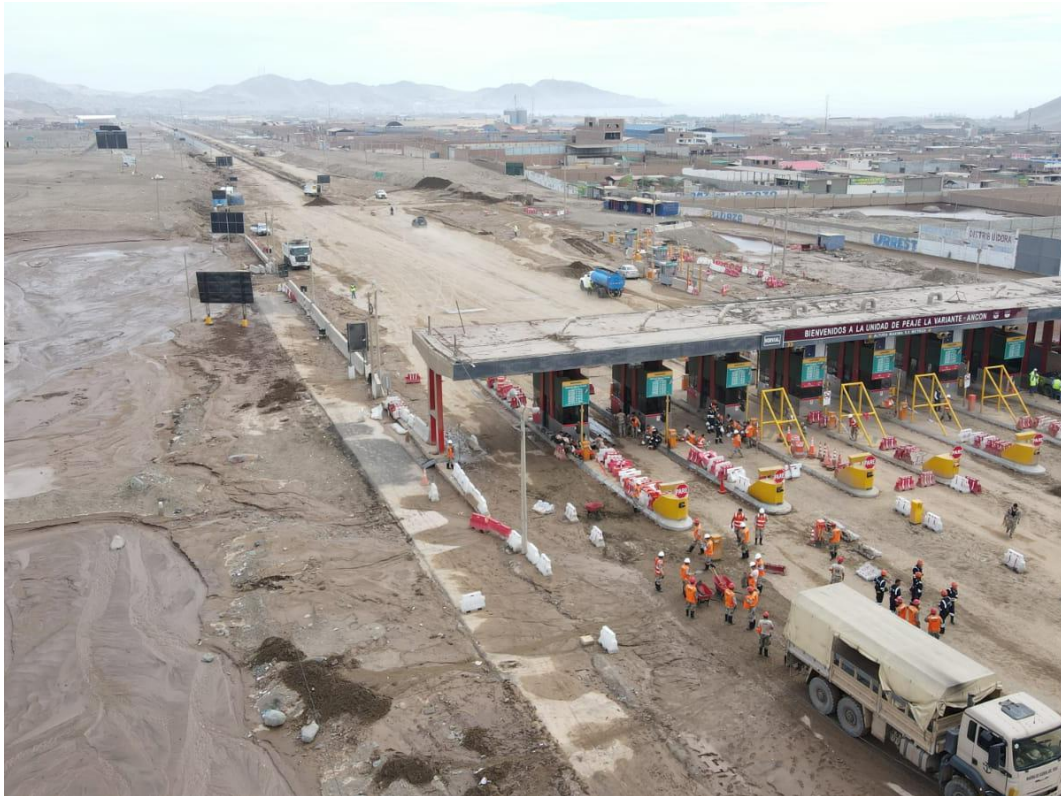
Fotografía 42. Zona crítica 15-001. Peaje de Ancón en el km 47 de la carretera Panamericana Norte afectado por un flujo de lodo que se generaron en las quebradas Los Inocentes y Río Seco por influencia del ciclón Yaku. Coordenadas UTM 18S E301540; N8635545 (Fuente: Diario Gestión, 15/03/2023).
