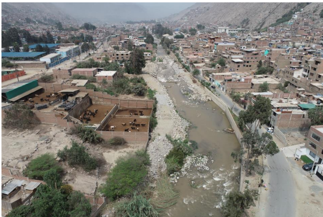
Fotografía 156. Zona crítica 15-048. Vista aguas abajo del río Rímac, sector Cooperativa Pablo Patrón, en la margen izquierda puede afectar viviendas y establos; se ha colocado muro de contención en la margen derecha, el cauce se encuentra colmatado. Coordenadas UTM 18S E316629; N8681042 (tomada el 06/10/2023).
