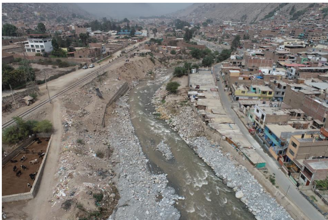
Fotografía 157. Zona crítica 15-048. Vista del río Rímac, en el sector Cooperativa Pablo Patrón, en la margen izquierda se observa parte de la vía férrea se encuentra sobre depósito de relleno, y en la margen derecha puede afectar algunas viviendas. Coordenadas UTM 18S E316629; N8681042 (tomada el 06/10/2023).
