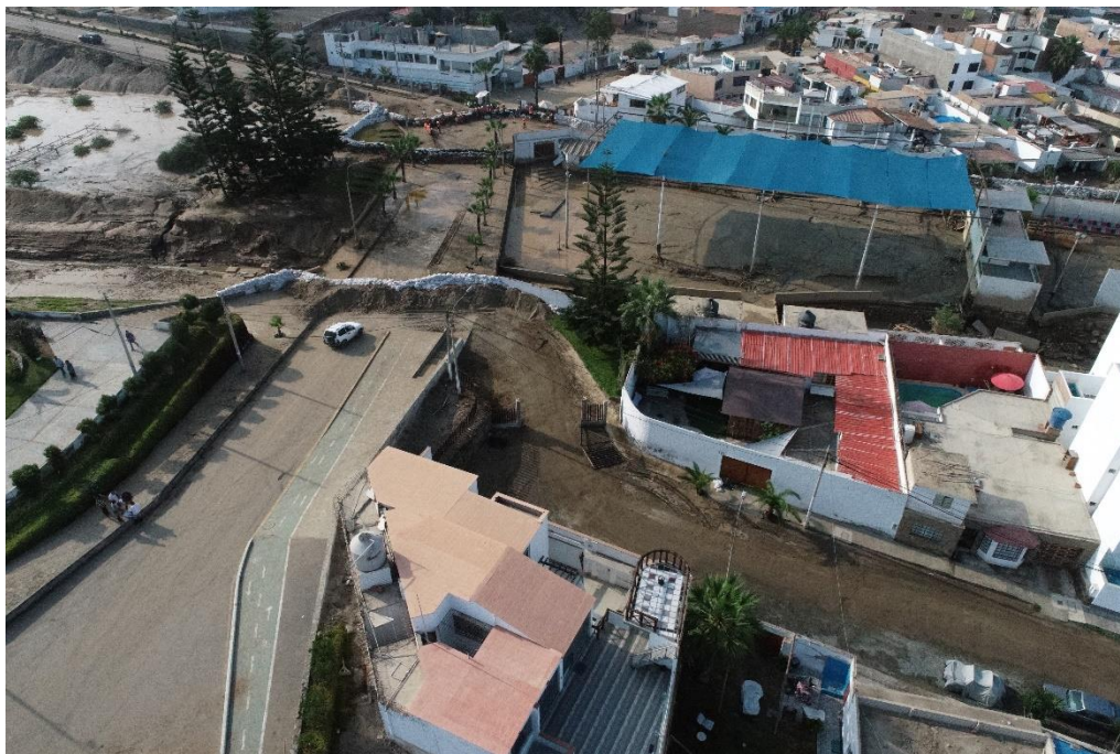
Fotografía 194. Zona crítica 15-066. Vista aguas arriba tomada con dron del flujo de lodo del 14/03/2023 que discurrió por la quebrada Malanche a la altura del puente y complejo deportivo Municipal. Coordenadas UTM 18S E301540; N8635545 (Tomada el 17/08/2023).
