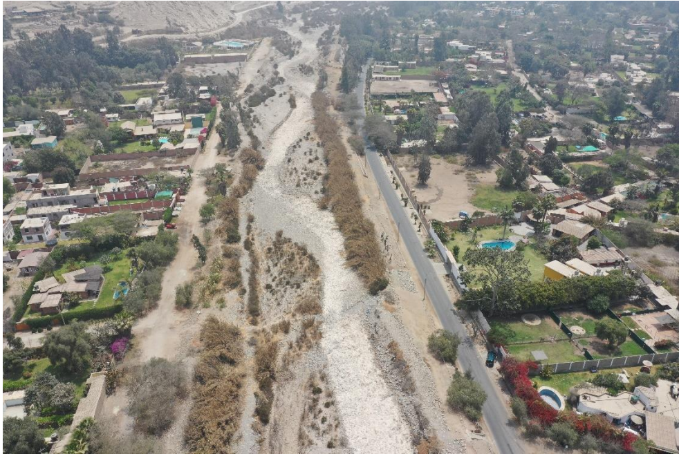
Fotografía 90. Zona crítica 15-022. Vista con dron del puente Panquilma se puede observar el cauce del río Lurín colmatado y las zonas que quedan expuestas como la vía hacia Manchay y viviendas. Coordenadas UTM 18S E306667; N8662420 (tomada el 28/10/2022).
