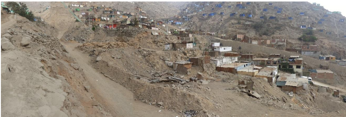
Fotografía 47. Zona crítica 15-004. Viviendas construidas sobre depósitos de relleno en forma de terrazas en el sector Ampliación 238B de la zona X de Huaycán, confluencia de dos quebradas con el cauce obstruido por el terraceo. Coordenadas UTM 18S E302252; N8669122 (Tomada el 12/09/2023).
