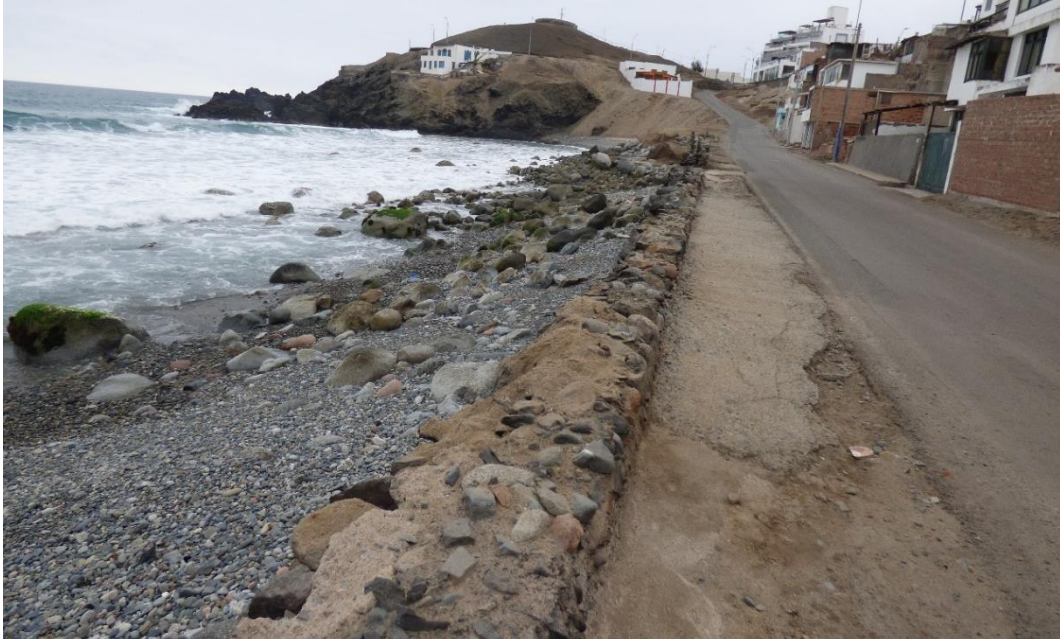
Fotografía 37. Playa Sur en el distrito de San Bartolo. Se observan cómo las aguas están erosionando la playa de cantos y socavando los muros de protección.
