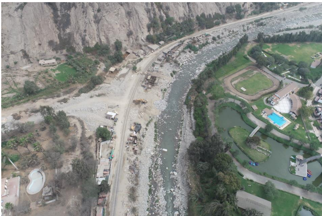
Fotografía 173. Zona crítica 15-054. Aguas abajo del puente Caracol, el cauce se encuentra colmatado, no cuenta con defensa ribereña y en la margen izquierda se observa un depósito de flujo de detritos de la quebrada La Cantuta. Coordenadas UTM 18S E313642; N8678415 (tomada el 06/10/2023).
