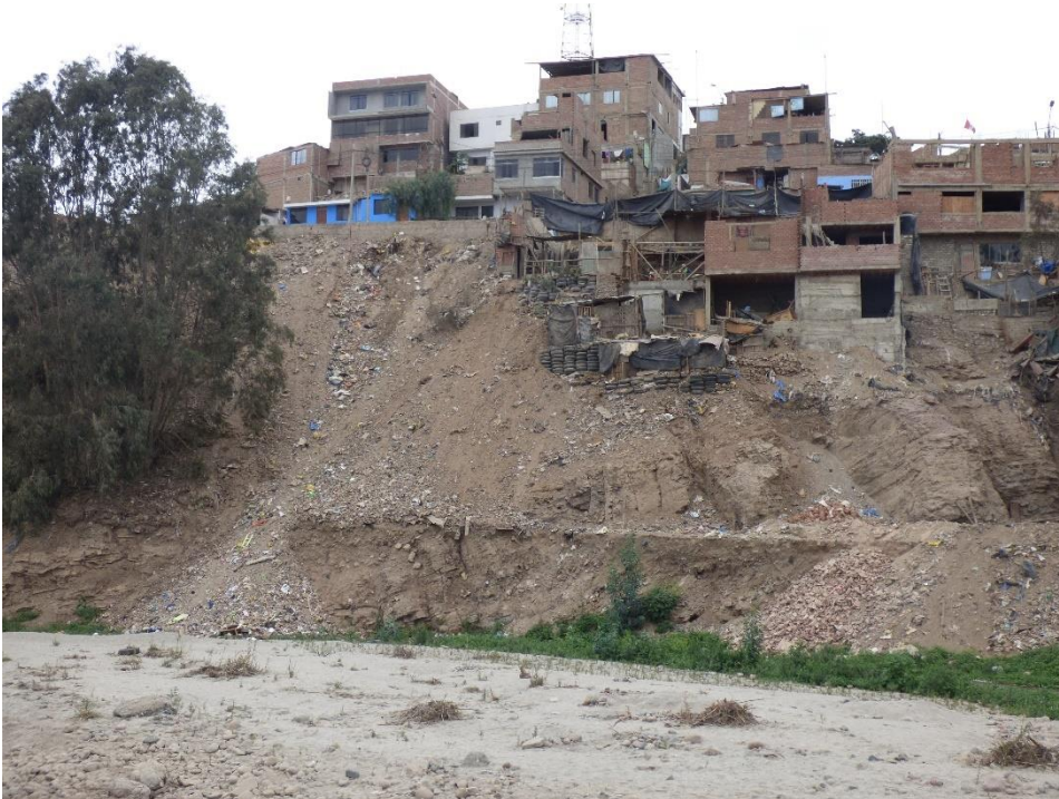
Fotografía 187. Zona crítica 15-063. Erosión fluvial en la margen derecha del río Lurín, la socavación de la ladera puede afectar viviendas del sector Puente Lurín (Coordenadas UTM 18S E293947; N8644895 (tomada el 05/09/2023).
