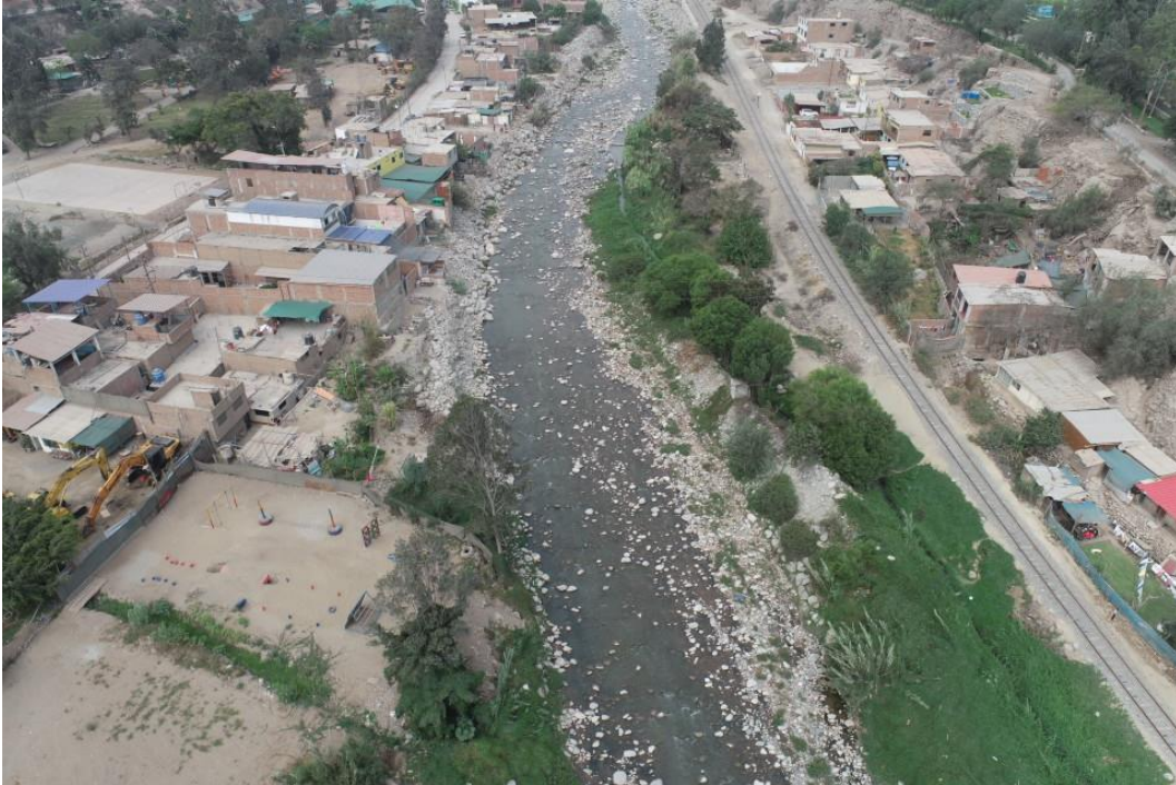
Fotografía 176. Zona crítica 15-055. Erosión fluvial en la margen derecha del río Rímac puede afectar viviendas del sector Santa María de Campanillas y en la margen derecha la vía férrea, no cuenta con defensa ribereña. Coordenadas UTM 18S E312527; N8678178 (tomada el 06/10/2023).
