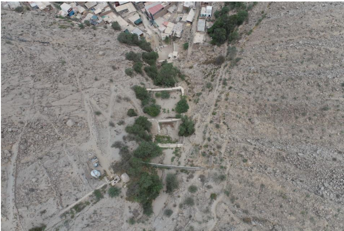
Fotografía 140. Zona crítica 15-043. Vista con dron, se observa los diques disipadores de energía colmatados en la quebrada La Libertad. Coordenadas UTM 18S E315366; N8680644 (tomada el 05/10/2023).
