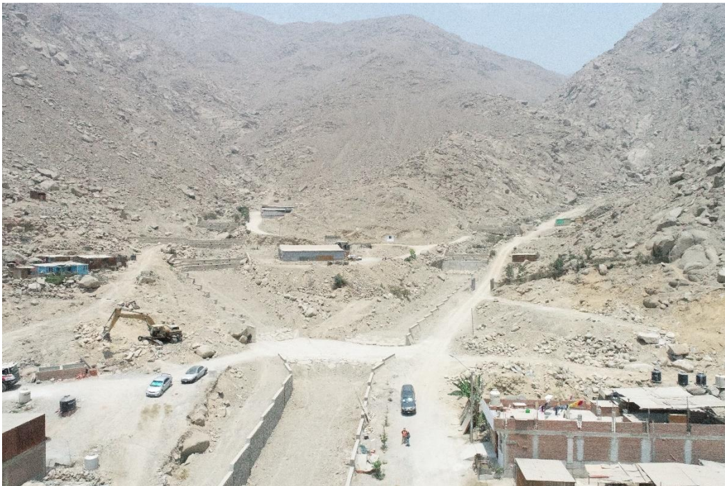
Fotografía 128. Zona crítica 15-039. Vista aguas arriba de la quebrada Chacrasana. Se observa canalización de la quebrada en un tramo. Coordenadas UTM 18S E309711; N8678061 (tomada con dron el 24/11/2022).
