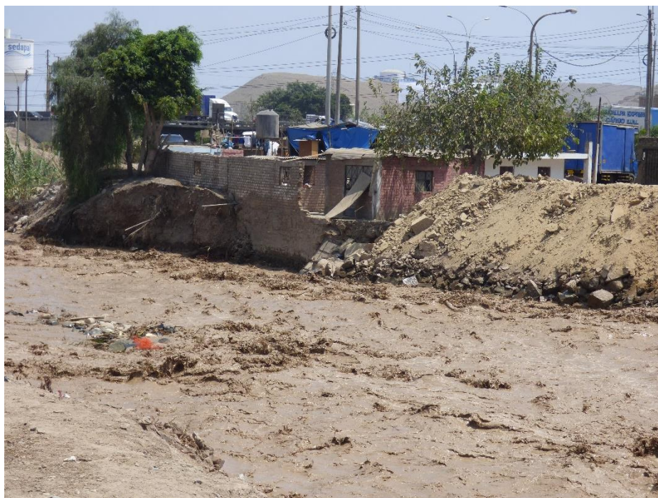
Fotografía 53. Zona crítica 15-008. Erosión fluvial en la margen derecha del río Chillón, durante las lluvias por el Ciclón Yaku afectó viviendas del sector Los Suyos (Carabaylo). Coordenadas UTM 18S E278847; N8687835 (Tomada el 20 /03/2023).
