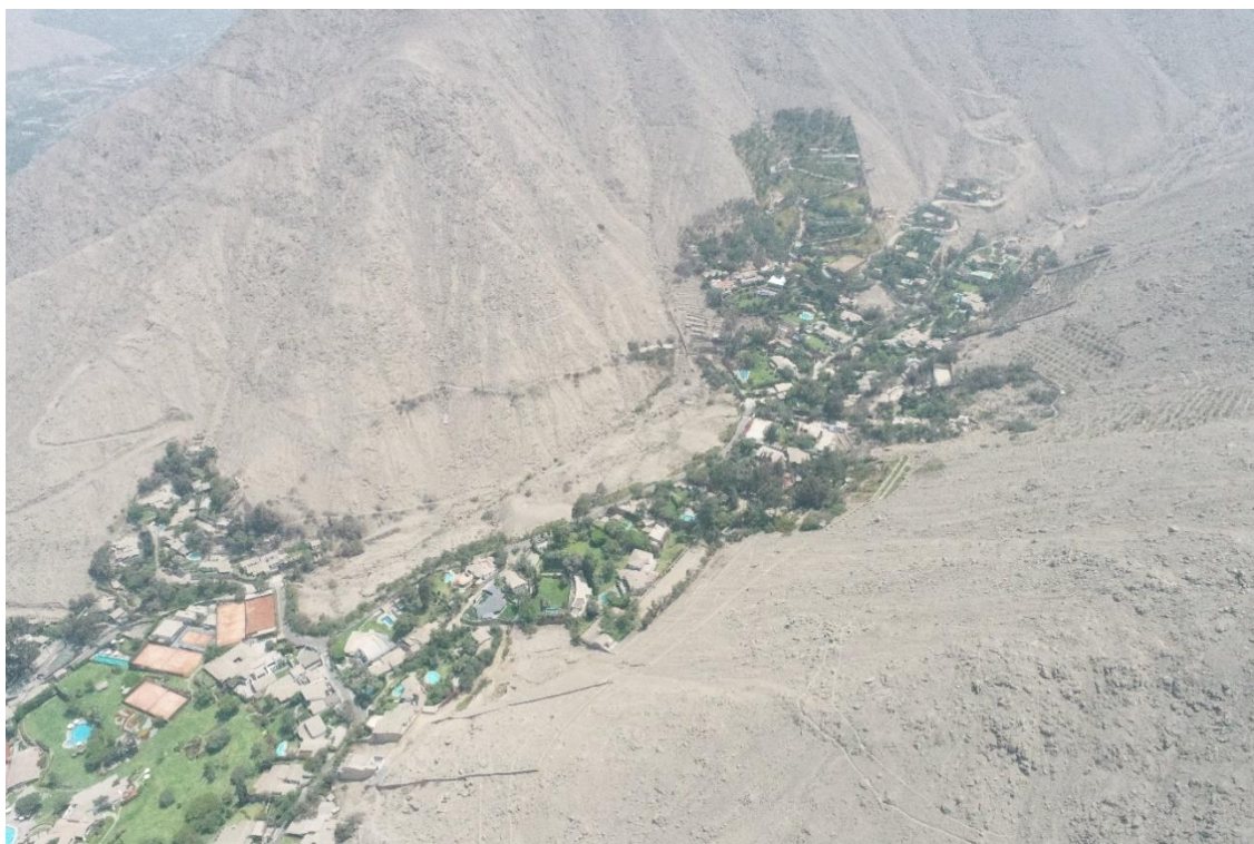
Fotografía 58. Zona crítica 15-011. Vista tomada con dron de la quebrada Los Cóndores, viviendas de zona residencial se encuentran asentadas sobre esta quebrada y vertientes tributarias. Coordenadas UTM 18S E309839; N8675982 (Tomada el 25/11/2022).
