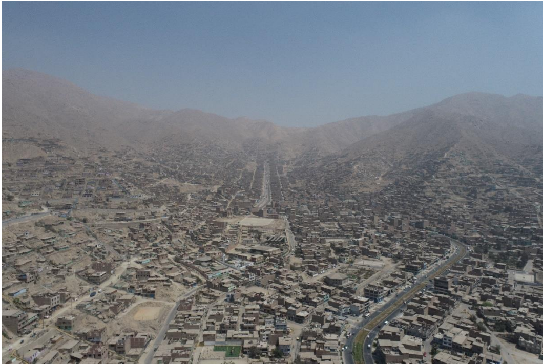
Fotografía 46. Zona crítica 15-003. Vista con dron hacia el sur de la Zona T de Huaycán que fue afectado por flujo de lodo del 14/03/2023, que discurrió por quebrada cuyo cauce fue obstruido por la construcción de viviendas, el cual se receptó en la Av. Andrés Avelino Cáceres. Coordenadas UTM 18S E303386; N8669531 (Tomada el 10/11/2022).
