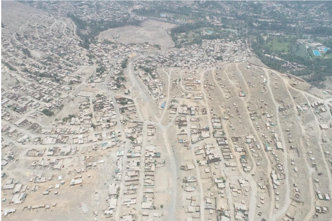
Fotografía 131. Zona crítica 15-040. Vista con dron de la quebrada Santa María, no se observa ninguna infraestructura de mitigación ante huaicos que puede afectar aguas abajo al sector Yanacoto y carretera Central. Coordenadas UTM 18S E311716; N8678760 (tomada el 24/11/2022).
