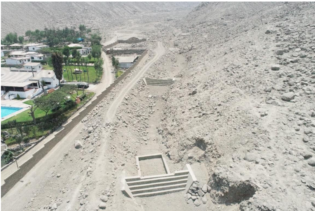
Fotografía 65. Zona crítica 15-013. Vista tomada con dron de los diques colocados en la quebrada Cusipata. Coordenadas UTM 18S E307015; N8674561 (tomada el 25/11/2022).
