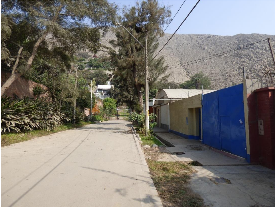
Fotografía 60. Zona crítica 15-012. Viviendas de la calle Santa Inés fueron afectadas por huaico que discurre de quebrada del mismo nombre. Coordenadas UTM 18S E308975; N8675547 (Tomada el 11/09/2023).
