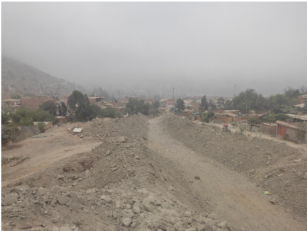
Fotografía 132. Zona crítica 15-040. Quebrada Santa María se ha realizado limpieza de cauce y arrimado de material hacia sus márgenes, reduciendo el ancho del cauce. Coordenadas UTM 18S E311716; N8678760 (tomada el 20/09/2023).
