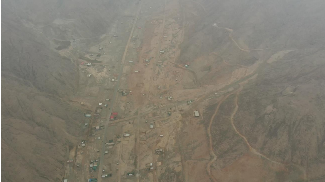
Fotografía 213. Zona crítica 15-075. Viviendas de la Asoc. Villa Jicamarca (Chancadora) se ubican sobre depósitos proluviales de la quebrada Jicamarca y tributarios. Coordenadas UTM 18S E290045; N8686050. (Tomada el 20/03/2023).
