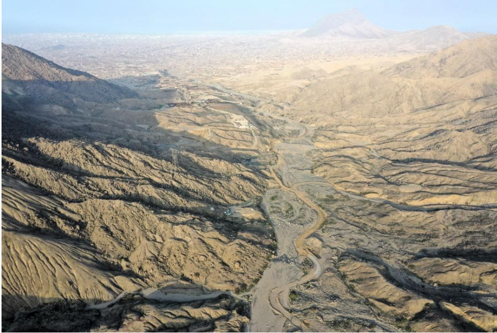
Fotografía 3. Zona crítica 13-001. Ocurrencias de flujos de detritos en la quebrada San Idelfonso que podría afectar los distritos de El Porvenir, Alto Trujillo, Florencia Mora, Trujillo y Víctor Larco Herrera. Coordenadas UTM: 720412 / 9107649, Zona 17. Tomado el 18-04-2023.
