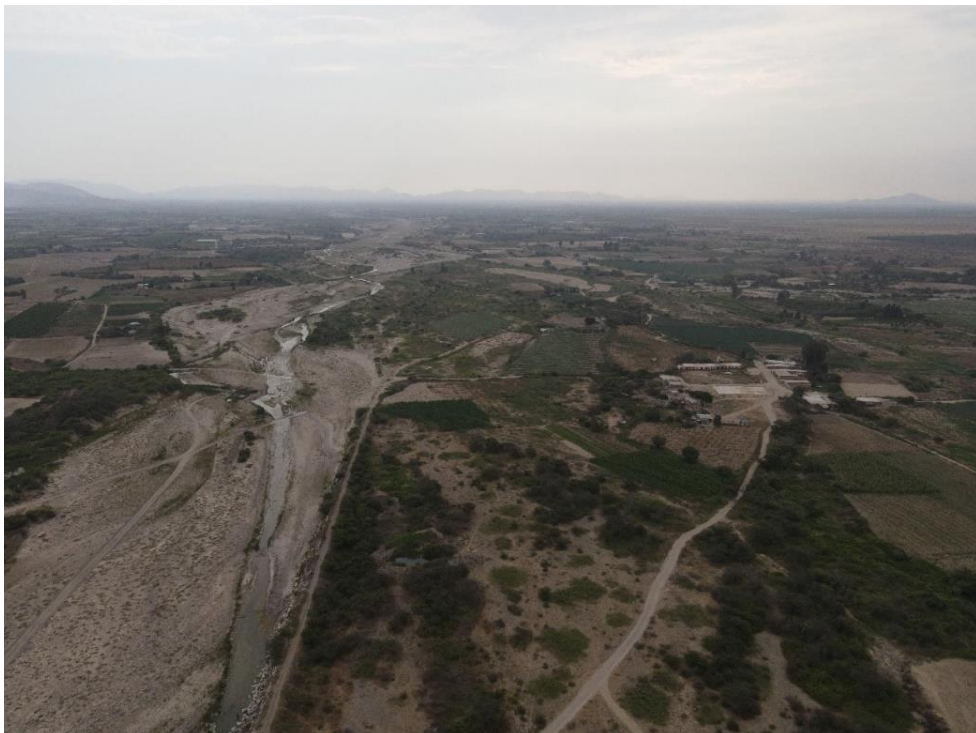
Fotografía 76. Zona crítica 13-041. Viviendas del centro poblado de Huaca Blanca Alta ubicados en la margen derecha del río Loco de Chamán en proceso de reubicación (distrito de Pacanga). Coordenadas UTM: 682106 / 9210291, Zona 17. Tomado el 26-09-2023.
