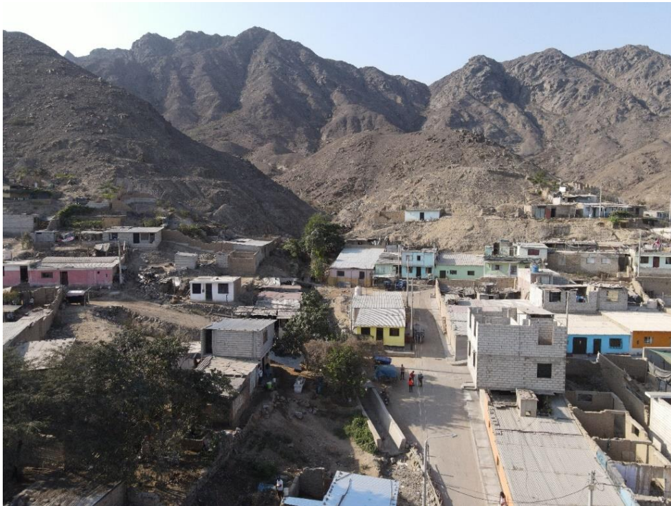
Fotografía 50. Zona crítica 13-026. Cauce de quebrada en el asentamiento humano Víctor Raúl y viviendas construidas sobre depósitos de flujos de detritos (distrito de Ascope). Coordenadas UTM: 708685 / 9147243, Zona 17. Tomado el 22-09-2023.
