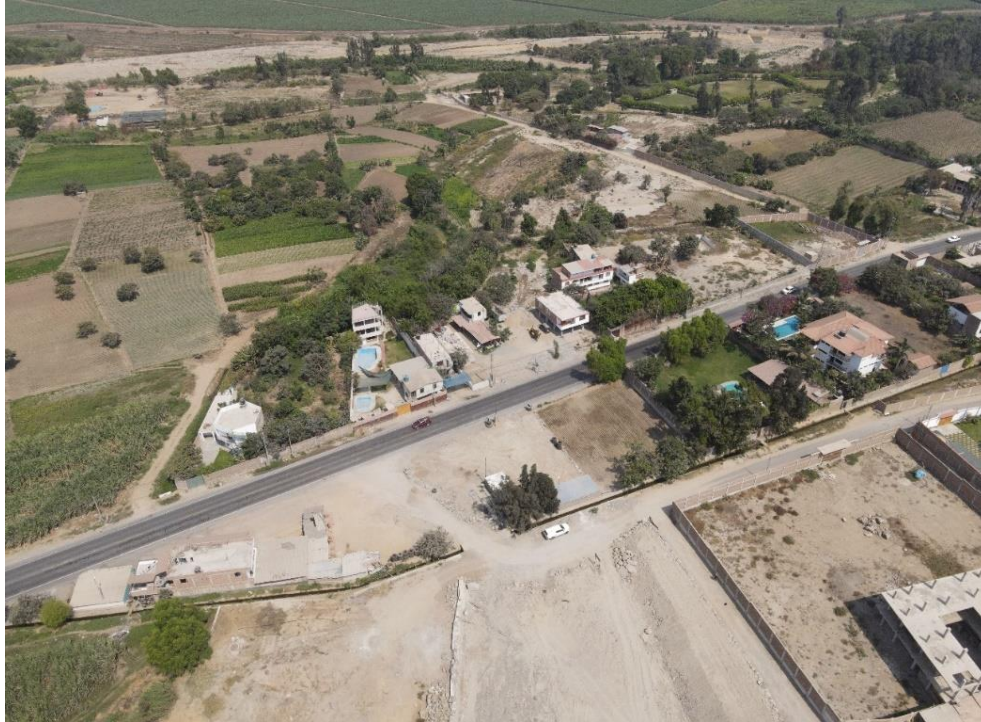
Fotografía 23. Zona crítica 13-010. Viviendas en el sector Bello Horizonte construidas en cauce de quebrada que obstruyen el paso libre de flujos de agua y flujos de detritos (distrito de Laredo).
