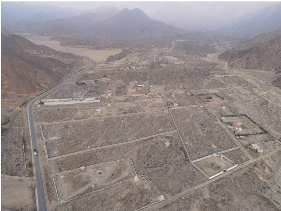
Fotografía 28. Zona crítica 13-014. Espacios lotizados para viviendas ubicados en el cauce la quebrada León; también, se aprecian múltiples torrenteras que se activan con precipitaciones pluviales (distrito de Poroto). Coordenadas UTM: 741084 / 9107463, Zona 17. Tomado el 14-09-2023.
