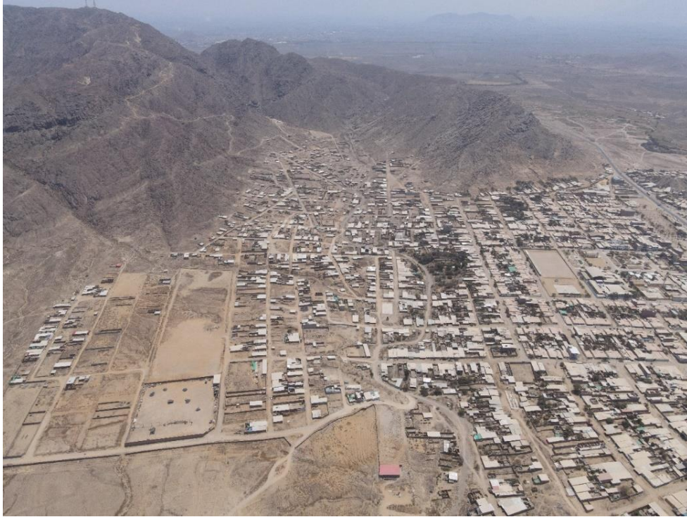
Fotografía 101. Zona crítica 13-056. Cauce de la quebrada Víctor Raúl que cruza los centros poblados de Ciudad de Dios y Faclo Chico (distrito de Guadalupe). Coordenadas UTM: 667296 / 9192785, Zona 17. Tomado el 24-09-2023.
