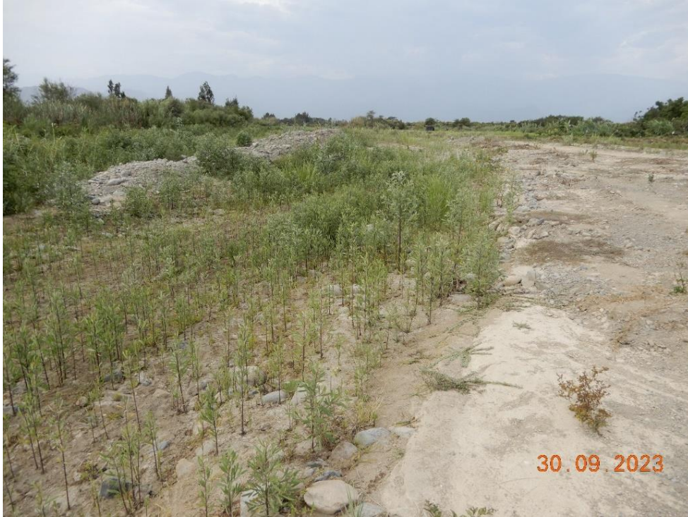
Fotografía 133. Zona crítica 13-077. Cauce colmatado de río Cerro Blanco ubicado aguas arriba del Sector El Inca (distrito de Chao). Coordenadas UTM: 758459 / 9058676, Zona 17. Tomado el 30-09-2023.
