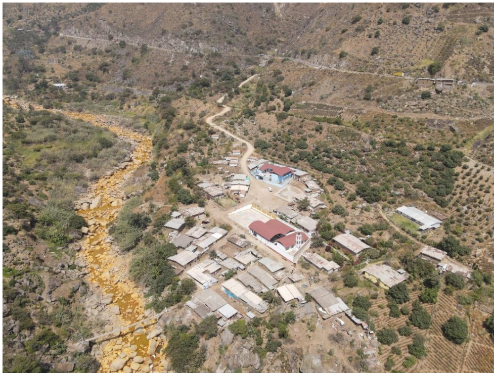
Fotografía 95. Zona crítica 13-052. Viviendas del sector El Ángulo asentada sobre depósitos de flujos de detritos (distrito de Salpo). Coordenadas UTM: 757925 / 9116139, Zona 17. Tomado el 14-09-2023.
