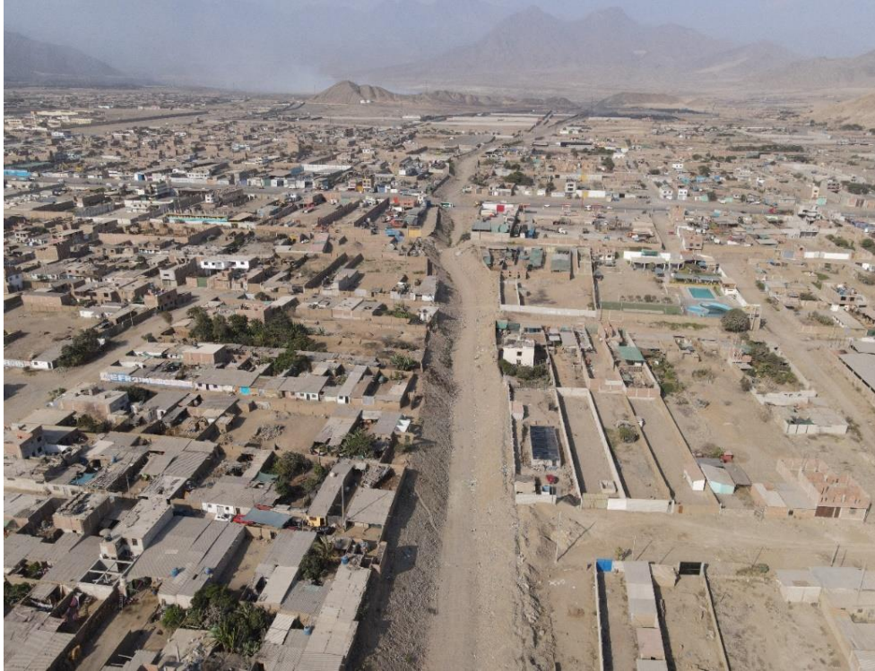
Fotografía 9. Zona crítica 13-004. Apertura de canal sin revestimiento en el sector del A. H. Virgen del Socorro, distrito de Huanchaco. Coordenadas UTM: 713545 / 9110690, Zona 17. Tomado el 13-09-2023.
