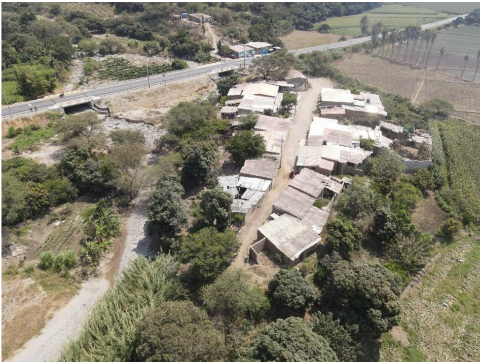
Fotografía 68. Zona crítica 13-037. Viviendas del sector Zapotal asentada en la margen izquierda de la quebrada De la Salinas susceptibles a erosión fluvial (distrito de Chepén). Coordenadas UTM: 688191 / 9195433, Zona 17. Tomado el 25-09-2023.
