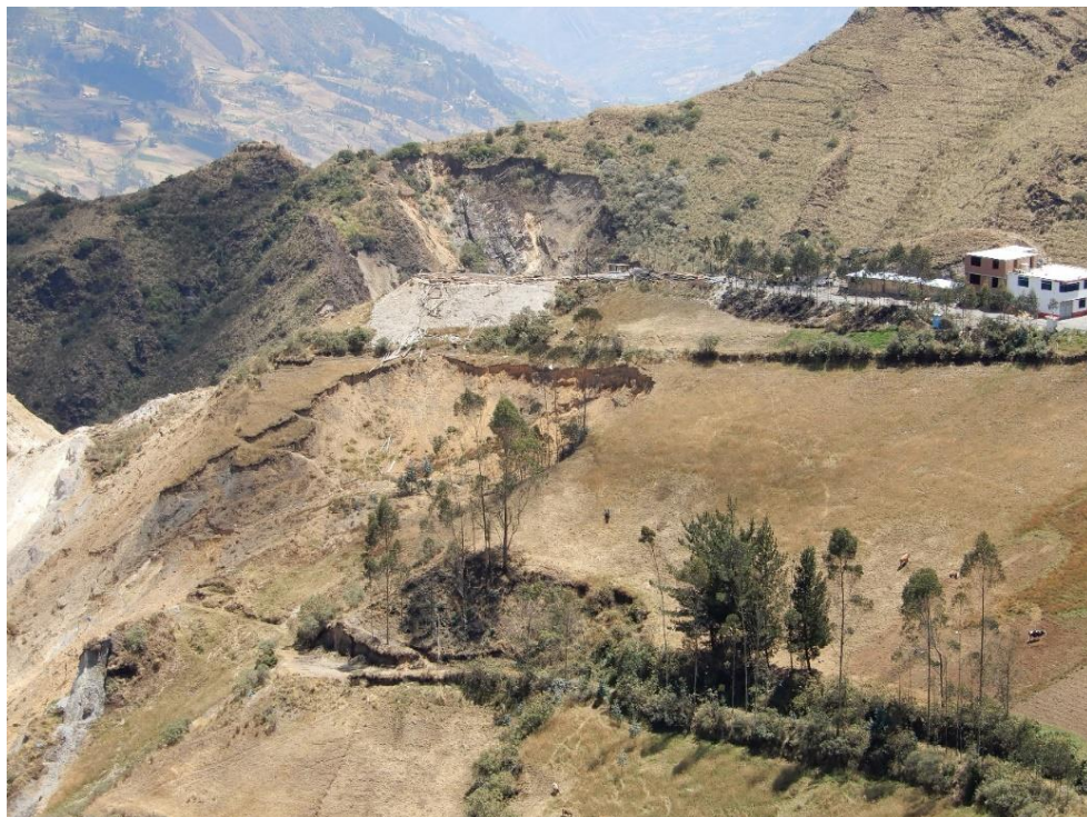
Fotografía 109. Zona crítica 13-059. Viviendas asentadas en la parte superior de la escarpa principal de deslizamiento rotacional. Caserío La Victoria, distrito de Quiruvilca. Coordenadas UTM: 798420 / 9125891, Zona 17. Tomado el 18-09-2023.
