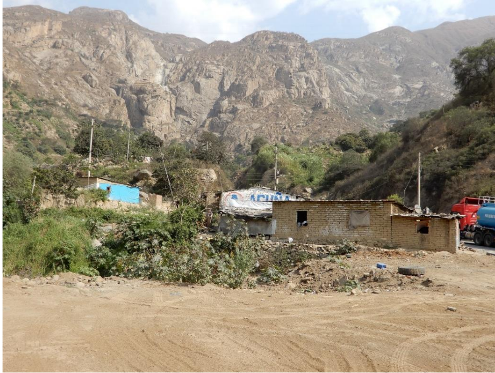
Fotografía 25. Zona crítica 13-012. Las viviendas asentadas sobre flujos de detritos y en la desembocadura de la quebrada en Miñate (distrito de Poroto). Coordenadas UTM: 750618 / 9113361, Zona 17. Tomado el 14-09-2023.
