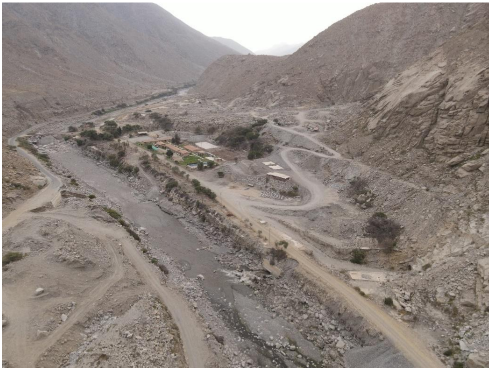
Fotografía 136. Zona crítica 13-079. Campamento del proyecto Chavimochic ubicado en la margen derecha del río Santa (distrito de Chao)
