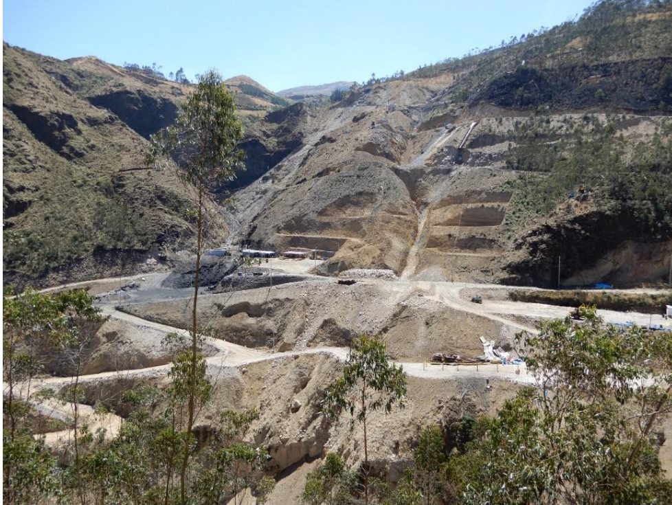
Fotografía 108. Zona crítica 13-059. Vista panorámica del caserío La Victoria donde ocurrió deslizamiento (distrito de Quiruvilca). Coordenadas UTM: 798420 / 9125891, Zona 17. Tomado el 18-09-2023.
