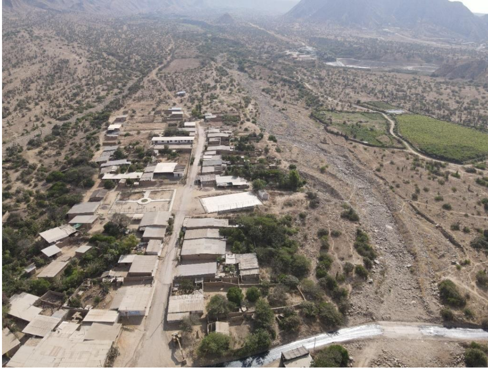
Fotografía 120. Zona crítica 13-067. Viviendas del sector Cerro Negro ubicadas en la margen derecha del cauce principal de la quebrada Arrancamachete (distrito de Marmot). Coordenadas UTM: 754330 / 9159189, Zona 17. Tomado el 21-09-2023.
