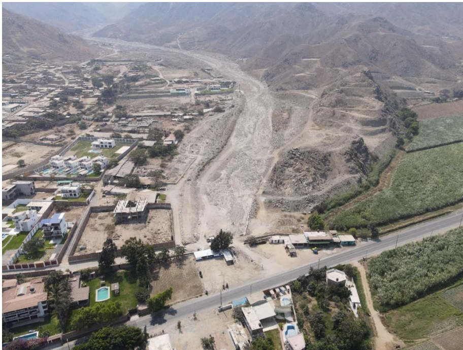
Fotografía 22. Zona crítica 13-010. Se observa viviendas del sector Bello Horizonte asentadas sobre depósitos de flujos de detritos y en la margen derecha del cauce de la quebrada. También se aprecia trabajos que podrían ser afectadas por erosión fluvial (distrito de Laredo). Coordenadas UTM: 736350 / 9108599, Zona 17. Tomado el 11-09-2023.
