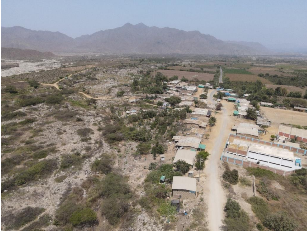
Fotografía 129. Zona crítica 13-074. Viviendas del sector de Huamanzaña ubicada en la margen izquierda del río Huaraday que pueden ser afectadas por erosión fluvial (distrito de Chao). Coordenadas UTM: 775392 / 9059625, Zona 17. Tomado el 29-09-2023.
