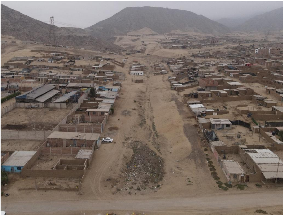
Fotografía 44. Zona crítica 13-022. Cauce de la quebrada Betel colmatado de depósitos eólicos; además en el cauce se observa construcción de viviendas. También se observa el encausamiento provisional (distrito de Alto Trujillo). Coordenadas UTM: 719242 / 9110143, Zona 17. Tomado el 12-09-2023.
