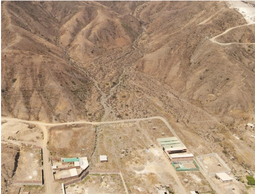
Fotografía 30. Zona crítica 13-015. Zona de arranque de las ocurrencias de flujos de detritos que se activan ante lluvias excepcionales. También se observa parte de las viviendas del centro poblado Cajamarca construidas sobre los depósitos de huaicos antiguos (distrito de Simbal). Coordenadas UTM: 741476 / 9119057, Zona 17. Tomado el 15-09-2023.
