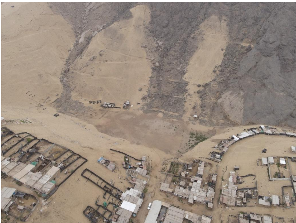
Fotografía 42. Zona crítica 13-021. Viviendas del sector Pedro Ordoño ubicadas en el borde de una depresión conformada por depósitos eólicos y susceptible a inundación (distrito de Alto Trujillo). Coordenadas UTM: 716637 / 9108526, Zona 17. Tomado el 12-09-2023.
