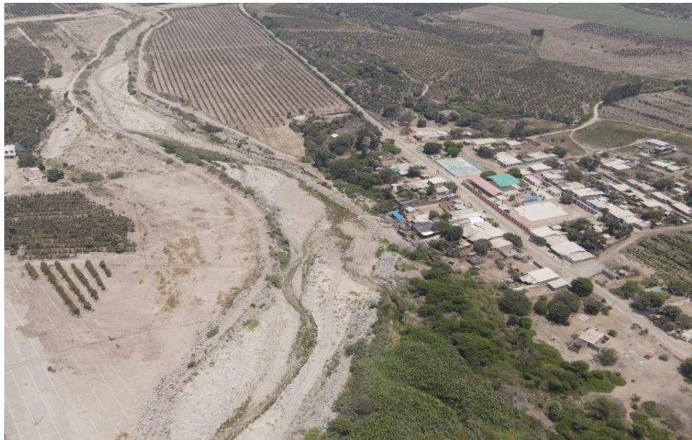
Fotografía 130. Zona crítica 13-075. Viviendas del sector de Monte Grande ubicado en la margen derecha del río Huamanzaña que pueden ser afectadas por erosión fluvial (distrito de Chao). Coordenadas UTM: 765941 / 9061938, Zona 17. Tomado el 29-09-2023.
