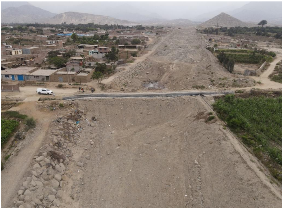
Fotografía 20. Zona crítica 13-009. Vista aguas arriba, se observa viviendas asentadas sobre depósitos de flujo de detritos en la margen derecha de la quebrada San Carlos que podrían ser afectadas por erosión fluvial (distrito de Laredo). Coordenadas UTM: 726849 / 9106756, Zona 17. Tomado el 11-09-2023.
