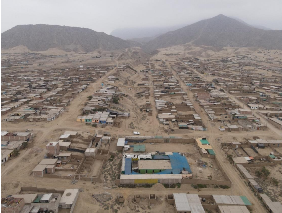
Fotografía 45. Zona crítica 13-023. Cauce de la quebrada Río Verde sobre depósitos eólicos. En sus márgenes se observa viviendas susceptibles a ser afectadas por erosión fluvial y flujos de lodos (distrito de Alto Trujillo). Coordenadas UTM: 719949 / 9110058, Zona 17. Tomado el 12-09-2023.
