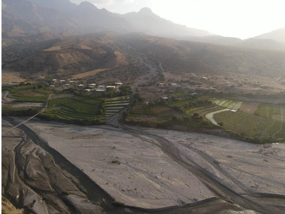
Fotografía 118. Zona crítica 13-066. Viviendas del sector Septen asentadas sobre depósitos de flujos de detritos y en la desembocadura de la quebrada Salavin: (distrito de Marmot)
