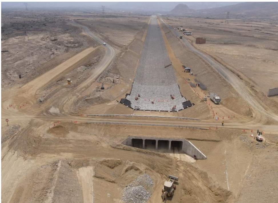
Fotografía 12. Zona crítica 13-005. Canal en construcción que pasa por la confluencia de las quebradas Del León, La Encantada y Río Seco que podría desbordarse y generar inundaciones en distrito de Huanchaco y La Esperanza. También, se observa la construcción de alcantarilla para el pase de vehículo motorizados Coordenadas UTM: 716423 / 9114475, Zona 17. Tomado el 13-09-2023.
