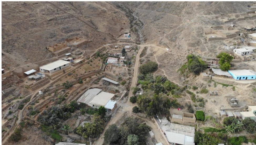
Fotografía 40. Zona crítica 13-020. Viviendas del sector Cruz Blanca asentadas sobre depósitos de flujos de detritos y ubicadas en las riberas del cauce principal de la quebrada susceptibles a erosión fluvial (distrito de Simbal). Coordenadas UTM: 742237 / 9113527, Zona 17. Tomado el 15-09-2023.
