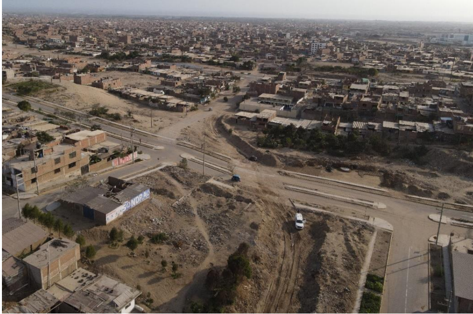
Fotografía 15. Zona crítica 13-006. Vista aguas debajo de la ruta del flujo de lodo que se originó en quebrada Las Palmeras durante el ciclón Yaku y que afectó las calles del distrito La Esperanza. Coordenadas UTM: 715013 / 9109554, Zona 17. Tomado el 13-09-2023.
