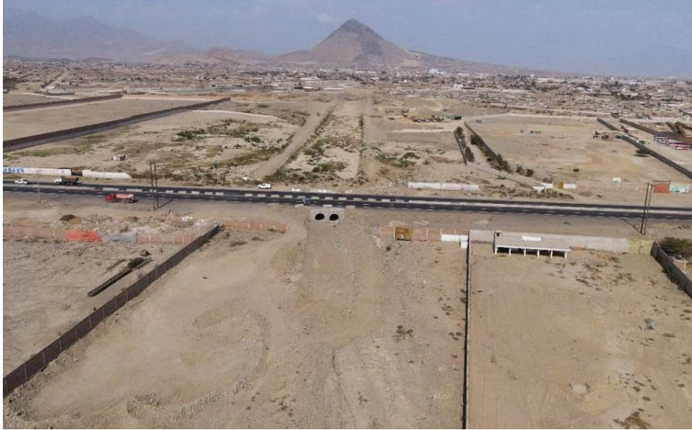
Fotografía 7. Zona crítica 13-003. Vista aguas arriba del canal aperturado sin revestimiento y las alcantarillas circulares construidas para el pase de agua por la carretera Panamericana Norte, sector A. H. Virgen del Socorro, distrito de Huanchaco. Coordenadas UTM: 711040 / 9110183, Zona 17. Tomado el 13-09-2023.
