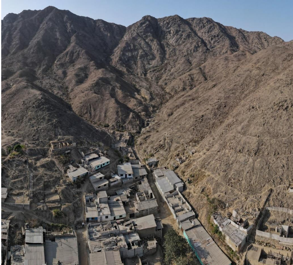
Fotografía 51. Zona crítica 13-027. Cauce de la quebrada Catan, ocupadas por viviendas, la quebrada no tiene drenaje (distrito de Ascope). Coordenadas UTM: 708814 / 9147318, Zona 17. Tomado el 22-09-2023.
