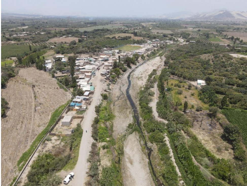
Fotografía 131. Zona crítica 13-076. Viviendas del sector de Palermo ubicada en la margen izquierda del río Cerroblanco que pueden ser afectadas por erosión fluvial (distrito de Chao).
