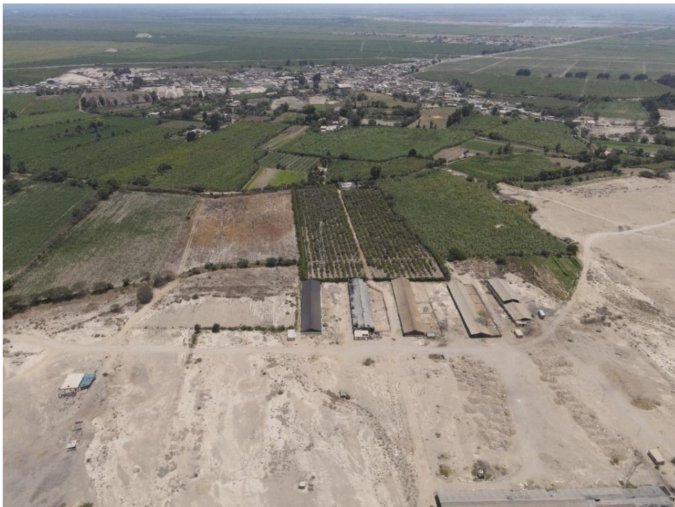
Fotografía 56. Zona crítica 13-030. Vista panorámica de las viviendas del pueblo de Chicama (distrito de Chicama). Coordenadas UTM: 706171 / 9132317, Zona 17. Tomado el 20-09-2023.
