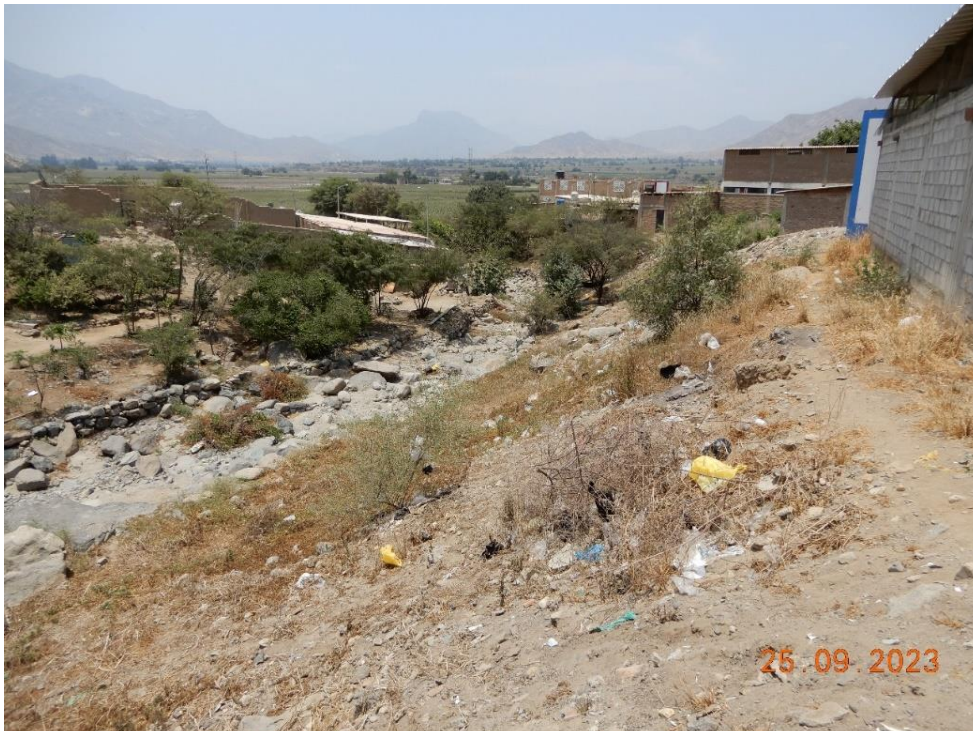
Fotografía 72. Zona crítica 13-039. Cauce de quebrada que cruza el poblado Huabal sin defensas ribereñas estables (distrito de Chepén). Coordenadas UTM: 685051 / 9193779, Zona 17. Tomado el 25-09-2023.
