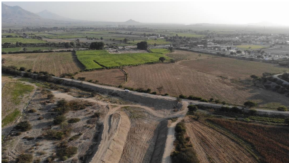
Fotografía 54. Zona crítica 13-029. Cauce de la quebrada Cuculicote modificado por la actividad antrópica (distrito de Ascope) para direccionar las aguas fluviales. Coordenadas UTM: 709879 / 9147196, Zona 17. Tomado el 22-09-2023.
