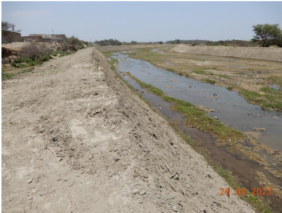
Fotografía 82. Zona crítica 13-044. Defensa ribereña en base a acumulación de arena en el cauce del río Loco de Chamán en el C. P. Alto San Idelfonso (distrito de Pueblo Nuevo). Coordenadas UTM: 656195 / 9209977, Zona 17. Tomado el 26-09-2023.
