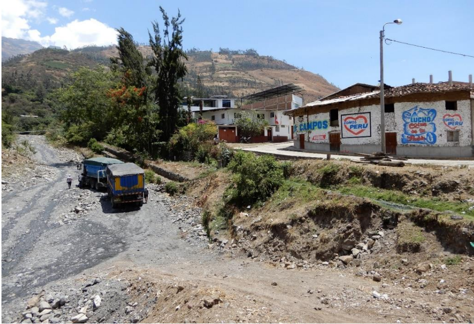
Fotografía 98. Zona crítica 13-054. Viviendas del centro poblado de Coina asentadas en la margen izquierda del cauce activo de la quebrada Huarmamochal (distrito de Usquil).
