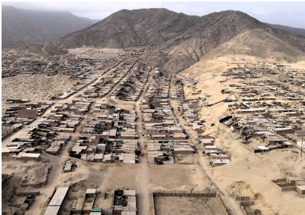
Fotografía 6. Zona crítica 13-002. Quebrada Víctor Raúl ubicado en el distrito El Porvenir donde se observa construcción de viviendas en su cauce. Coordenadas UTM: 722188 / 9108343, Zona 17. Tomado el 12-09-2023.
