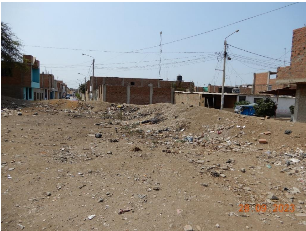
Fotografía 126. Zona crítica 13-072. Montículo de tierra para proteger las viviendas de las inundaciones al asentamiento humano California (distrito de Virú).
