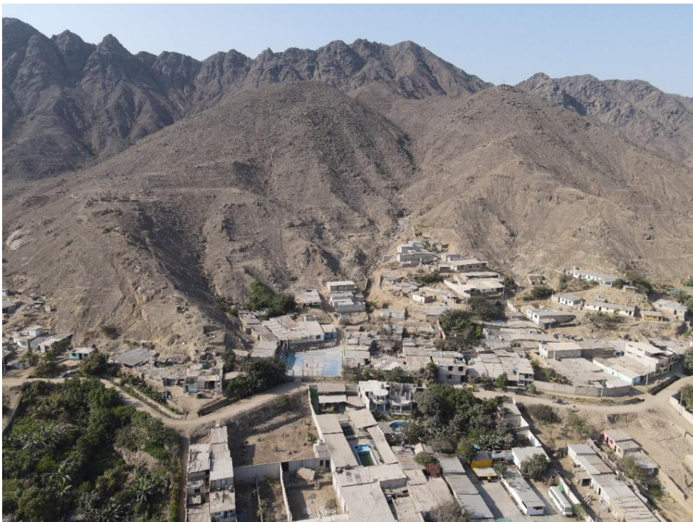
Fotografía 48. Zona crítica 13-025. En el asentamiento humano Luis Alberto Sánchez se observa construcción de viviendas en pleno cauce quebrada (distrito de Ascope). Coordenadas UTM: 707682 / 9147115, Zona 17. Tomado el 22-09-2023.
