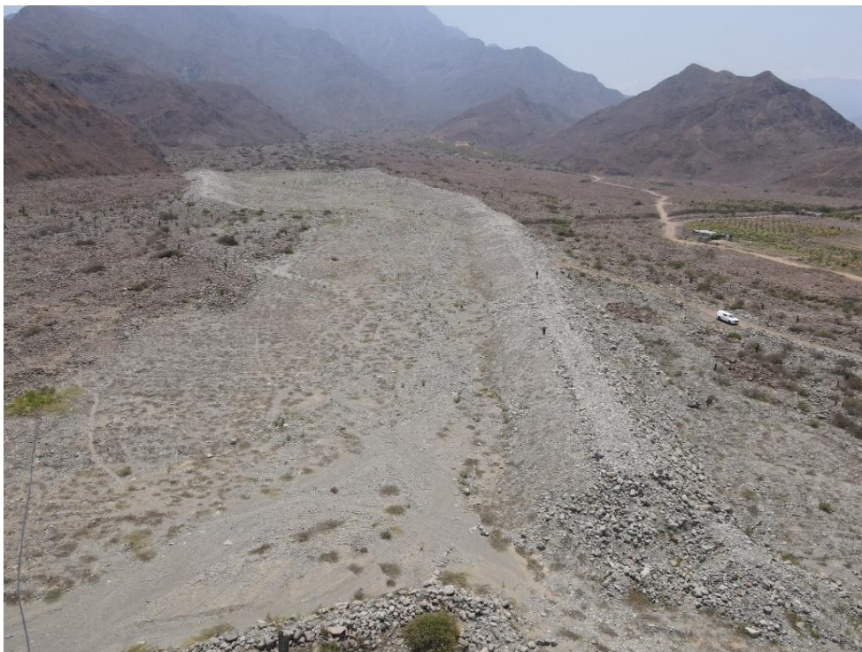
Fotografía 122. Zona crítica 13-068. Dique de derivación de los flujos de detritos ubicado en la parte superior de la población de El Niño (distrito de Virú).
