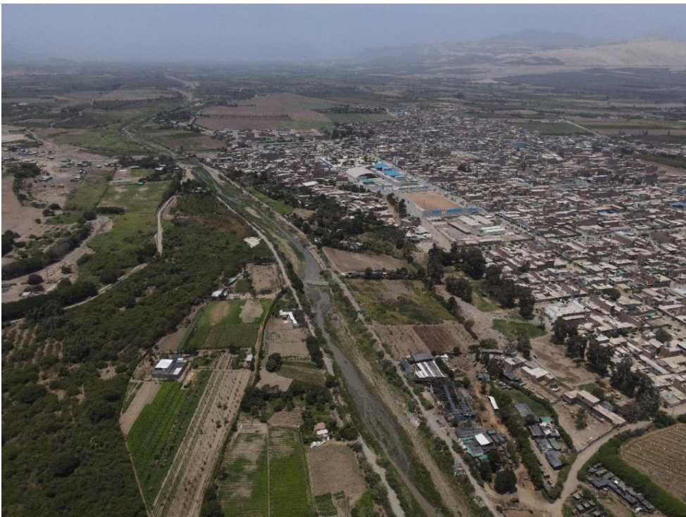
Fotografía 134. Zona crítica 13-078. Viviendas del sector de Choloue ubicadas en la margen izquierda del río Cerroblanco que pueden ser afectadas por erosión fluvial (distrito de Chao). Coordenadas UTM: 754844 / 9054949, Zona 17. Tomado el 29-09-2023.
