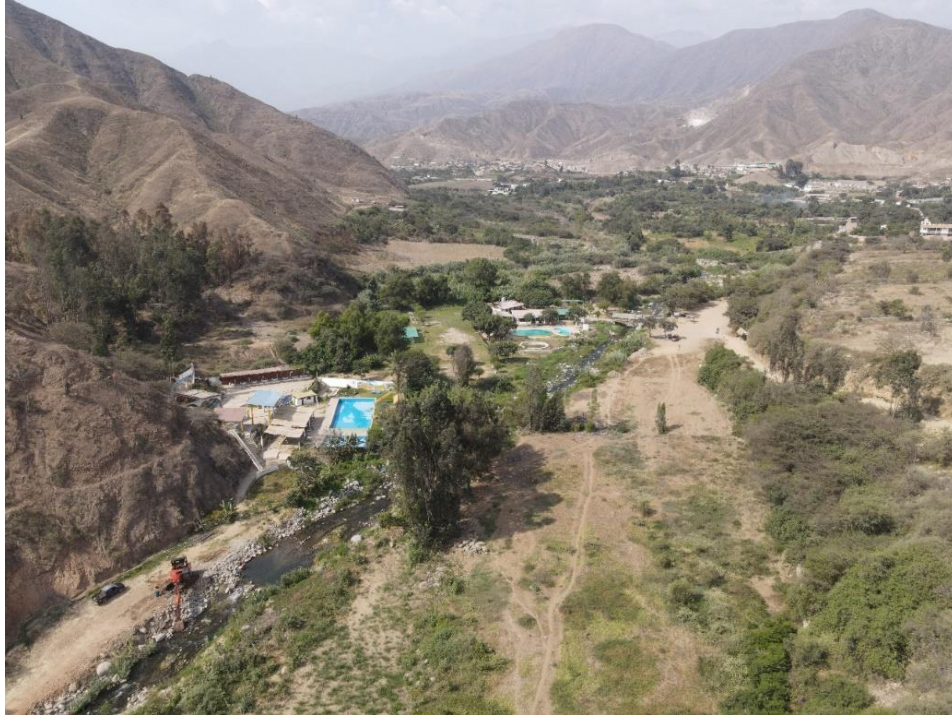
Fotografía 33. Zona crítica 13-016. Centros recreacionales privados asentados sobre depósitos fluviales que pueden ser afectados por erosión fluvial e inundación fluvial. Se ubican en las márgenes del río Sinsicap (distrito de Simbal). Coordenadas UTM: 740783 / 9118007, Zona 17. Tomado el 15-09-2023.
