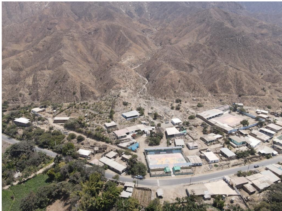
Fotografía 113. Zona crítica 13-062. Viviendas del sector Sinupe asentadas sobre depósitos flujos de detritos acumulados en forma de abanico (distrito de Cascas).
