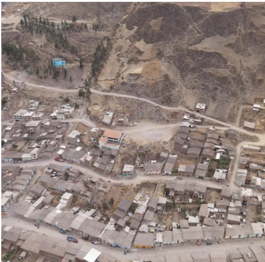
Fotografía 87. Zona crítica 13-047. Deslizamiento rotacional en el Barrio Ramón Castilla parte alta (distrito de Otuzco). Coordenadas UTM: 769085 / 9125941, Zona 17. Tomado el 27-09-2023.
