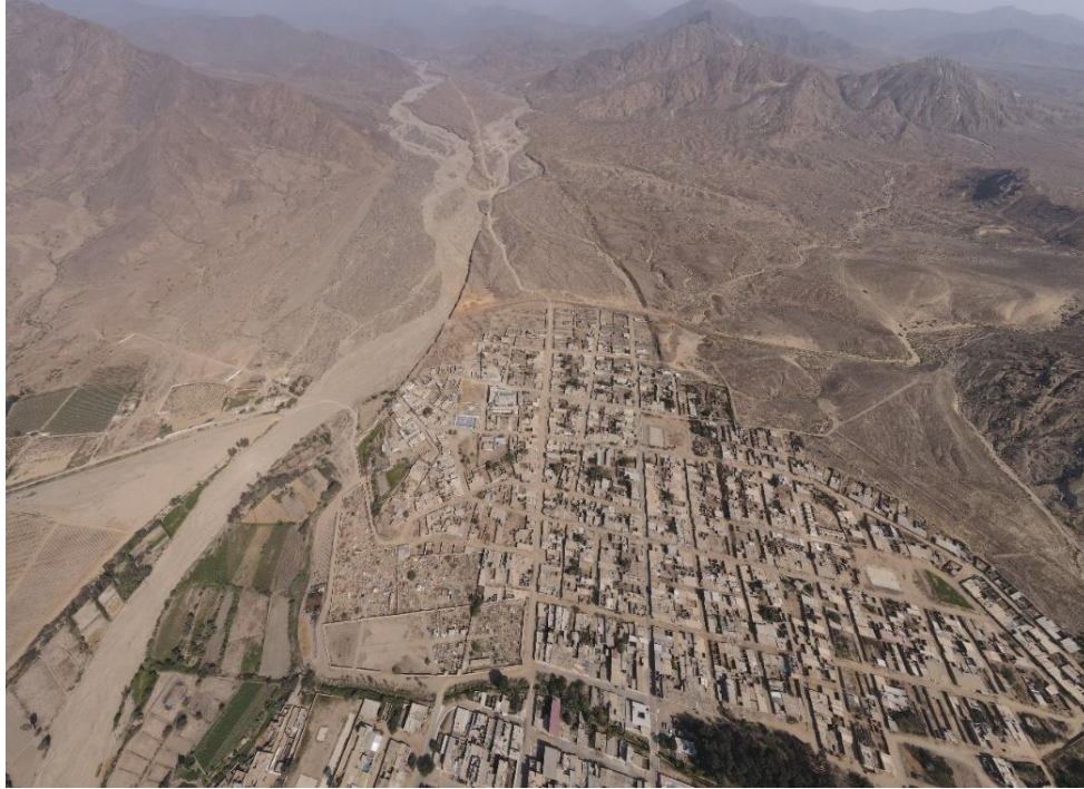
Fotografía 57. Zona crítica 13-031. Viviendas del centro poblado Sausal asentadas sobre el cauce de quebrada seca, además, el cauce actual de la quebrada ha sido canalizado hacia la margen izquierda (distrito de Chicama). Coordenadas UTM: 720100 / 9143990, Zona 17. Tomado el 20-09-2023.
