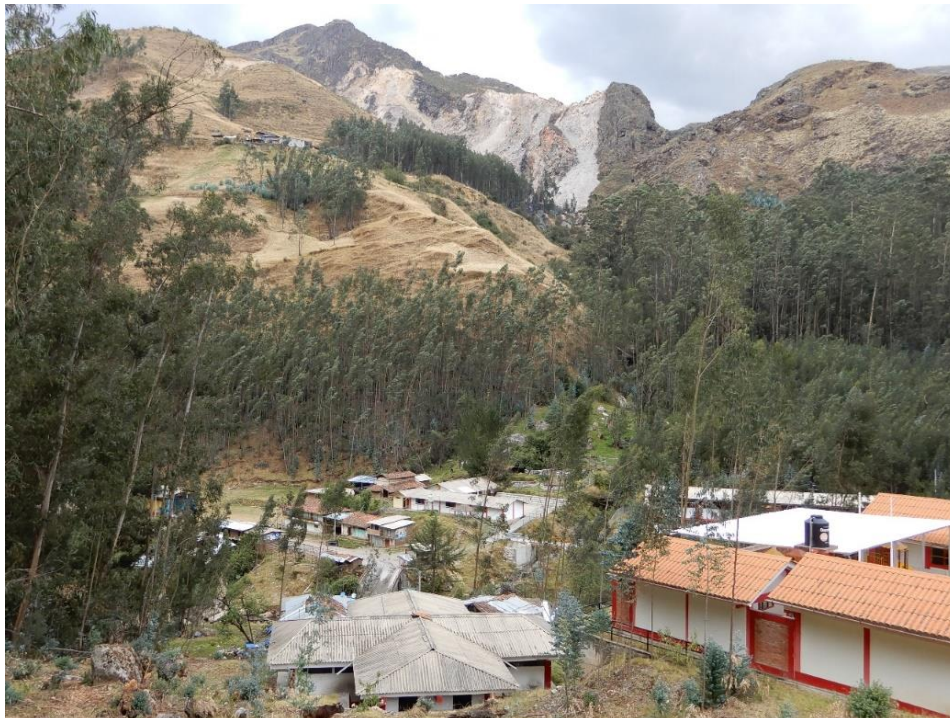
Fotografía 111. Zona crítica 13-060. Viviendas del caserío Llaray asentadas en desembocadura de quebrada (distrito de Quiruvilca).
