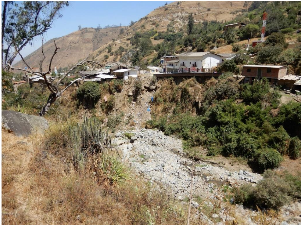
Fotografía 93. Zona crítica 13-050. Viviendas en la localidad de La Cuesta asentadas en la margen derecha del río La Cuesta susceptible a ser afectadas por erosión fluvial (distrito de La Cuesta). Coordenadas UTM: 753092 / 9124019, Zona 17. Tomado el 15-09-2023.
