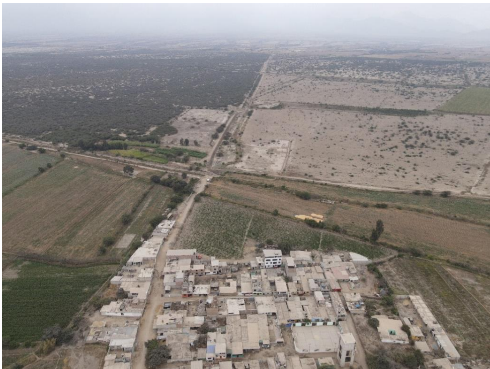
Fotografía 64. Zona crítica 13-035. Vista panorámica del sector de Mocan (distrito de Casa Grande). Coordenadas UTM: 693885 / 9153298, Zona 17. Tomado el 23-09-2023.
