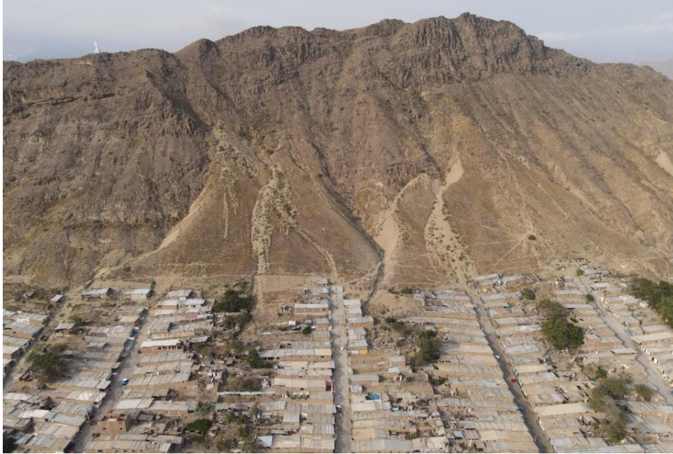
Fotografía 65. Zona crítica 13-036. Se observa el cerro Chepén con torrenteras cubiertas por depósitos eólicos en dirección a la ciudad del mismo nombre (distrito de Chepén). Coordenadas UTM: 673877 / 9201106, Zona 17. Tomado el 25-09-2023.
