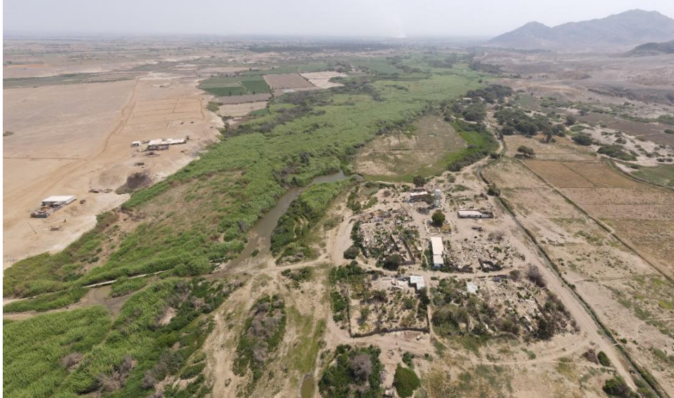
Fotografía 83. Zona crítica 13-045. Viviendas del centro poblado Tahuantinsuyo asentadas sobre terraza aluvial de la margen derecha del río Chamán (distrito de Pueblo Nuevo). Coordenadas UTM: 653064 / 9206836, Zona 17. Tomado el 26-09-2023.
