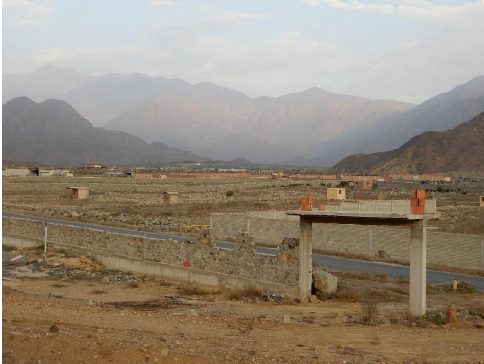
Fotografía 29. Zona crítica 13-014. Construcciones de paredes en los espacios lotizados y construcción de viviendas ubicados en la Quebrada León (distrito de Poroto). Coordenadas UTM: 741084 / 9107463, Zona 17. Tomado el 14-09-2023.
