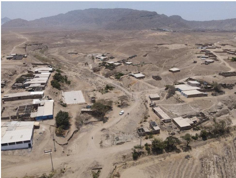
Fotografía 104. Zona crítica 13-057. Tres viviendas del centro poblado Nueva Esperanza asentadas en la margen izquierda de la desembocadura del cauce de quebrada que podrían ser afectadas por la erosión fluvial (distrito de Guadalupe). Coordenadas UTM: 665615 / 9191369, Zona 17. Tomado el 24-09-2023.
