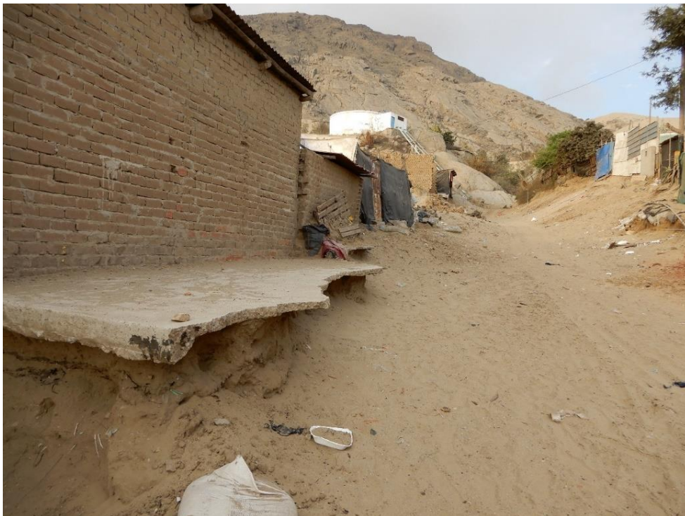
Fotografía 18. Zona crítica 13-008. Desembocadura de la quebrada Indoamérica en el distrito de La Esperanza. Durante el ciclón Yaku fue afectada por flujo de lodo y erosión fluvial. Coordenadas UTM: 715742 / 9108526, Zona 17. Tomado el 13-09-2023.
