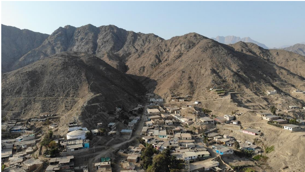
Fotografía 52. Zona crítica 13-028. Cauce de la quebrada Catan y viviendas construidas sobre depósitos de flujos de detritos (distrito de Ascope). Coordenadas UTM: 709131 / 9147345, Zona 17. Tomado el 22-09-2023.
