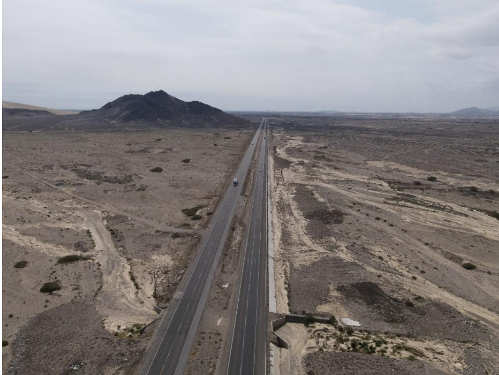
Fotografía 99. Zona crítica 13-055. Carretera Panamericana Norte en la quebrada Cupisnique donde se generan flujos de detritos (Distrito San Pedro de Lloc). Coordenadas UTM: 673445 / 9173825, Zona 17. Tomado el 23-09-2023.
