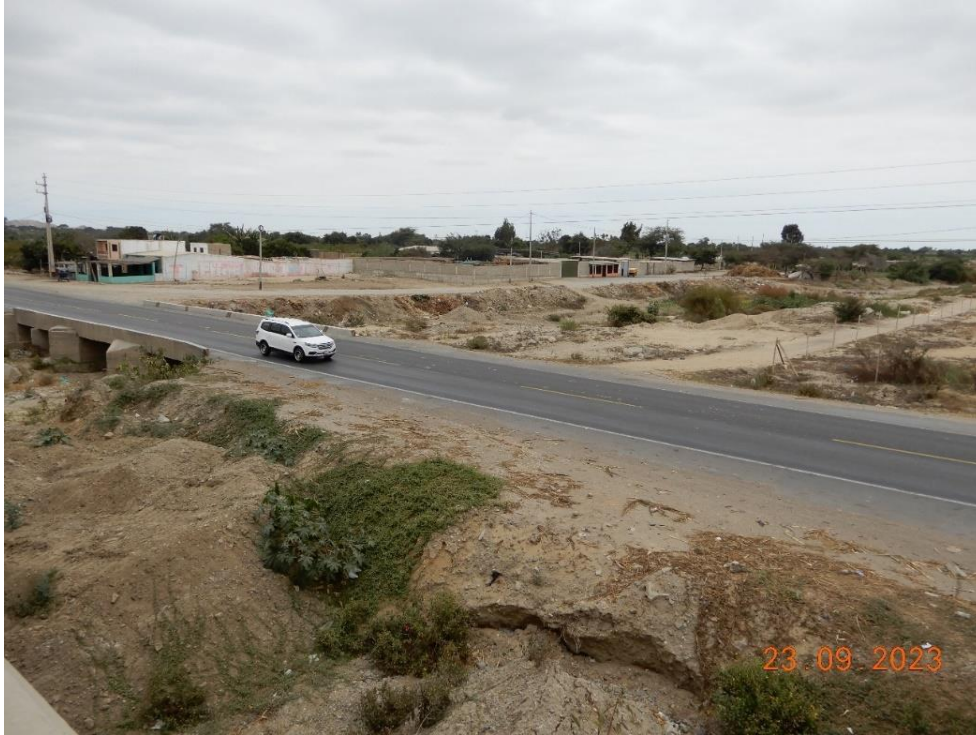
Fotografía 63. Zona crítica 13-034. Cauce de la quebrada Acequia en el Sector La Arenita sin defensa ribereña segura (distrito de Chocope). Coordenadas UTM: 684647 / 9150800, Zona 17. Tomado el 23-09-2023.
