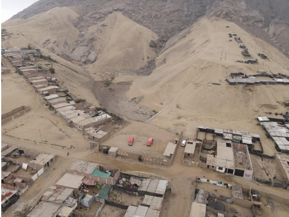
Fotografía 41. Zona crítica 13-021. Viviendas del sector La Flores ubicadas en depresión conformada por depósitos eólicos y susceptible a inundación y ocurrencias de flujos de lodo (distrito de Alto Trujillo). Coordenadas UTM: 716637 / 9108526, Zona 17. Tomado el 12-09-2023.
