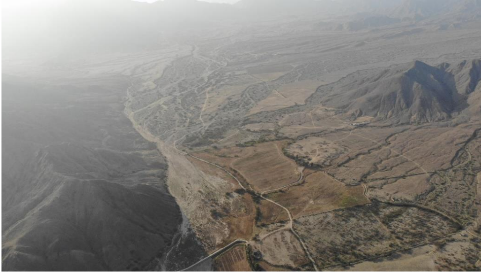
Fotografía 53. Zona crítica 13-029. Confluencia de múltiples quebradas y torrenteras con acumulación de depósitos de flujos de detritos en la quebrada Cuculicote (distrito de Ascope).
