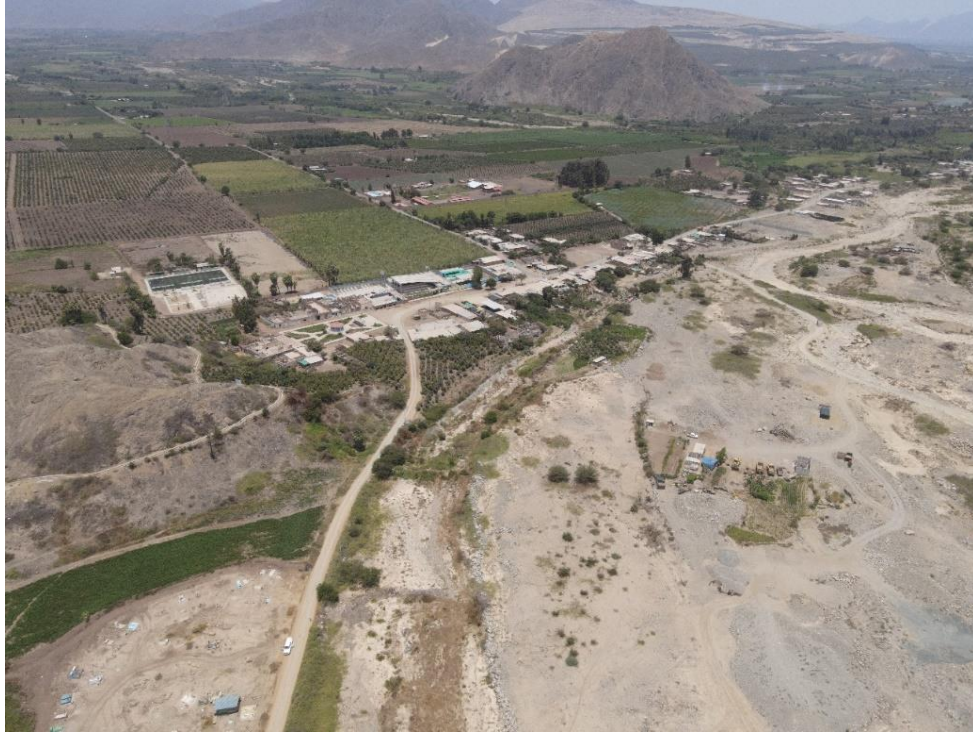
Fotografía 123. Zona crítica 13-069. Viviendas de sector Tomaval asentadas en la margen izquierda del río Carabambita que pueden ser afectadas por erosión fluvial (distrito de Virú). Coordenadas UTM: 750937 / 9075685, Zona 17. Tomado el 28-09-2023.
