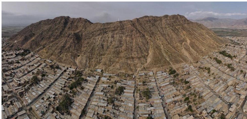
Fotografía 66. Zona crítica 13-036. Cerro Chepén rodeada de viviendas susceptibles a ser afectadas por flujos de lodo (distrito de Chepén); además, se observan las múltiples torrenteras en dirección al pueblo. Coordenadas UTM: 673877 / 9201106, Zona 17. Tomado el 25-09-2023.
