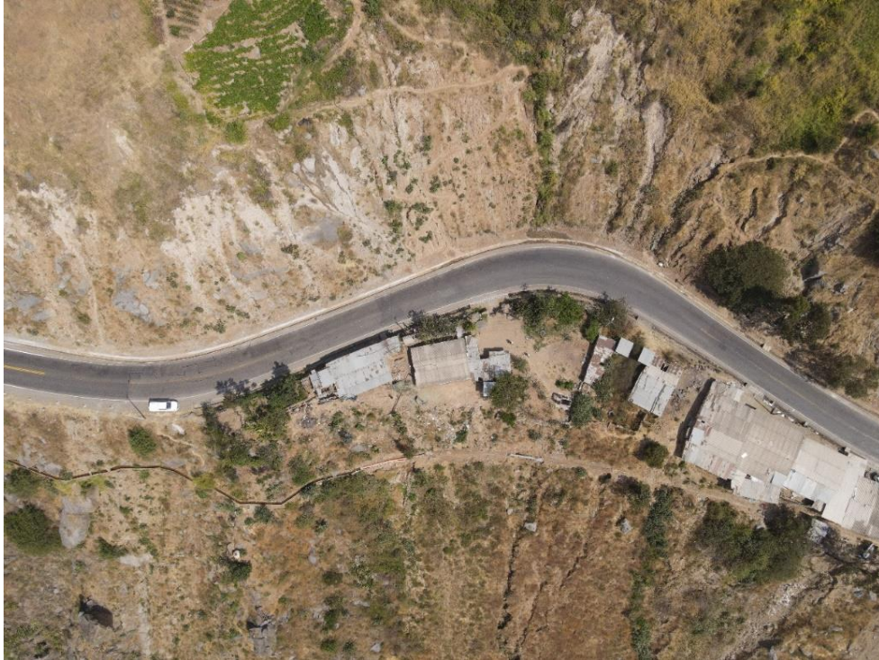
Fotografía 96. Zona crítica 13-053. Viviendas del sector Plaza Pampa asentadas sobre deslizamiento rotacional (distrito de Salpo).
