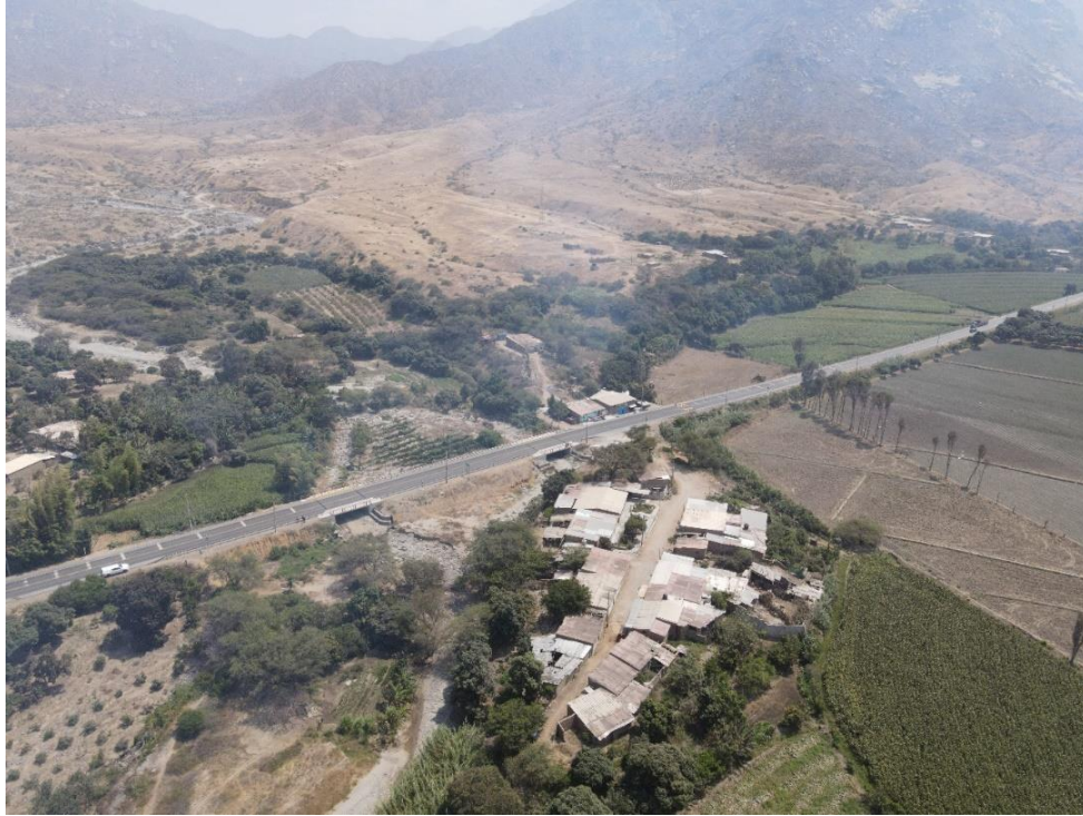
Fotografía 67. Zona crítica 3-037. Vista panorámica de quebrada De la Salinas en el sector Zapotal (distrito de Chepén). Coordenadas UTM: 688191 / 9195433, Zona 17. Tomado el 25-09-2023.
