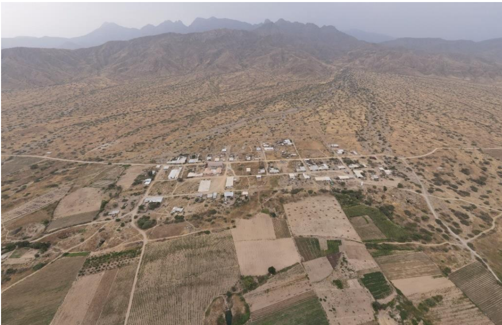
Fotografía 78. Zona crítica 13-042. Se observa múltiples torrenteras en dirección al poblado de La Aventuranza (distrito de Nanchoc). Coordenadas UTM: 685281 / 9211246, Zona 17. Tomado el 26-09-2023.
