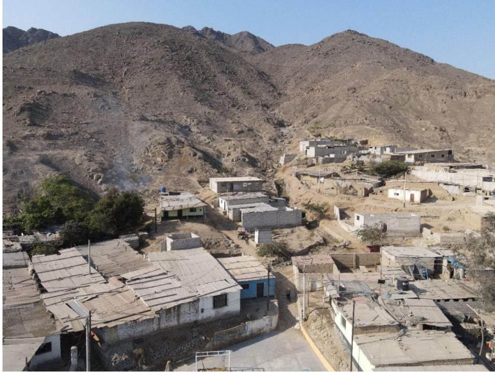
Fotografía 49. Zona crítica 13-025. Vista del cauce de quebrada en el asentamiento humano Luis Alberto Sánchez. Se observa viviendas construidas sobre depósitos de flujos de detritos (distrito de Ascope). Coordenadas UTM: 707682 / 9147115, Zona 17. Tomado el 22-09-2023.
