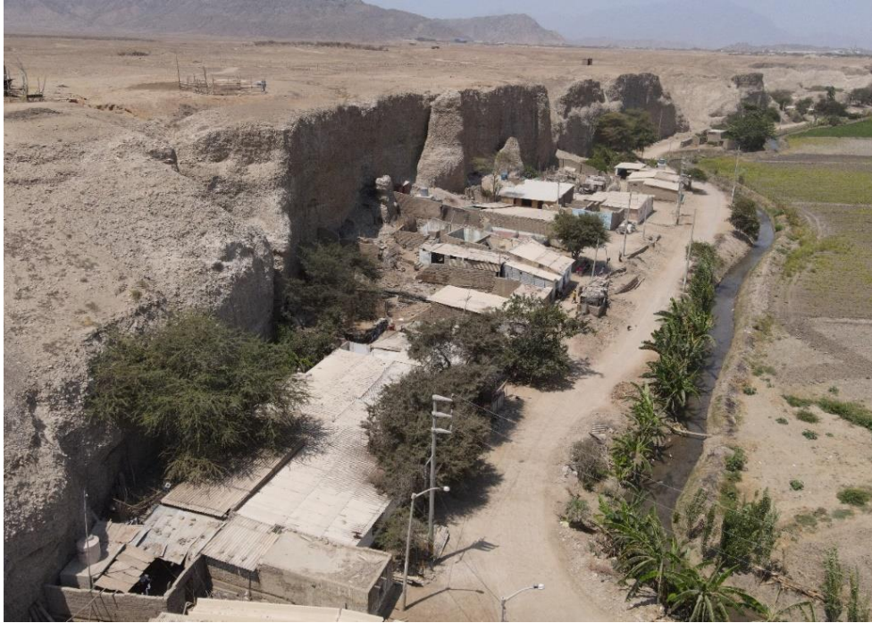
Fotografía 107. Zona crítica 13-058. Viviendas del centro poblado Faclo Grande ubicadas al pie de acantilados que pueden ser afectados por derrumbes y activación de torrenteras intermitentes. (distrito de Guadalupe)
