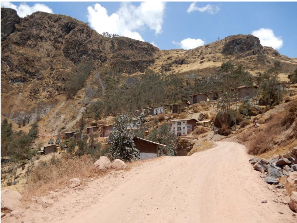
Fotografía 91. Zona crítica 13-049. Viviendas asentadas sobre depósito de derrumbes en el sector de Laclambay (distrito de Charat).
