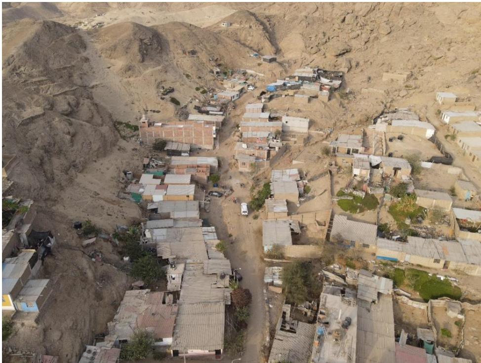
Fotografía 16. Zona crítica 13-007. Viviendas ubicadas en la desembocadura de la quebrada Clementina en el distrito de La Esperanza que podrían ser afectados por flujos de lodo y erosión fluvial. Coordenadas UTM: 715355 / 9109492, Zona 17. Tomado el 13-09-2023.
