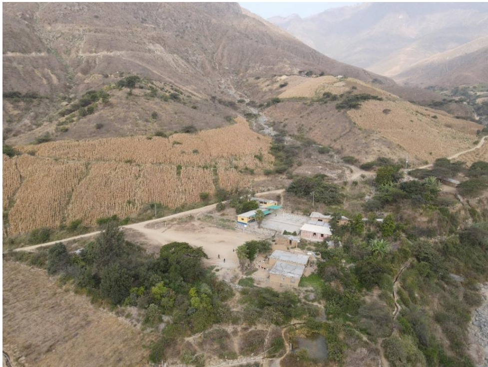
Fotografía 26. Zona crítica 13-013. Viviendas del Caserío Huayabito asentadas sobre depósitos de flujos de detritos y en desembocadura de quebrada (distrito Poroto). Coordenadas UTM: 749341 / 9108017, Zona 17. Tomado el 14-09-2023.
