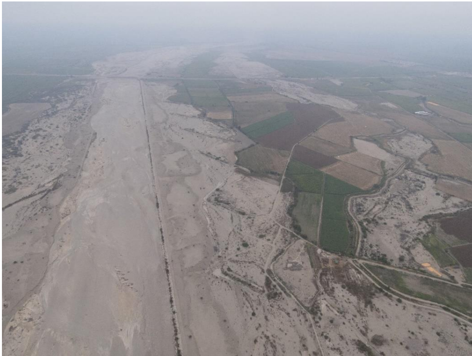
Fotografía 60. Zona crítica 13-033. Vista panorámica del Río Chicama dividido en dos brazos en el cruce con la carretera Panamericana Norte (distrito de Chocope). Coordenadas UTM: 700572 / 9135936, Zona 17. Tomado el 23-09-2023.
