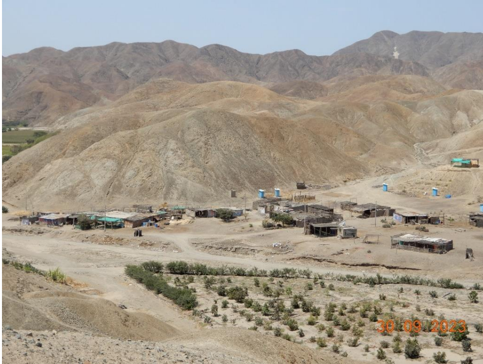
Fotografía 137. Zona crítica 13-080. Viviendas del sector Huacacorral asentada en desembocadura de y sobre depósitos de flujos de detritos (distrito de Guadalupito). Coordenadas UTM: 764873 / 9020985, Zona 17. Tomado el 30-09-2023.
