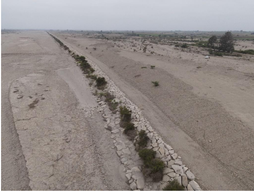
Fotografía 61. Zona crítica 13-033. Defensa ribereña en la margen derecha del Río Chicama (distrito de Chocope).
