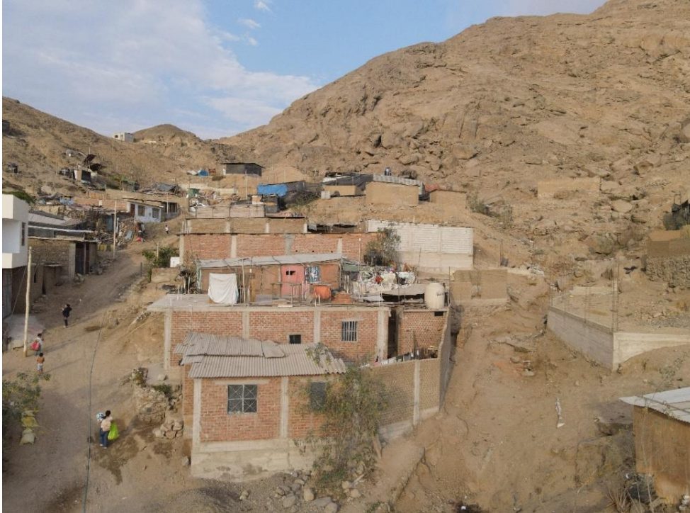
Fotografía 17. Zona crítica 13-007. Condiciones de las calles por donde pasa el cauce de la quebrada Clementina en el distrito de La Esperanza. Durante el ciclón Yaku fue afectada por flujo de lodo y erosión fluvial. Coordenadas UTM: 715355 / 9109492, Zona 17. Tomado el 13-09-2023.
