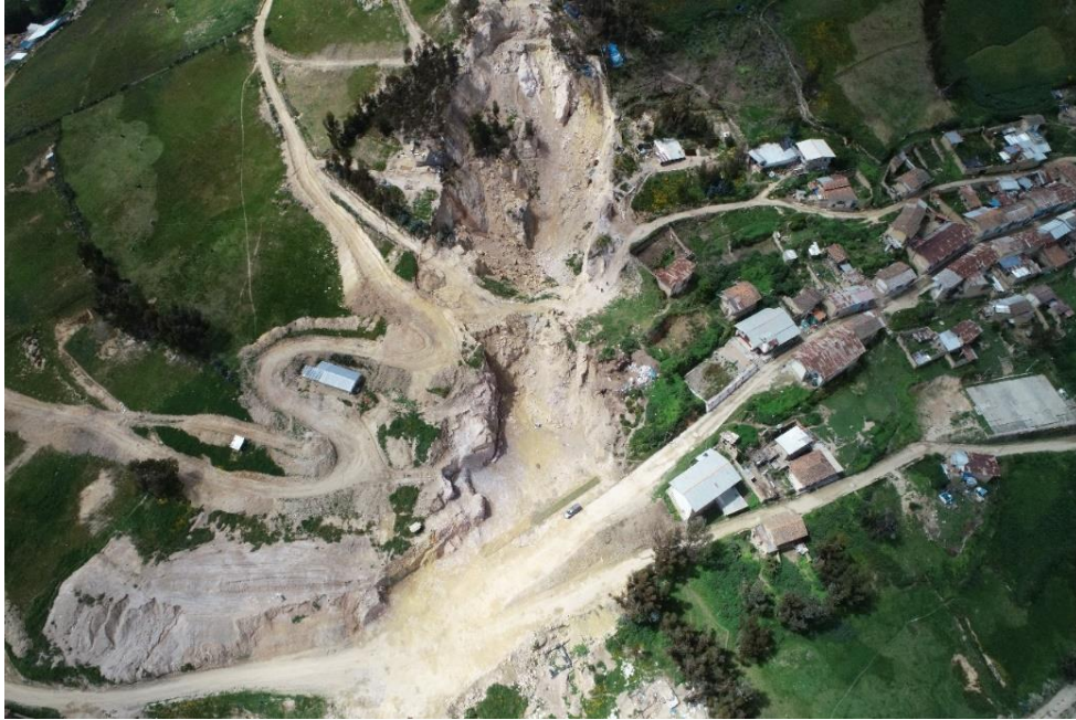
Fotografía 94. Zona crítica 13-051. Viviendas de la localidad de Salpo asentadas sobre el sustrato rocoso susceptible a hundimiento (distrito de Salpo). Coordenadas UTM: 764591 / 9114861, Zona 17. Tomado el 14-09-2023.
