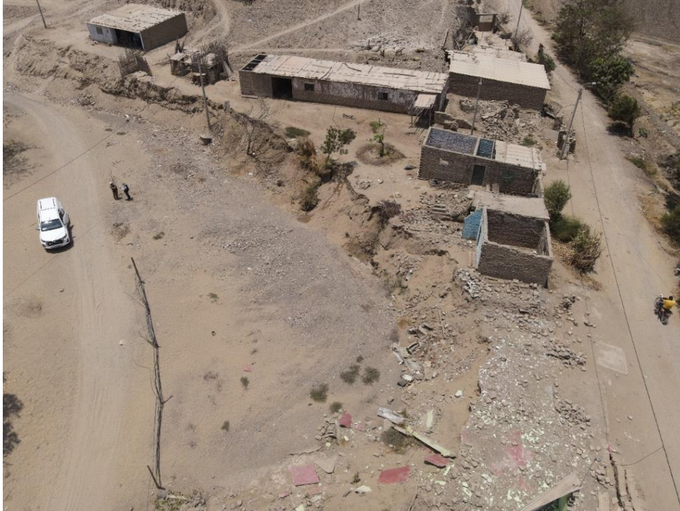
Fotografía 105. Zona crítica 13-057. Viviendas que podrían ser afectadas por la erosión fluvial en el centro poblado de Nueva Esperanza (distrito de Guadalupe). Coordenadas UTM: 665615 / 9191369, Zona 17. Tomado el 24-09-2023.
