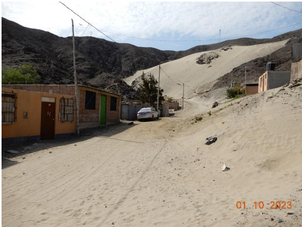
Fotografía 138. Zona crítica 13-081. Viviendas del centro poblado Campo Nuevo ubicada en desembocadura de quebrada (distrito de Guadalupito). Coordenadas UTM: 760537 / 9011684, Zona 17. Tomado el 01-10-2023.
