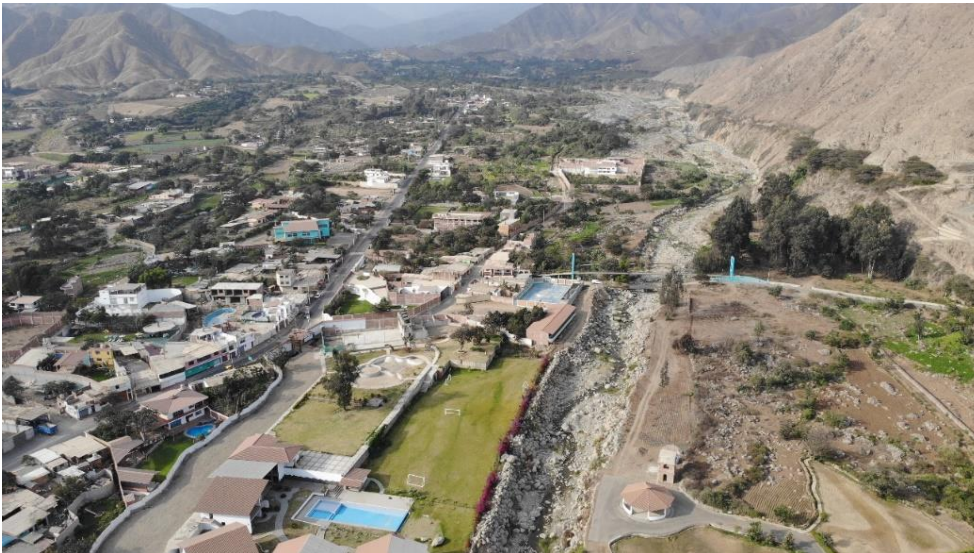
Fotografía 38. Zona crítica 13-019. Población del Caserío Pedregal ubicada en la margen derecha del río La Cuesta susceptible a la erosión e inundación fluvial. (distrito de Simbal). Coordenadas UTM: 739865 / 9114280, Zona 17. Tomado el 15-09-2023.
