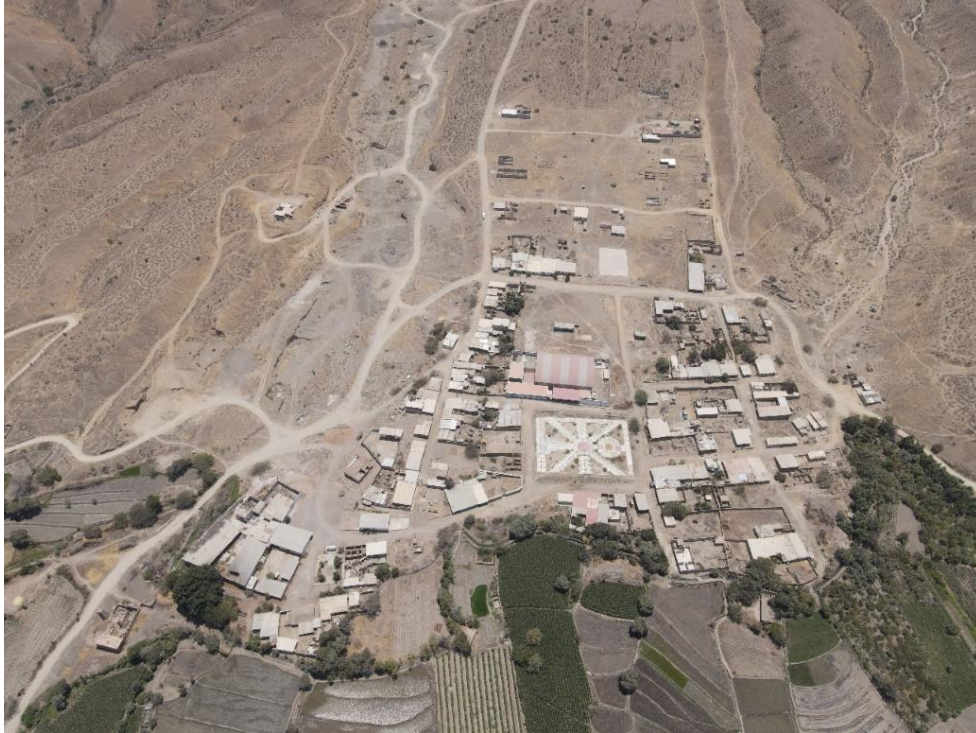
Fotografía 114. Zona crítica 13-063. Viviendas del sector El Progreso asentadas sobre depósitos de flujos de detritos y en la desembocadura de la quebrada Casa Quemada (distrito de Cascas). Coordenadas UTM: 732208 / 9160406, Zona 17. Tomado el 22-09-2023.
