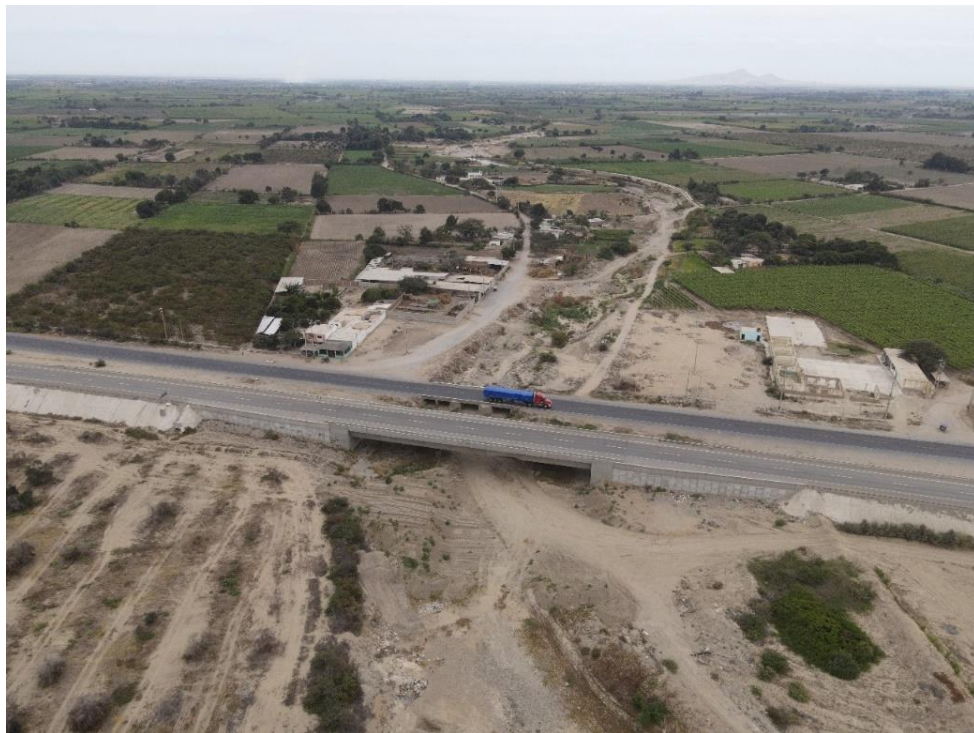
Fotografía 62. Zona crítica 13-034. Viviendas del sector La Arenita ubicadas en la margen izquierda de la quebrada Acequia susceptible a erosión fluvial e inundaciones (distrito de Chocope).
