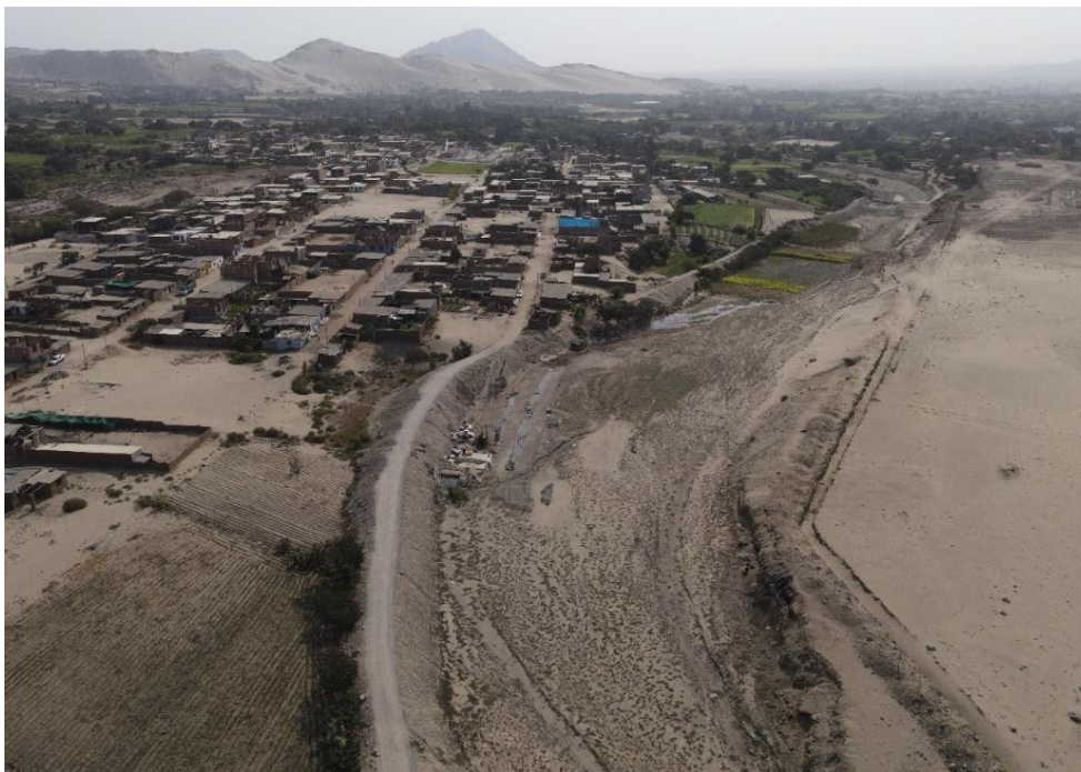
Fotografía 24. Zona crítica 13-011. Viviendas del centro poblado Pampas de San Juan asentada en la margen izquierda del cauce de la quebrada Santo Domingo: (distrito de Laredo).
