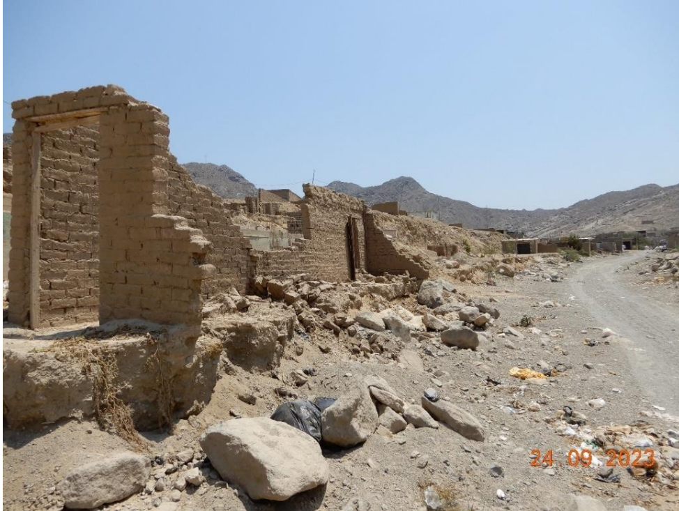
Fotografía 103. Zona crítica 13-056. Viviendas afectadas por erosión fluvial en el cauce quebrada Víctor Raúl (distrito de Guadalupe). Coordenadas UTM: 667296 / 9192785, Zona 17. Tomado el 24-09-2023.
