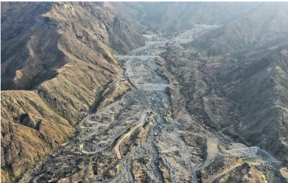
Fotografía 4. Zona crítica 13-001. Diques transversales para retención de flujos de detritos en las torrenteras afluentes al cauce principal de la Qda. San Idelfonso. Coordenadas UTM: 720412 / 9107649, Zona 17. Tomado el 18-04-2023.
