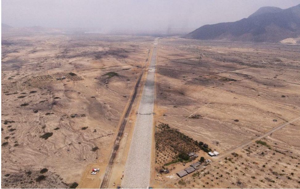
Fotografía 11. Zona crítica 13-005. Canal en construcción para desviar las aguas de la quebrada Río Seco y del rebose de la poza de sedimentación ubicado en la quebrada El León, distrito de Huanchaco. Coordenadas UTM: 716423 / 9114475, Zona 17. Tomado el 13-09-2023.
