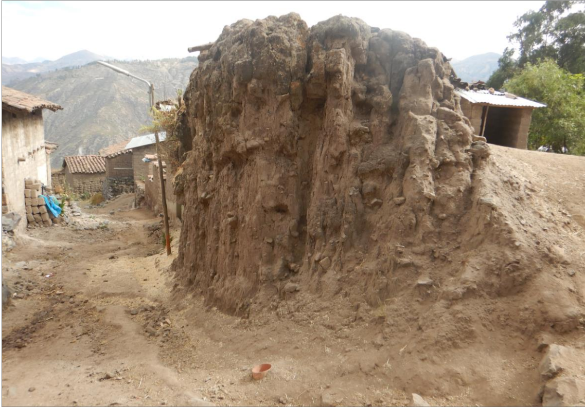
Fotografía 4. La presencia de depósitos semiconsolidados, compuesto con bloques, arenas limos y arcillas, favorece la ocurrencia de movimientos en masa y otros peligros geológicos.
