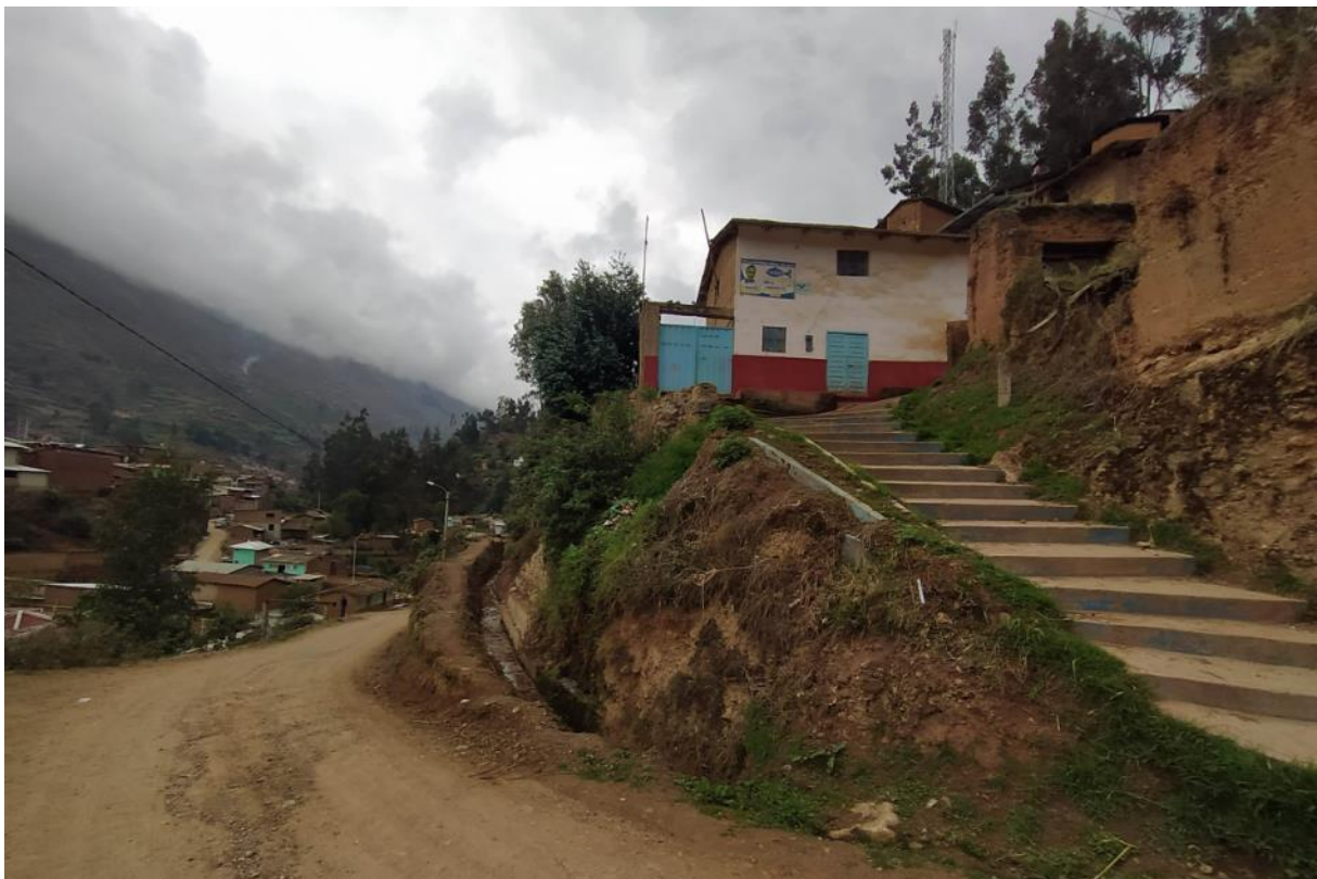
Fotografía 12 Parte baja del barrio Yauli muestra la pendiente pronunciada de la ladera y la construcción de viviendas realizando cortes de talud sin control técnico.
