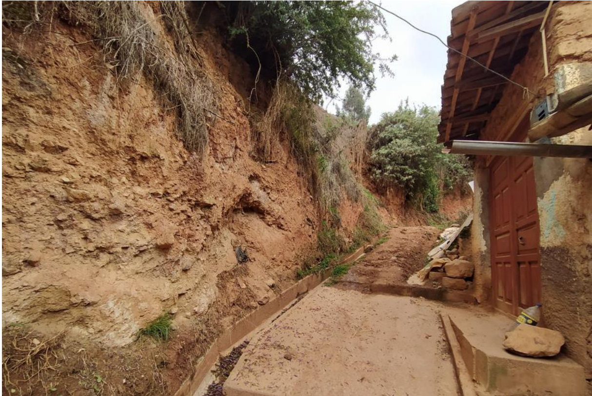
Fotografía 11 Muestra cortes de ladera para construcción de viviendas y caminos vecinales.
