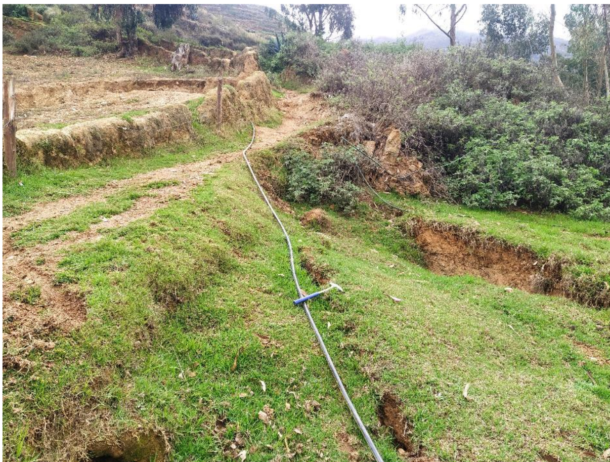
Fotografía 17 Muestra las medidas provisionales para desviar el agua de los manantes fuera de la zona de deslizamiento.
