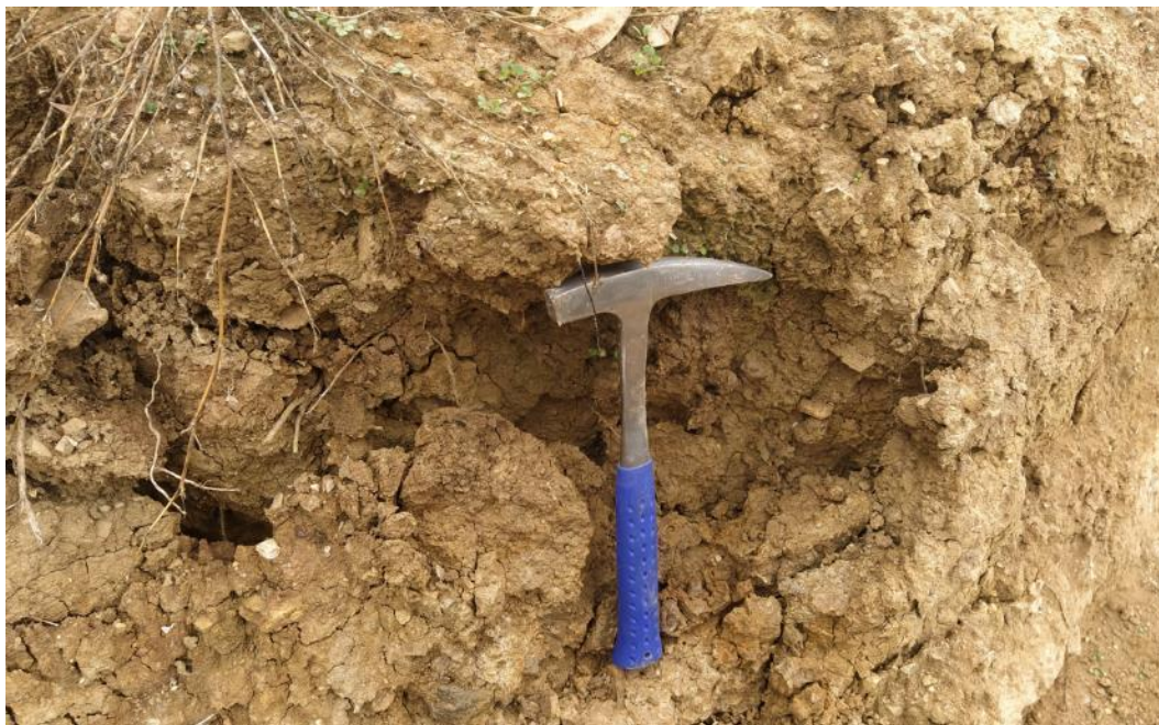
Fotografía 5. Depósitos coluvio-deluviales con alto contenido limo-arcillosos cerca de la zona de deslizamiento.
