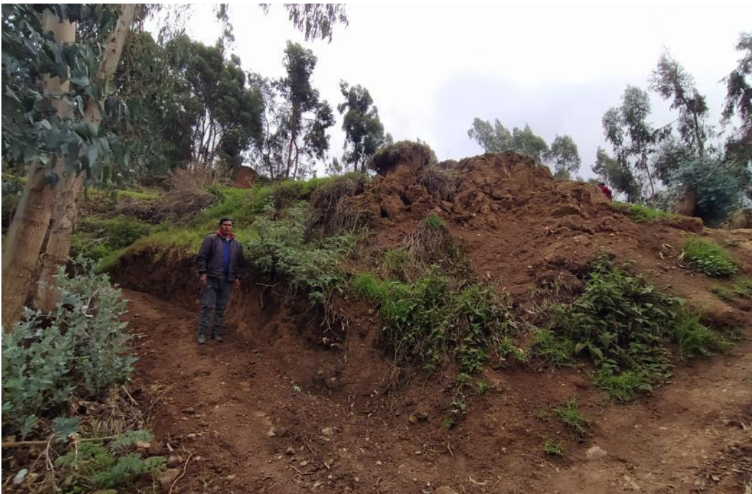
Fotografía 7. Frente de avance del deslizamiento de Tapo/ Barrio Yauli.
