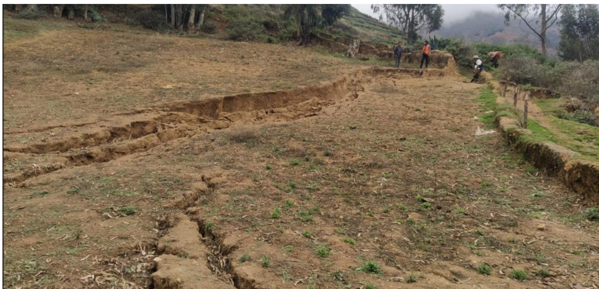
Fotografía 5. Escarpa principal del deslizamiento de Tapo/Barrio Yauli.
