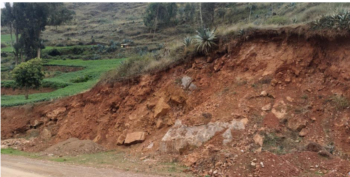
Fotografía 14. material coluvio-deluvial que compone las laderas del terreno propuesta por la Municipalidad de Tapo.
