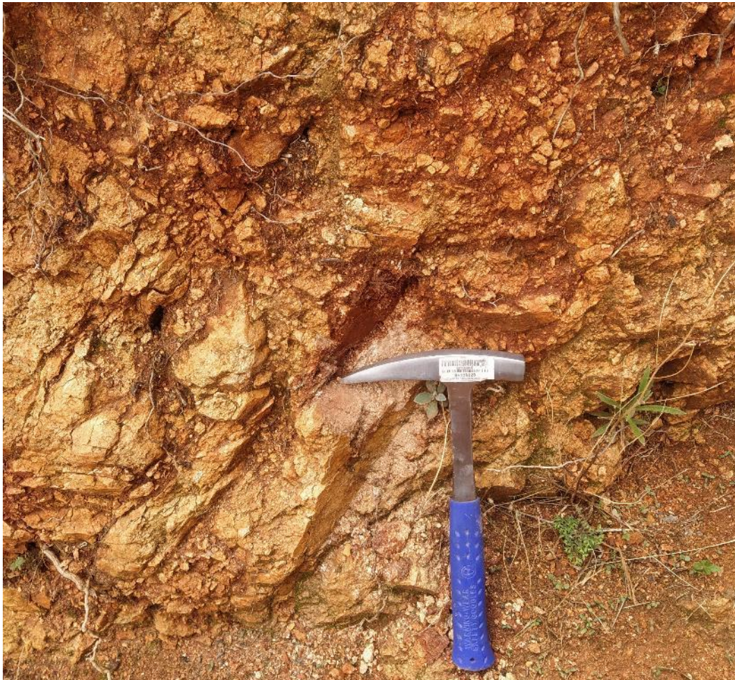
Fotografía 1. Sustrato rocoso conformado por esquistos color gris del complejo del Marañón. Estas rocas se presentan medianamente fracturas y altamente meteorizadas en la ubicación: 438098 m E, 8740629 m S
