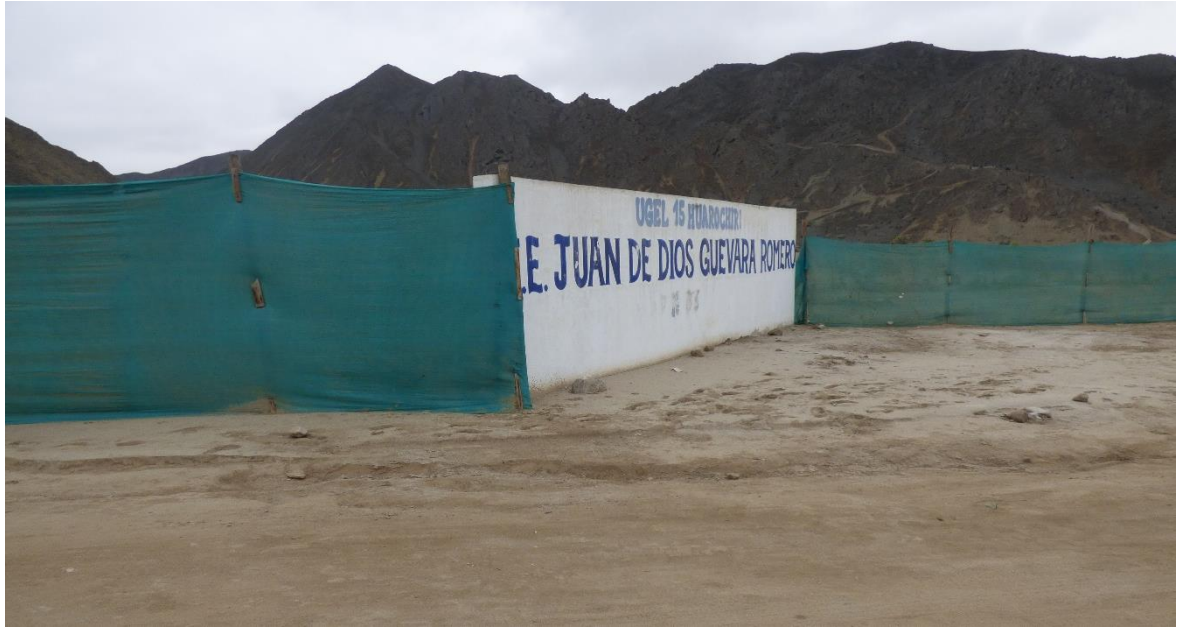
Fotografía 7. Institución educativa "Juan de Dios Guevara Romero", afectada por el flujo del 2023. Centro poblado Santa Rosa
