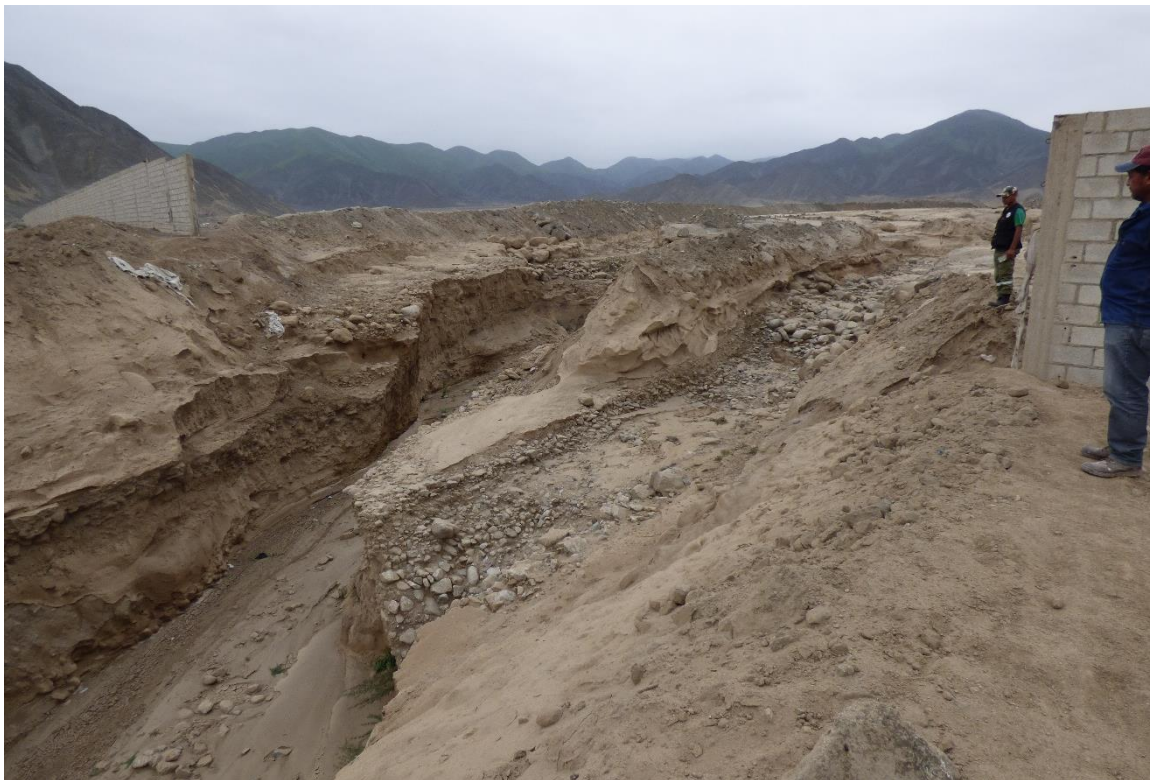
Fotografía 6. Flujo de marzo del 2023, se desbordó a la altura del C.P. Santa Rosa, destruyó el muro avícola, continuó su recorrido por el cauce y el desborde llegó a la institución educativa Juan de Dios Guevara Romero con el acompañamiento para los trabajos de campo del Presidente de la Comunidad Pampapacta y ronderos de la zona.
