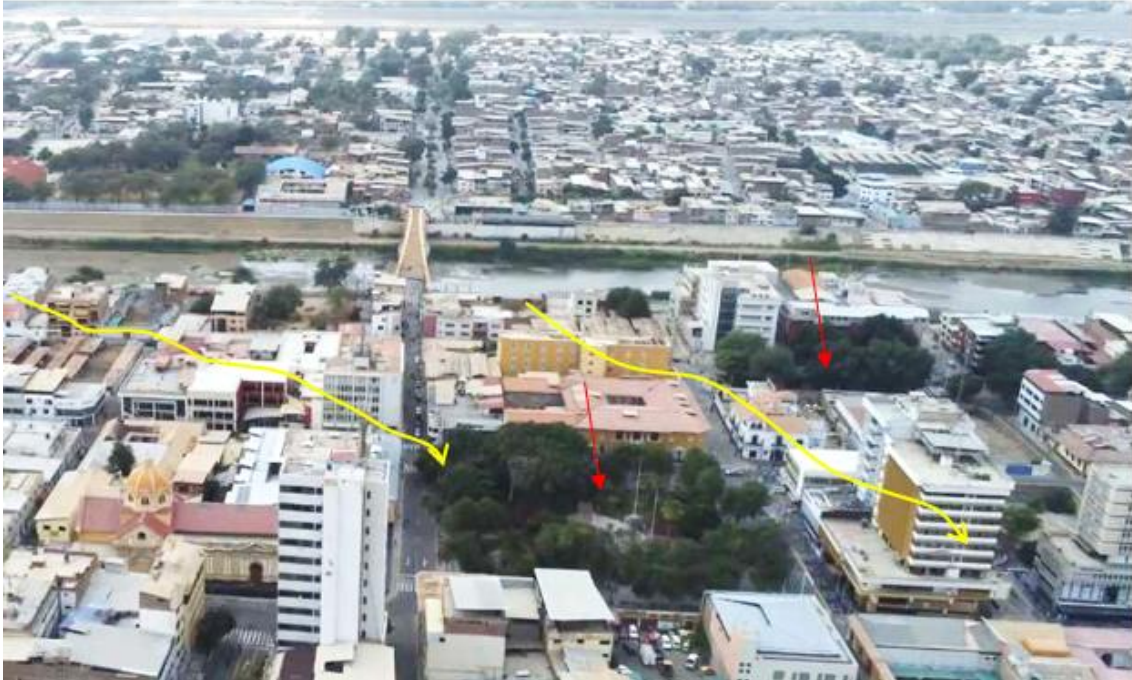
Figura 137. Zona crítica 20-075, En el año 2017, el río Piura se desbordo e inundó alrededor de 40 has del casco urbano, donde se encuentran centros comerciales, centros turísticos como la Plaza principal de Piura, Parque Abelardo Quiñones, restaurantes, etc. Coordenadas (N: 9425466, E: 541475, 14/09/23).
