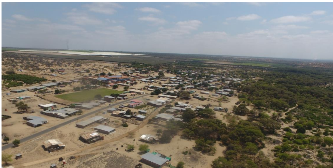
Fotografía 29. Caserío Olivares San Fernando (ZC 20-072), en el distrito de Tambogrande afectado por inundación pluvial.
