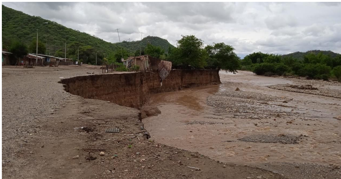
Fotografía 28. Erosión fluvial en el caserío Pampa Flores (ZC 20-145), donde el río ha erosionado el margen izquierdo de la planicie donde se ubica el área urbana.
