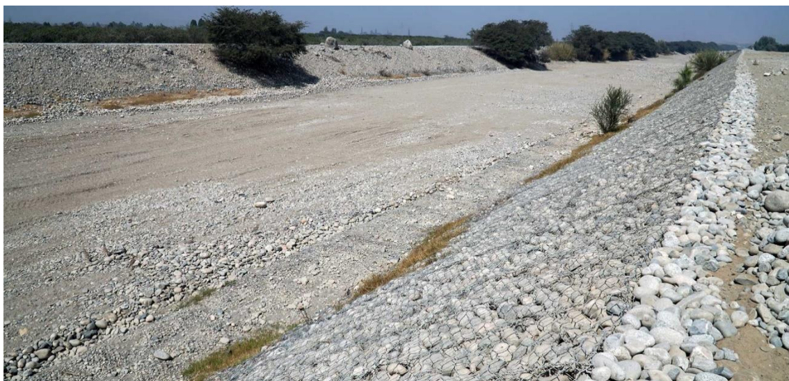
Fotografía 38. Ejemplo de una defensa ribereña con un pedraplén y geomallas.
