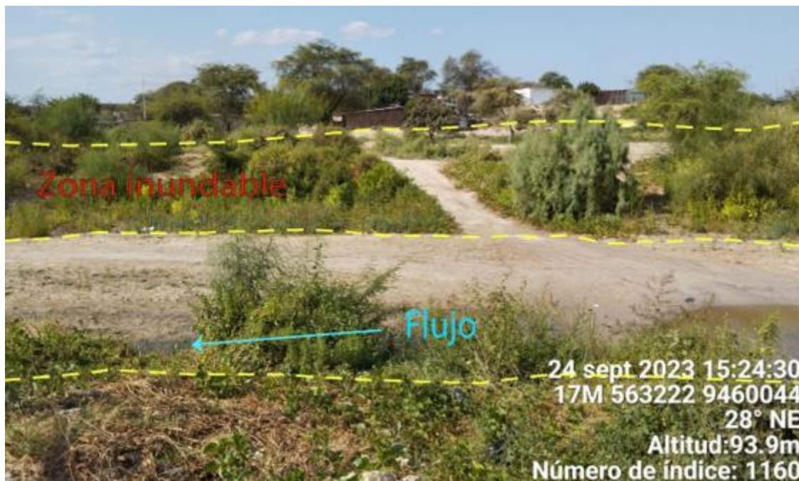
Figura 131a. Zona crítica 20-070. Se aprecian terrenos de cultivo y viviendas que se encuentran a 5 m del cauce de máxima avenida. (N:9460044 E:563222 24/09/23).
