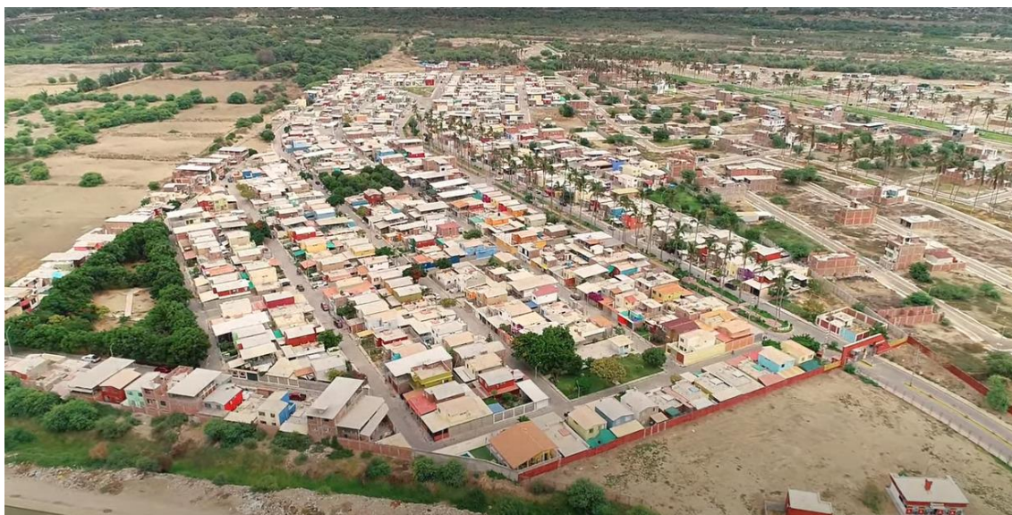
Figura 140. Zona crítica 20-078. Urb. Monteverde afectada por inundación pluvial en presencia de lluvias extraordinarias como las observadas en el Niño Costero 2017 y Yacu 2023. (N: 9421958, E: 54171, 15/09/23).
