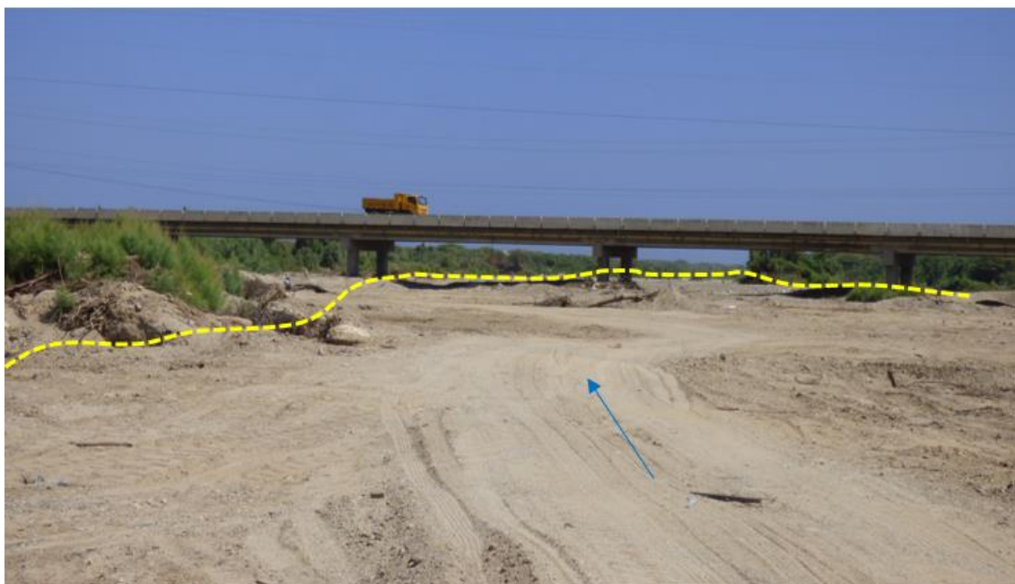
Figura 60. Zona crítica 20-001. Sujeta a flujos de lodo y detritos principalmente por la activación de la quebrada Fernández, que erosiona márgenes y socava márgenes poniendo en riesgo viviendas ubicados a la ribera, así como también medios de vida como granjas y cultivos. (N: 9546600, E: 496527, 29/08/2023).
