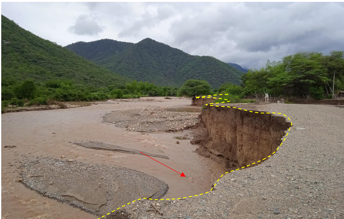
Figura 207. Zona crítica 20-145 Se identificó un flujo de detritos que desciende por la quebrada El Ingenio que se activó en el año 2017 con un tirante de 1 m de altura. Además, se han cartografiado cárcavas que erosionan las laderas arrastrando materiales a la quebrada. (N: 9425613, E: 619181, 17/09/23).
