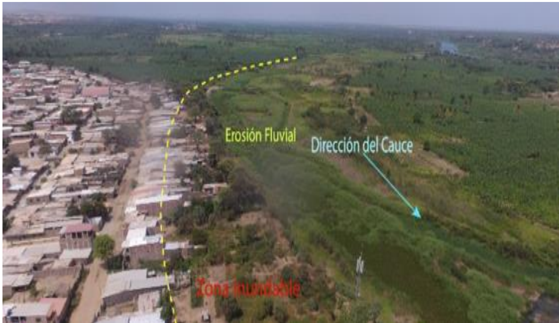
Figura 119. Zona crítica 20-059. El centro poblado Salitral se ubica en la margen derecha del río Chira, se identificó un tramo de 860 m de erosión fluvial e inundaciones que afectan viviendas e infraestructura pública ubicada a 10 m del cauce del río. (N:9462700 E:535600 14/09/23).
