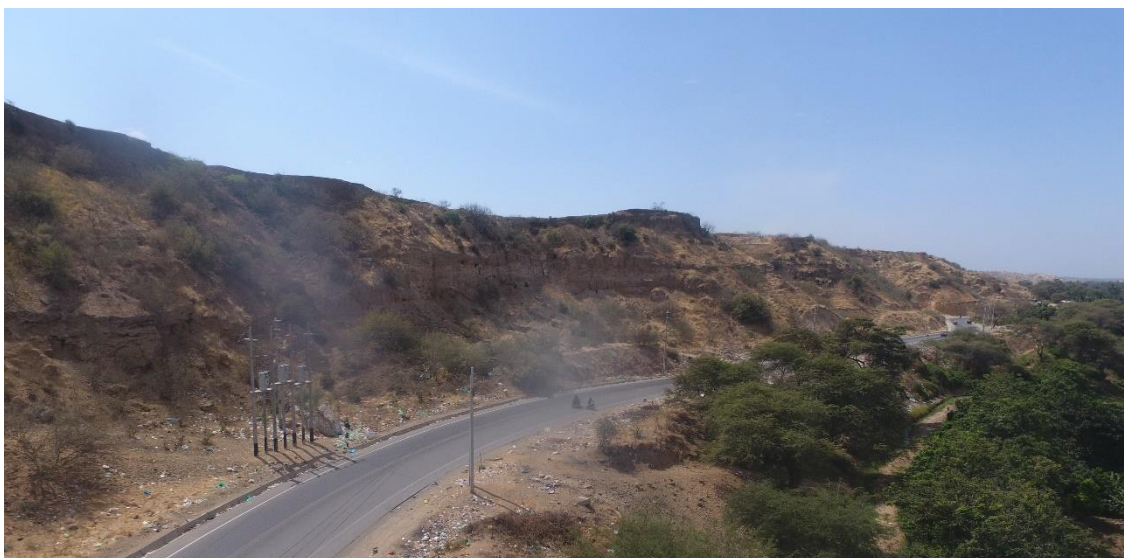
Fotografía 35. Tramo de la vía Marcavelica Las Palmeras (ZC 20-063), caídas de bloques.
