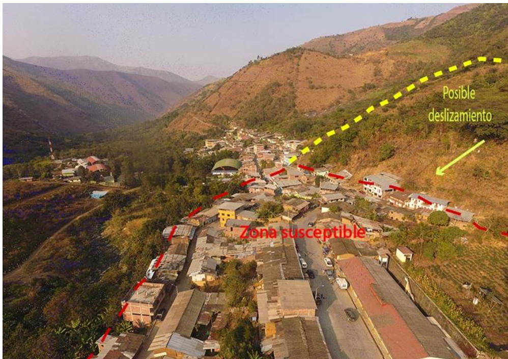
Figura 170. Zona crítica 20-108. Se identificaron deslizamientos antiguos en el sector Lojas estos presentaron reactivaciones en el mes de marzo del presente año. Además de la ocurrencia de flujos de detritos en las quebradas Juan Pablo II, La Esperanza y Marmas. (N: 9488063, E: 629693, 22/09/23).
