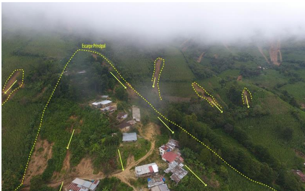
Figura 161. Zona crítica 20-099. Se identificaron deslizamientos en la parte alta del cerro Hualambí, los materiales movilizados son acarreados por quebradas que forman flujos de lodo y detritos. Las viviendas son afectadas por deslizamientos que originan flujos de detritos y lodos que se activan durante períodos de lluvias excepcionales y fenómenos de El Niño. (N: 9505938 E: 628131, 23/09/23).
