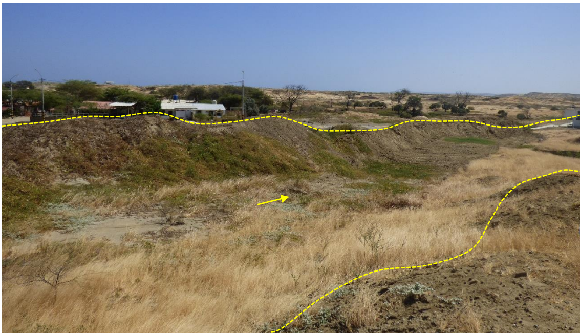
Figura 69. Zona crítica 20-010. Quebrada Zarumilla, zona de flujos de lodo evidenciado con la presencia de material suelto de arenas y limos, colmatada principalmente por material traído anteriormente. El cauce de la quebrada se encuentra canalizado con arrimado de material y atraviesa vía principal mediante un badén. (N: 9508528, E: 470244, 29/08/2023).
