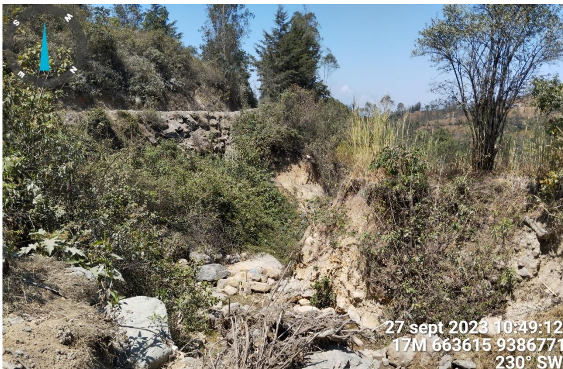
Figura 233. Zona crítica 20-171 Se identificaron deslizamientos con 470 m de largo y 50 m de ancho en ambas márgenes de la quebrada Sumuche, estos deslizamientos generan flujos de detritos en la quebrada, sin embargo, se considera que los deslizamientos como eventos principales ya que pueden afectar el área urbana de Sumuche Alto debido a movimientos retrogresivos.
