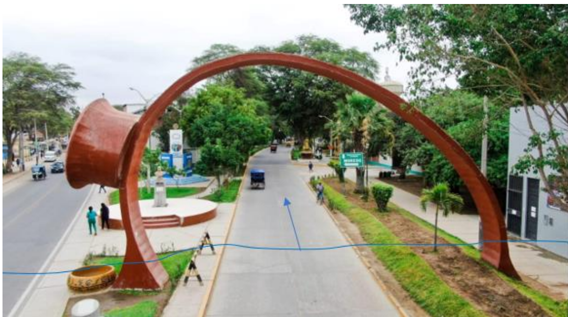
Figura 144. Zona crítica 20-082, Ciudad de Catacaos se asienta en la margen izquierda del río Piura, sobre una planicie inundable. (N: 9417798, E: 535798, 15/09/23).
