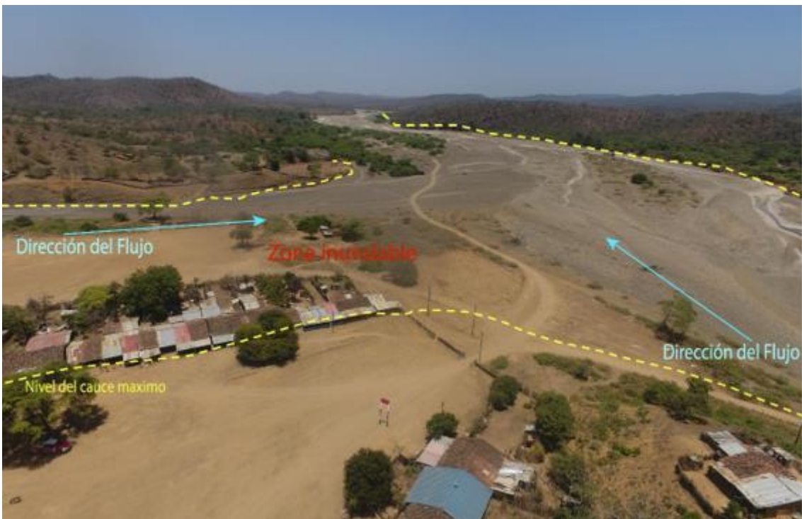
Figura 114. Zona Crítica 20-055, Se evidencia erosión en el margen derecho de la quebrada a menos de 50 m al área urbana del Chaylo (ubicada en la intersección de dos quebradas); así mismo hay una quebrada que arrastra detritos hacia el centro del pueblo (N: 9528497 E:554959, 13/09/2023).
