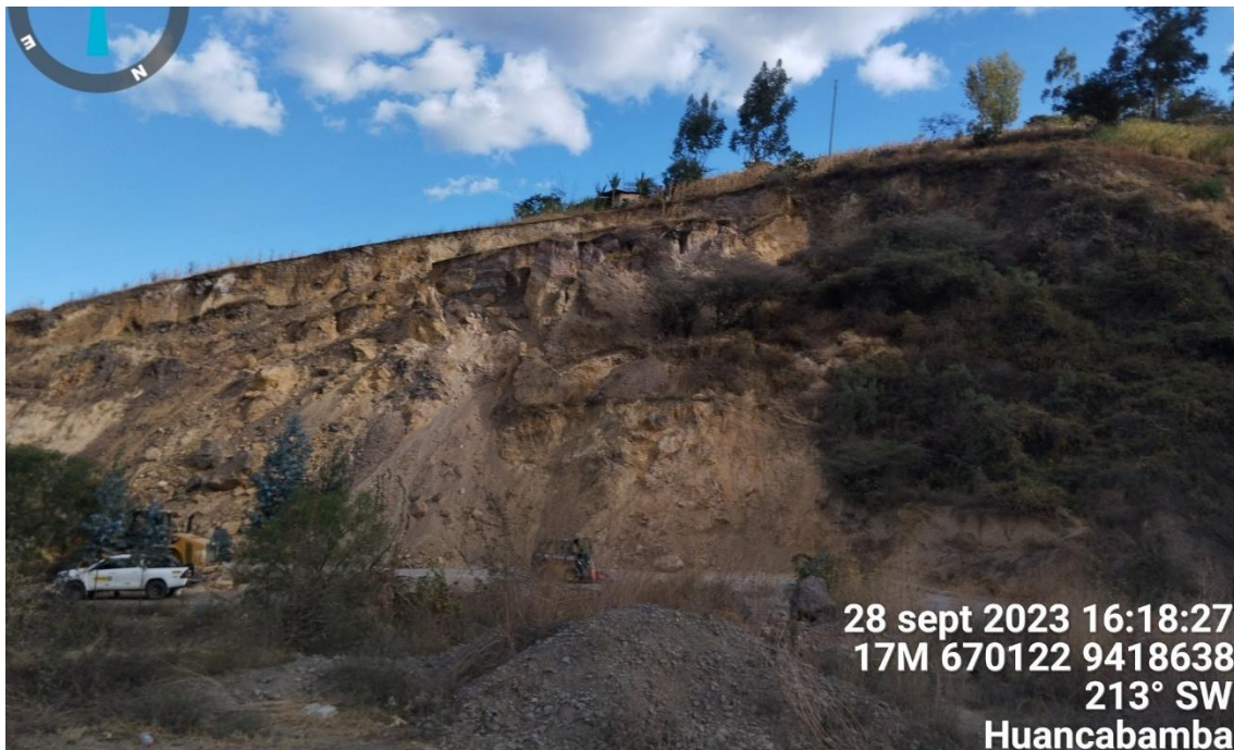
Figura 225. Zona crítica 20-163 En el sector Quispampa afloran secuencia volcanoclástica con intercalaciones de piroclastos de ceniza y lapilli, de composición andesítica y riolítica modelando relieves montañosos en roca volcánica. Se identificó un deslizamiento de tipo rotacional de 165 m de ancho y 80 m de largo, el escarpe tiene 190 m de largo con salto de 2 m de alto.
