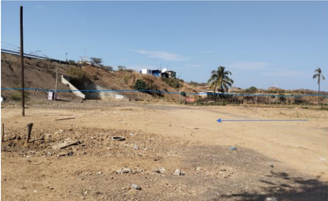
Figura 117. Zona crítica 20-057 Se evidencia que el río en temporada de avenida llega a desbordar aproximadamente en 8.2 has, a hasta las infraestructuras que han sido construidas al margen izquierdo sobre los depósitos fluviales, además, afecta terrenos de cultivo y la base de la estructura del puente.
