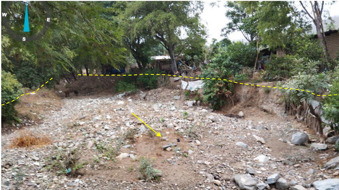
Figura 196. Zona crítica 20-134 Se identificó flujo de detritos que se desplazan de norte a sur sobre conos formados al pie de las laderas, tiene 54 m de ancho, se extiende aguas arriba donde se emplaza el área urbana hasta 550 m. (N: 9429746, E: 616757, 17/09/23).
