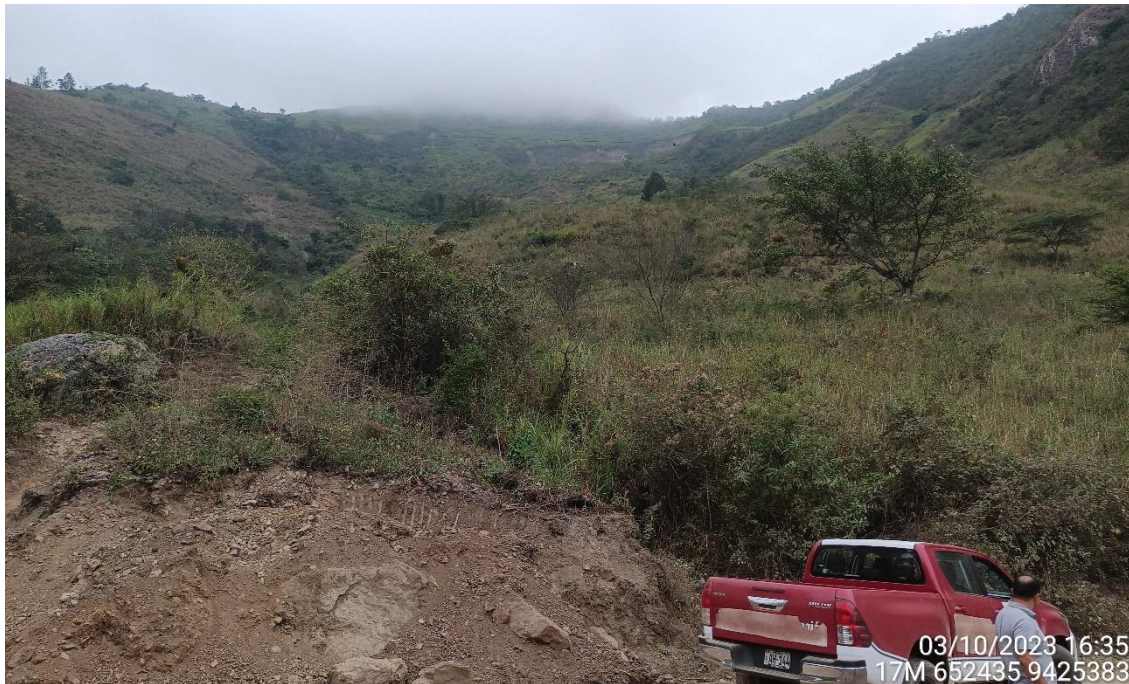
Figura 216. Zona crítica 20-154 El caserío La Virgen se asienta sobre un depósito coluvio deluvial modelado por la ocurrencia de antiguos deslizamientos y avalanchas, mientras que, en la parte alta afloran areniscas cuarzosas blanquecinas, limoarcillitas grises y niveles de carbón. Se han identificado un deslizamiento rotacional de 195 m de ancho y 420 m de largo con un escarpe de 280 m de largo. Además de, caídas de rocas en afloramientos de areniscas muy fracturadas.
