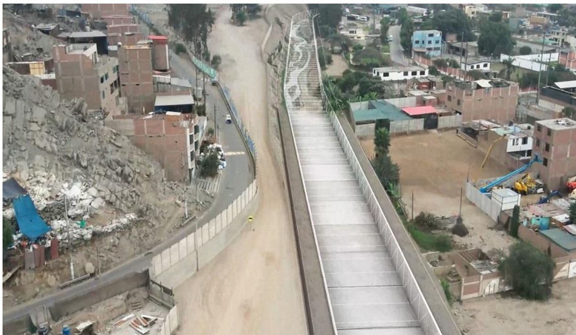
Fotografía 37. Canalización de una quebrada en los márgenes de un sector urbano.
