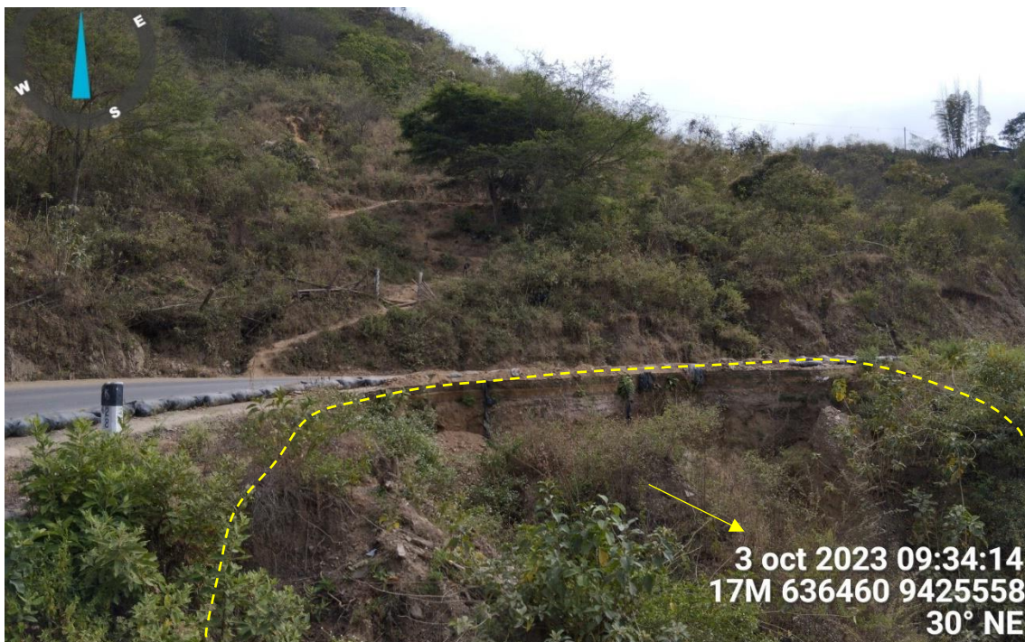
Figura 201. Zona crítica 20-139 El escarpe del deslizamiento tiene 28 m de largo, el deslizamiento tiene 30 m de ancho y 40 m de largo. Las cárcavas tienen 400 m de largo, 5 m de ancho y 3 m de profundidad. (N: 9425558, E: 636460, 03/10/23).
