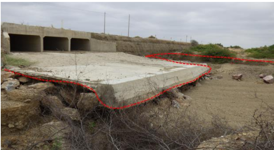
Figura 77. Zona crítica 20-018. En el Km 58 + 050, Puente de 20m de longitud, afectado por flujos de detritos. En la vía, la zona de relleno de acceso al puente, está afectada por procesos de erosión de ladera con avance retrogresivo, de seguir el proceso el puente quedará inhabilitado. (N: 9484230, E: 487888, 29/08/2023).
