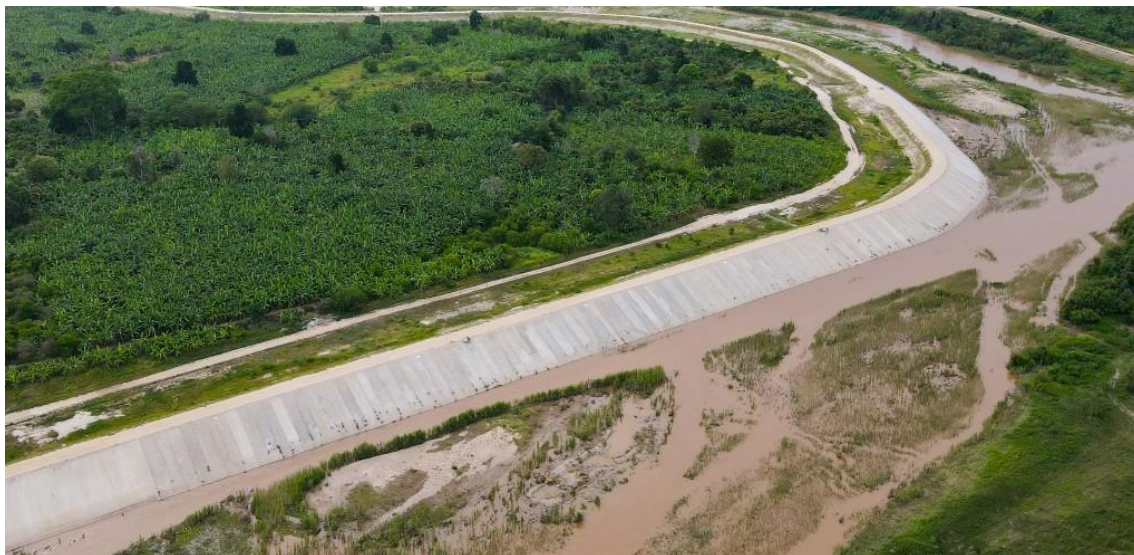
Fotografía 39. Ejemplo de una defensa ribereña con un muro de concreto.
