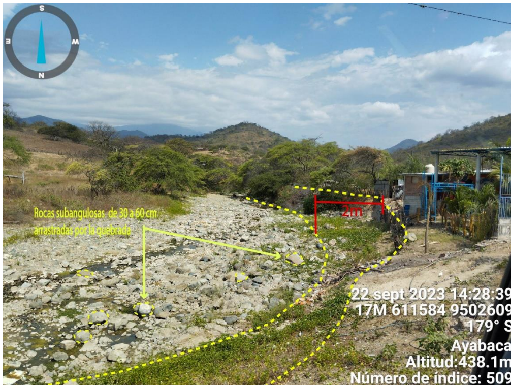
Figura 156. Zona crítica 20-094. Sector afectado por flujos de detritos provenientes desde el sector Coche Corral de norte a sur. (N: 9502609 E: 611584 22/09/23).
