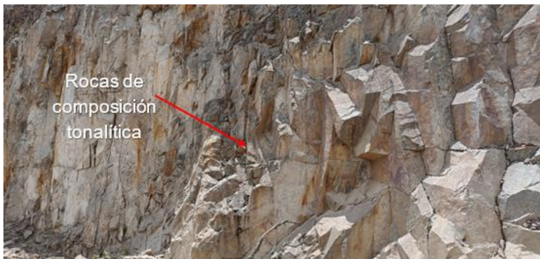
Figura 15. Rocas tonalíticas, moderadamente fracturada con presencia de patinas de óxidos de hierro en las caras de las discontinuidades, además se evidencia volcadura de rocas. Coordenadas: E: 658590; N: 9405964 (29/09/2023).
