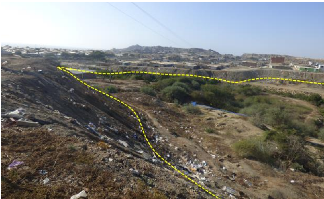
Figura 78. Zona crítica 20-019. Quebradas Micaela, zona afectada por flujos de lodo y erosión de ladera. Los flujos se presentan en muchos sectores y tienen su origen en la erosión de ladera que aportan material a las quebradas principales. En muchas de estas torrenteras se presenta viviendas dentro de los cauces como también hacia las márgenes. Aguas abajo, se encuentran canalizados con drenajes tipo calle canal; sin embargo, aguas arriba, con arrimado de material. (N: 9486934, E: 466605, 29/08/2023).
