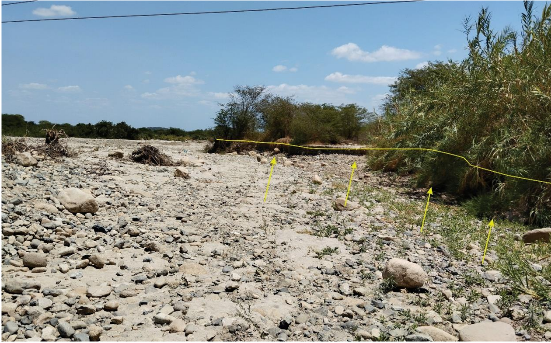
Figura 187. Zona crítica 20-125. El río Yapatera se activa por flujo de detritos y/o lodos, además de, inundación de tipo fluvial hacia el margen izquierdo, afectando terrenos de cultivos. (N: 9438456, E: 597554, 17/09/23).
