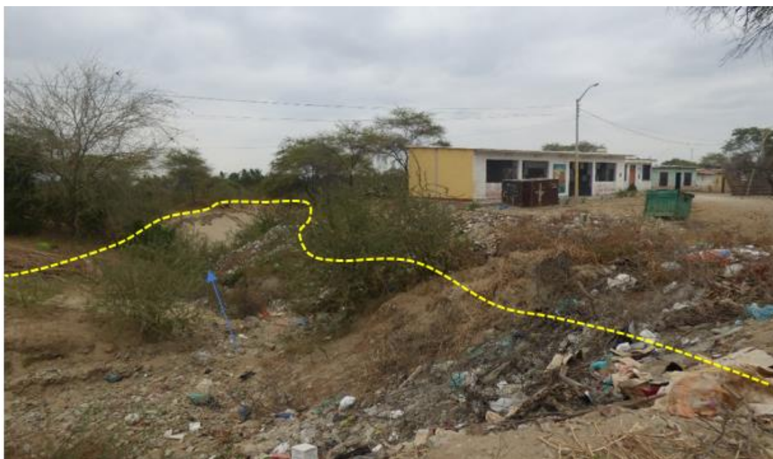
Figura 126. Zona crítica 20-065. Sector afectado por flujos de lodo que provienen de erosión en cárcavas. Las torrenteras en su mayoría están ocupadas por viviendas dentro y hacia los márgenes del cauce. El cauce está conformado por material suelto como arenas, además basura y desmote. (N: 9457690 E:527774, 16/09/2023).
