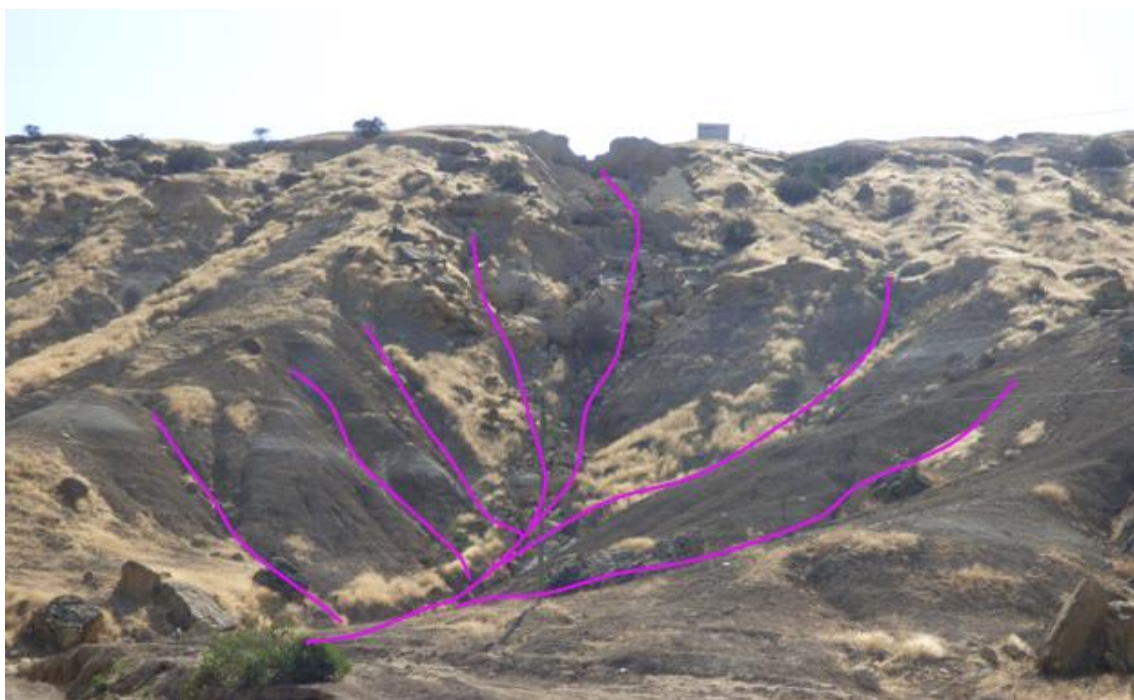
Figura 81. Zona crítica 20-022. Sector Cementerio, sujeto a flujos de lodo proveniente de erosión de laderas. Hacia las partes altas, la quebrada presenta una canalización, hacia las laderas se tiene material suelto que puede originar derrumbes. Los flujos pueden afectar la alcantarilla que cruza vía Amotape - Vichayal. (N: 9462424, E: 492577, 29/08/2023).
