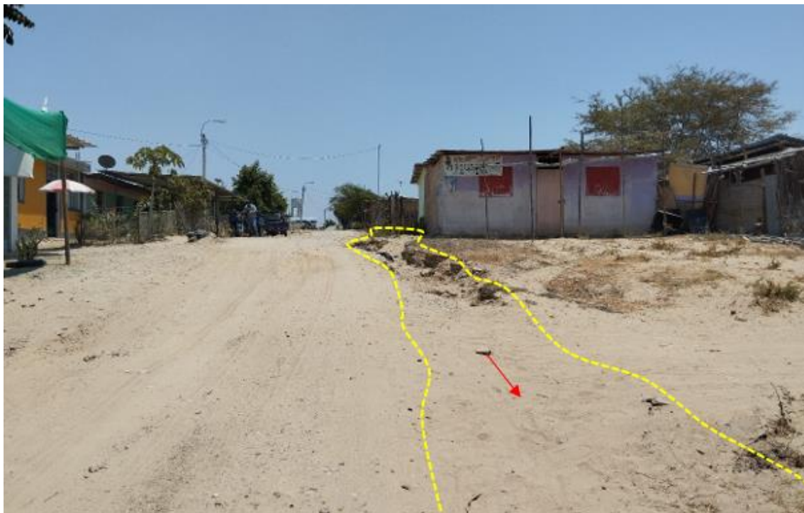
Figura 135. Zona crítica 20-073. Este sector se encuentra en una planicie depósitos eólicos que en temporada de lluvia se saturan, se parecían procesos de erosión de ladera que forma una escorrentía. (N: 9440774, E: 540908, 14/09/23).
