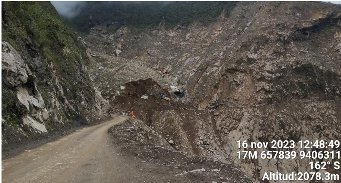
Figura 218. Zona crítica 20-156. Quebrada El Limón, el 15 de marzo del 2023 ocurrieron deslizamientos en la parte alta del sector Las Minas, que provocaron un flujo de detritos que descendió por la quebrada El Limón hasta el área urbana de Canchaque. Este evento tuvo como zona de arranque laderas con afloramientos de tonalitas y granodioritas muy fracturadas y meteorizadas con depósitos coluvio deluviales.
