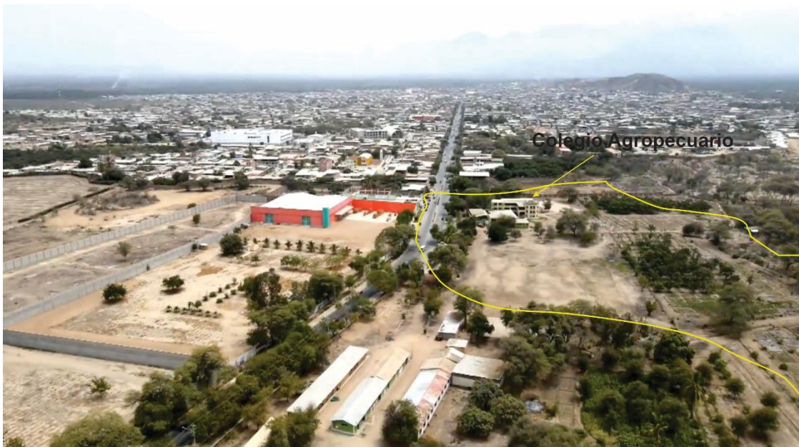
Figura 188. Zona crítica 20-126. Vista hacia uno de los puntos inundables, es el Colegio Agropecuario donde el agua llega a superar hasta 1 m de altura. (N: 9435354, E: 592025, 17/09/23).
