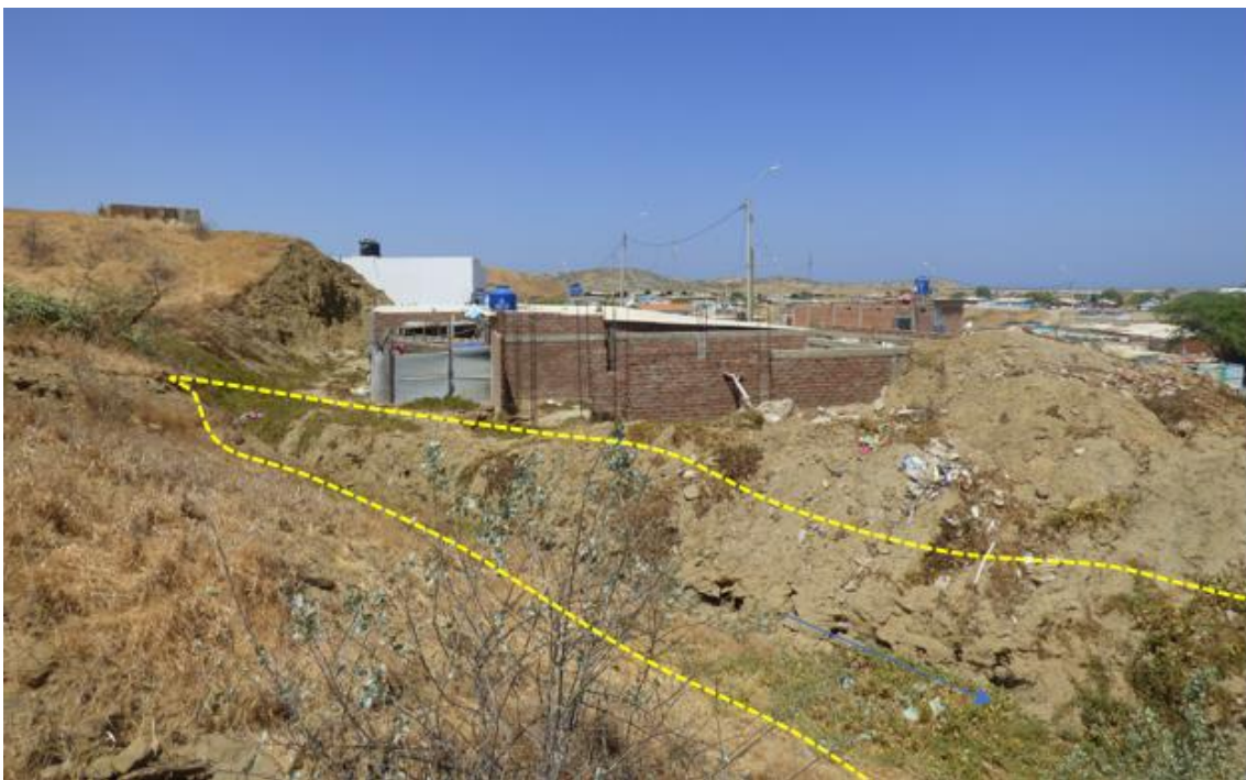
Figura 71. Zona crítica 20-012. Sector La Primavera, sujeto a derrumbes y procesos de erosión de ladera, como también flujos de detritos o lodo. Los flujos de detritos o lodo, se generan por los procesos de erosión de ladera. Afectan las viviendas de los nuevos asentamientos humanos. (N: 9507519, E: 469483, 29/08/2023).
