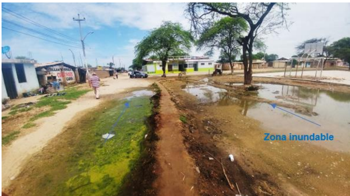
Figura 148. Zona crítica 20-086. El caserío Pozo de Los Ramos se encuentra a 2.6 km al este del río Piura en la margen izquierda, el área urbana se asienta sobre una planicie inundable (N: 9409314, E: 537524, 15/09/23).
