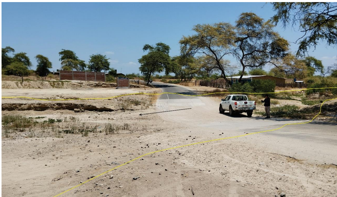
Figura 184. Zona crítica 20-122. Se identificó una quebrada que se activa por flujo de detritos que desciende por la quebrada Las Pampas, el flujo tiene un ancho aproximado de 42 m, el desborde del agua causa la inundación de viviendas e interrumpe el normal tránsito entre caseríos aledaños. (N: 9446974, E: 593227, 17/09/23).
