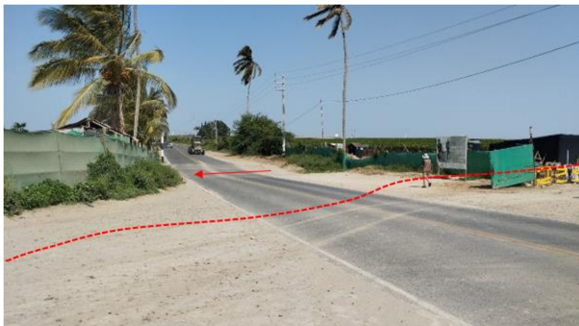
Figura 128. Zona crítica 20-067. Sector San Silvestre, en la margen derecha se ubican 8 viviendas a menos de 20 m del cauce en una zona inundable, (N: 9441611, E: 545299, 15/09/23).
