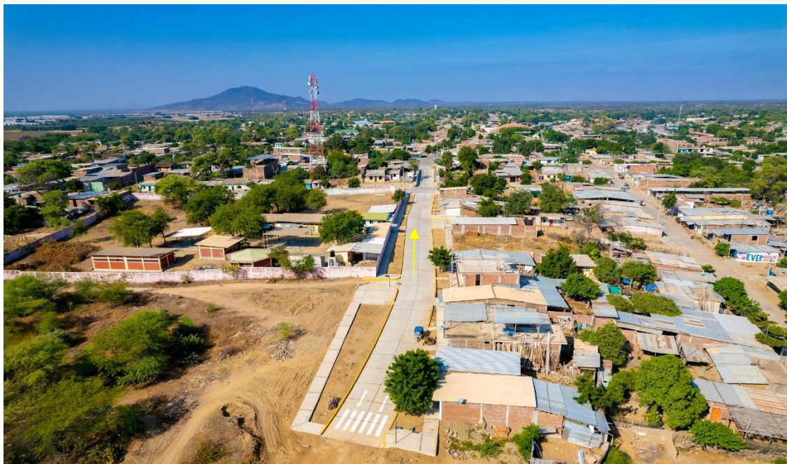
Figura 203. Zona crítica 20-141. En Villa La Matanza se han identificado inundaciones de tipo fluvial donde se activan quebradas que afectan viviendas e instituciones educativas con alturas o tirantes de agua 0.5 m. (N: 9423344, E: 600481, 26/09/23).
