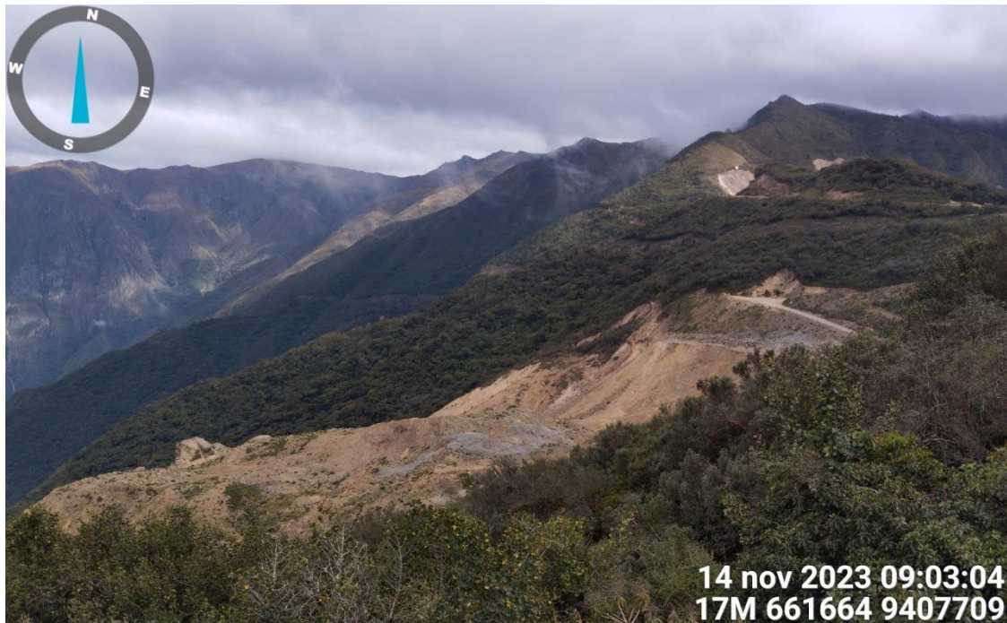
Figura 217. Zona crítica 20-155 En el mes de marzo del 2021 ocurrió un deslizamiento con posterior fase de flujo debido al colapso del DME-111 ubicado en el sector El Tambo o Cruz Blanca.
