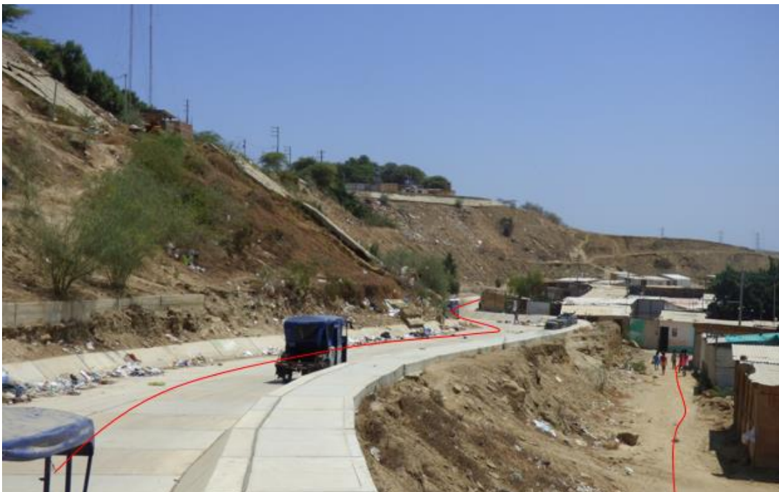
Figura 76. Zona crítica 20-017. Los acantilados del sur de la ciudad de Talara son afectados por erosión en cárcavas, las cuales se activan de manera excepcional (fenómeno de El Niño). La mayoría de las cárcavas han sido encauzadas con canales de concreto; sin embargo, algunas de las viviendas se encuentran localizadas muy cerca de las cárcavas o de los canales de desviación; en otros casos, las torrenteras cruzan la carretera por medio de badenes. (N: 9492788, E: 471130, 29/08/2023).
