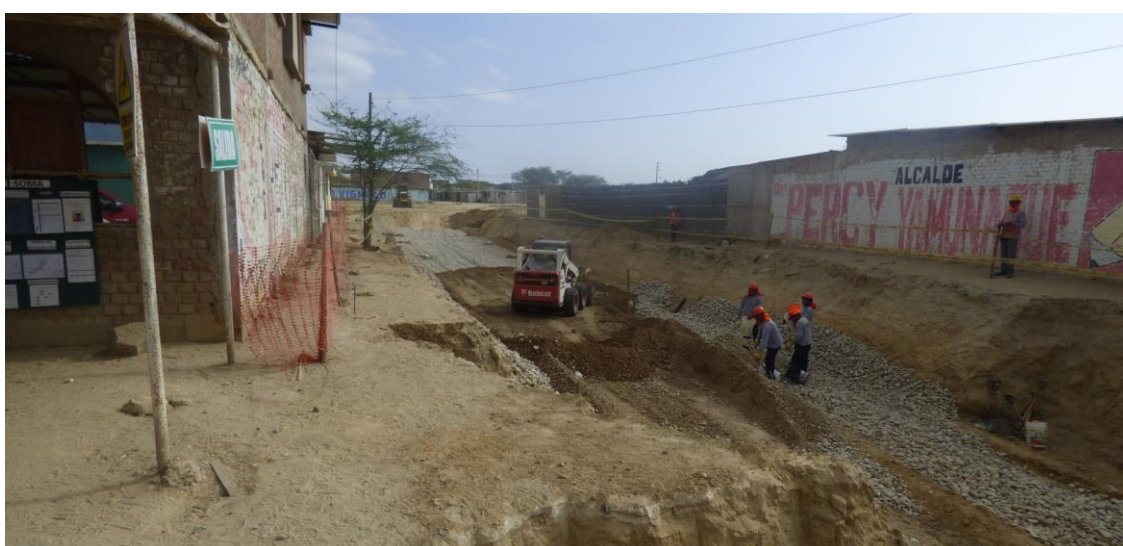
Fotografía 21. Sectores Pablo de la Flor, Tablazo Sur, Tablazo Norte, Yapato y San Martín de Letirá con ocurrencia de flujos de lodos, distrito La Unión. ZC 20-090.
