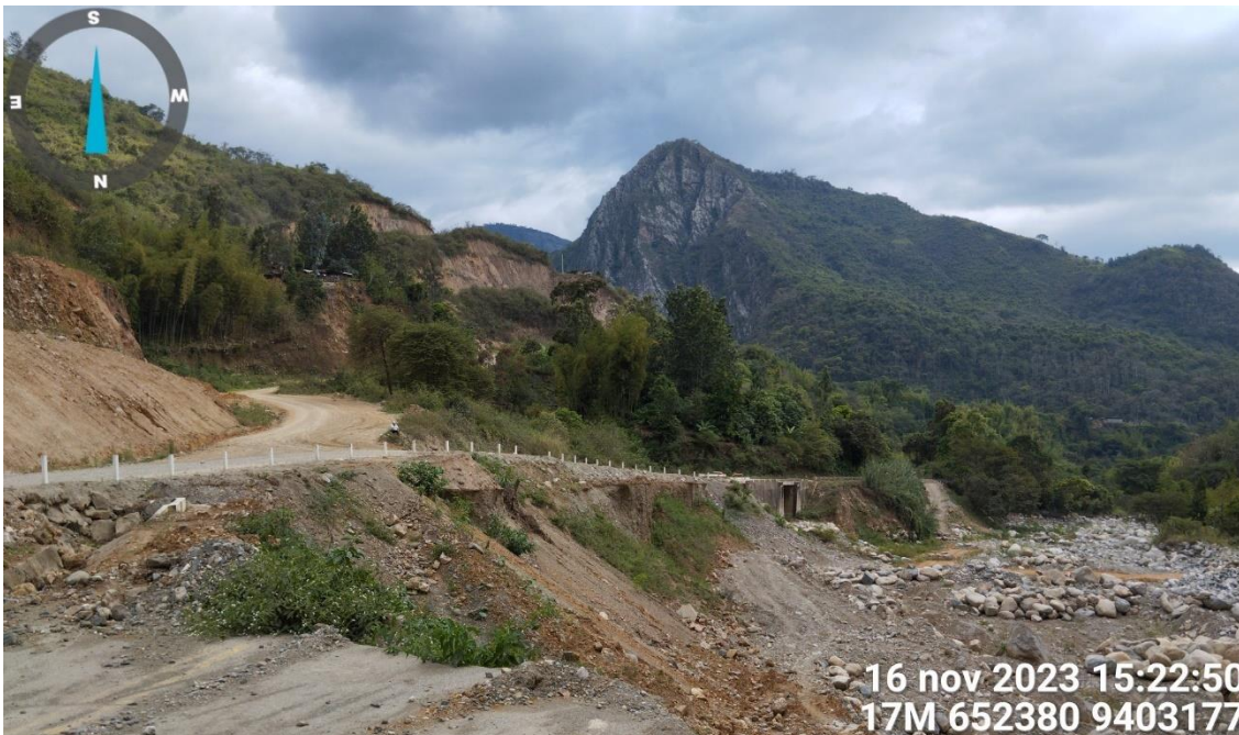
Figura 221. Zona crítica 20-159 Deslizamiento de tipo rotacional de 225 m de ancho y 523 m de largo. Erosión fluvial debido de 170 m de vías asfaltada a la ocurrencia de flujo de detrito (Evento Pusalca) y Evento Qda. El Limón.
