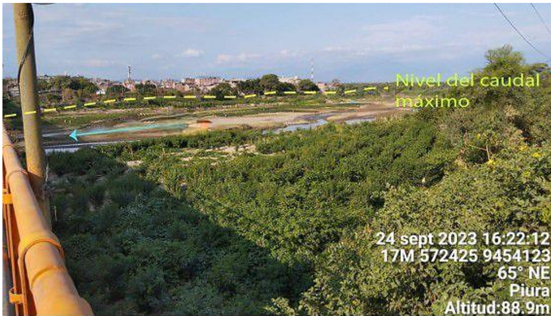
Figura 133. Zona crítica 20-071. Se muestra un puente, hacia la margen derecha se aprecian viviendas del casco urbano, que pueden ser inundadas en temporada de lluvia. (24/09/23).
