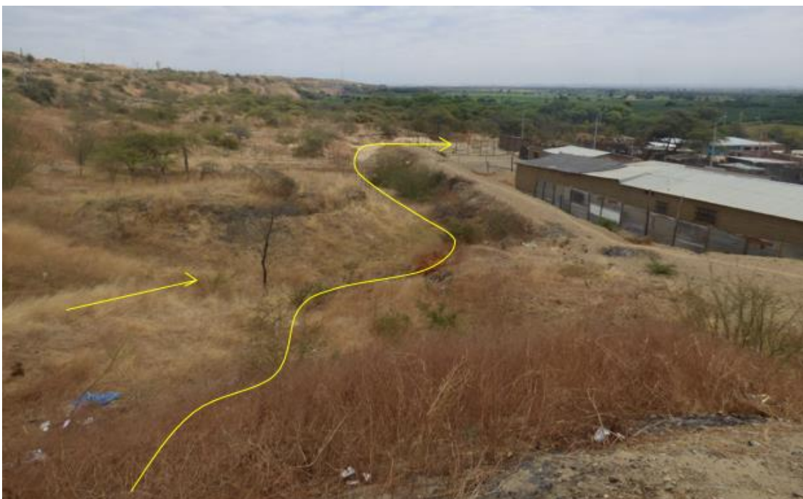
Figura 90. Zona crítica 20-031. C.P. Macará, el sector se encuentra afectado por flujo de lodo originados por erosión de laderas de las zonas altas. La quebrada receptora no presenta canalización, solo un dique de 2m. de altura que protege parcialmente las viviendas. (N: 9456055, E: 515562, 29/08/2023).
