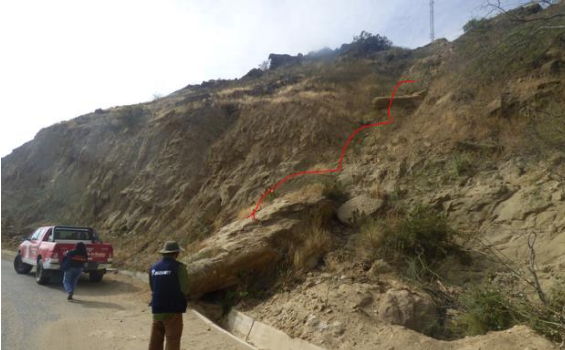
Figura 68. Zona crítica 20-009. Se presentan derrumbes hacia las zonas altas. Afecta tramos de vía que conecta Cabo Blanco - El Alto, en los Km 1+800 y Km 2+200. (N: 9528615, E: 474485, 29/08/2023).
