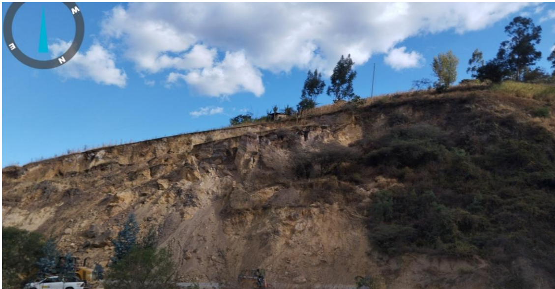
Fotografía 33. Deslizamiento rotacional en el sector Quispampa Alto en la vía Huancabamba-Canchaque.
