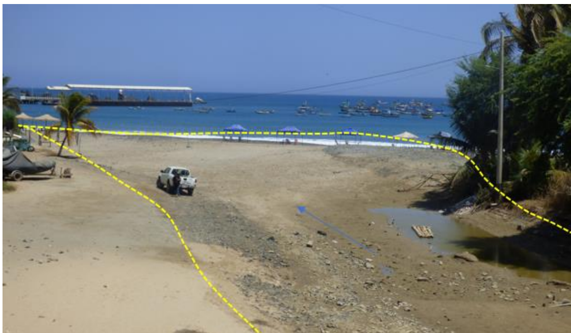
Figura 100. Zona crítica 20-041. C.P. Yacila, sector sujeto a flujos de detritos provenientes de la intensa erosión de laderas que alimentan la quebrada principal. Presenta desembocadura en el mar, presenta viviendas y hoteles hacia los márgenes. (N: 9432910, E: 481399, 09/09/2023).
