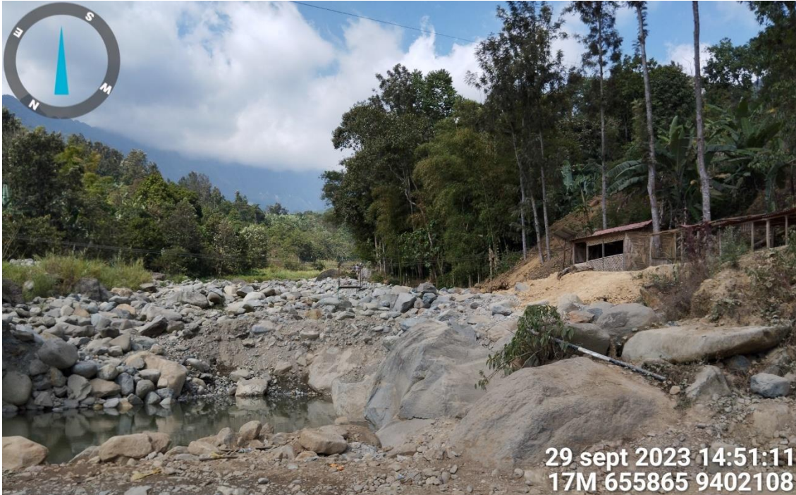
Figura 222. Zona crítica 20-160 La quebrada Los Chorros se activa por flujo de detritos con un ancho de 45 m y una extensión total de recorrido desde la naciente de 11.5 km.
