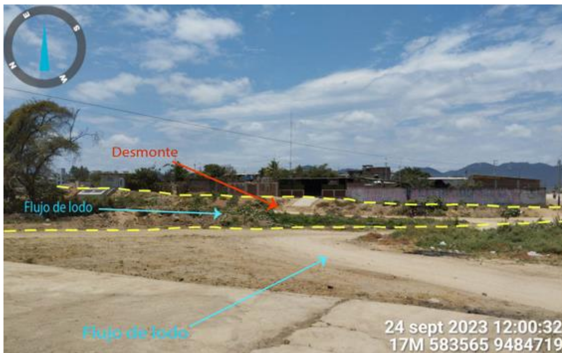
Figura 127. Zona crítica 20-066 En temporada de avenida la quebrada cubre un cauce mayor afectando a 12 viviendas como la carretera afirmada 260m, mientras que la erosión fluvial va desde el punto E:583460 N:9484789 que se encuentra al este de punto de observación principal hasta el oeste en las coordenadas E:583576 N:9484823 en aproximadamente 1km de recorrido (N: 9484712, E: 583592 24/09/2023).
