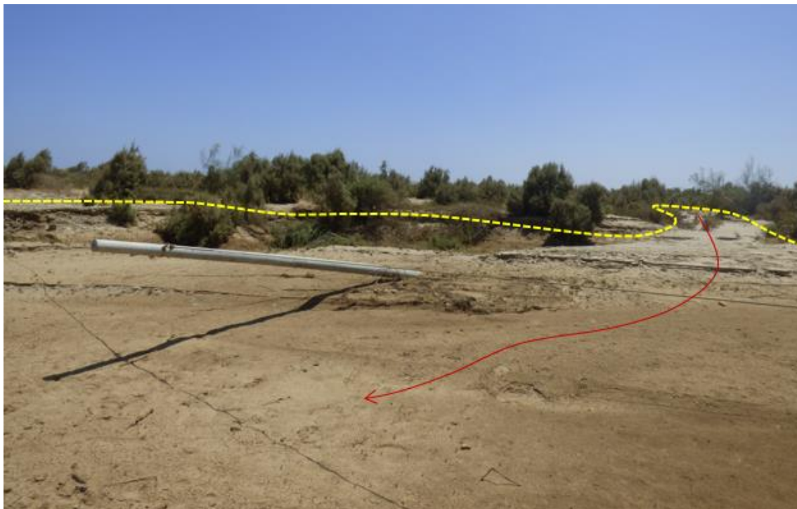
Figura 72. Zona crítica 20-013. Las quebradas Honda y Pariñas presentan cauce con ancho variable de hasta 400 m. Se generan flujos de detritos en tiempos de lluvias excepcionales y fenómenos de El Niño afecta tramos de vía Lobitos con Talara, dejando incomunicado. (N: 9501870, E: 469963, 29/08/2023).
