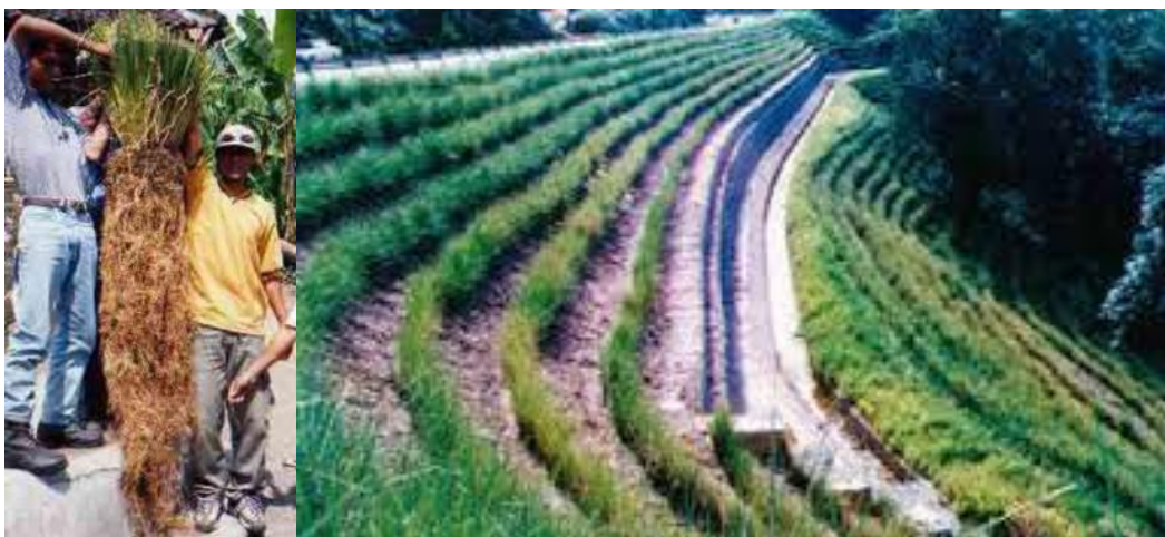
Fotografía 36. Ejemplo de bioingeniería con arbusto (vetiver) en taludes de materiales sueltos.
