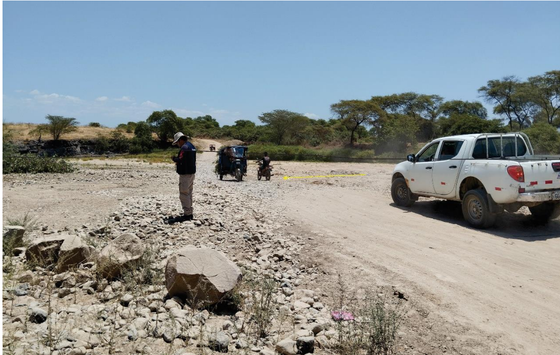
Figura 185. Zona crítica 20-123. Activación de la quebrada Cruz Pampa, que generó flujo de detritos que tiene un ancho aproximado de 72 m. (N: 9443961, E: 592614, 17/09/23).
