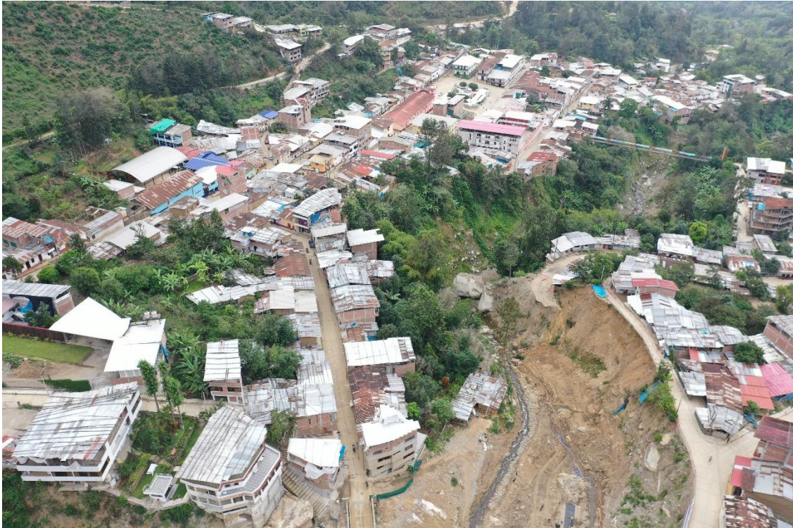
Figura 220. Zona crítica 20-158 El flujo de detritos que descendió desde el sector Las Minas y se encausó en la quebrada El Limón afectando el área urbana de Canchaque, ubicada sobre un depósito coluvio deluvial antiguo. El flujo de detritos alcanzó 8 m de alto y 20 m de ancho.
