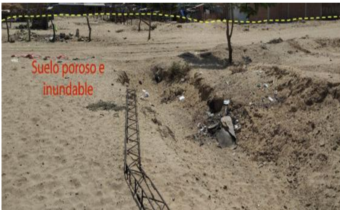
Figura 134. Zona crítica 20-072. Se aprecia viviendas e infraestructura del centro poblado Olivares de San Fernando, se ubican en una depresión expuesta a inundación pluvial en temporada de lluvias extraordinarias (N: 9450896, E:544194 14/09/23).
