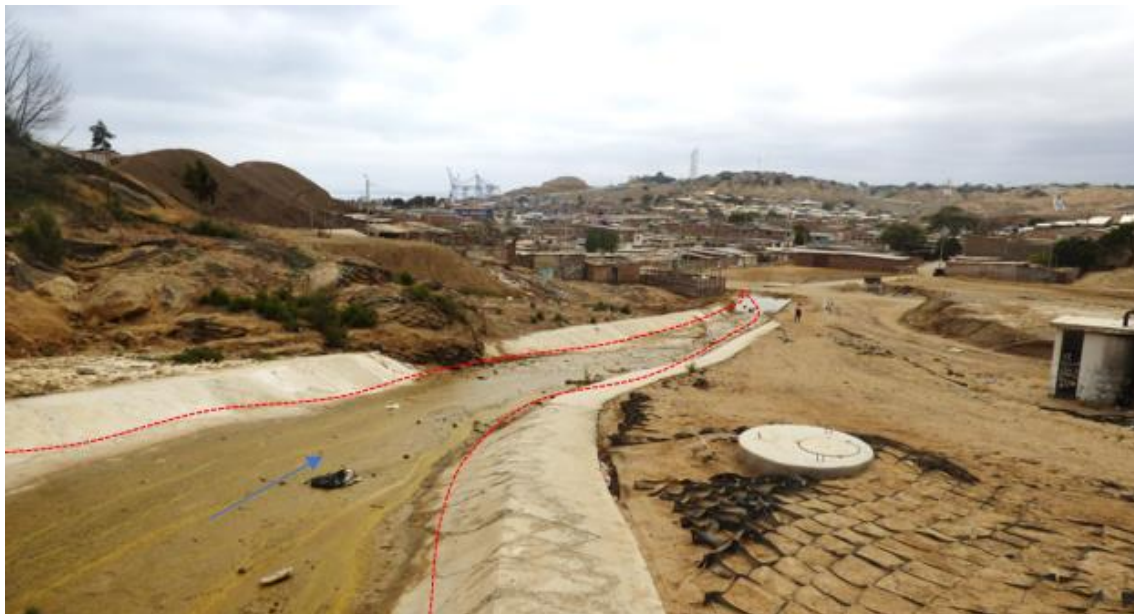
Figura 99. Zona crítica 20-040. En el cerro Llorón, ubicado en las partes altas del sector Pueblo Joven San Martín Central, es lugar de constantes derrumbes y flujos de detritos originados por abundantes surgencias de agua entre los estratos rocosos de diferente permeabilidad (Formaciones Chira y Mirador), así, los materiales saturados son removidos hasta el casco urbano de la parte baja del sector. (N: 9437016, E: 487078, 29/08/2023).
