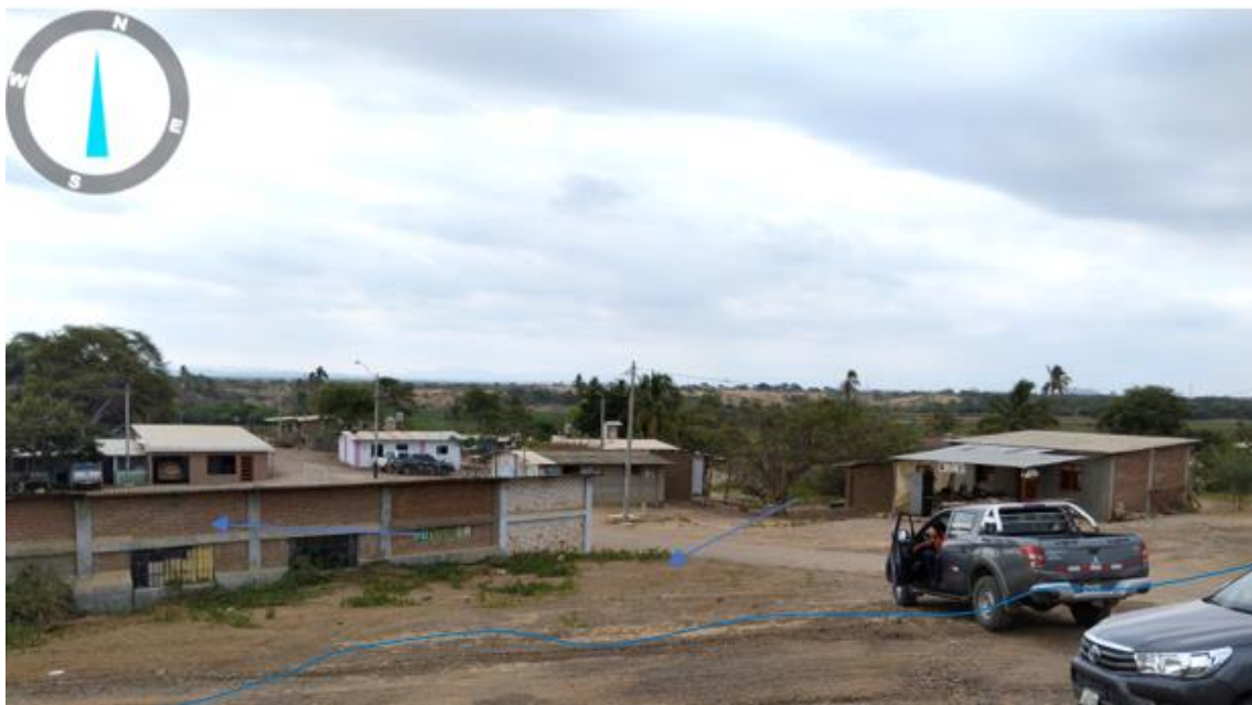
Figura 120. A. Zona crítica 20-060. Centro poblado Chilaco Pelado y Riecito, que pueden ser afectadas por inundación, el río fluye de este a oeste (líneas azules) con alturas probables de hasta 1.5 m ante lluvias excepcionales (N:9480585 E:556118 15/09/23).
