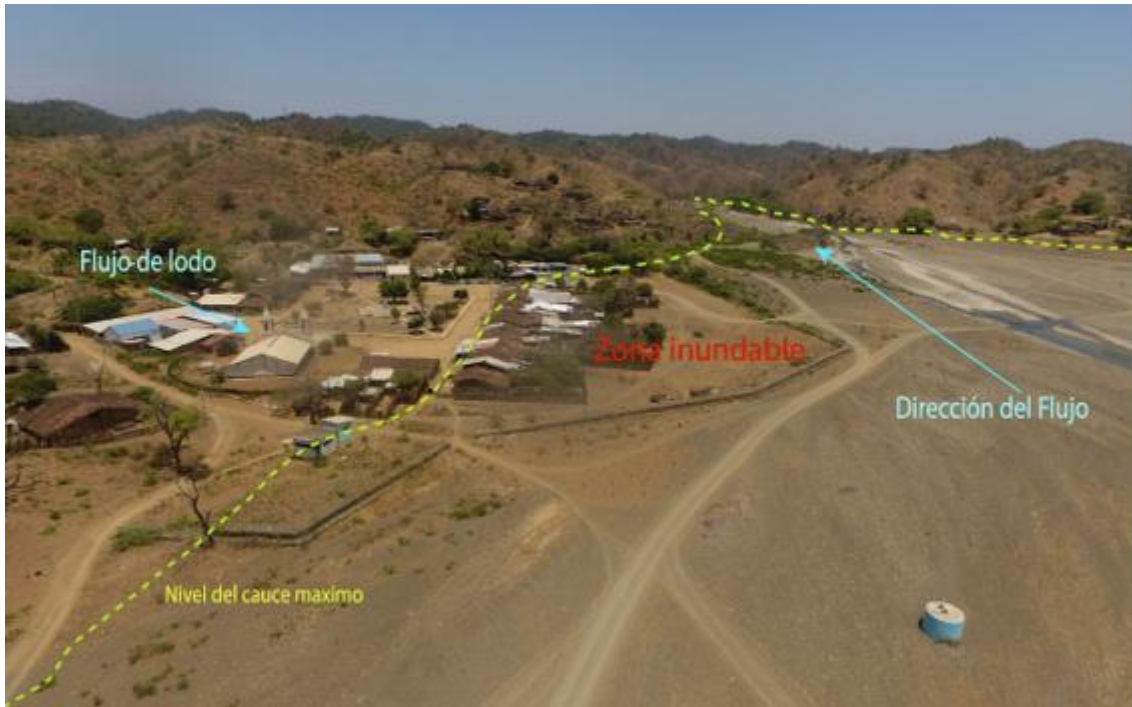
Figura 115. Zona Crítica 20-056. Caserío Los Encuentros de Pilar, la quebrada arrastra flujos de detritos aumentando el ancho del cauce e inundando viviendas y terrenos de cultivo que se encuentran en el cauce de la misma. Afectan alrededor de 20 viviendas y 1.23 has de cultivo (N: 9522060 E:555124, 13/09/23).
