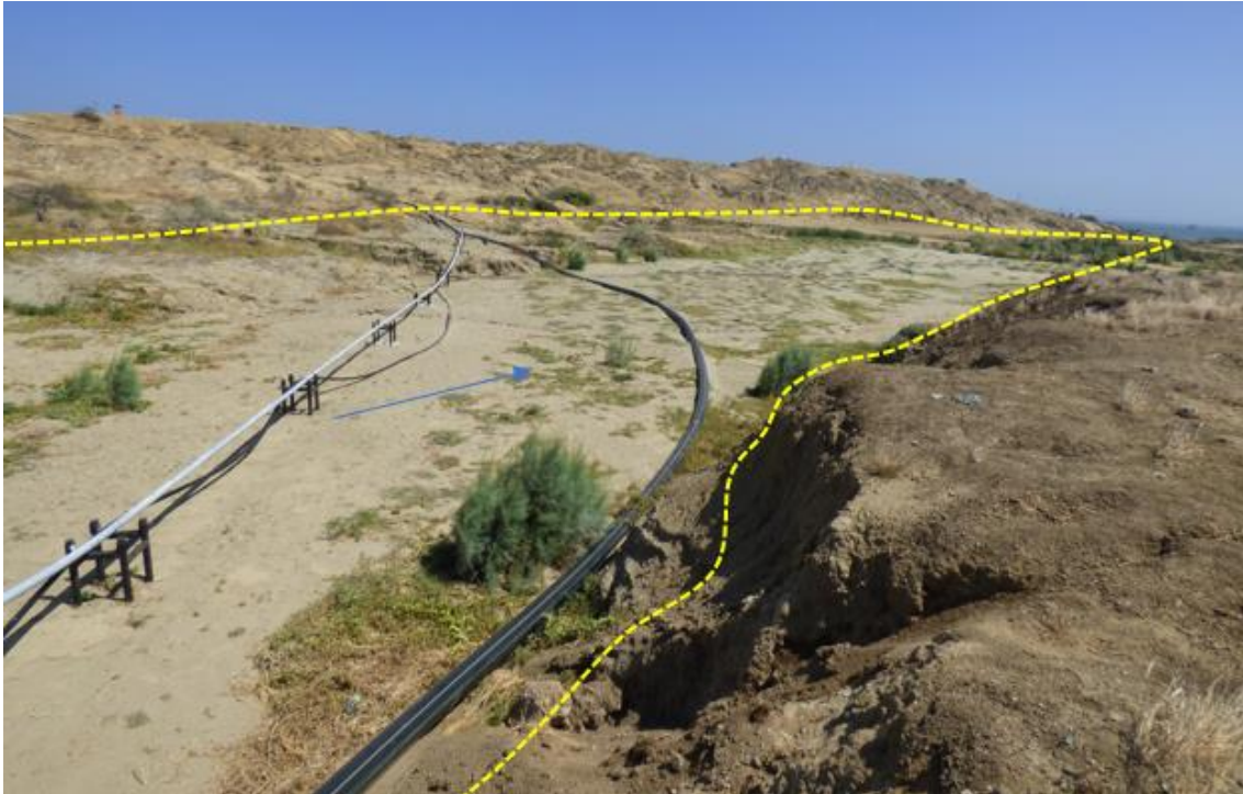
Figura 70. Zona crítica 20-011. Quebrada Nuevo Lobitos presenta un ancho promedio de 30 m, en el lecho tiene principalmente arena y limos. La quebrada se activa durante fenómenos de El Niño y/o períodos de lluvias excepcionales. (N: 9507598, E: 468536, 29/08/2023).
