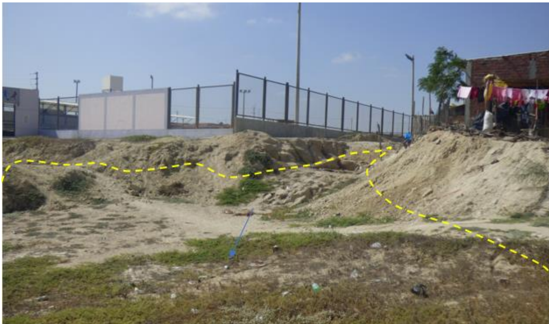
Figura 105. Zona crítica 20-046 El sector se encuentra afectado por flujos originados por erosión de laderas. Estos discurren por torrenteras hasta llegar a formar cuencas ciegas, afectando viviendas, vías de comunicación, colegios e infraestructura deportiva.
