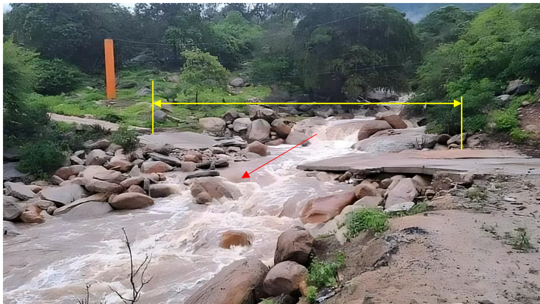
Figura 176. Zona crítica 20-114. Se identificó la ocurrencia de flujos de detritos que se desarrollan en la quebrada Huabal, este flujo interrumpe el tránsito vehicular y destruye 45 m de pista asfaltada, además de viviendas ubicadas 60 m aguas abajo en el margen izquierdo. (N: 9474413, E: 605180, 22/09/23).
