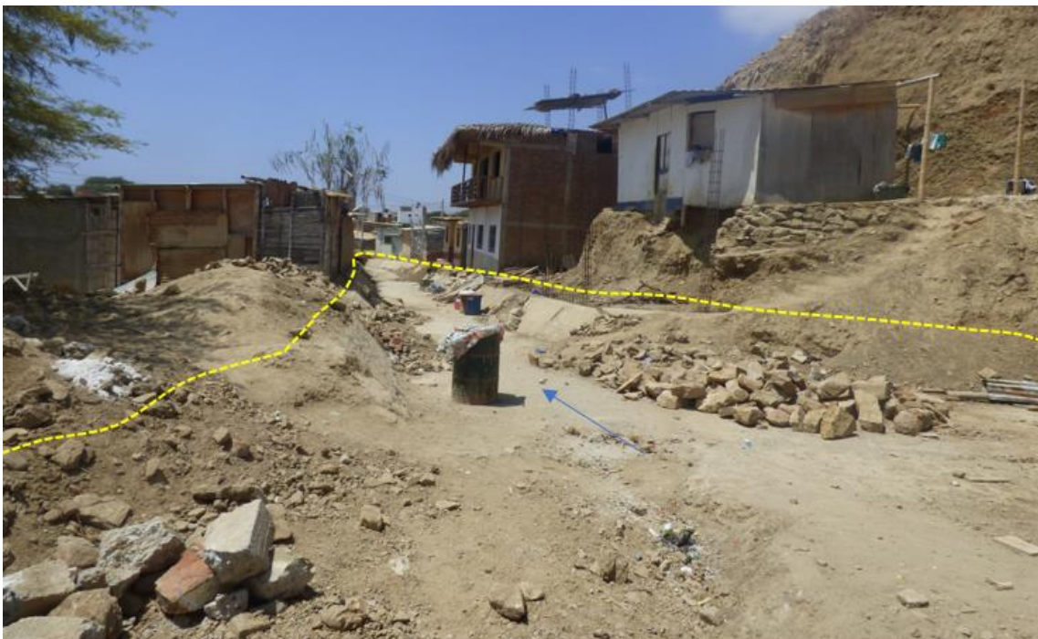
Figura 65. Zona crítica 20-006. A.H. 28 de Enero, área sujeta a flujos, derrumbes y erosión de laderas. Los flujos son originados por erosión de ladera. Los cauces están encausados, se tiene viviendas sobre los muros de contención. (N: 9537790, E: 485648, 29/08/2023).
