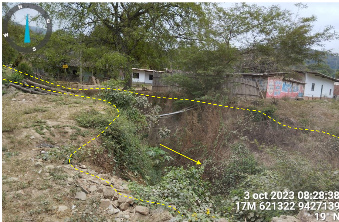
Figura 199. Zona crítica 20-137. Existen 03 quebradas importantes que se activan por flujo de detritos. La quebrada Maray tiene una obra en curso, muros de contención, enrocado y puente que no han considerado el ancho real del cauce. (N: 9427139, E: 621322, 03/10/23).
