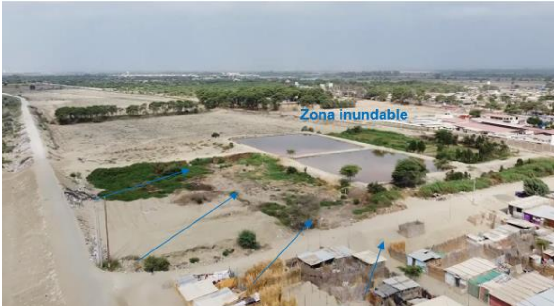
Figura 143. Zona crítica 20-081, Zona afectada por inundación fluvial debido al desborde del río Piura, afectando viviendas, terrenos de cultivos e interrumpiendo parcialmente los accesos de entrada y salida. (N: 9420116, E: 538659, 15/09/23).
