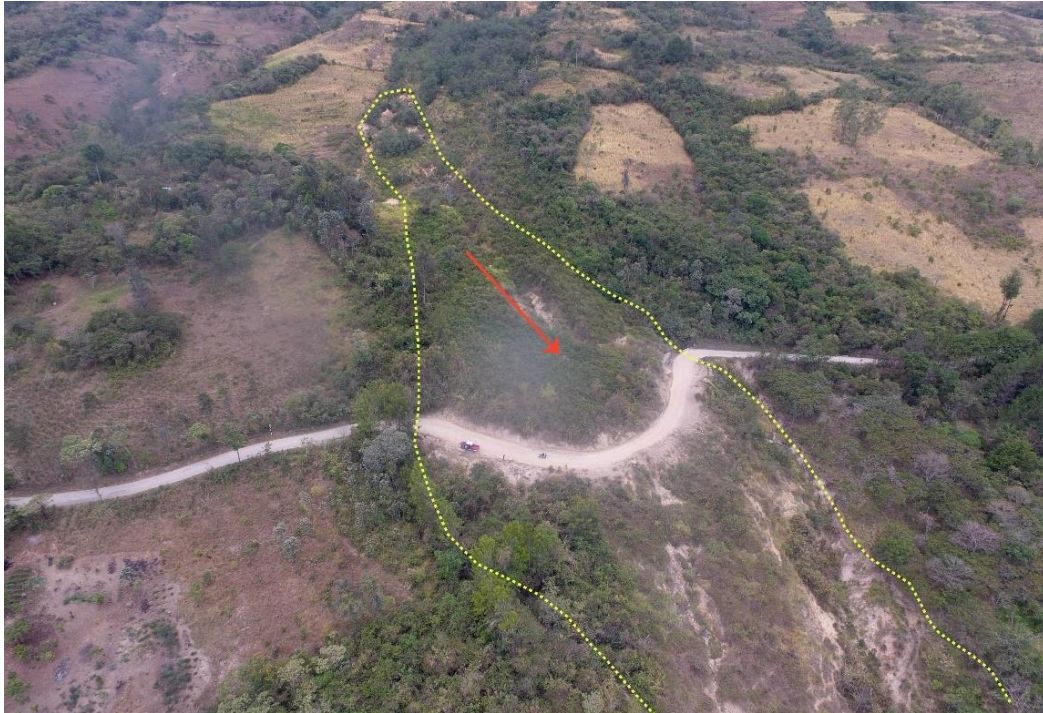
Figura 174. Zona crítica 20-112. Deslizamiento de dimensiones importantes, el escarpe alcanza 215 m de largo con saltos de 2 m. Puede afectar viviendas ubicadas 75 m ladera abajo y un total de 150 m lineales de una vía afirmada. este deslizamiento ha presentado reactivaciones en el mes de marzo del presente año y durante el 2017. (N: 9483773, E: 655523, 22/09/23).
