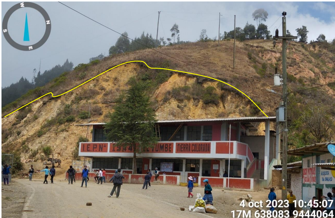
Figura 192. Zona crítica 20-130. El deslizamiento ocurrió desde el 2000, se reactivó en marzo del 2017 que extendió el cuerpo del deslizamiento de 45 a 120 m de largo y 25 a 100 m de ancho, el escarpe principal mide 75 m de largo. La escuela de nivel primario y secundario 15441 Yumbe-Tierra Colorada puede verse afectada. (N: 9444064, E: 638083, 04/10/23).
