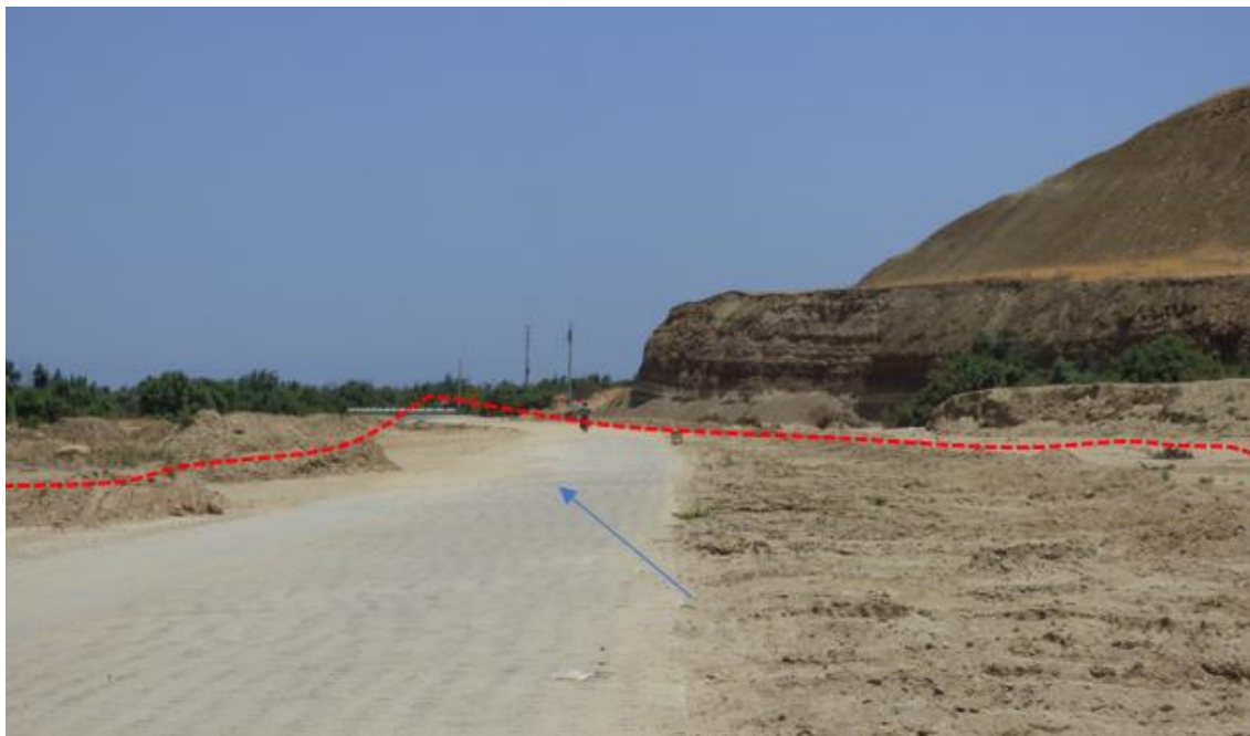
Figura 85. Zona crítica 20-026. Caserío Nuevo San Francisco, sector sujeto a flujos de detritos por quebrada Charanal. El cauce de la quebrada presenta un de 260 m. Conformado por material suelto de arenas, gravas, arcillas y cantos de diferentes composiciones, son de formas subangulosas a angulosos. (N: 9464357, E: 497477, 29/08/2023).
