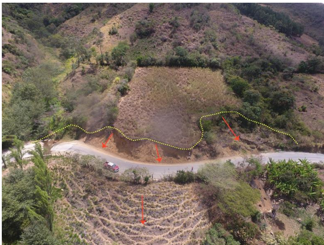
Figura 173. Zona crítica 20-111. Sector El Lúcumo, se identificaron varios deslizamientos de dimensiones importantes que puede afectar viviendas, cultivos y un total de 150 m lineales de una vía afirmada. Varios deslizamientos han presentado reactivaciones en el mes de marzo del presente año y durante el 2017. (N: 9484806, E: 657009, 22/09/23).
