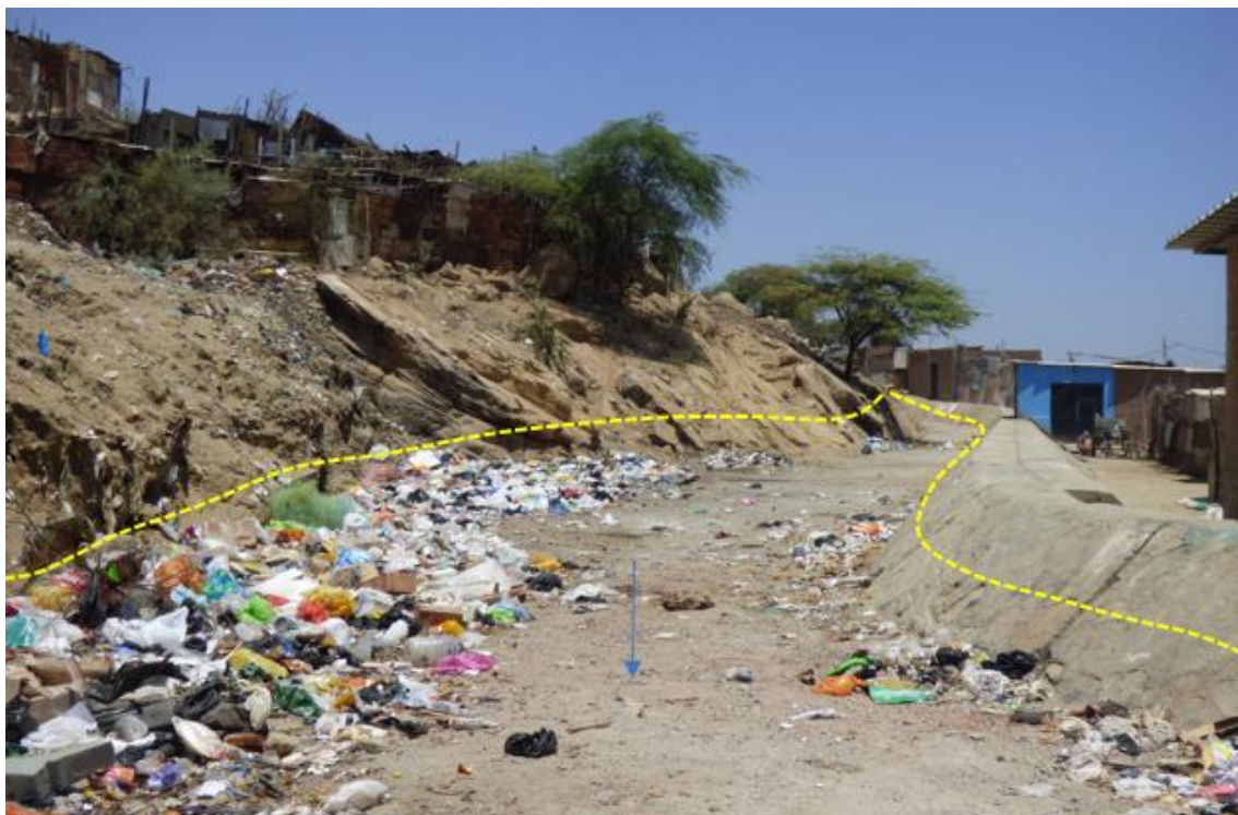
Figura 73. Zona crítica 20-014. Sector Ampliación Jesús María, afectado por flujos de lodo, derrumbes, caída de rocas y erosión de laderas. Los canales dejados por los procesos de erosiones de ladera, generan flujos de lodo o detritos. Los canales se encuentran colmatados por desechos sólidos y desmonte, además algunos bloques rocosos producto de caídas y derrumbes. (N: 9496171, E: 469838, 29/08/2023).
