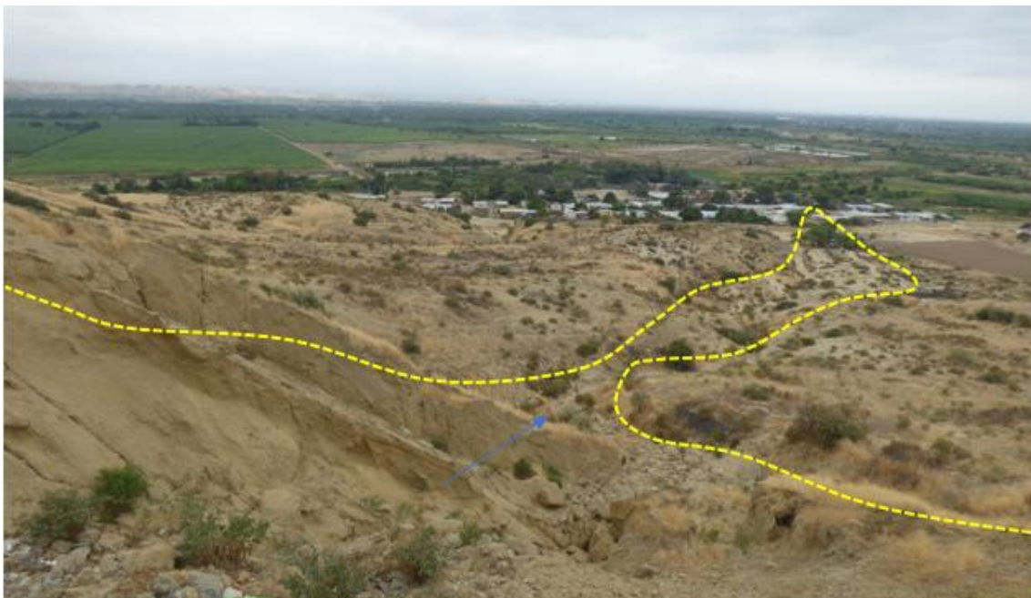
Figura 94. Zona crítica 20-035. CC.PP. Pucusulá y Buenaventura, tienen quebradas que atraviesan los centros poblados en varios tramos, afectando viviendas que se encuentran en los márgenes; y badenes en su paso por la vía principal. Se encuentran canalizadas con arrimado de material arrastrado en los anteriores flujos. El ancho del cauce oscila entre 10 y 12 m. estrechándose aguas abajo. (N: 9455557, E: 501016, 29/08/2023).
