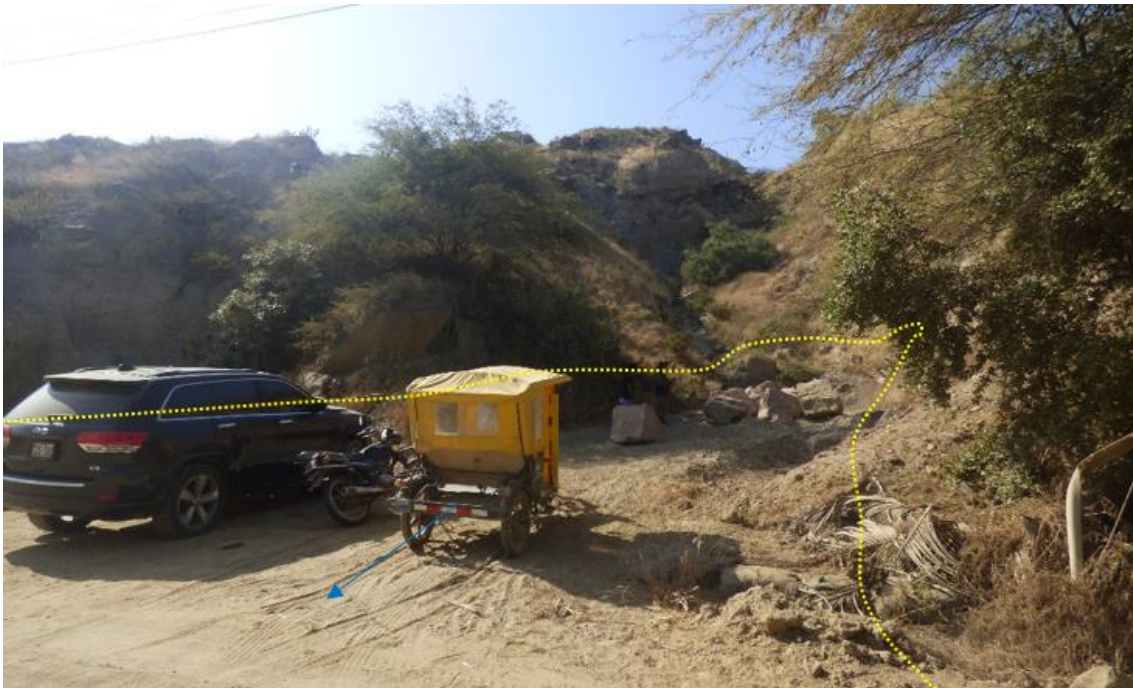
Figura 63. Zona crítica 20-004. El sector Las Pocitas es afectado por flujos de lodo, derrumbes, caídas de rocas y procesos de erosión de laderas. Los derrumbes o caída de rocas se dan en el acantilado del cerro Peña Mala, para la construcción de viviendas y hoteles han realizado cortes de talud en forma inadecuada, además se tienen viviendas al borde del talud. (N: 9545570, E: 491722, 29/08/2023).
