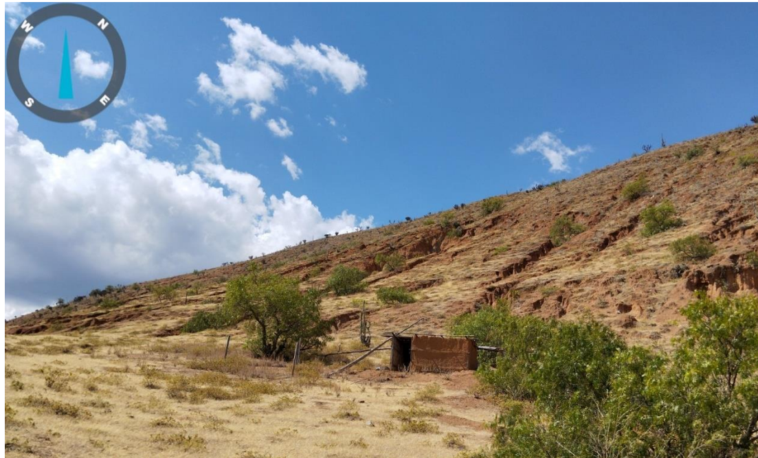
Figura 231. Zona crítica 20-169 Ambos caseríos tienen relieves que se encuentran cubiertas por depósitos coluvio deluviales de naturaleza arcillosa muy susceptibles a procesos de erosión y formación de cárcavas. Se identificaron procesos de erosión de laderas de 320 m de largo y 3 m de ancho.
