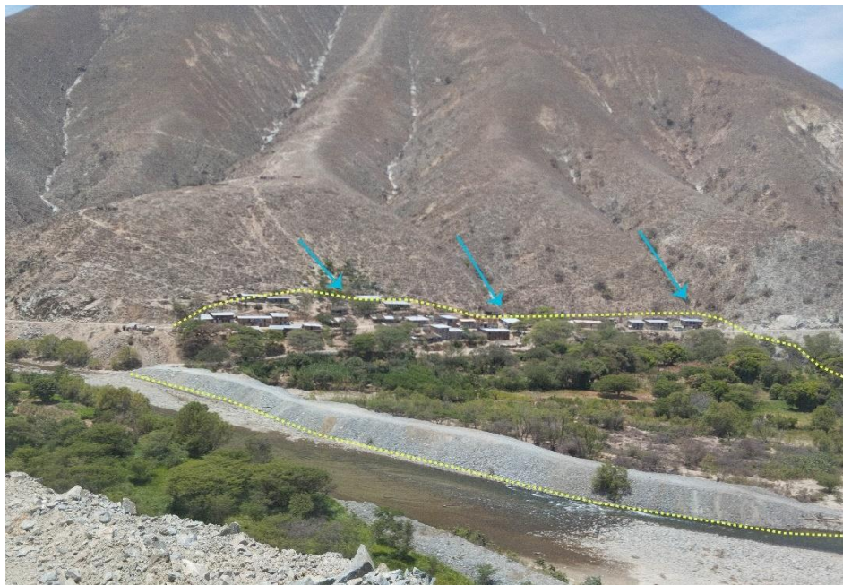
Figura 175. Zona crítica 20-113. Se identificó la ocurrencia de flujos de detritos que se desarrollan en las quebradas circundantes, y el río Quiroz, también se han registrado daño por inundaciones que afectan viviendas, cultivos y un total de 350 m lineales amabas márgenes del caserío Sausal de Culucan. Estos eventos han presentado activaciones en el mes de marzo del presente año y durante el 2017. (N: 9474728, E: 637356. 22/09/23).
