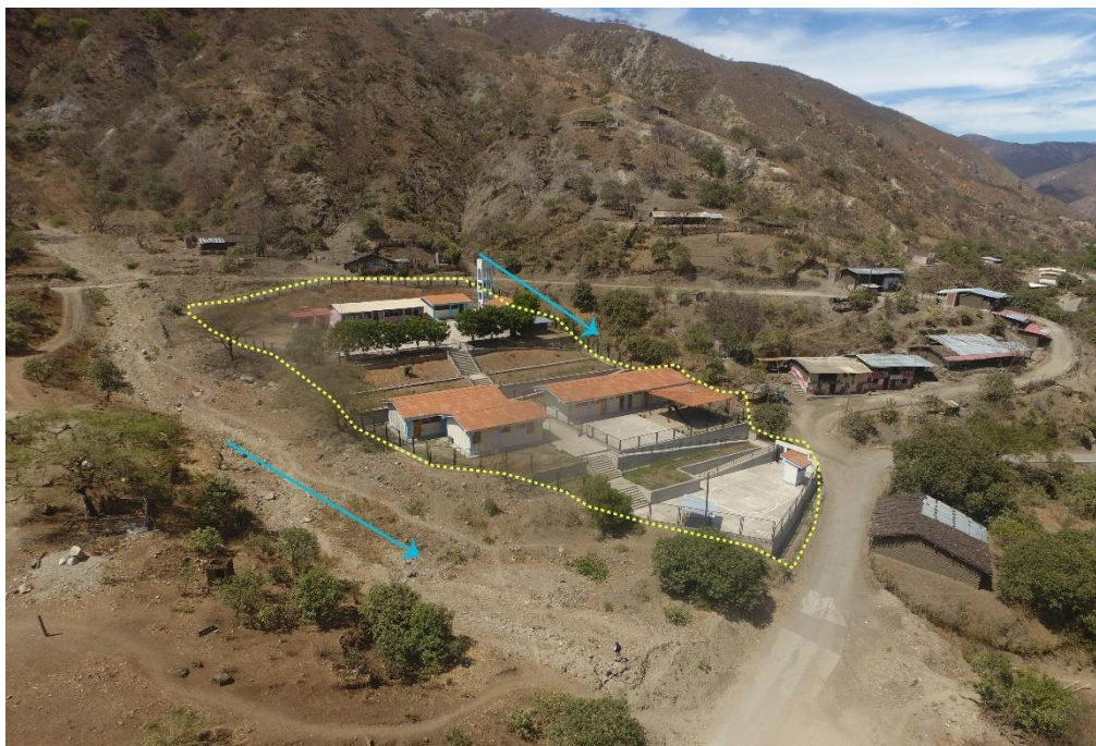
Figura 179. Zona crítica 20-117. Se identificó la ocurrencia de deslizamientos y caídas en la parte alta del sector Aranza. Los procesos se activan durante períodos de lluvias excepcionales y fenómenos de El Niño. (N: 9463431, E: 656446, 22/09/23).
