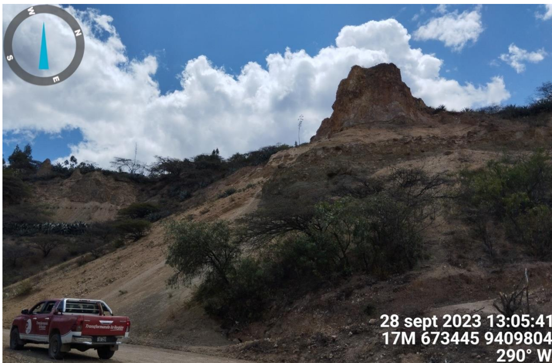
Figura 230. Zona crítica 20-168 En la parte alta de Sondorillo, con referencia al caserío Virgen del Carmen se han identificado secuencias sedimentarias expuestas a deslizamientos y procesos de erosión de laderas. Se identificó un deslizamiento de 210 m de largo y 162 m de ancho, el escarpe principal tiene 240 m de largo y 15 m de salto de falla.
