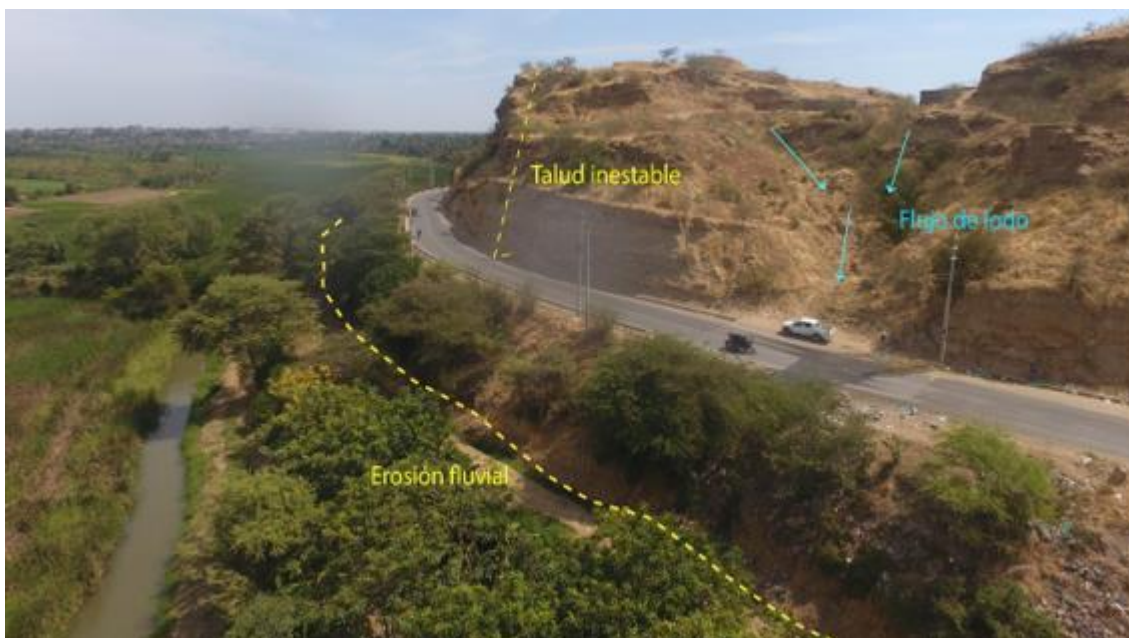
Figura 124. Zona crítica 20-063. Marcavelica, sector Las Palmeras donde se observa un talud inestable donde pueden generarse derrumbes, caída de rocas, como también flujos de lodo. Todos estos eventos pueden afectar un tramo de 120 m (N:9461183 E:533528 14/09/23).
