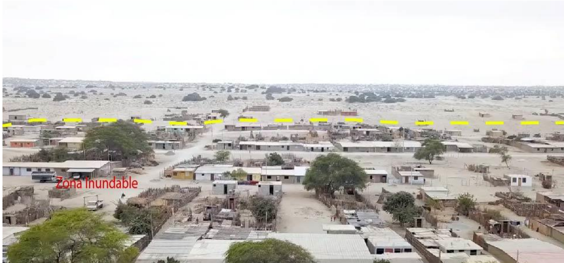
Figura 153. Zona crítica 20-091. Sector El Tabanco afectado por inundaciones que afectó viviendas y vías de acceso en el año 2017. Coordenadas (N: 9410371, E: 533610, 15/09/23).
