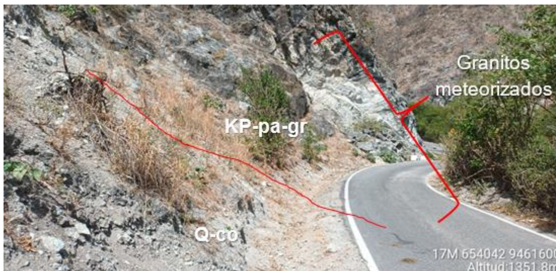
Figura 16. Granitos meteorizados cuyas plagioclasas se han convertido en arcillas, se encuentra cubierto por depósitos coluviales. Coordenadas: E: 654042; N: 9461600 (24/09/2023).
