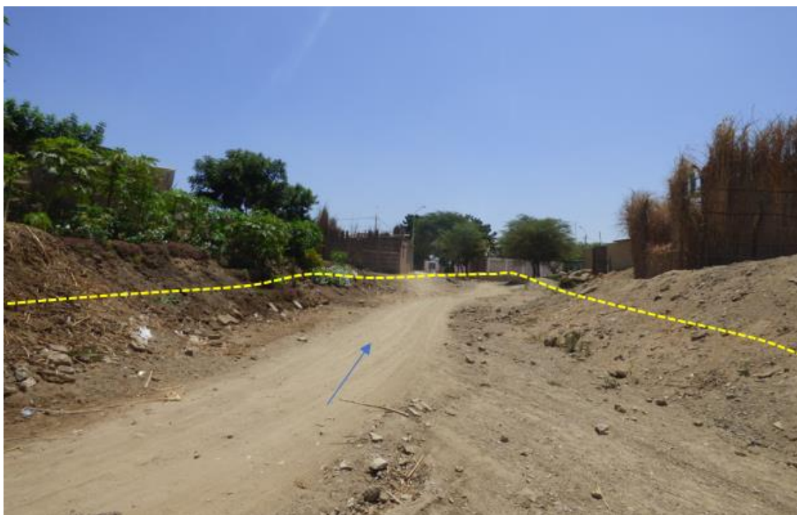
Figura 86. Zona crítica 20-027. Quebradas La Posta, sector sujeto a flujos de lodo provenientes de la intensa erosión de laderas alimentando quebradas principales. Las quebradas no presentan canalización, todos los flujos que se generarán discurrirán hacia el centro poblado. Se tiene alcantarillas de insuficientes dimensiones para la carga que va a generar los flujos, como también se tiene una mala ubicación. (N: 9459941, E: 498373, 29/08/2023).
