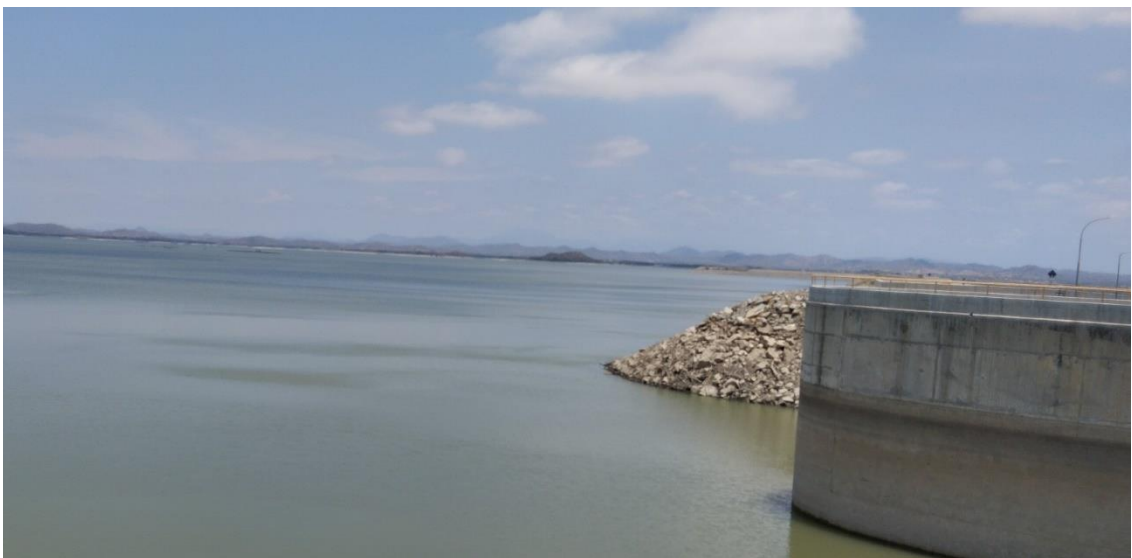
Fotografía 8. Superficie de agua en la represa Poechos.
