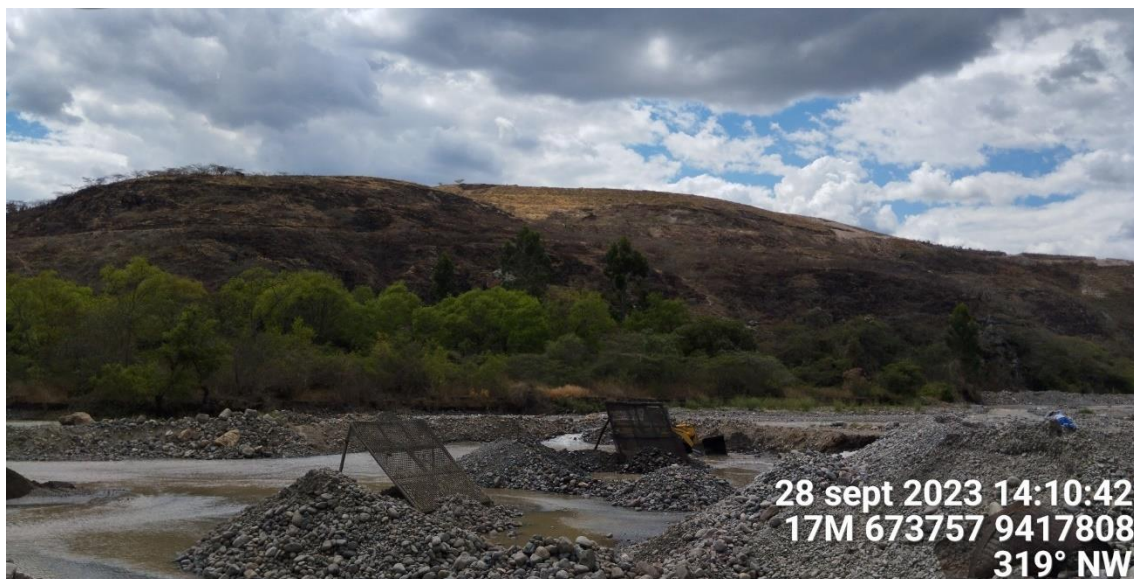
Figura 226. Zona crítica 20-164 En la etapa de campo se advierte que, en el sector del Aeródromo de Huancabamba, se viene ocupando ladera inferior por viviendas y se encuentra lotizado. Se identificaron deslizamientos en la ladera inferior del Aeródromo, proceso de erosión de laderas (cárcavas), erosión fluvial en la parte baja río Huancabamba.
