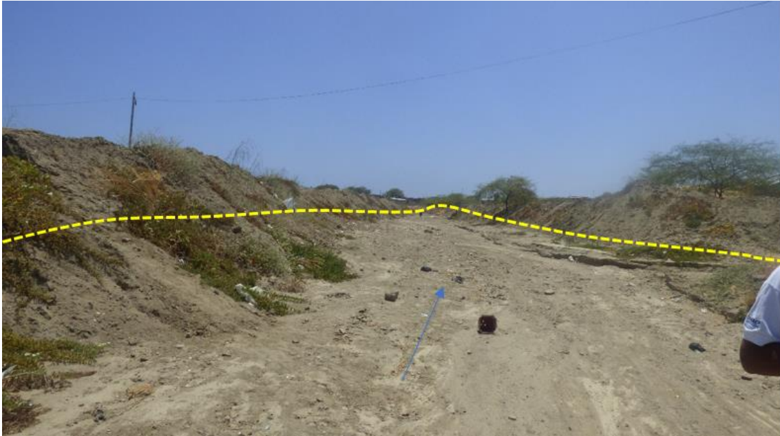
Figura 66. Zona crítica 20-007. Quebrada Somatitos, sector sujeto a flujos de lodo que se activa durante eventos del fenómeno de El Niño. La quebrada presenta un ancho de cauce de 10 m, se encuentra canalizada agua abajo de aprox. 800 m. (N: 9537481, E: 486438, 29/08/2023).
