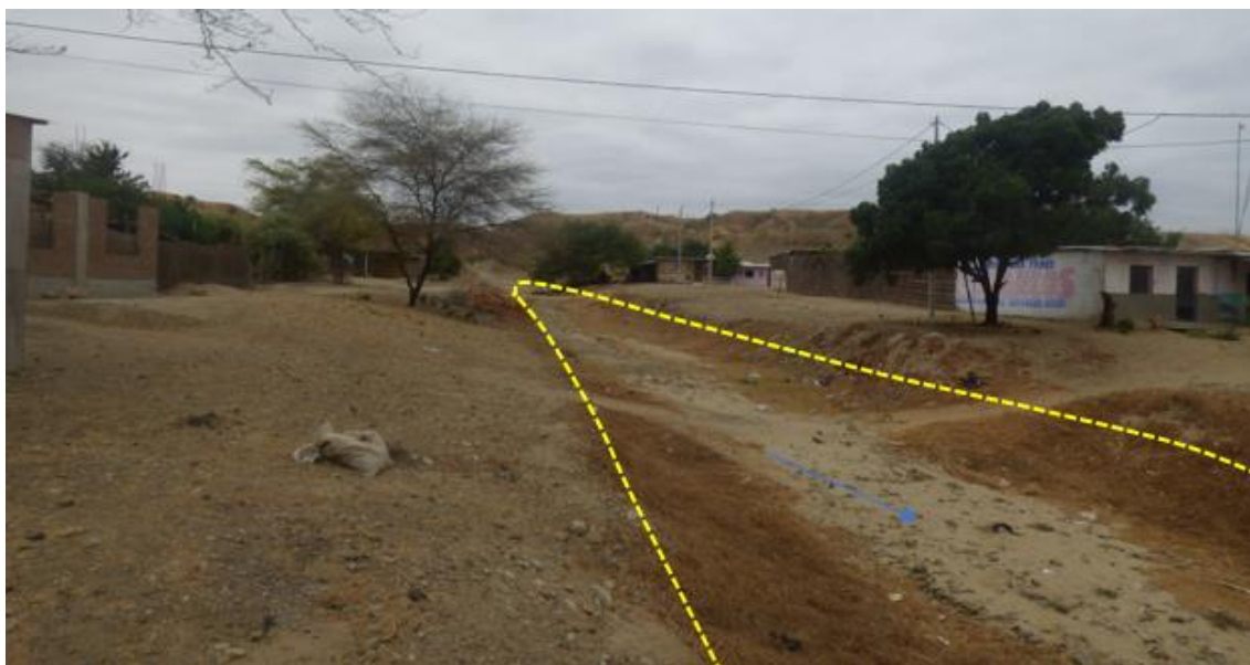
Figura 92. Zona crítica 20-033. C.P. El Portón, afectado por 03 quebradas que se activan durante fenómenos de El Niño y lluvias excepcionales arrastrando flujos de detritos. Presentan canalización por arrimado de material, con un ancho de cauce de 12 m. que se estrecha aguas abajo. En el lecho se tiene material suelto conformado por arena, gravillas y cantos subredondeados. (N: 9456507, E: 510699, 29/08/2023).
