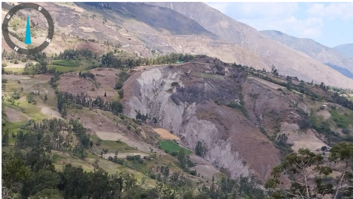
Figura 228. Zona crítica 20-166 El área urbana de Sondor y el Caserío El Rosario se asienta sobre un piedemonte coluvio deluvial conformado por grava y arenas de clastos angulosos, envueltos en un matriz limo arcillosa muy susceptible a movimientos en masa. Se identificaron deslizamientos y la formación de escarpes, además de deslizamientos antiguos que provienen desde la parte alta del sector Sondor.
