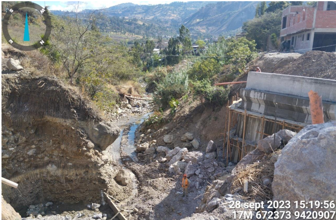
Figura 224. Zona crítica 20-162 Deslizamientos de tipo rotacional y flujos de detritos que descendieron por la quebrada Ungulo. Se destaca que, 550 m aguas arriba se viene ejecutando la construcción de puente vehicular, se advierte que esta estructura estrangula el ancho real del cauce de la quebrada. Ante la ocurrencia de nuevos flujos, este cauce puede represarse y generar un evento más crítico. Además, el puente Ungulo sigue teniendo las mismas condiciones de altura y ancho no idóneas ante la ocurrencia de flujos.
