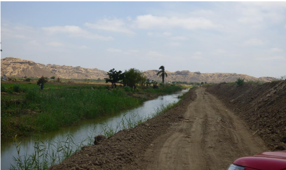
Figura 88. Zona crítica 20-029. Quebrada Santo Papa y Nueva Libertad, se encuentran canalizadas con arrimado de material y atraviesa vía Tamarindo - Amotape mediante un badén. El cauce de la quebrada se estrecha aguas abajo, pasando de 20 m a 8 m. (N: 9460839, E: 501327, 29/08/2023).
