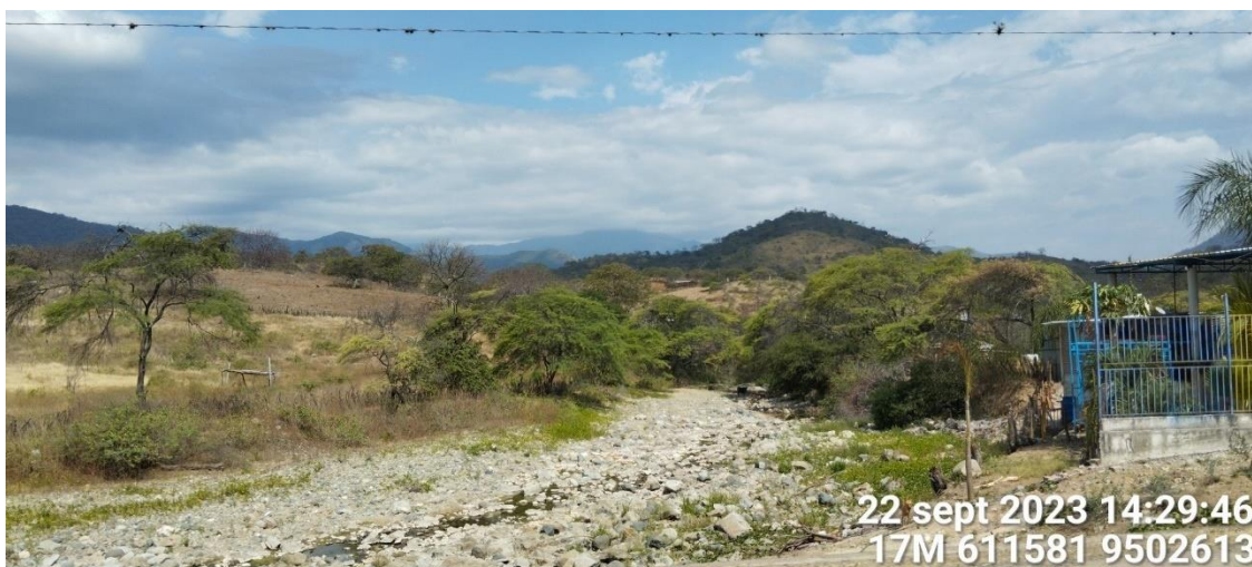
Fotografía 20. Centro Poblado Roca Rajada afectado por flujos de detritos, Suyo.
