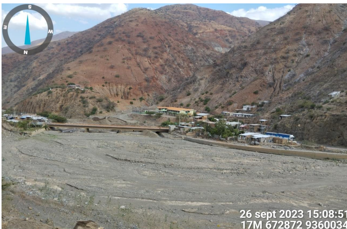
Figura 235. Zona crítica 20-173 En la quebrada Hualapampa ocurren constantemente flujos de detritos que se activan en temporada de lluvia, debido a la litología in situ y de la cuenca media y alta, los materiales acarreados colmatan el cauce afectando infraestructura como puentes y viviendas.
