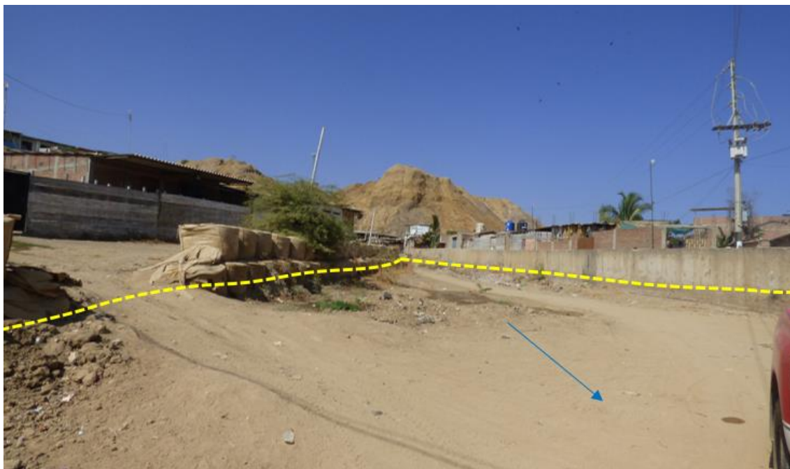
Figura 61. Zona crítica 20-002. Sector expuesto a flujos de lodo proveniente de quebradas y flujos por erosión de laderas, que discurren por los canales de las calles de los AA.HH. 1 de Mayo y A.H. Víctor Raúl. Las calles canal, el cauce esta cementado y hacia sus márgenes tienen muros (tipo barrera) de mampostería, con profundidad de 1 m y ancho de 12 m. Este canal se estrecha aguas abajo. (N: 9545767, E: 494798, 29/08/2023).
