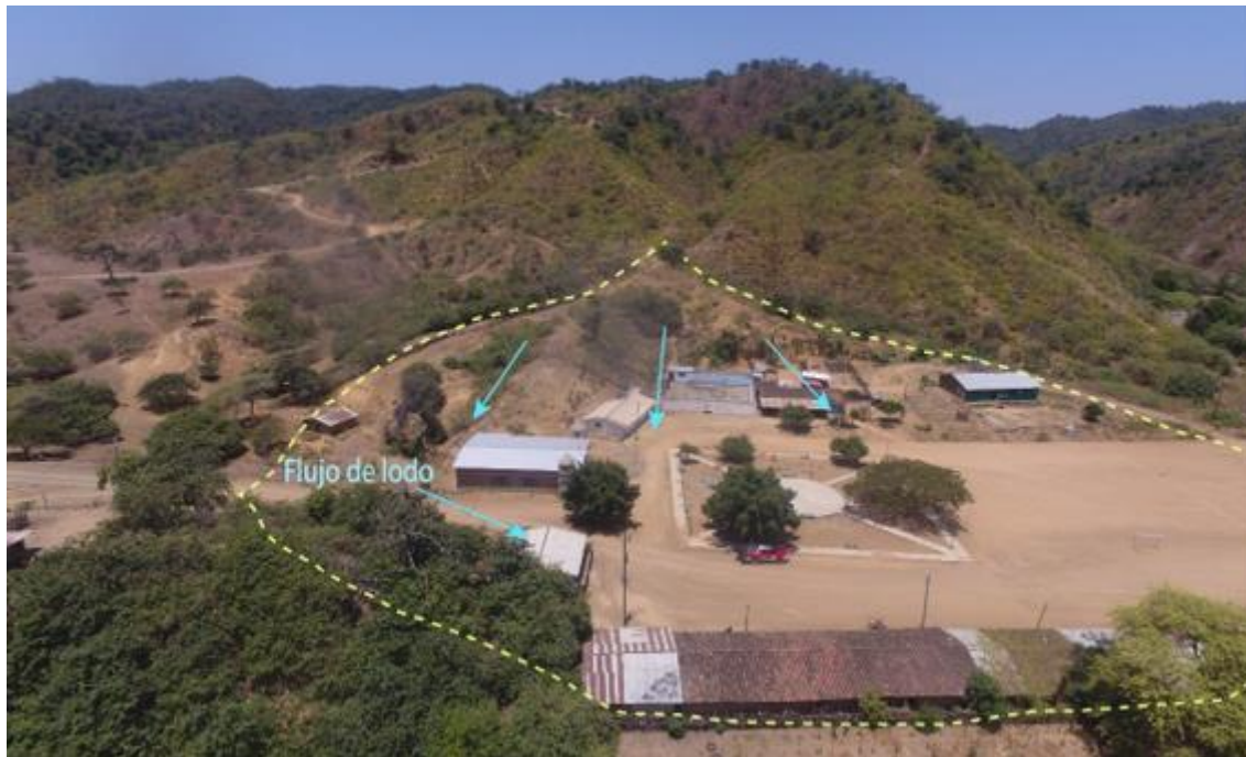
Figura 116. Zona crítica 20- 056. Papayo de los Encuentros, coordenadas E: 555393 N: 9521399, se observa una quebrada s/n de corto recorrido, pero de pendiente moderada a fuerte que genera un flujo de detritos, afecta viviendas y la plaza principal.
