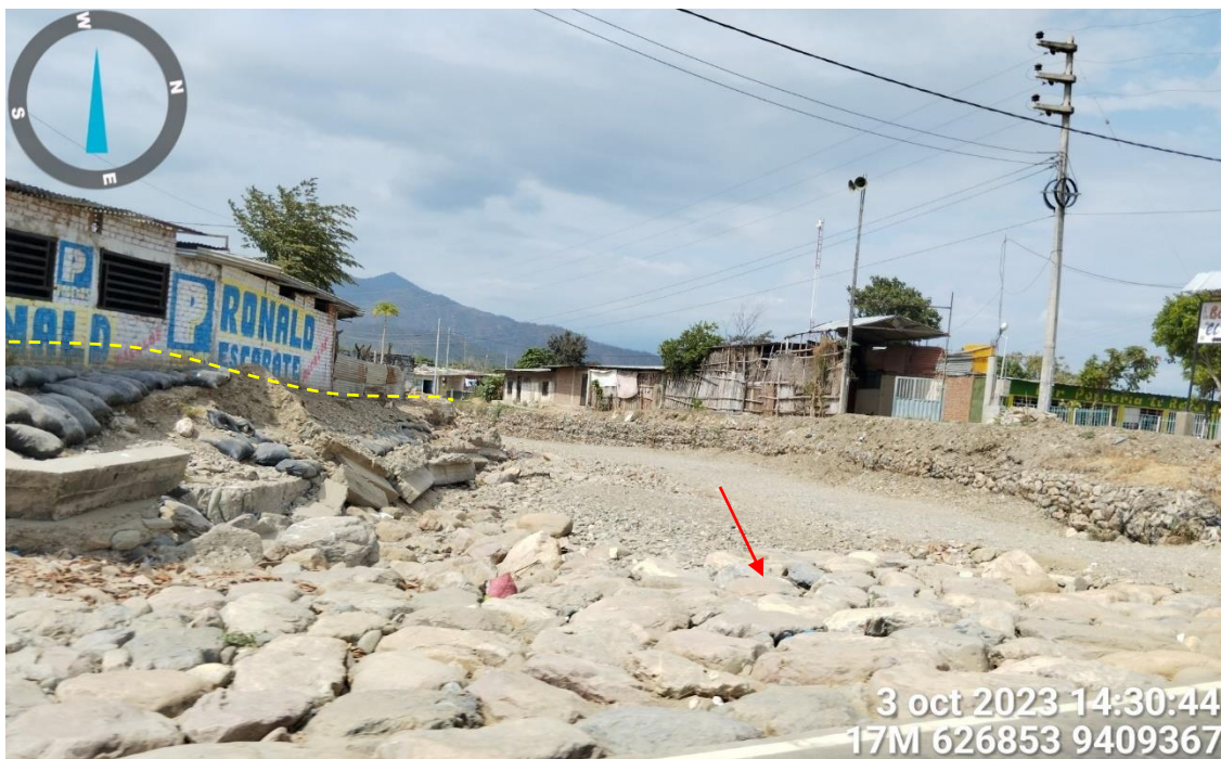
Figura 213. Zona crítica 20-151 Villa Malacasi se ubica en un abanico aluvial, limitado por montañas en rocas metamórficas conformados por facies de gneis - esquistos y mica esquistos con presencia de cuarzo. Los flujos de detritos descenden por quebradas que se activan en temporada de lluvias afectando viviendas y vías de comunicación (trocha carrozable). (N: 9409367, E: 626853, 17/09/23).
