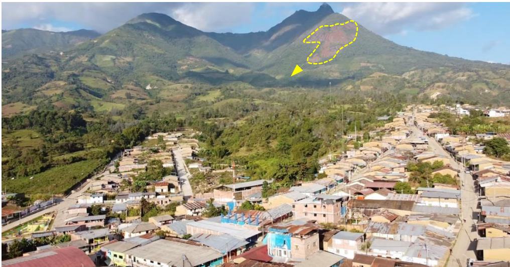
Figura 181. Zona crítica 20-119. Deslizamientos en la ladera sur donde los materiales forman flujos que descienden por las quebradas circundantes al área urbana. (N: 9454120, E: 619499, 22/09/23).
