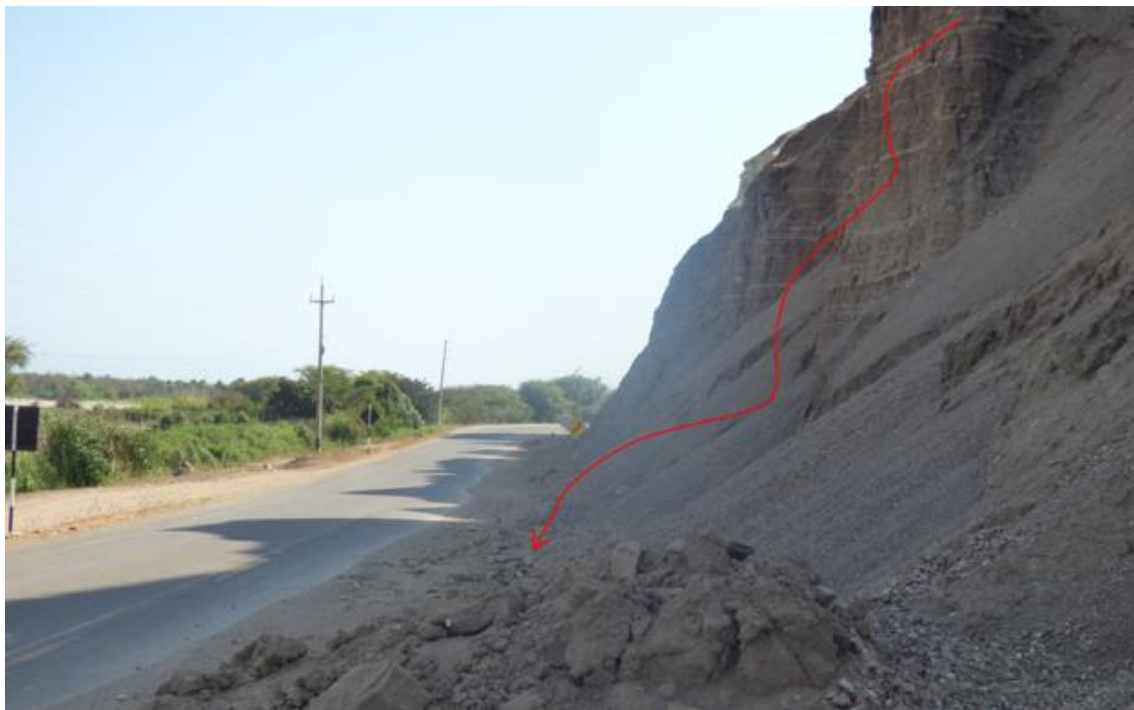
Figura 82. Zona crítica 20-023. Sector Cerros Hinchados, las areniscas se encuentran medianamente fracturadas y moderadamente meteorizadas. Las lutitas y limolitas se encuentran medianamente a muy fracturadas y moderadamente meteorizadas. Se tiene además depósitos coluvio-deluviales producto de los derrumbes. (N: 9464047, E: 495651, 29/08/2023).
