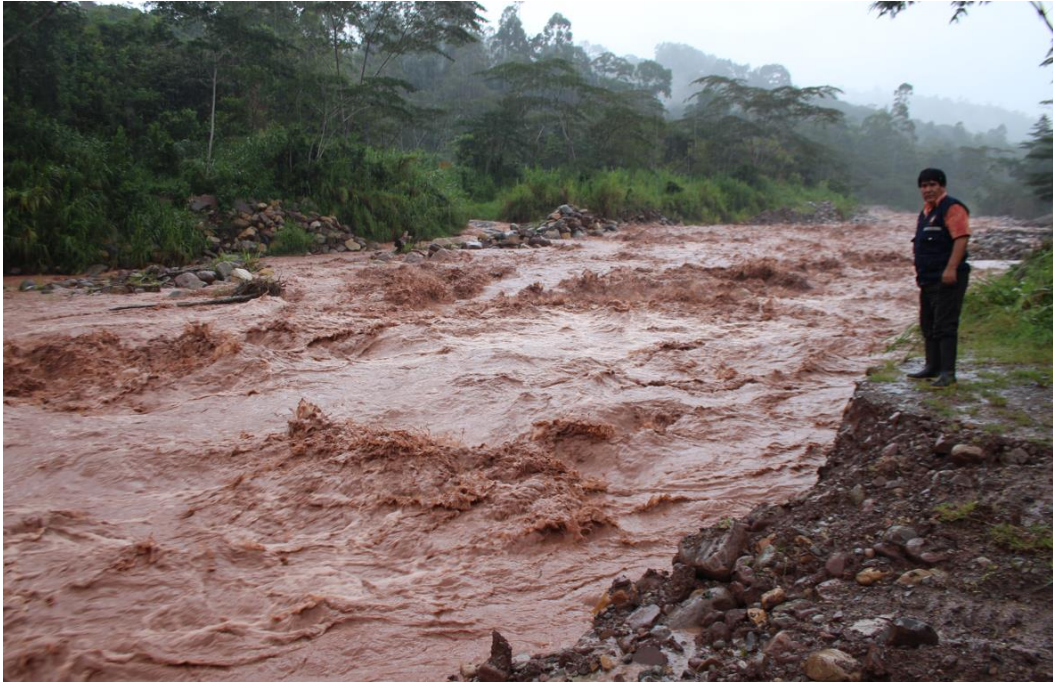
Fotografía 3. Crecida en el río Entaz Barrio Industrial – Villa Rica. Muestra erosión en las márgenes del río.
