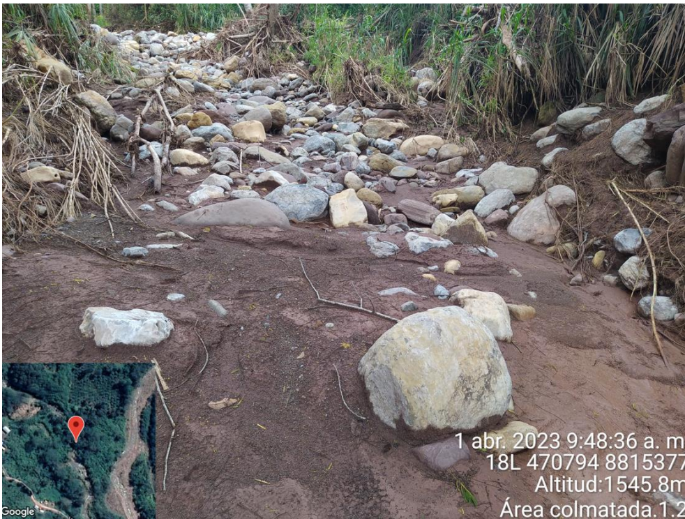
Fotografía 6. Colmatación del río en el Área 1.2, lado 1
