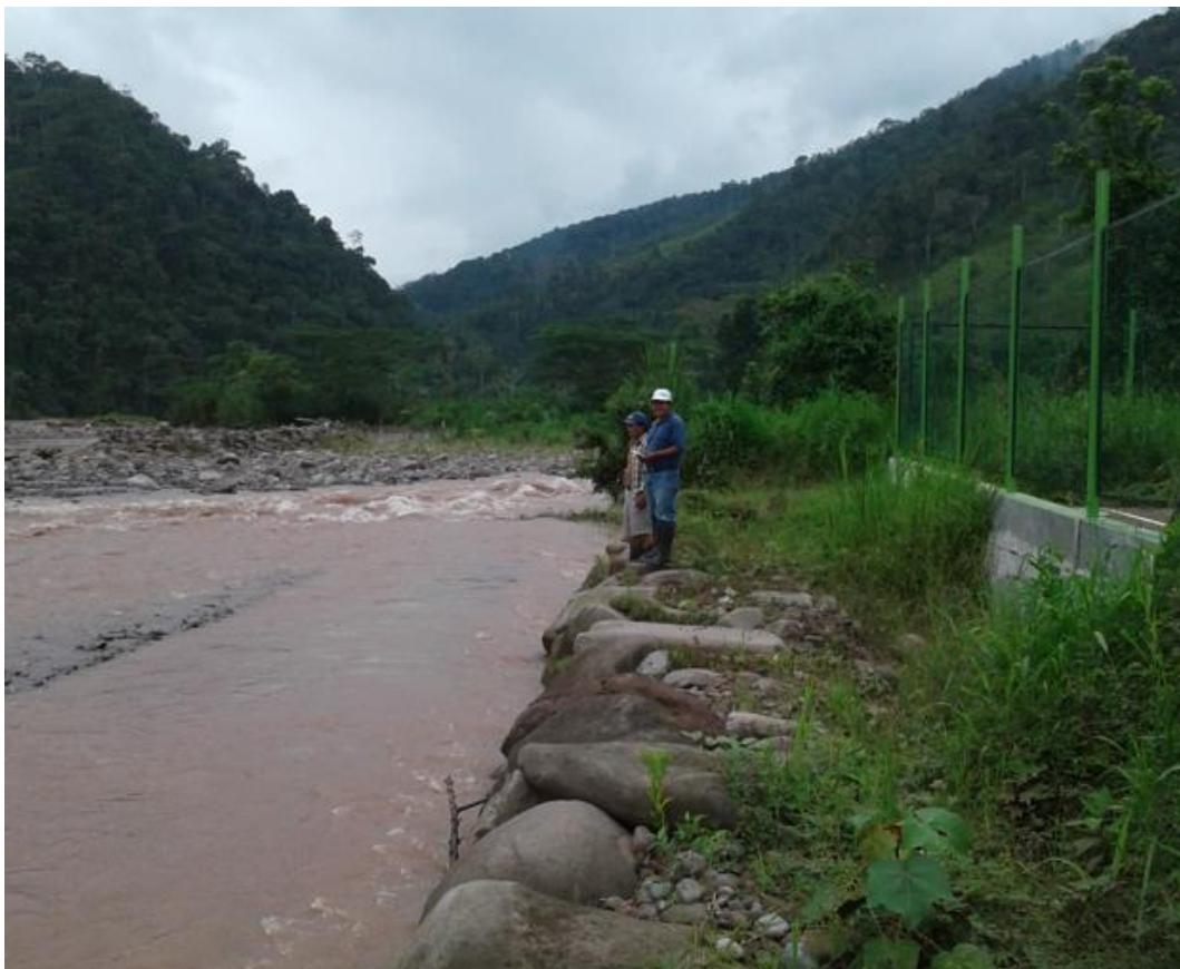
Fotografía 4. Crecida en el río Entaz Barrio Industrial – Villa Rica. Muestra el funcionamiento de enrocado.
