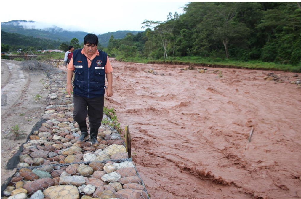
Fotografía 2. Crecida en el río Entaz Barrio Industrial – Villa Rica. Muestra el funcionamiento de los gaviones.
