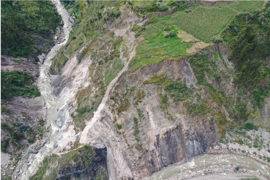
Fotografía 1: Vista aérea de la margen derecha del río Mosna, se observan agrietamientos en los depósitos de suelo, los suelos en contacto con la Formación Oyón.
