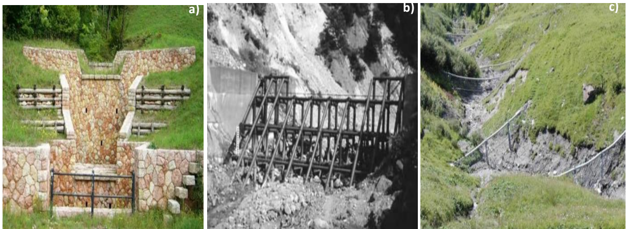
Figura 5. Presas tipo SABO de sedimentación escalonada para controlar la fuerza destructiva de los huaicos, a) de control; b) tipo rejilla; c) barras flexibles.
