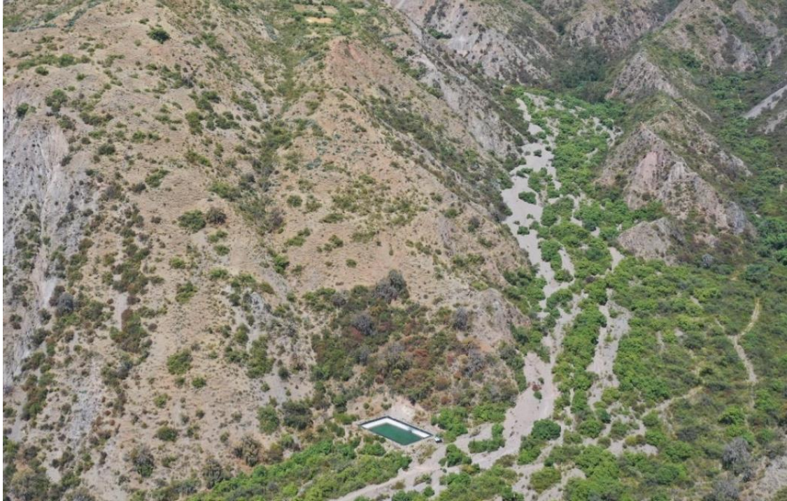
Fotografía 6. Vista del revensorio ubicado en la margen derecha de la Yuracc Ccacca, la misma que en la actualidad está en uso, imagen obtenida con el dron.
