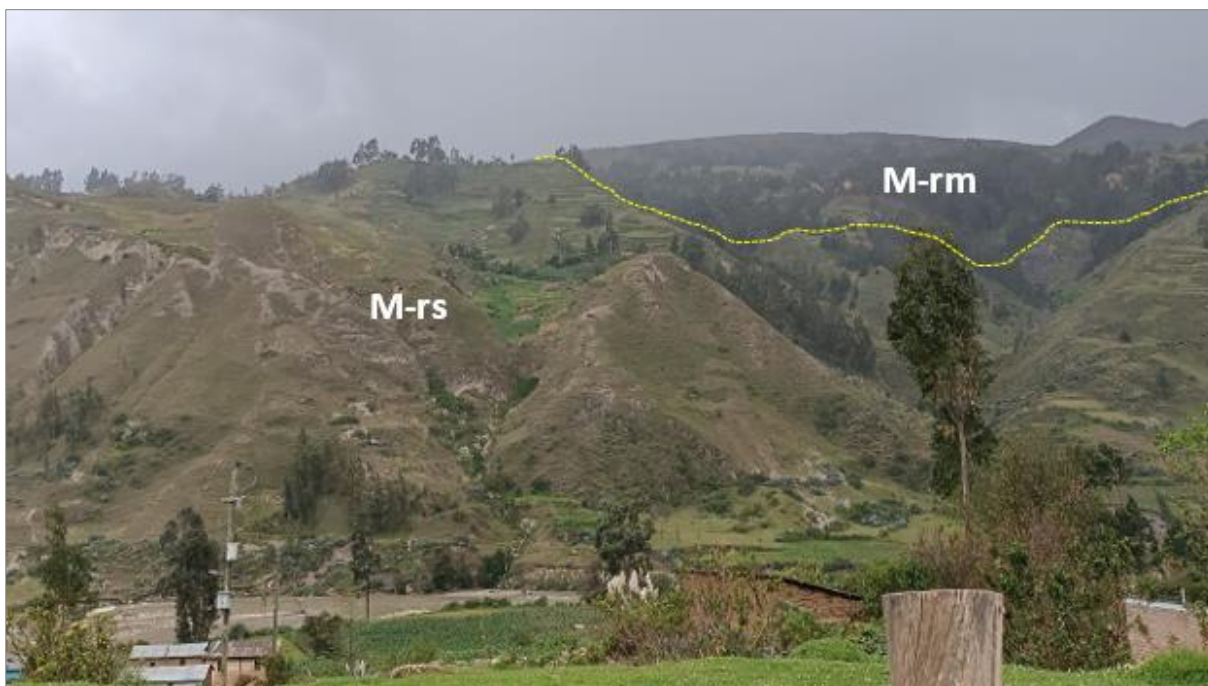
Figura 11. Vista con dirección al sureste, se observa el contacto de las subunidades geomorfológicas conformadas por montaña en roca sedimentaria (M-rs) y montaña en roca metamórfica (M-rm).
