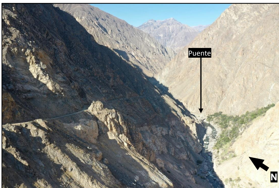
Figura 25. Zona de caída de rocas, carretera de acceso a Choco, margen derecha del río Colca.
