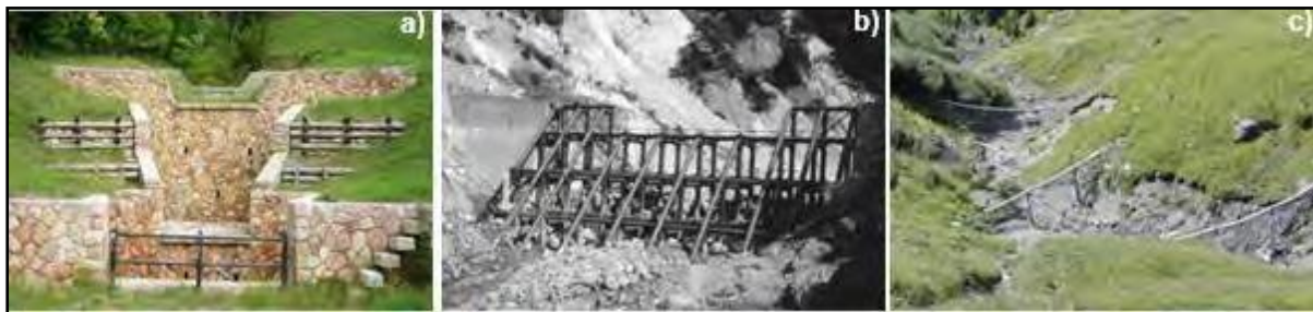
Figura 27. Presas tipo SABO de sedimentación escalonada para controlar la fuerza destructiva de los huacos, a) de control; b) tipo rejilla; c) barras flexibles, (Vilches, 2021)
