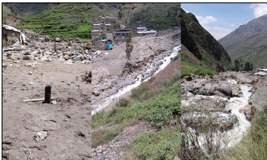
Figura 13. Afectación en la localidad de Miña. Fotografías: Municipalidad de Choco
