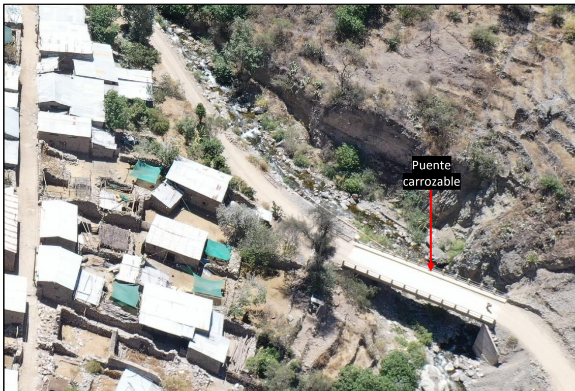
Figura 12. Puente carrozable antes del huaico del 22 de enero.
