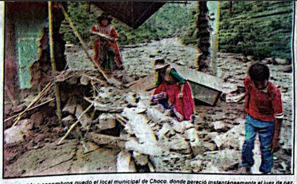
Reducido a escombros quedó el local municipal de Choco, donde pereció instantáneamente el juez de paz, Eradio Barrionuevo Carpio y el Teniente Alcalde Adrian Lupaca Banda.
