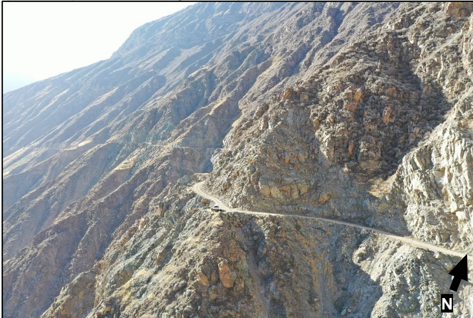
Figura 24. Zona de caída de rocas, carretera de acceso a Choco.
