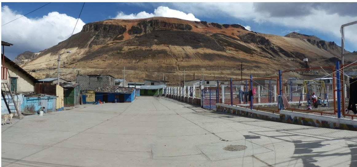
Fotografía 4. Asentamiento de terreno muy cerca al parque recreacional, intersección de calle Pflucker con el Jr. 04 (tomada de INGEMMET, 2013). En la actualidad el parque y las viviendas aledañas se encuentran destruidas.
