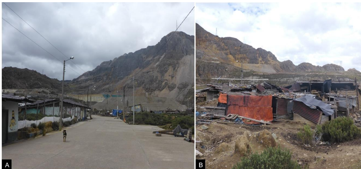
Figura 6. A. Las calles de Morococha antigua lucen vacías, a los lados se observan escombros de las casas que fueron destruidas, algunas viviendas aún albergan personas. B. Viviendas precarias a punto de colapsar y con óxidos que constituyen peligro para la salud.
