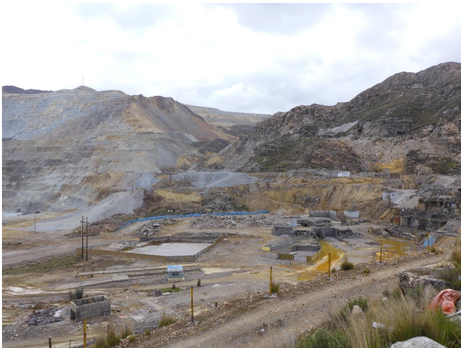
Fotografía 3. En la imagen se observa el depósito de relave muy cerca de las viviendas que aún alojan familias en el sector de Morococha antigua.
