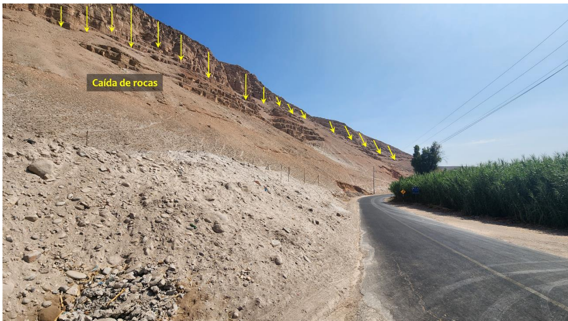
Figura 15. Se observa la zona de arranque de caída de rocas.
