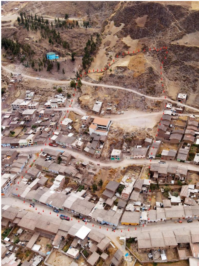
Figura 6. Se observa el área de influencia directa del deslizamiento rotacional activo.
