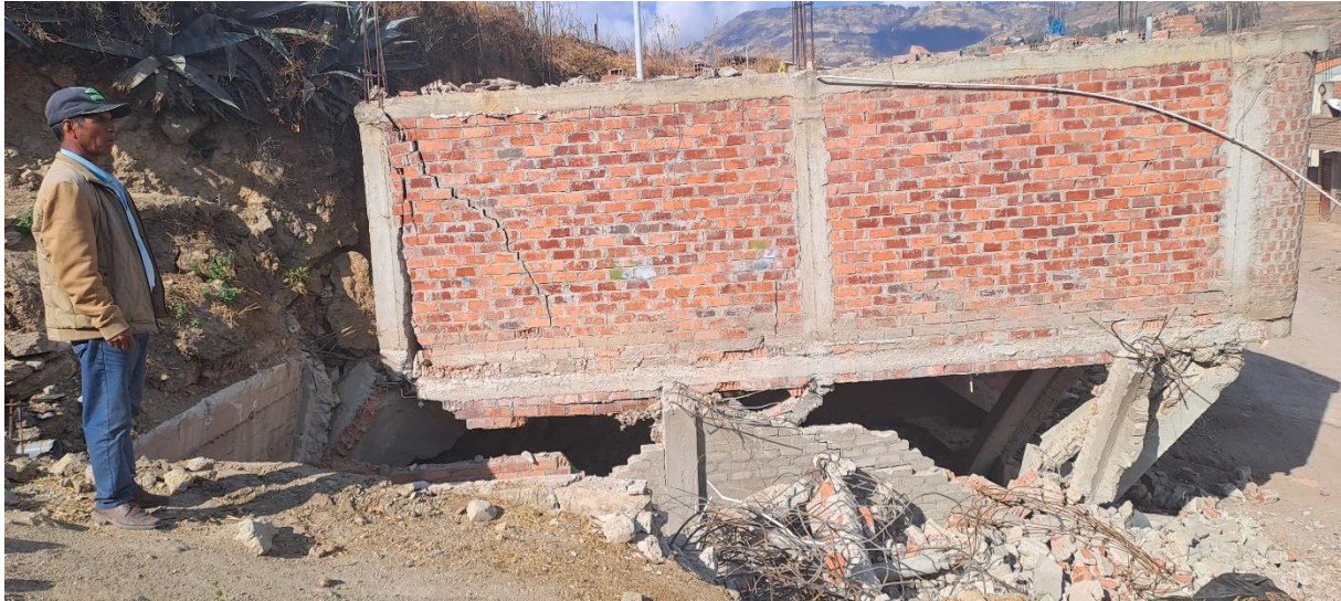
Fotografía 3. Vivienda destruida ubicada en el cuerpo de deslizamiento rotacional activo. UTM: 769015 / 9125943, Zona 17.
