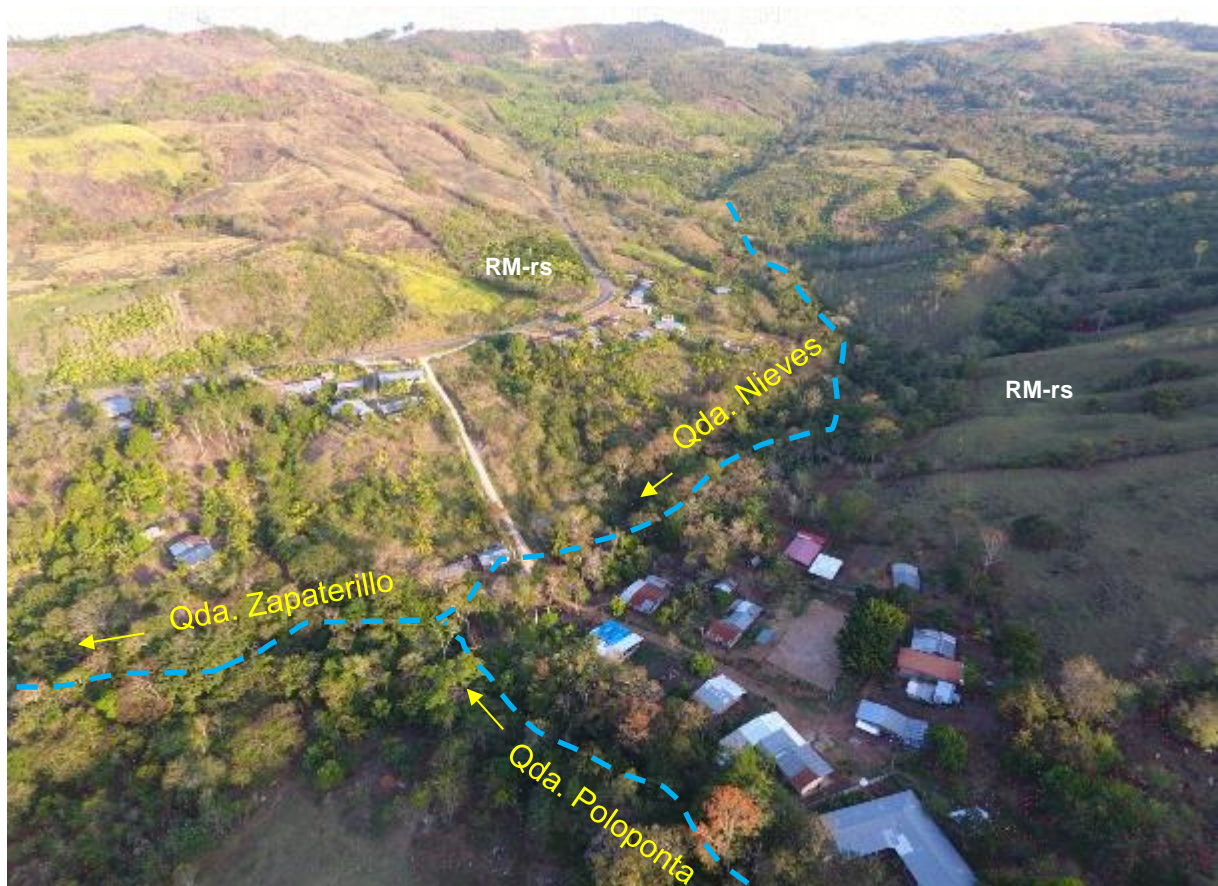
Figura 11. Vista general del C.P Poloponta, asentada sobre laderas de montañas en roca sedimentaria.
