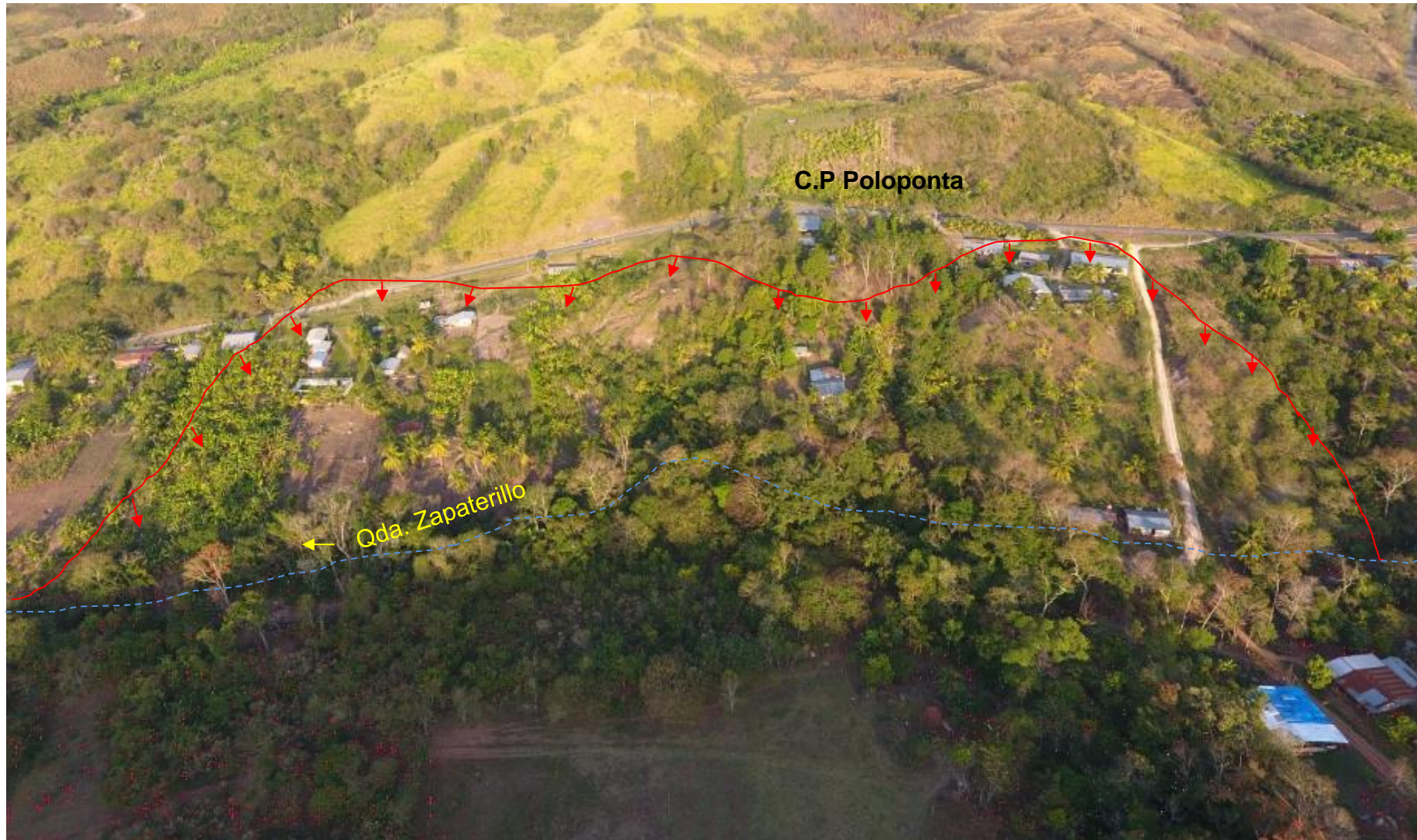
Figura 13. Vista frontal del deslizamiento de Poloponta.
