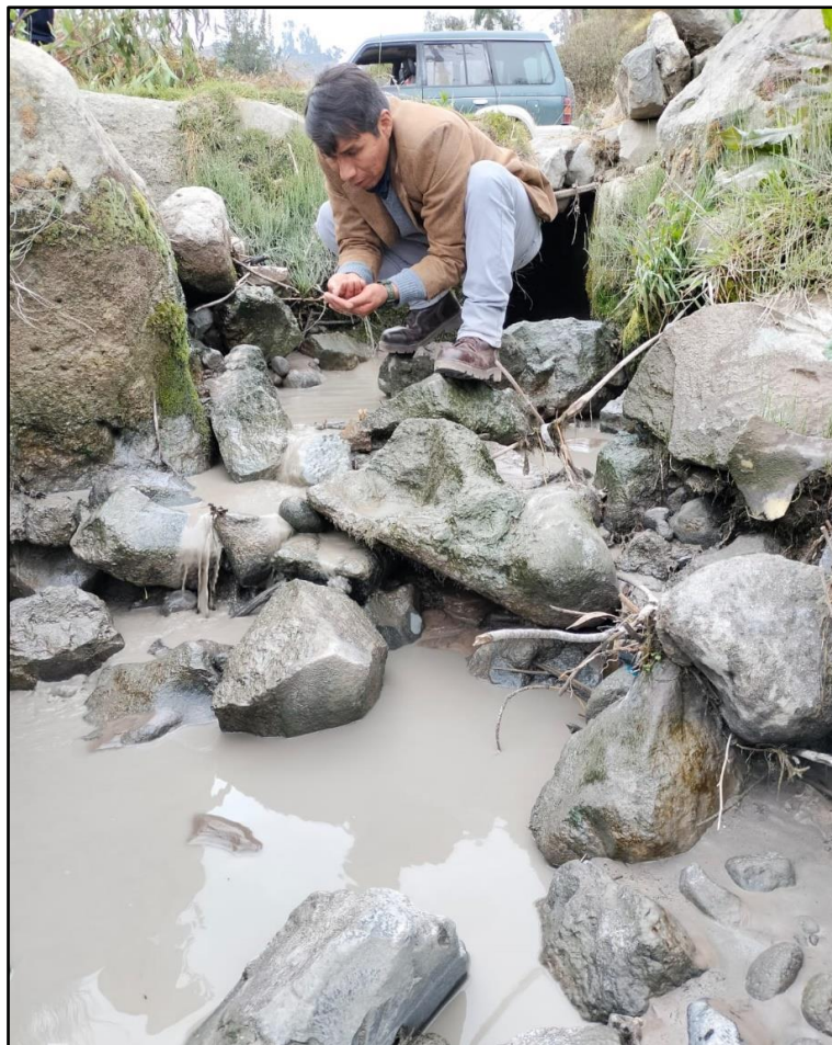
Figura 7. Canal de irrigación que arrastró material fino (lodo) causando inconvenientes en el suministro de agua para la actividad pecuaria. Foto. R. Portilla.
