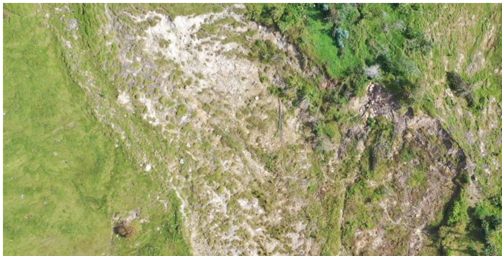
Fotografía 2. Suelos coluvio deluviales compuestos por arcillas de alta plasticidad ubicadas en la parte alta del movimiento complejo de Recta. Ubicación: E: 191061, N: 9344750, Z: 2206.
