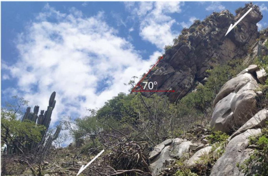
Figura 3: Afloramientos de areniscas de la Formación Chimú, sobre el poblado de Chacapunta (Distrito de Lucma). Estas rocas se muestran muy fracturadas y una de las familias a favor de la pendiente. Fuente: Luna & Albinez (2021).
