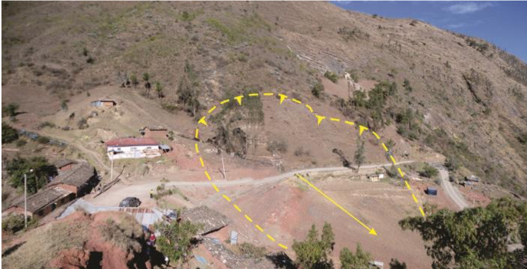
Foto 10 y 11. Deslizamiento de Antacalla (foto septiembre 2013)
