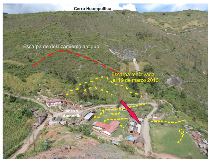
Foto 10. Deslizamiento de Antacalla (foto abril 2013)
